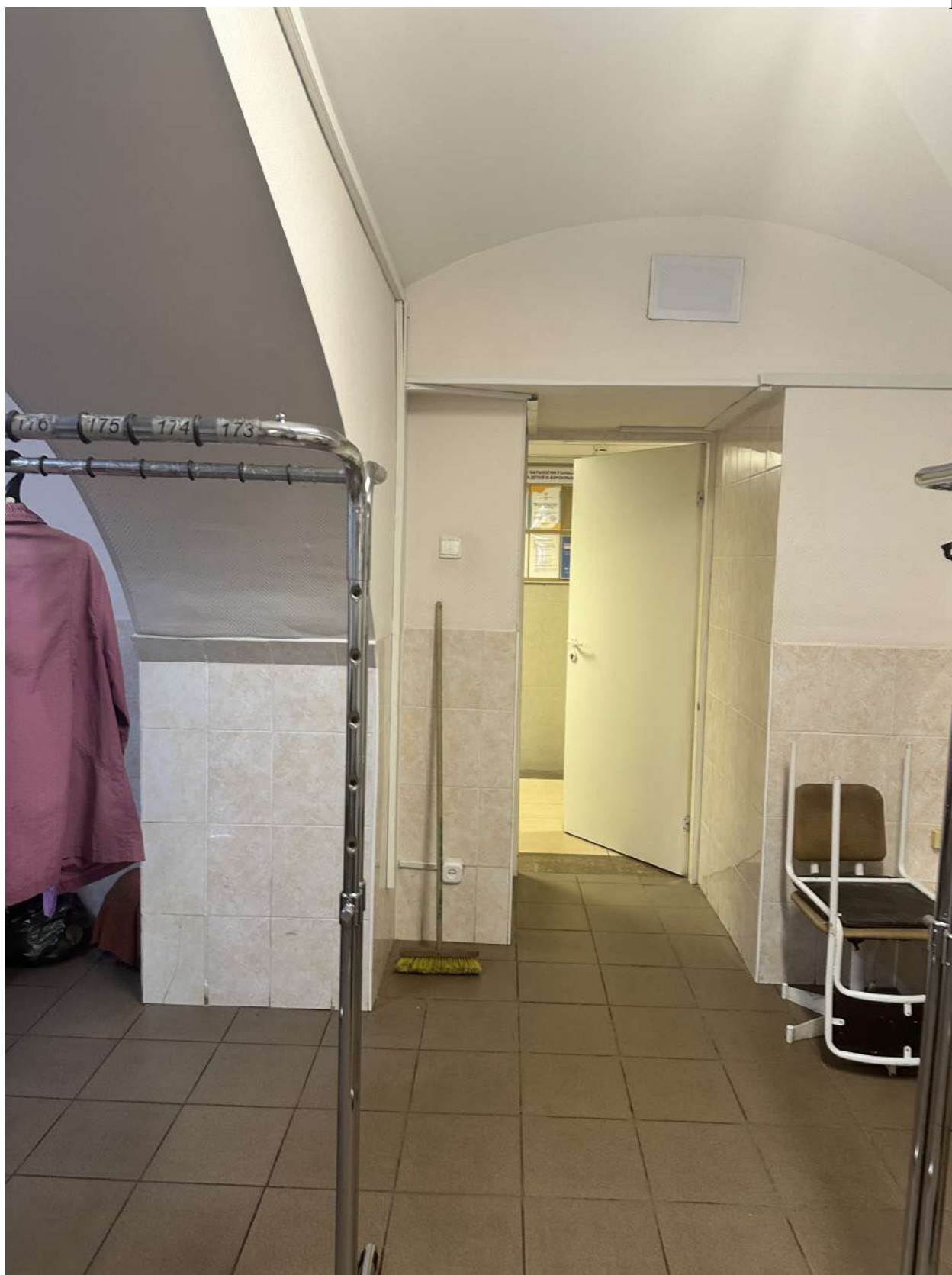
Фото 21. Общий вид на часть помещений в границе проектирования.
