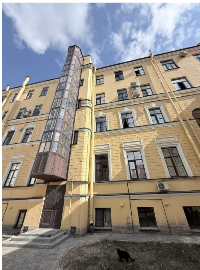
Фото 2. Общий вид на дворовой фасад объекта.
