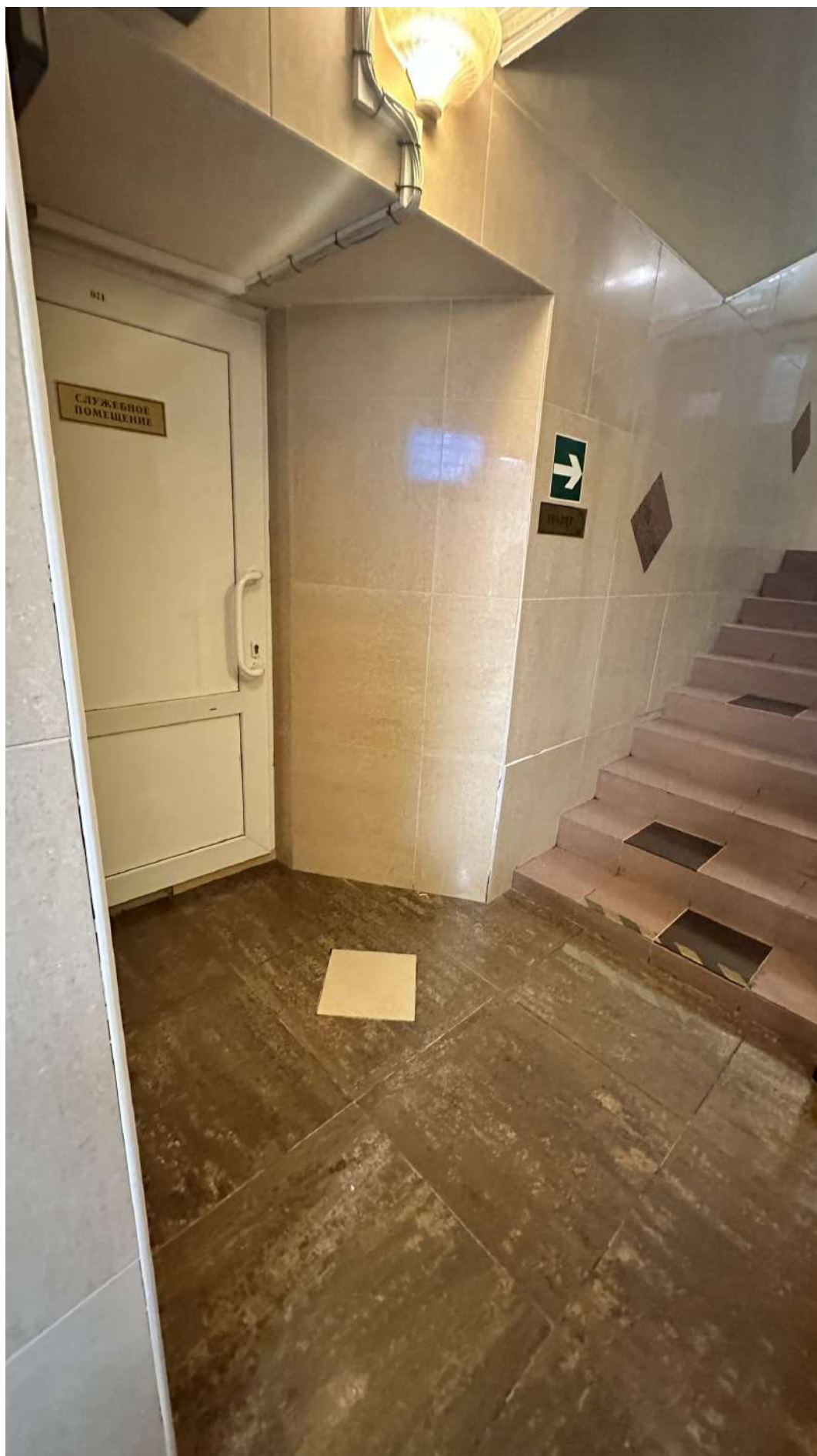
Фото 17. Общий вид на часть помещений в границе проектирования.
