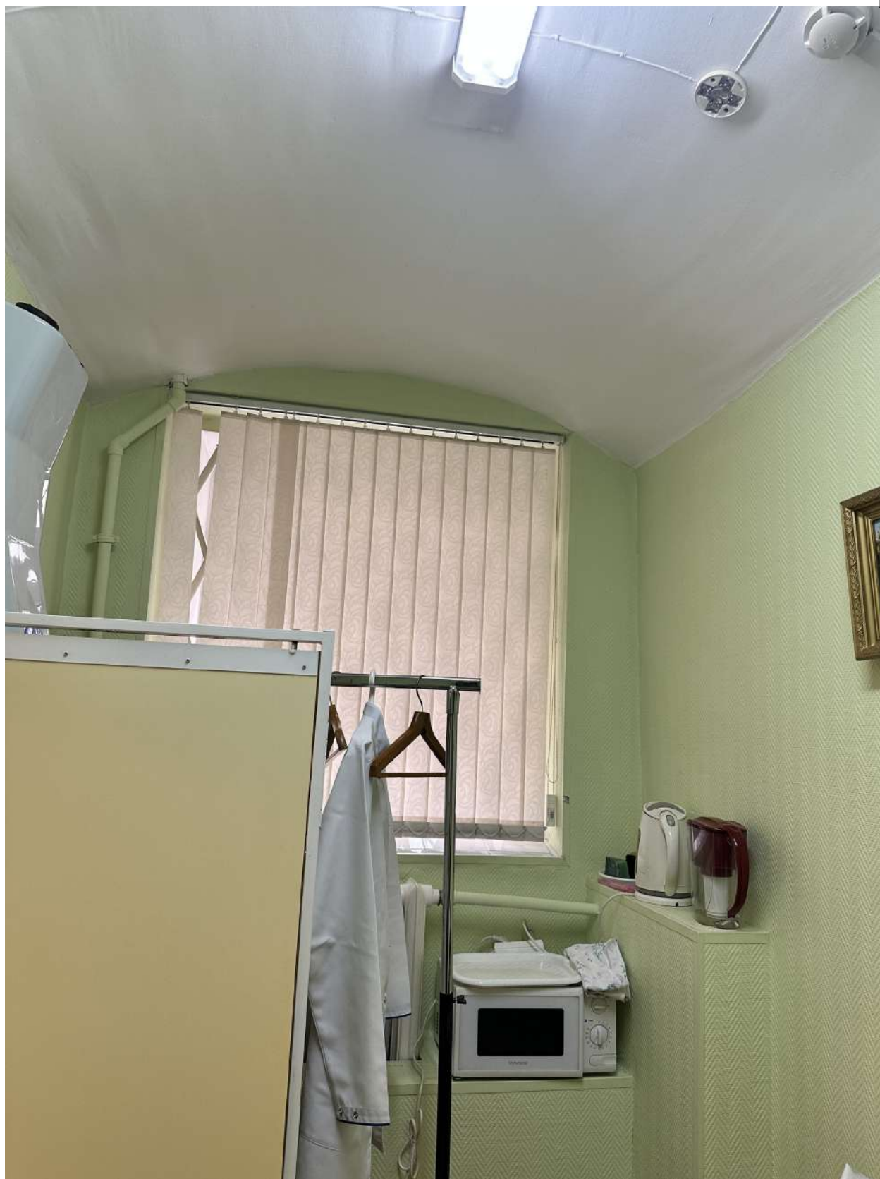
Фото 6. Общий вид на часть помещений в границе проектирования.
