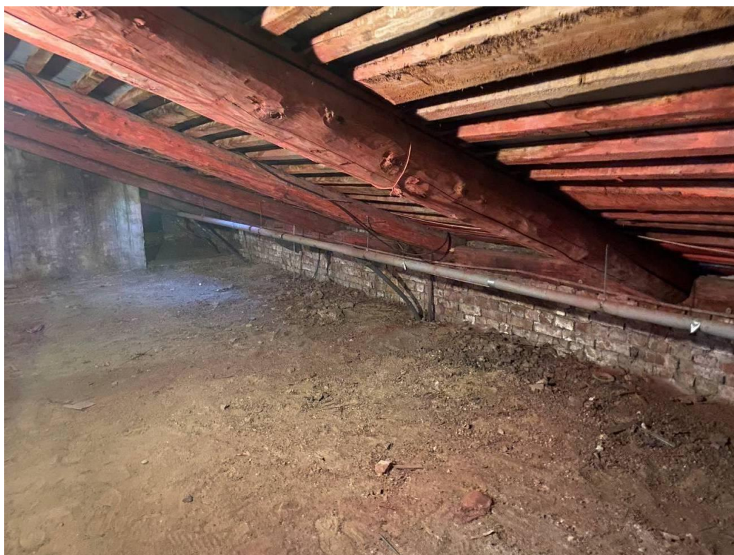
Фото 52. Интерьер чердачного этажа выявленного объекта культурного наследия «Дом для служащих», входящего в состав выявленного объекта культурного наследия «Царскосельская очистная станция (3 здания)»
