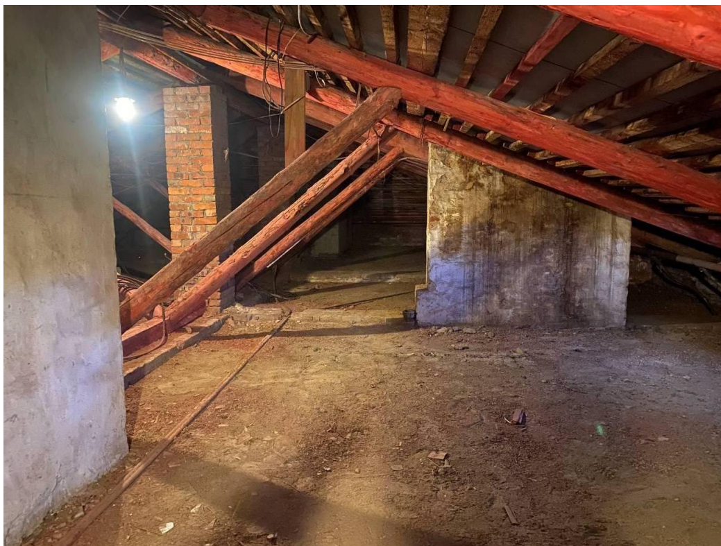
Фото 53. Интерьер чердачного этажа выявленного объекта культурного наследия «Дом для служащих», входящего в состав выявленного объекта культурного наследия «Царскосельская очистная станция (3 здания)»
