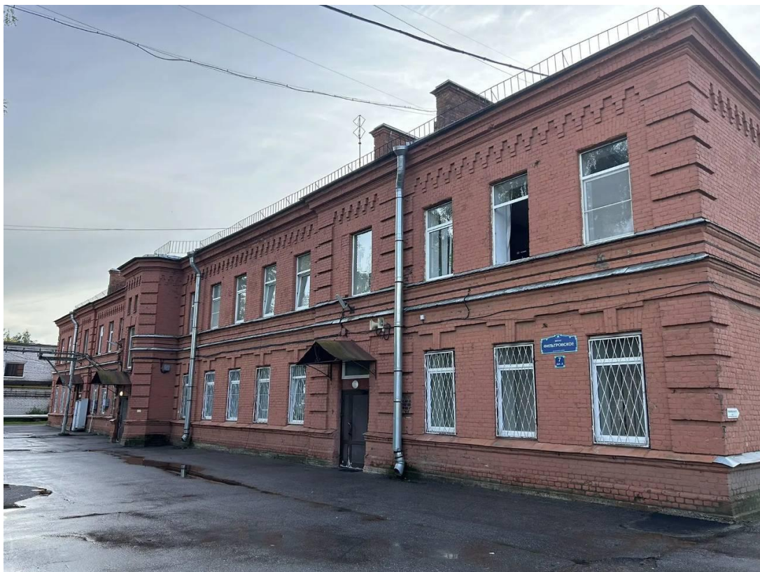
Фото 1. Фрагмент фасада выявленного объекта культурного наследия «Дом для служащих», входящего в состав выявленного объекта культурного наследия «Царскосельская очистная станция (3 здания)»
