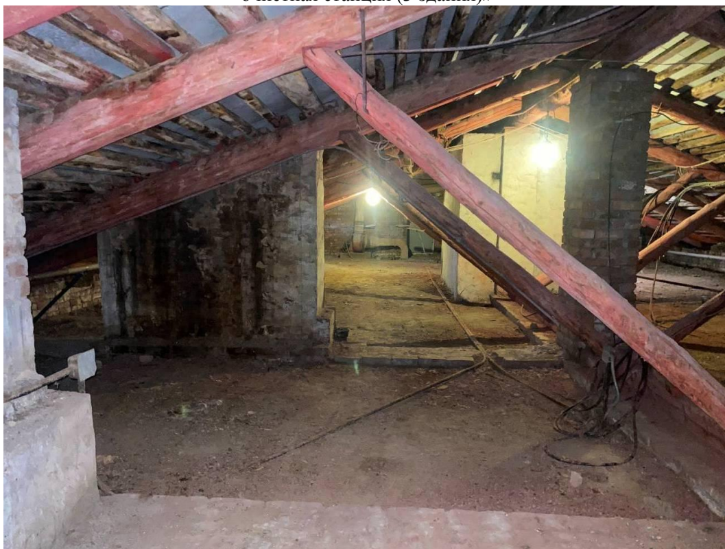
Фото 54. Интерьер чердачного этажа выявленного объекта культурного наследия «Дом для служащих», входящего в состав выявленного объекта культурного наследия «Царскосельская очистная станция (3 здания)»
