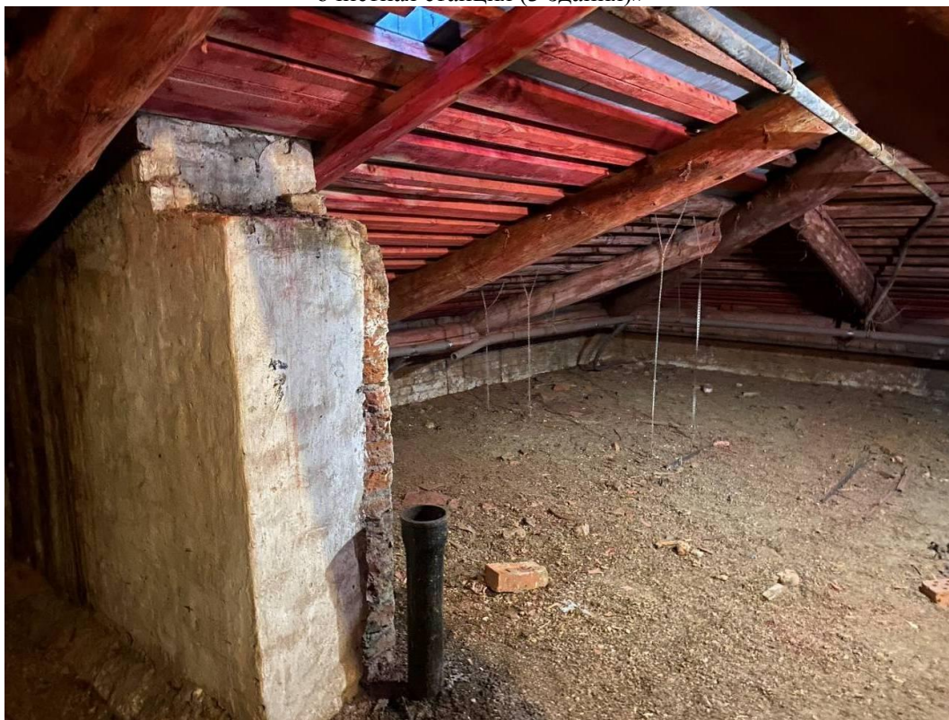
Фото 56. Интерьер чердачного этажа выявленного объекта культурного наследия «Дом для служащих», входящего в состав выявленного объекта культурного наследия «Царскосельская очистная станция (3 здания)»
