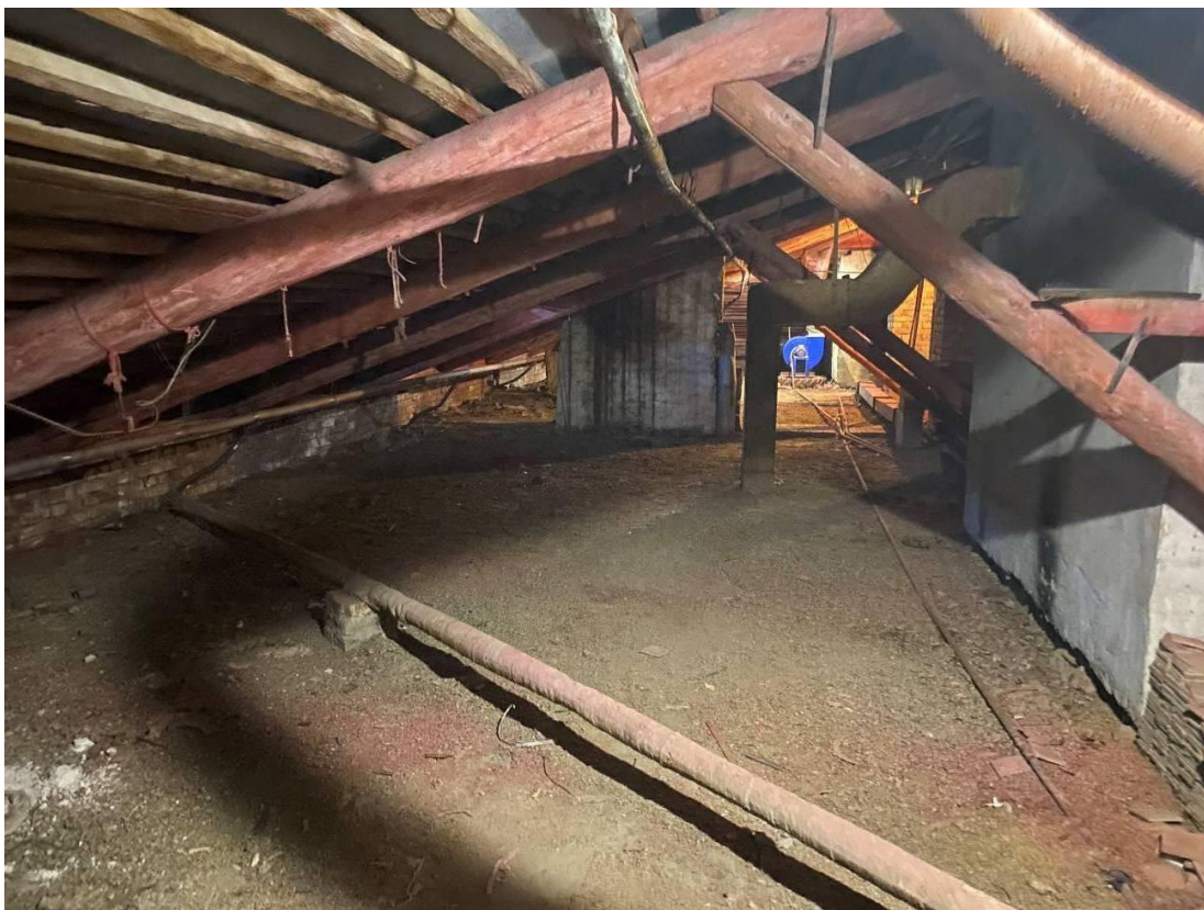
Фото 55. Интерьер чердачного этажа выявленного объекта культурного наследия «Дом для служащих», входящего в состав выявленного объекта культурного наследия «Царскосельская очистная станция (3 здания)»
