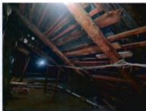
13. Фрагмент стропильной системы. Подпорки под стропилами. (25.09.2023)
