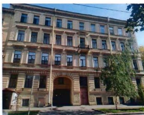
6. Западный фасад объекта культурного наследия. (25.09.2023)
