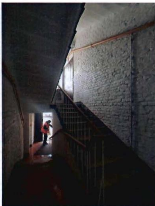
30. Лестничная клетка 2-ЛК. (25.09.2023)
