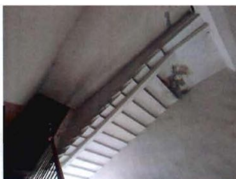
37. Лестничная клетка 4-ЛК. Шелушение и растрескивание окрасочного слоя. Следы протечек. (25.09.2023)
