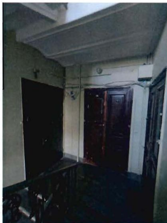
20. Лестничная клетка 1-ЛК. (25.09.2023)
