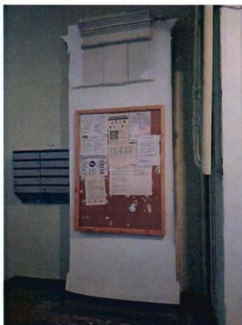
15. Печка vestibюля 1-ЛК (парадная в которой расположены квартиры с 9 по 17). Утрата большей части изразцов. (25.09.2023)
