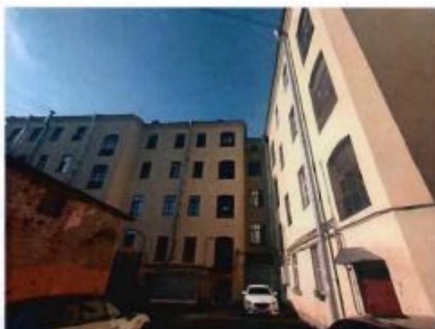
9. Дворовые фасады объекта культурного наследия. (25.09.2023)
