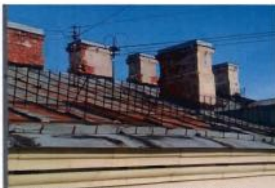
12. Фрагмент кровли. Коррозия металла. Деструкция отделочных слоев воздуховодов. (25.09.2023)
