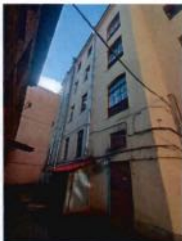
10. Фрагмент дворового фасада. (25.09.2023)
