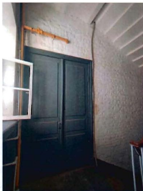
31. Лестничная клетка 2-ЛК. (25.09.2023)
