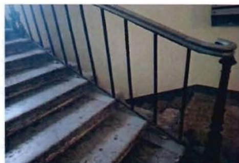
17. Лестничная клетка 1-ЛК. (25.09.2023)
