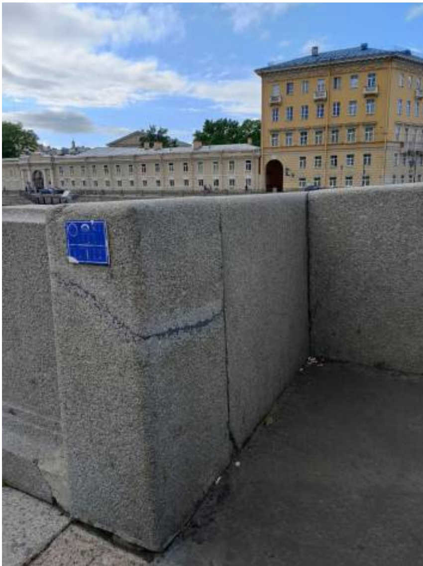
18. Низовой левобережный (юго-западный) открылок. Сквозная трещина в блоке парапета (зачеканена).
