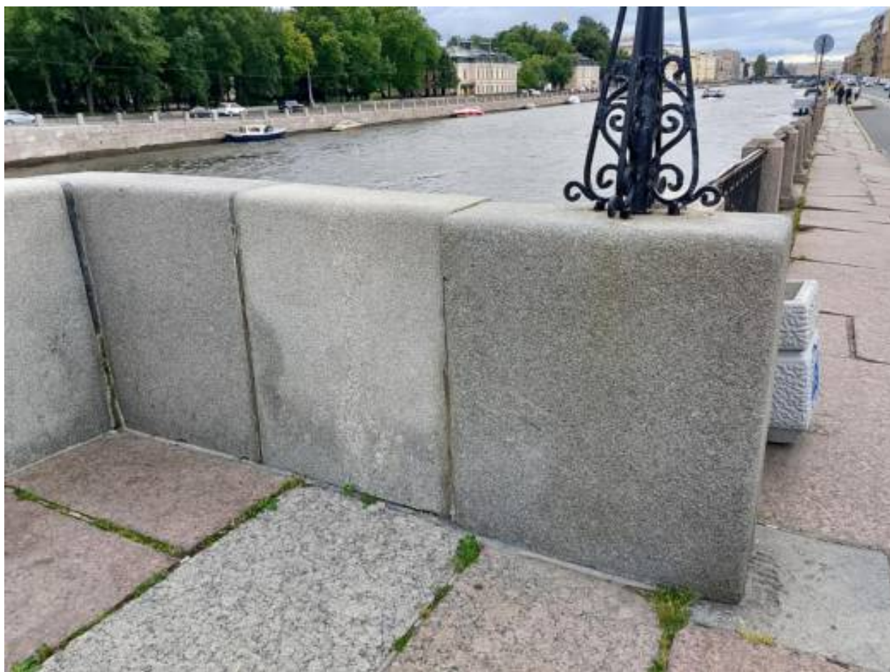
35. Правобережный спуск. Отклонение парапетного блока от проектного положения, произрастание самосеивной растительности в облицовке площадки.
