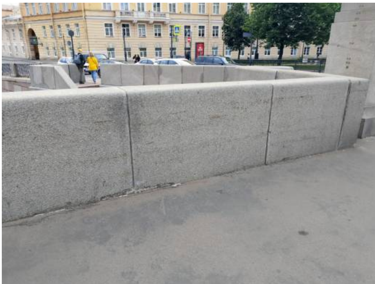
28. Низовая сторона моста. Общее загрязнение парапетных блоков.
