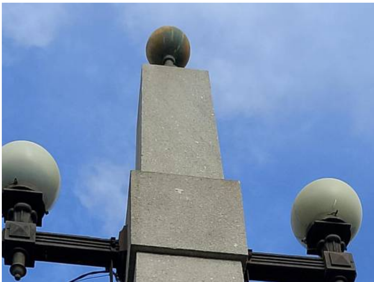
4. Северо-восточный фонарь: утраты покрытия шаровидного навершия.
