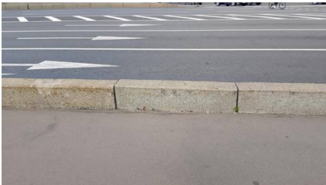
24. Низовая сторона. Сколы, загрязнение, выход из проектного положения бордюрных камней.
