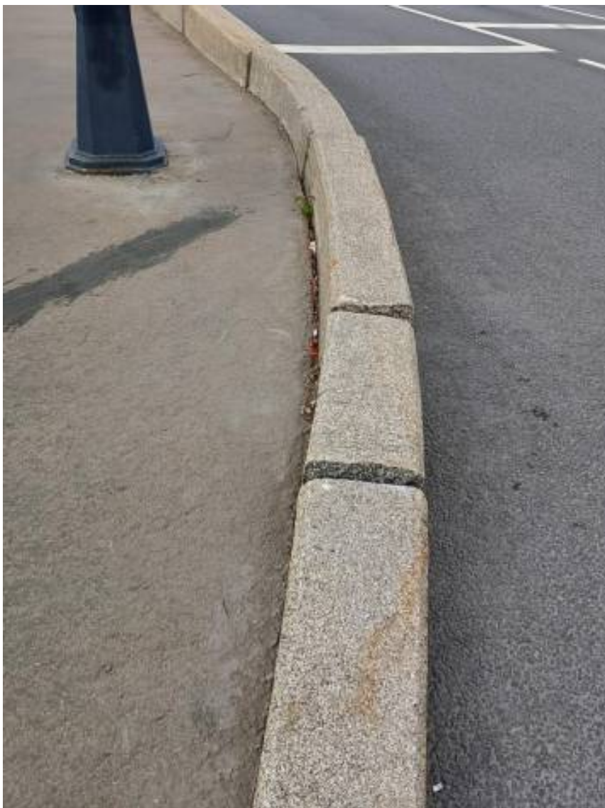
20. Низовая сторона моста, отклонение бордюрного камня от проектного положения, загрязнение.
