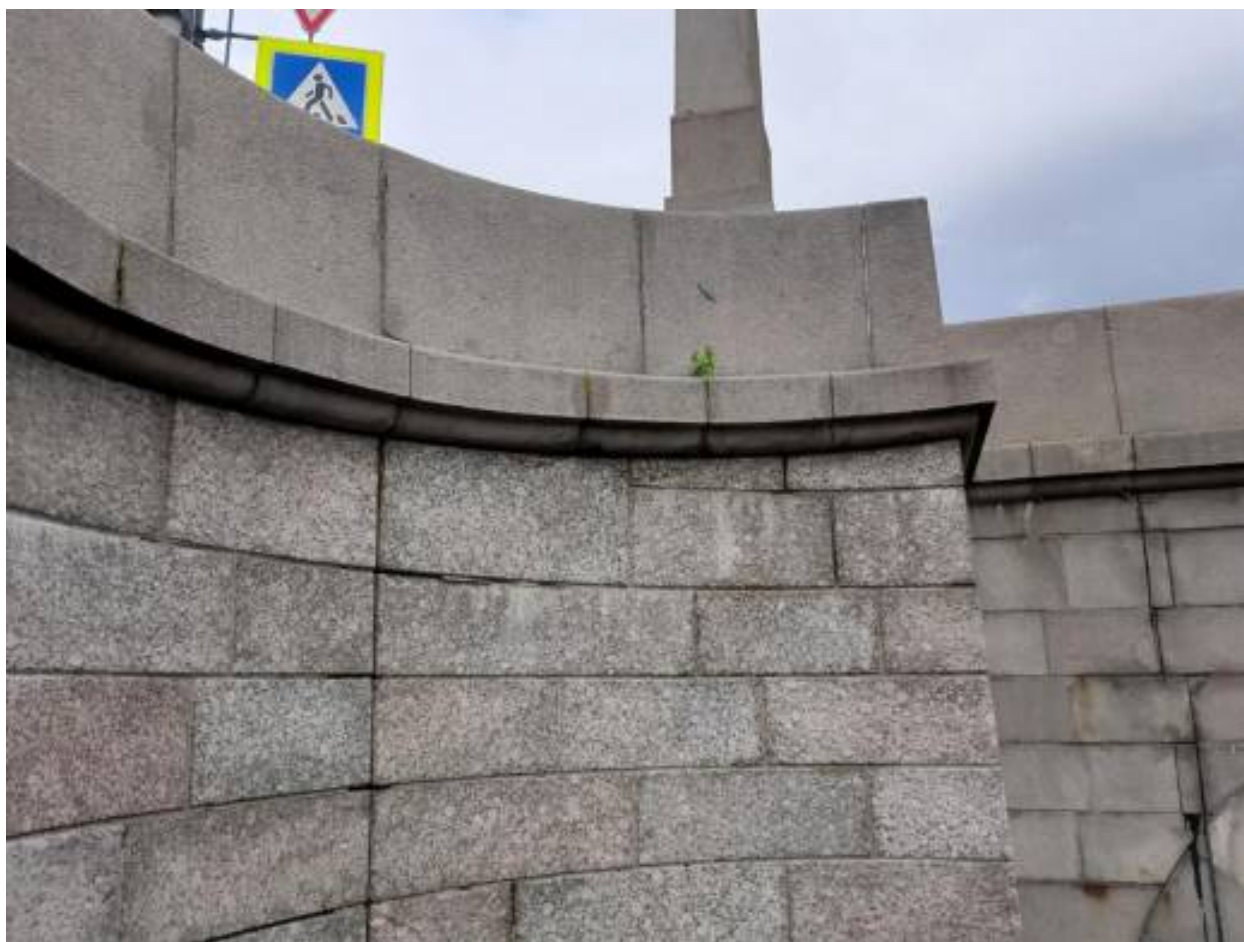
39. Правобережный спуск. Облицовка стенки спуска, следы намокания и произрастание самосевной растительности на карнизном камне.
