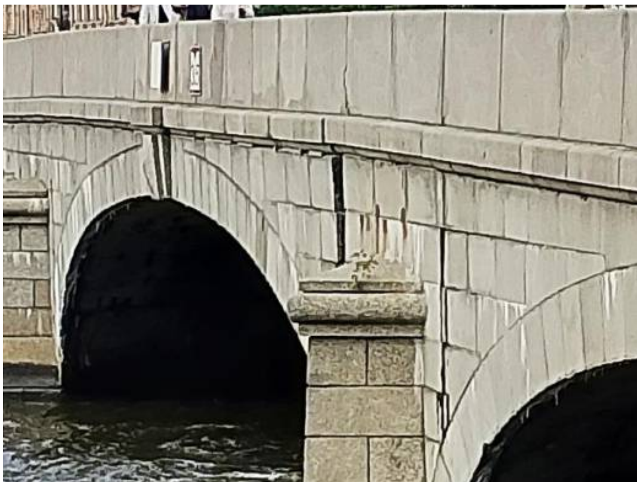
23. Низовая сторона моста. Отслоение облицовки в зоне деформационного шва.
