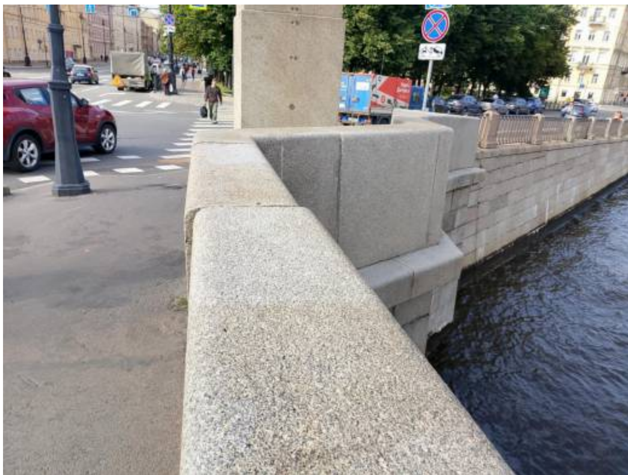
5. Верховая сторона: смещение блоков парапета.
