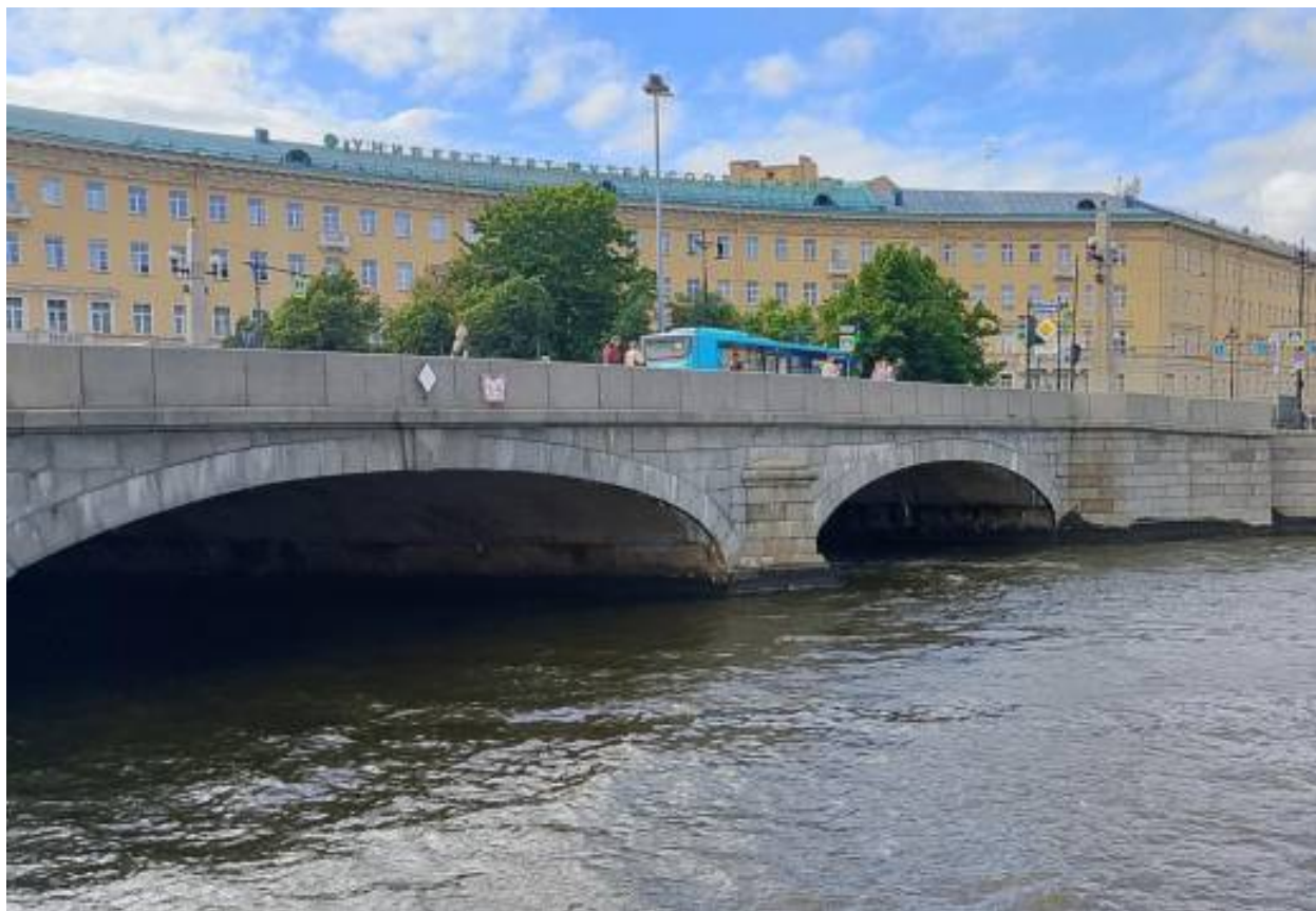
17. Центральный и северный пролёт верховой стороны. Высолы и загрязнение на облицовке, сильное загрязнение и биопоражение по границе с уровнем воды.
