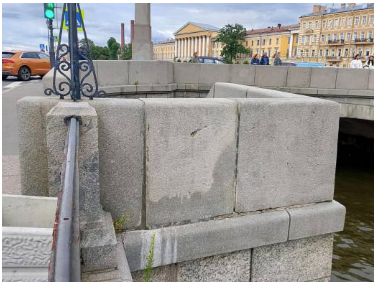
34. Правобережный спуск. Сколы и загрязнение на парапетных блоках, утраты шовного заполнения.
