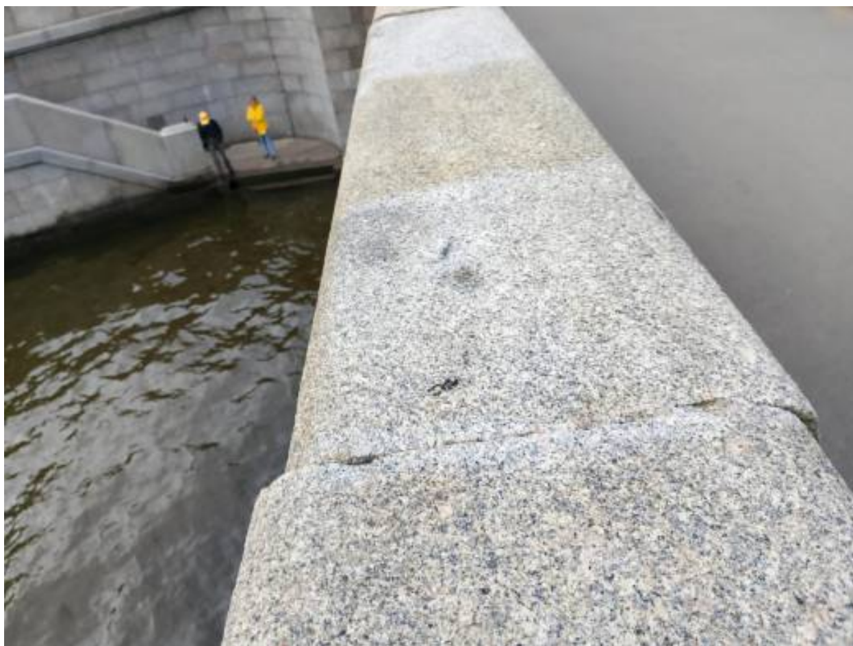
27. Низовая сторона моста. Смещение, сколы на гранях и поверхности, загрязнение блоков парапета.
