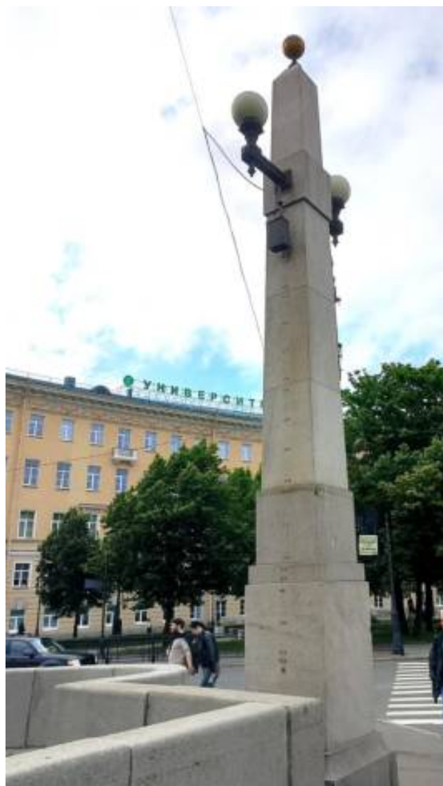
29. Северо-западный фонарный столб (обелиск). Отверстия от монтажа электросетей, общее загрязнение.
