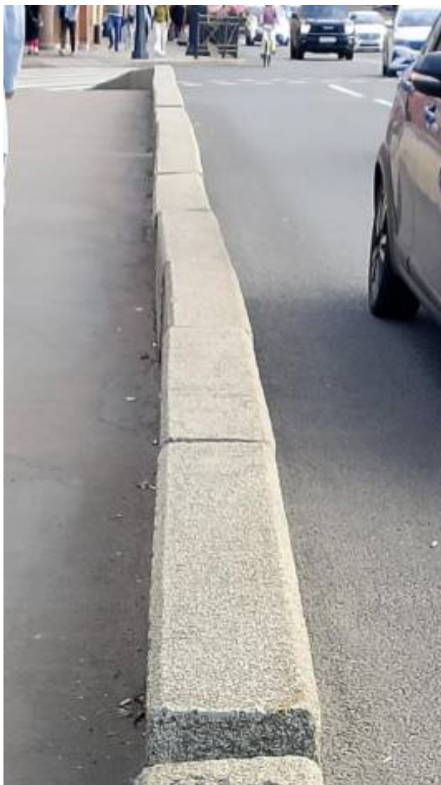
8. Выход бордюрных камней из проектного положения.
