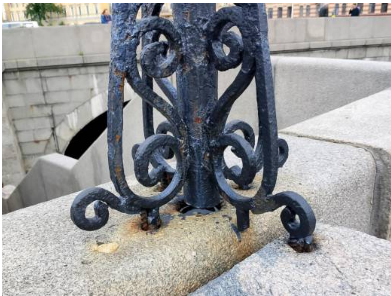
38. Правобережная информационная стойка. Многослойное окрашивание, коррозия арматуры в местах утраты красочного слоя, следы краски на парапетном блоке.
