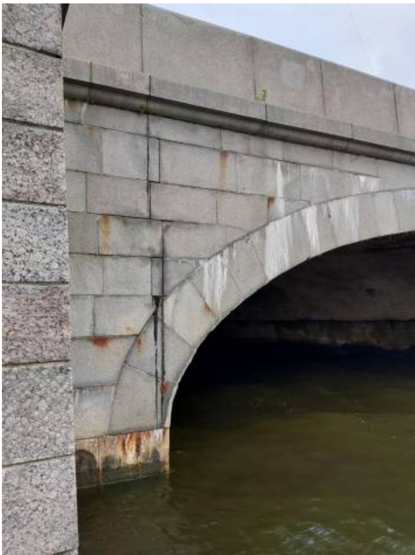
41. Низовая сторона моста. Потечи ржавчины и битума на облицовке правобережного устоя.
