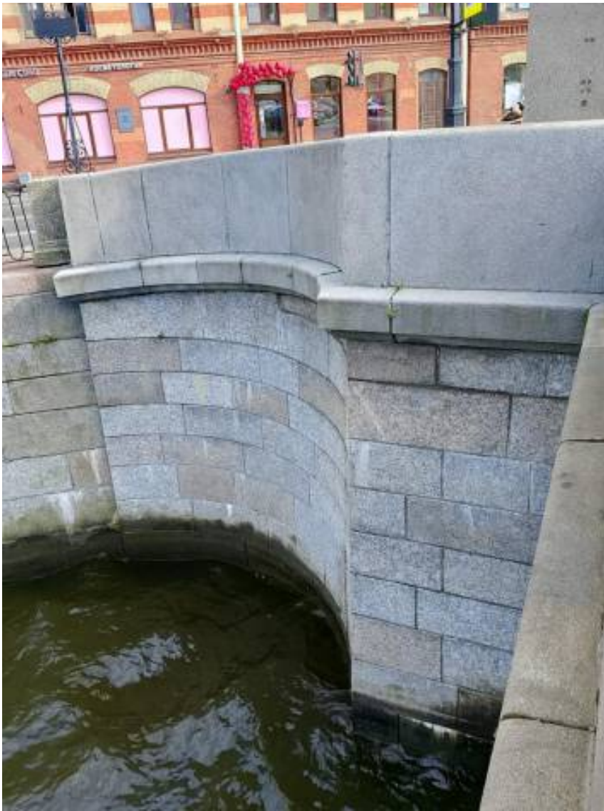
12. Верховой левобережный открылок: загрязнения по границе с уровнем воды, высолы на облицовке, самосевная растительность на карнизном камне.
