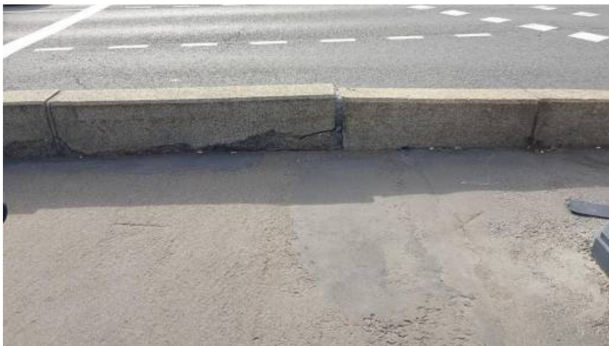
6. Верховая сторона: выход блоков бордюрного камня из проектного положения, сколы и трещины.
