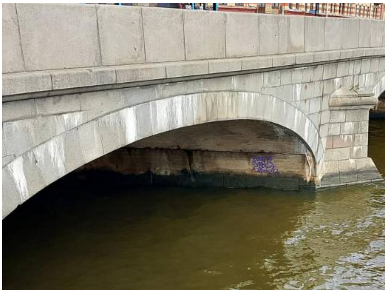
33. Низовая сторона моста. Северный (правобережный) пролёт. Высолы на облицовке и сводах, потёки ржавчины (следы коррозии арматуры) на сводах, химическое и биозагрязнение.
