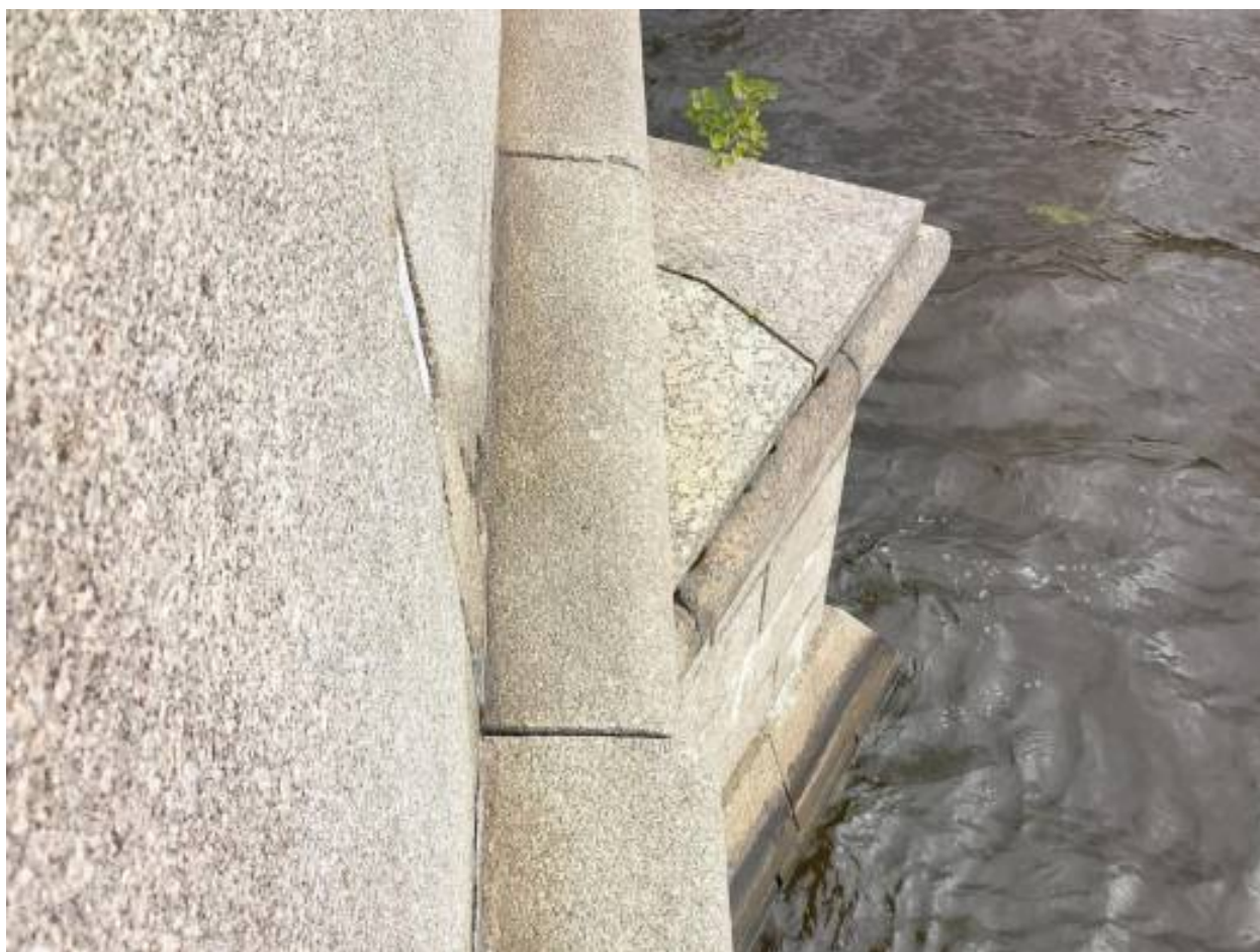
26. Низовая сторона моста. Южный ледорез. Сильное загрязнение по границе с уровнем воды; произрастание самосевной растительности на крышке.
