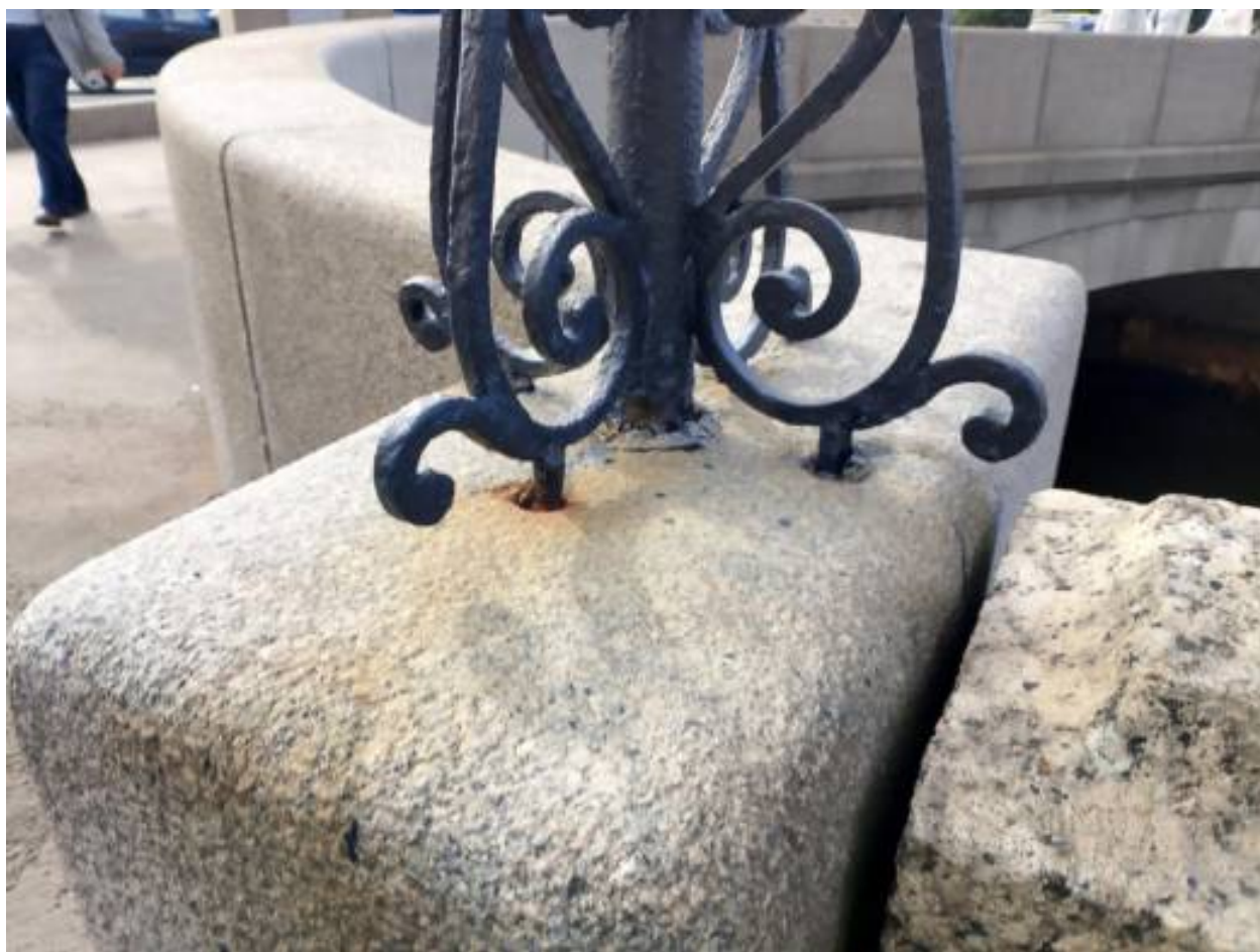
14. Южная информационная стойка: многослойное окрашивание, утраты окрасочного слоя.
