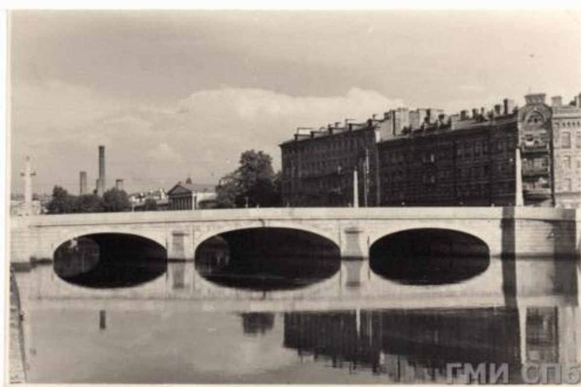
38. Обуховский мост. Автор фото: Тумилович Е. В. 1946 г. ГМИ СПб. Инв.№-II-Б-3974 ф. Эл. доступ: https://goskatalog.ru/portal/#/collections?id=61551968
