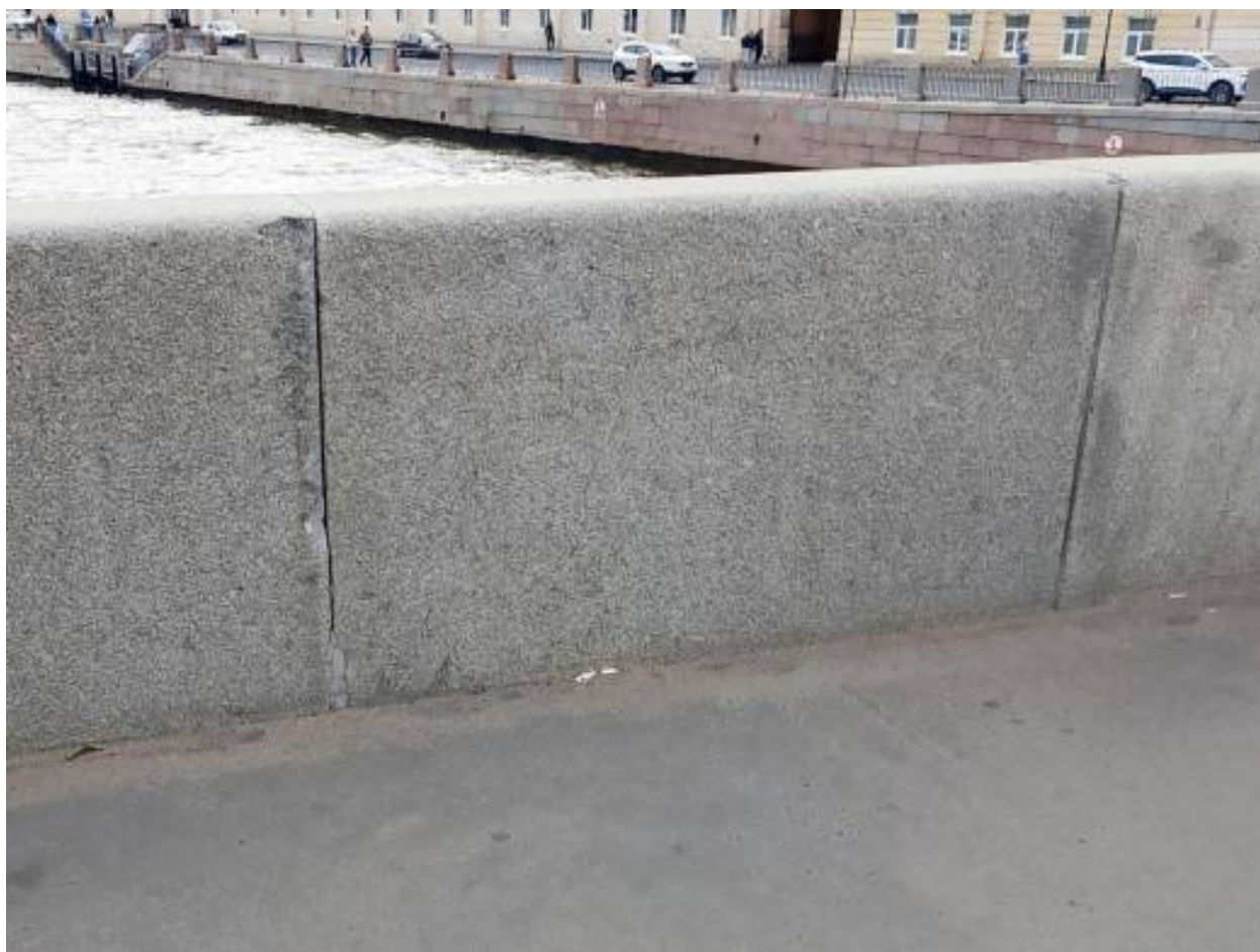
25. Низовая сторона моста. Общее загрязнение, сколы по грани блоков парапета.
