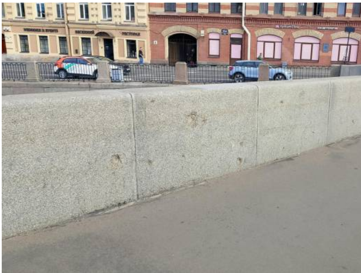
10. Сколы и загрязнение блоков парапета.
