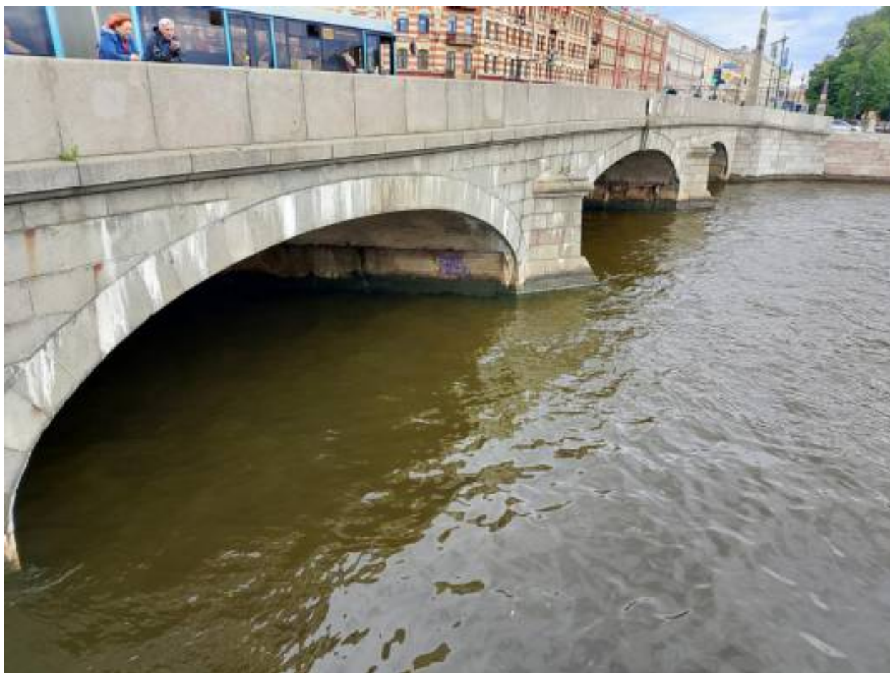
32. Низовая сторона моста. Общий вид с северо-запада. Загрязнение облицовки, произрастание самосевной растительности.
