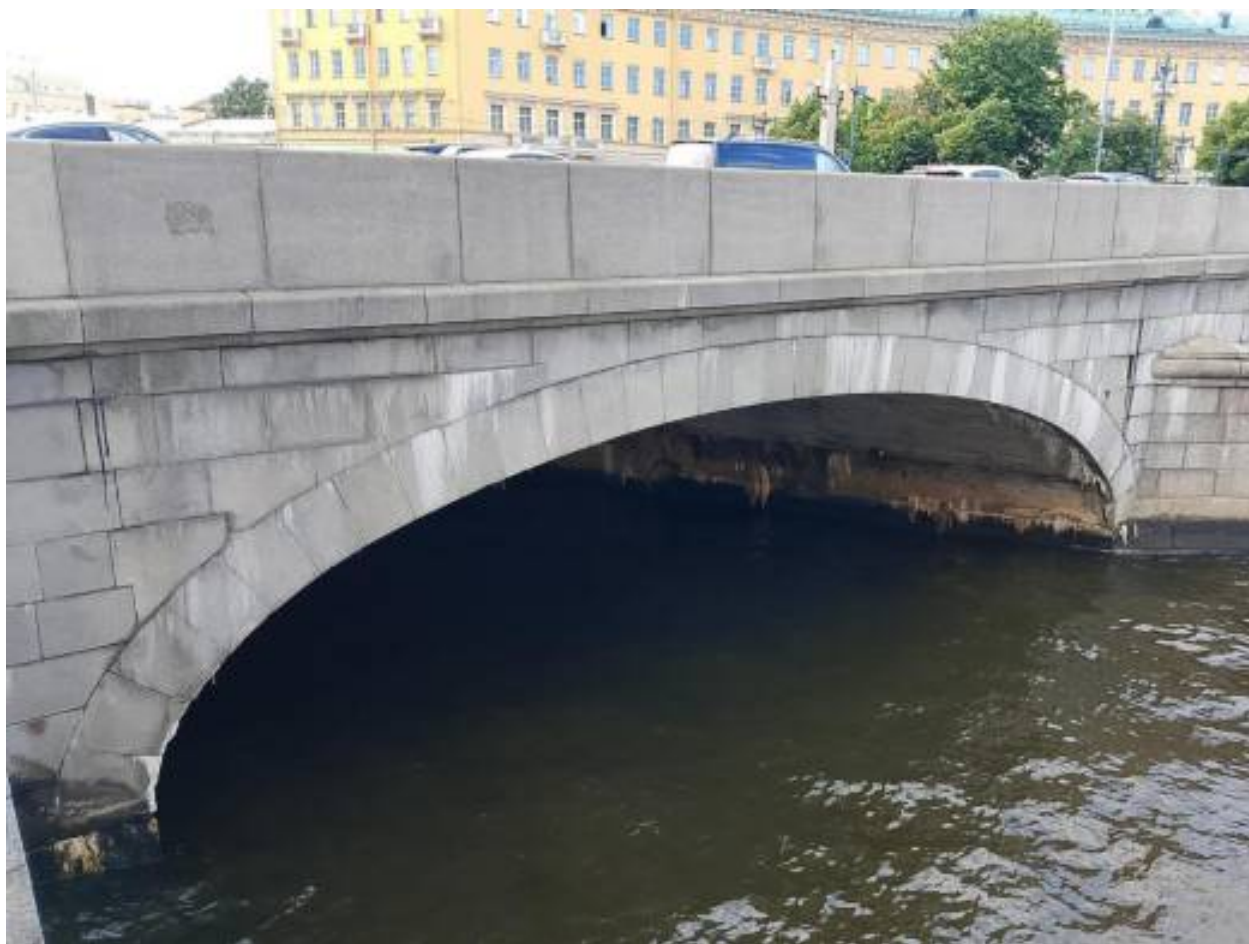
15. Южный пролёт верховой стороны. Высолы на облицовке и своде, сильное загрязнение и биопоражение по границе с уровнем воды.
