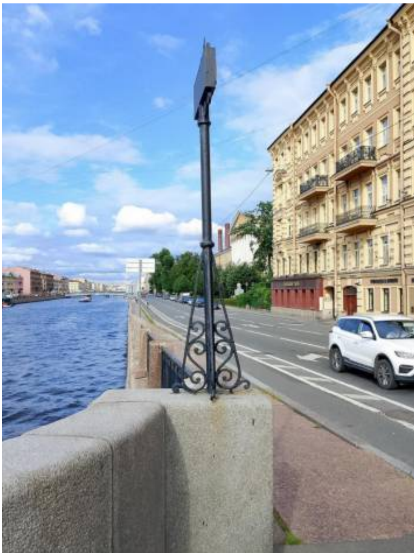
13. Потёки ржавчины и чёрной краски на парапетном блоке под информационной стойкой.
