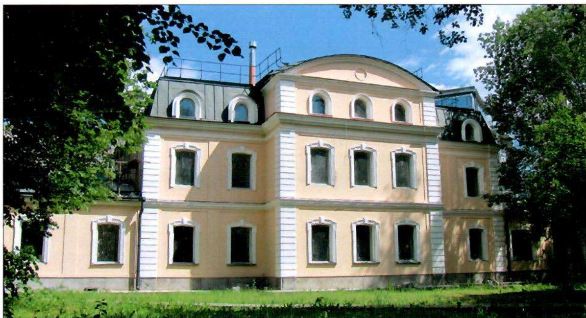
1. «Главный корпус хозяйственного двора». Общий вид с запада.
