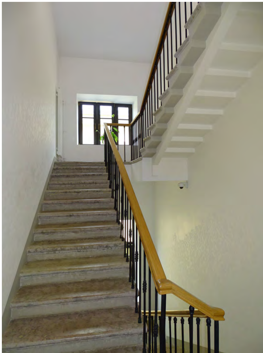
13. Лестница Л-2. 3-й этаж. Съемка 04.05.2026 г. Трушковский В.Э.
