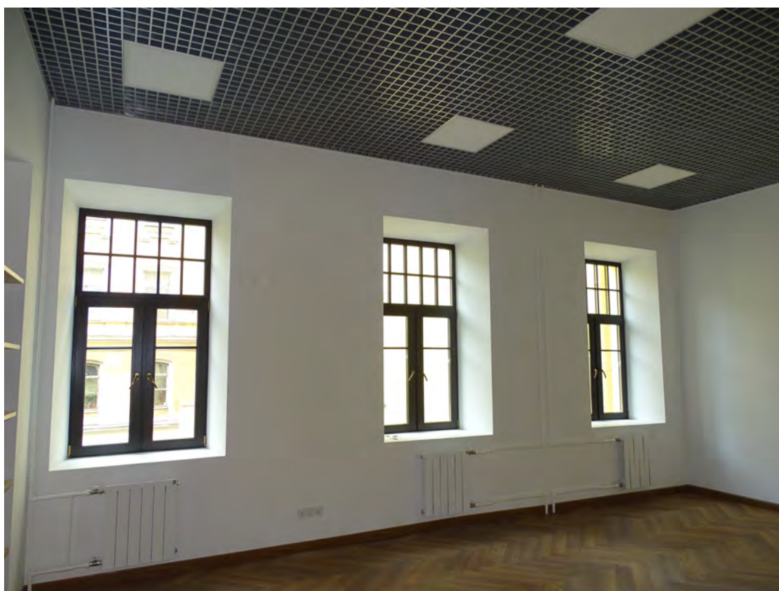
28. 2-й этаж. Пом. 2/23,0; 7/12,8. Съемка 04.05.2026 г. Трушковский В.Э.
