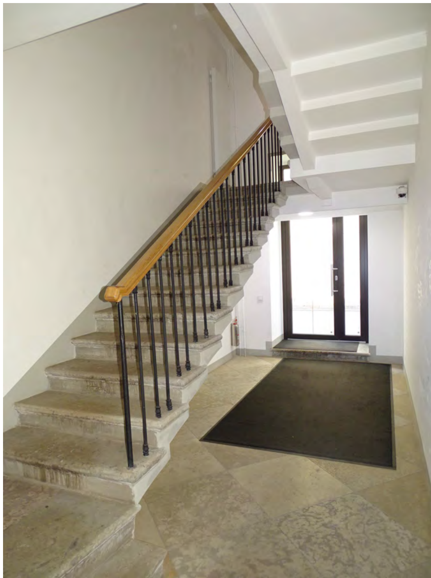
01. 1-й этаж. Лестница Л-2. Съемка 04.05.2026 г. Трушковский В.Э.
