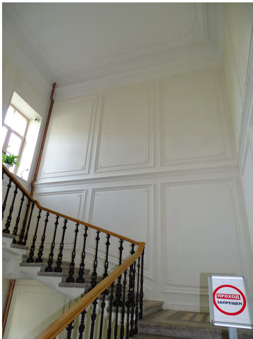
18. Лестница Л-1. Вид с междуэтажной площадки между 2-м и 3-м этажом. Съемка 04.05.2026 г. Трушковский В.Э.
