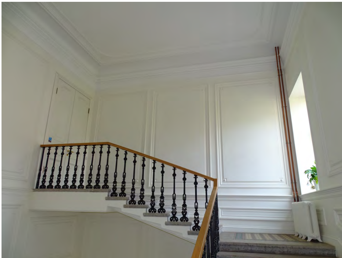
20. Лестница Л-1. Вид на площадку 3-го этажа. Съемка 04.05.2026 г. Трушковский В.Э.
