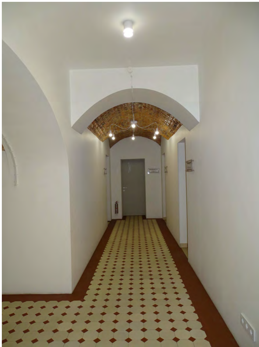
04. 1-й этаж. Пом. 12/7,8. Съемка 04.05.2026 г. Трушковский В.Э.
