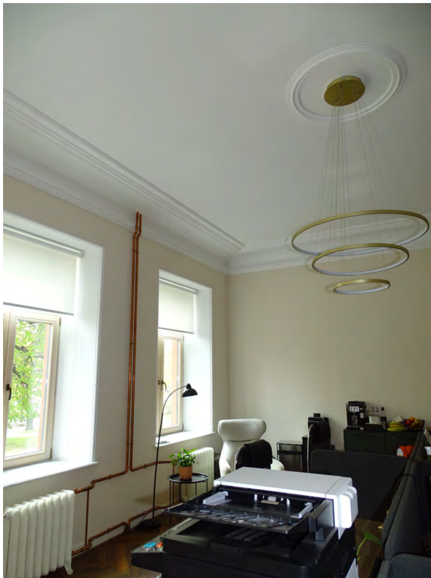
24. 2-й этаж. Пом. 10/10,4; 11/12,8; 12/13,8. Съемка 04.05.2026 г. Трушковский В.Э.
