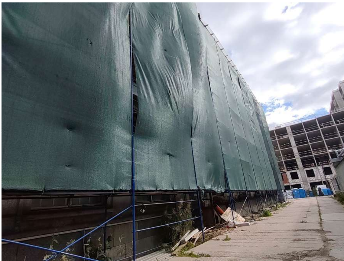
4. Вид с юго-запада
