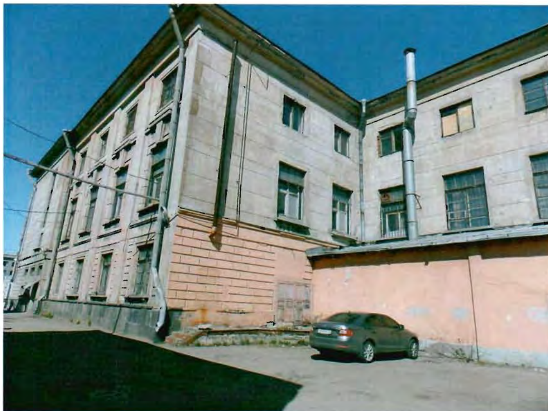
Фото 7. Часть южного и восточного фасада.
