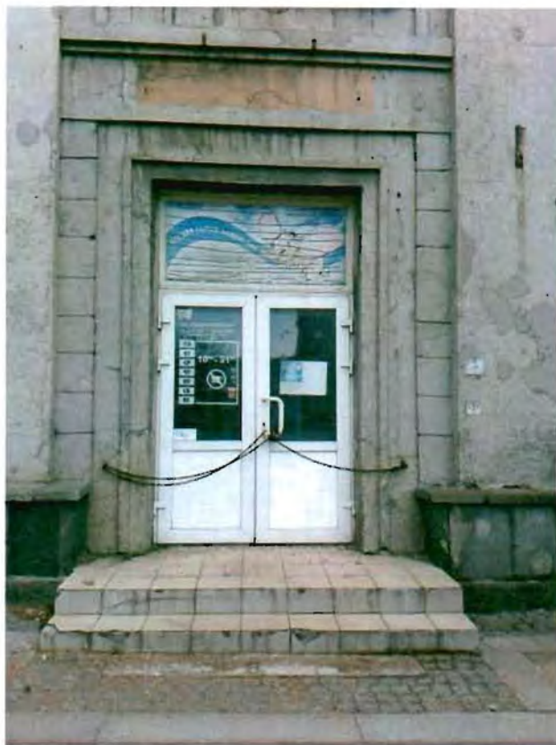
Фото 4. Дверной проем западного фасада.
