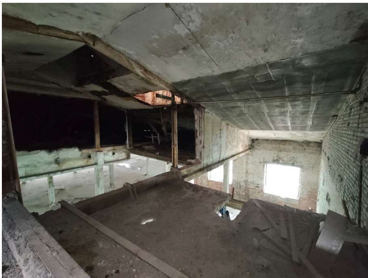
58. Фрагмент интерьера чердака
