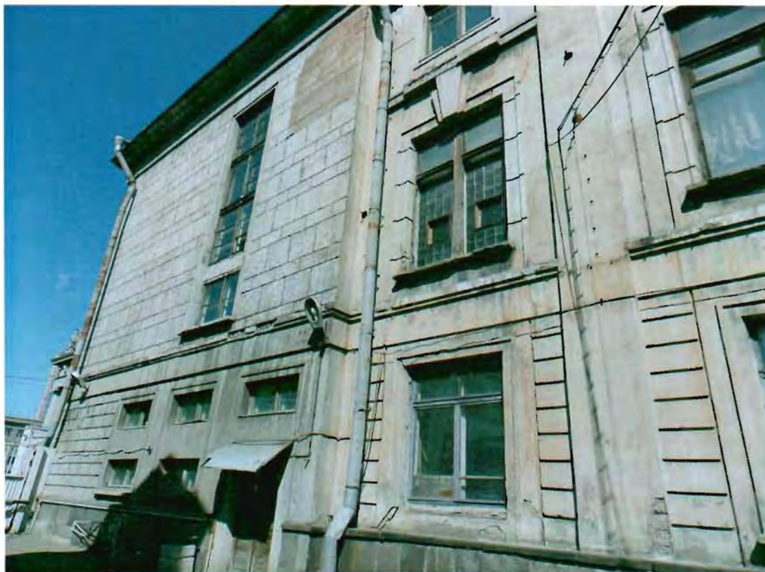
Фото 8. Часть южного фасада.
