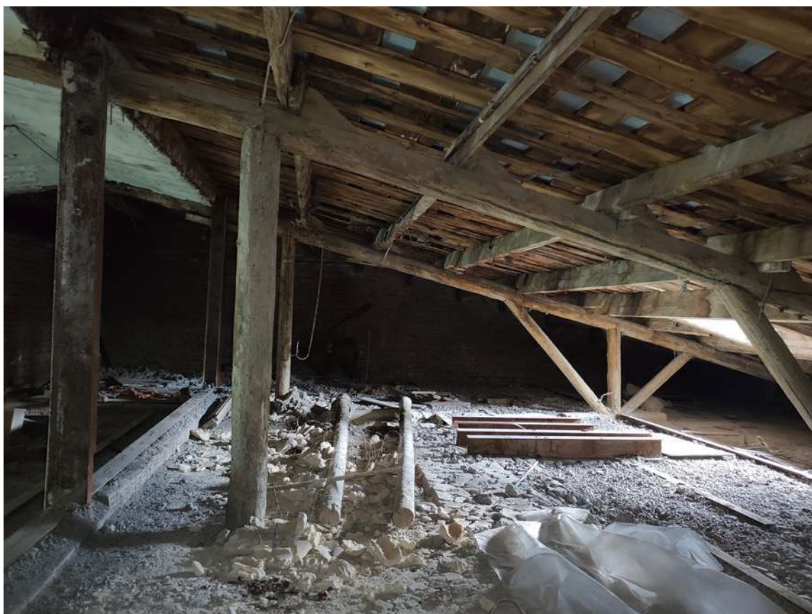
60. Фрагмент интерьера чердака
