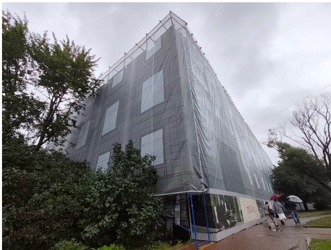
14. Вид с северо-запада
