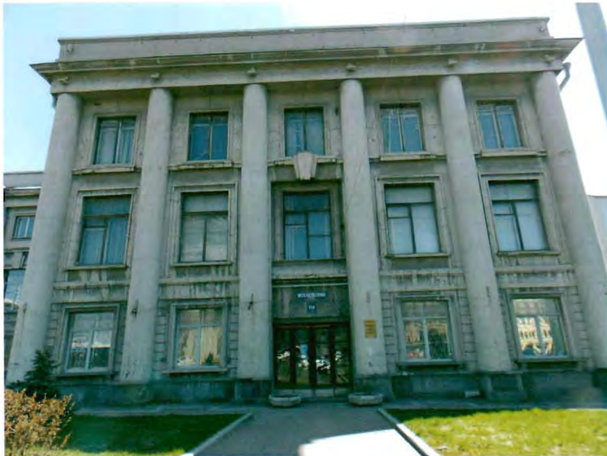
Фото 1. Фрагмент западного фасада.
