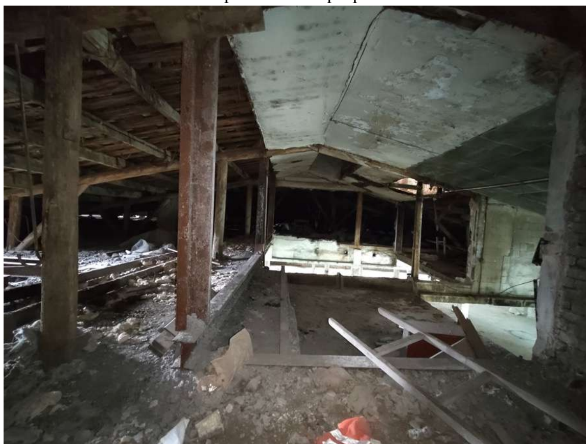
57. Фрагмент интерьера чердака
