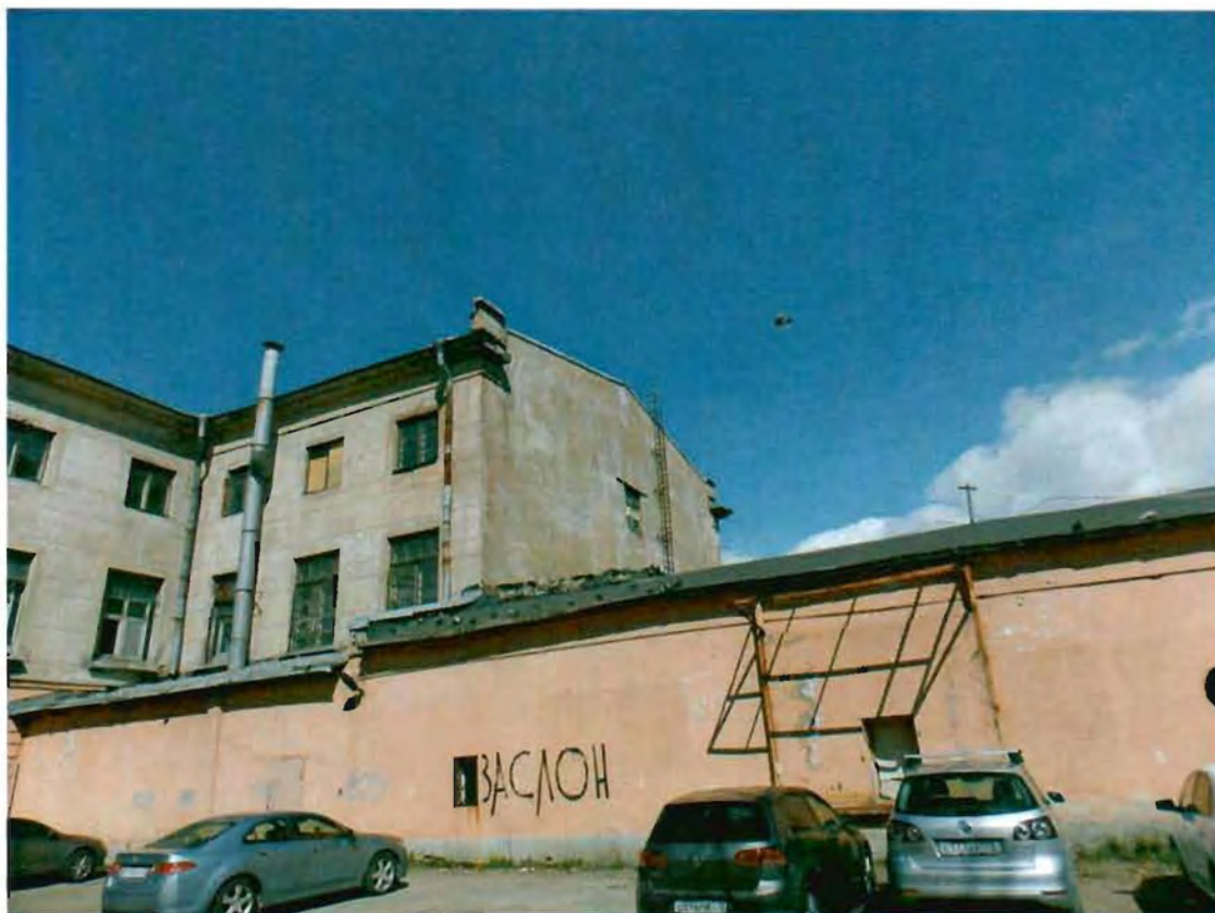
Фото 9. Часть южного и восточного фасада.
