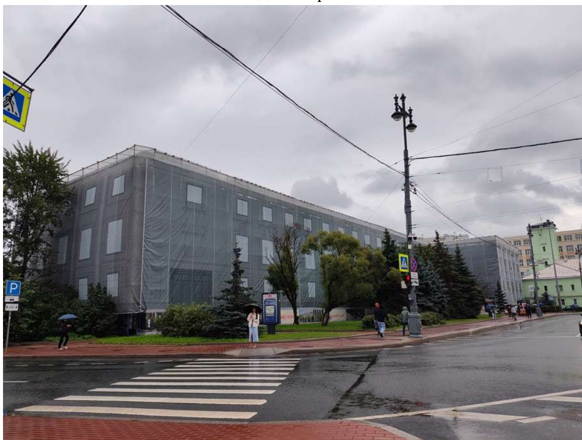
16. Вид с северо-запада
