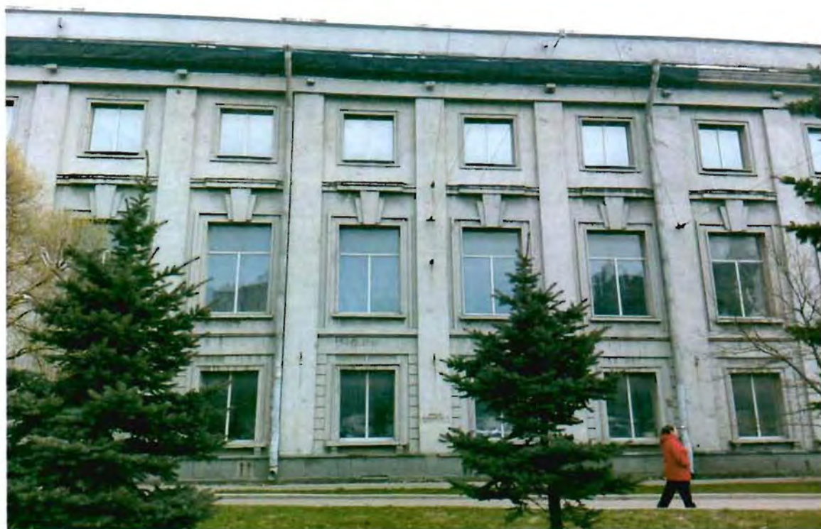
Фото 6. Фрагмент западного фасада.
