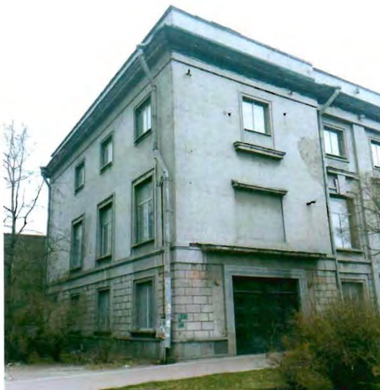
Фото 3. Часть западного и северного фасада.
