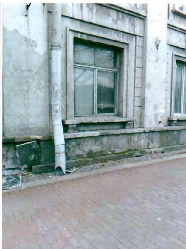
Фото 5. Фрагмент западного фасада.
