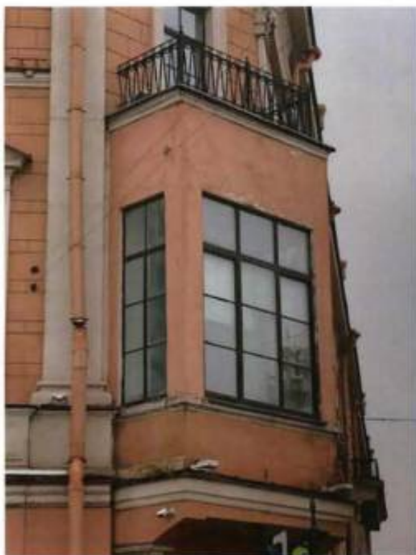
11. Фрагмент северного фасада объекта культурного наследия. Эркер второго этажа. Фото выполнено 15.03.2024
