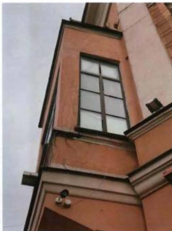
12. Эркер второго этажа. Вид со стороны западного фасада объекта культурного наследия. Фото выполнено 15.03.2024
