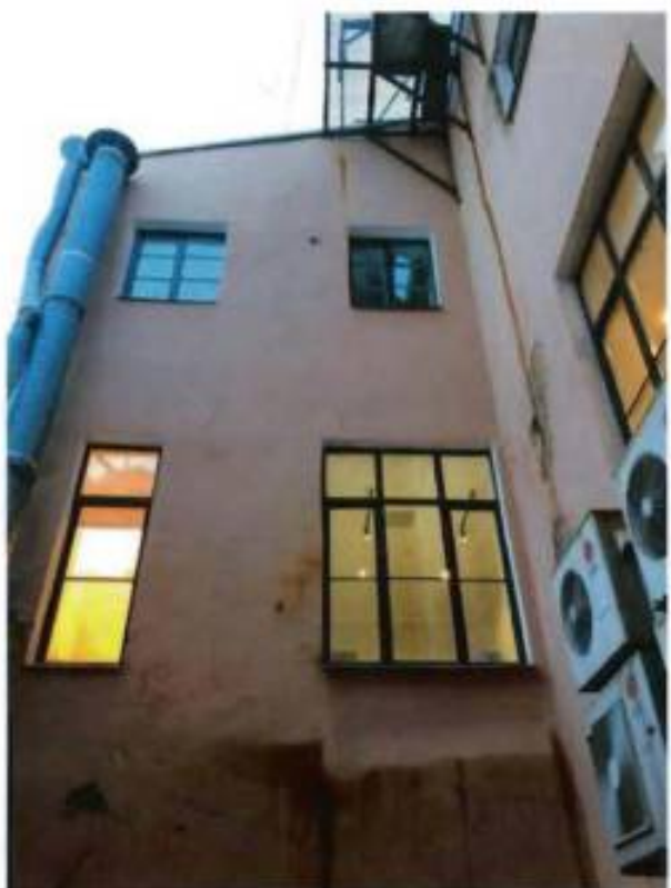
23. Фрагмент южного фасада, расположенного в световом кармане в северной части объекта культурного наследия. Фото выполнено 26.12.2023
