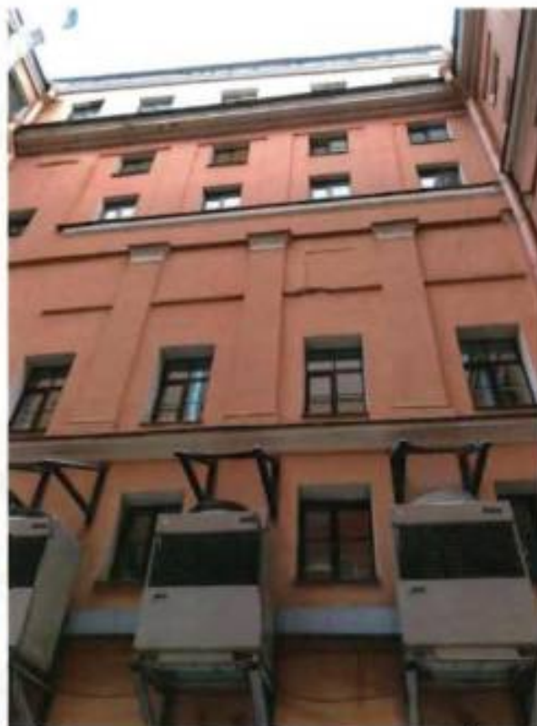
18. Фрагмент восточного дворового фасада объекта культурного наследия.
