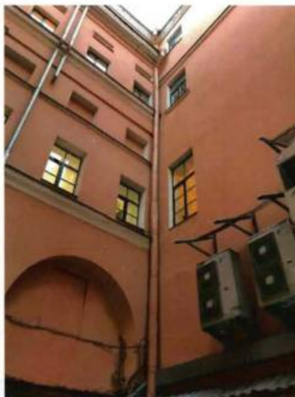
20. Фрагмент западного дворового фасада объекта культурного наследия.
