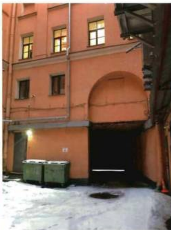
16. Фрагмент южного дворового фасада объекта культурного наследия. Фото выполнено 26.12.2023
