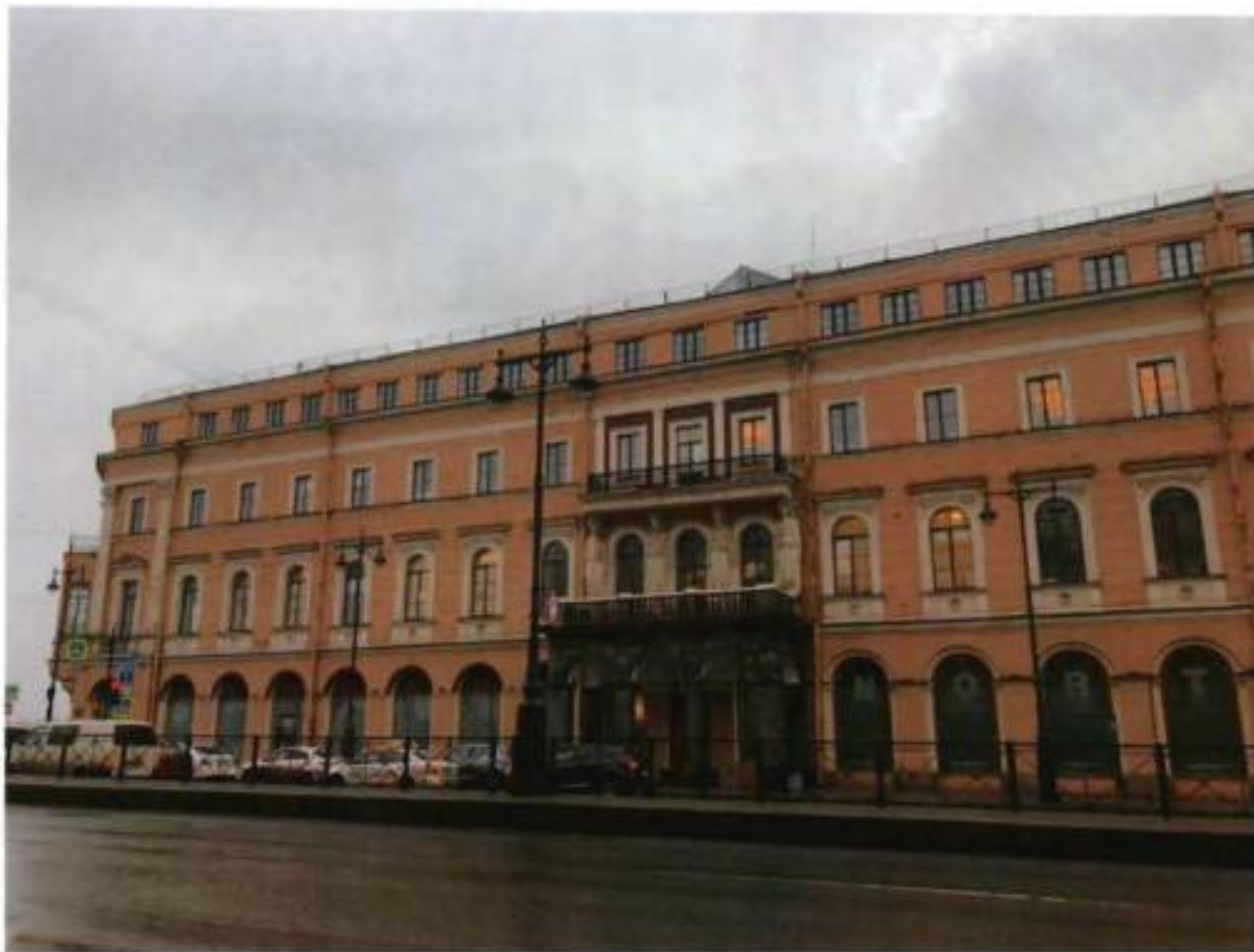
2. Западный фасад объекта культурного наследия. Фото выполнено 15.03.2024
