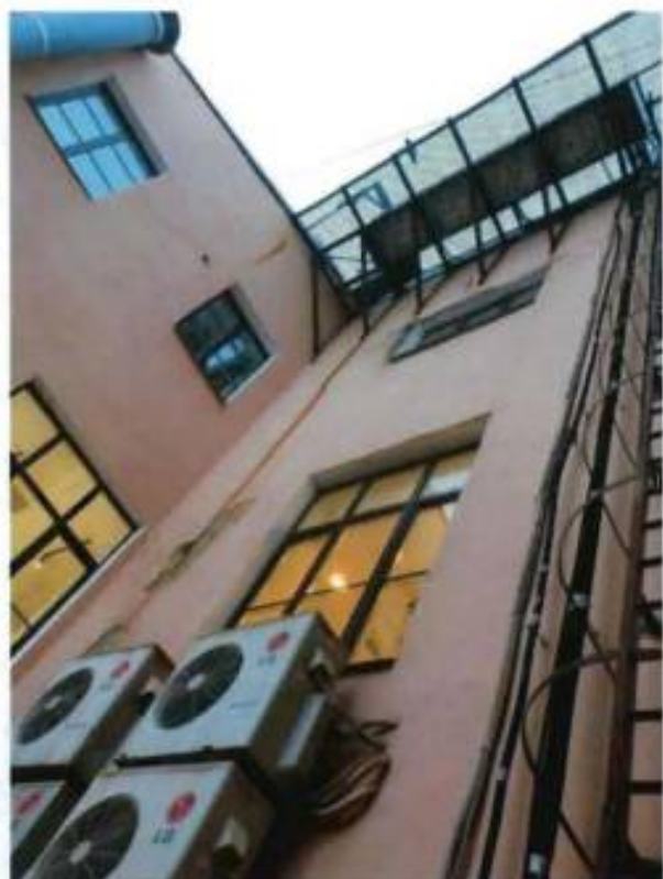
24. Фрагмент западного фасада, расположенного в световом кармане в северной части объекта культурного наследия. Фото выполнено 26.12.2023
