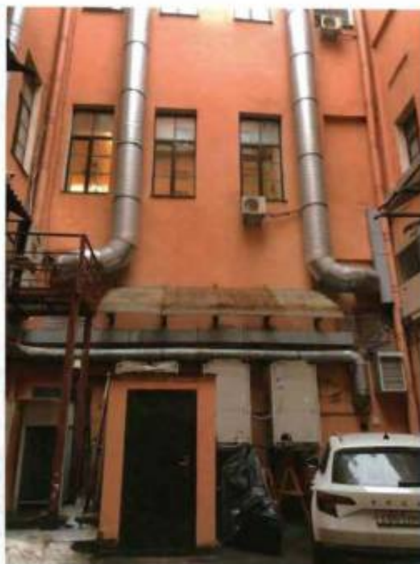
14. Фрагмент северного дворового фасада объекта культурного наследия. Фото выполнено 15.03.2024
