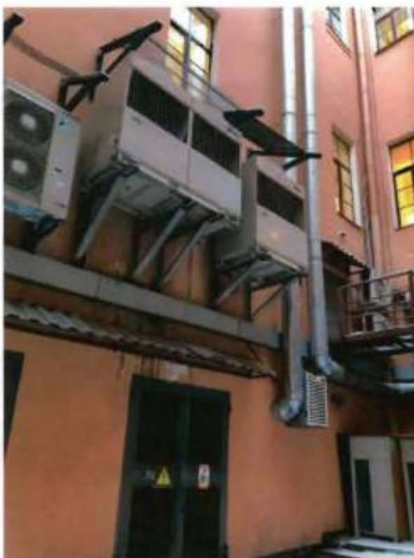
19. Фрагмент западного дворового фасада объекта культурного наследия.
