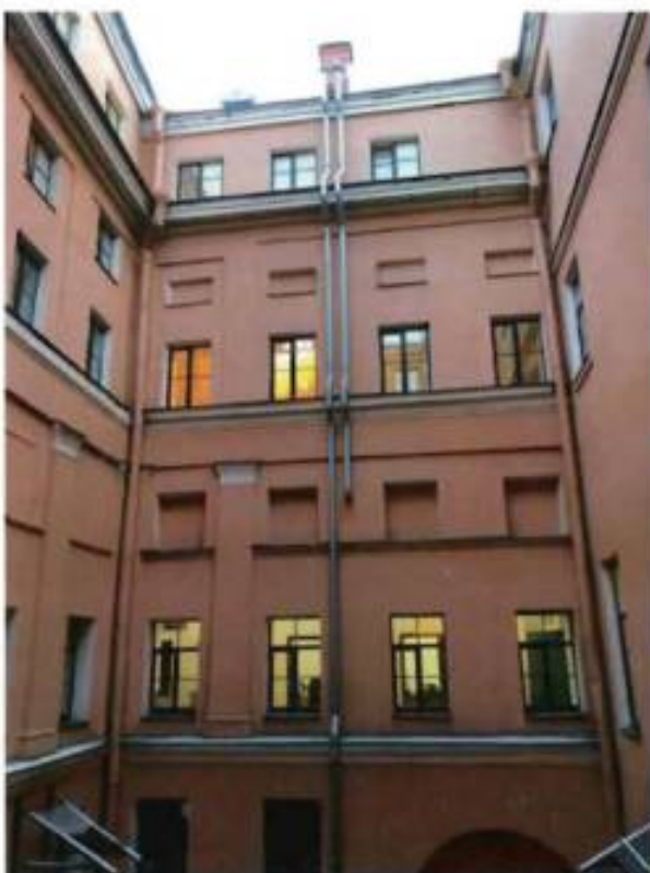
15. Фрагмент южного дворового фасада объекта культурного наследия. Фото выполнено 26.12.2023
