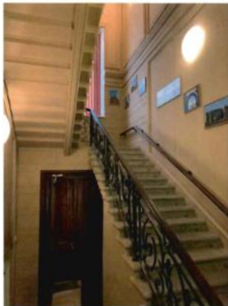
7, 8. Парадная лестница (1-ЛК). Фрагменты.
