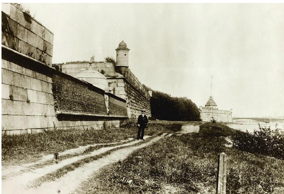
30. Ботардо между Алексеевским рavelином и Трубецким бастионом. Фотография. 1903-1907 гг. https://pastvu.com
