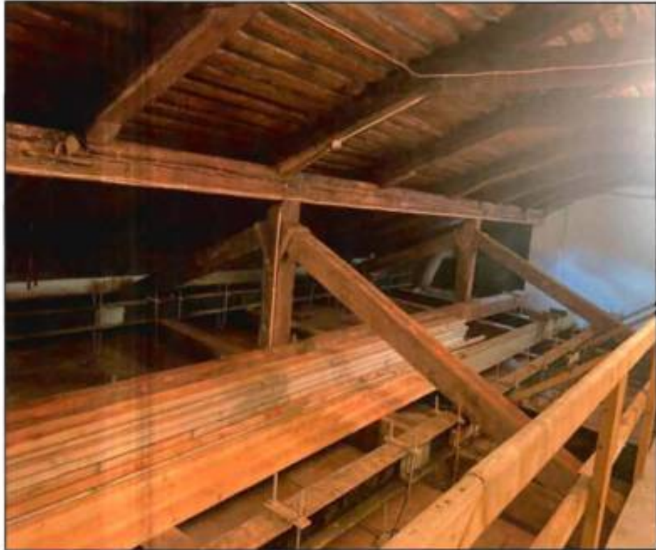
7. Стропильная система.
