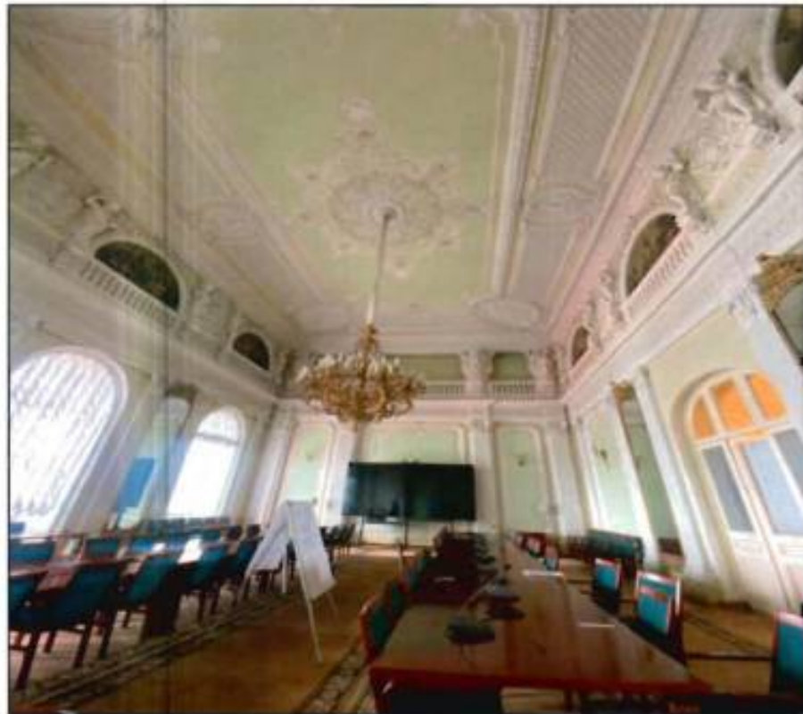
10. Помещение 1-Н(73) с оформлением потолка лепными элементами, розетками, карнизами, фигурными филёнками и поясами.
