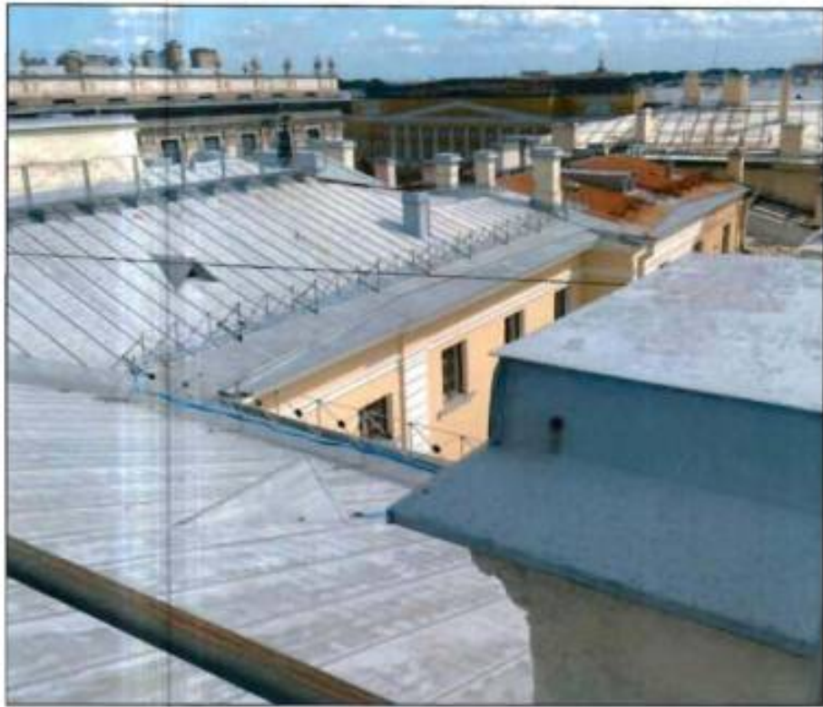
9. Металлическое покрытие кровли.
