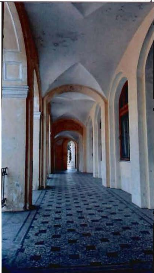
4. Фрагмент обходной галереи со стороны лицевого фасада
