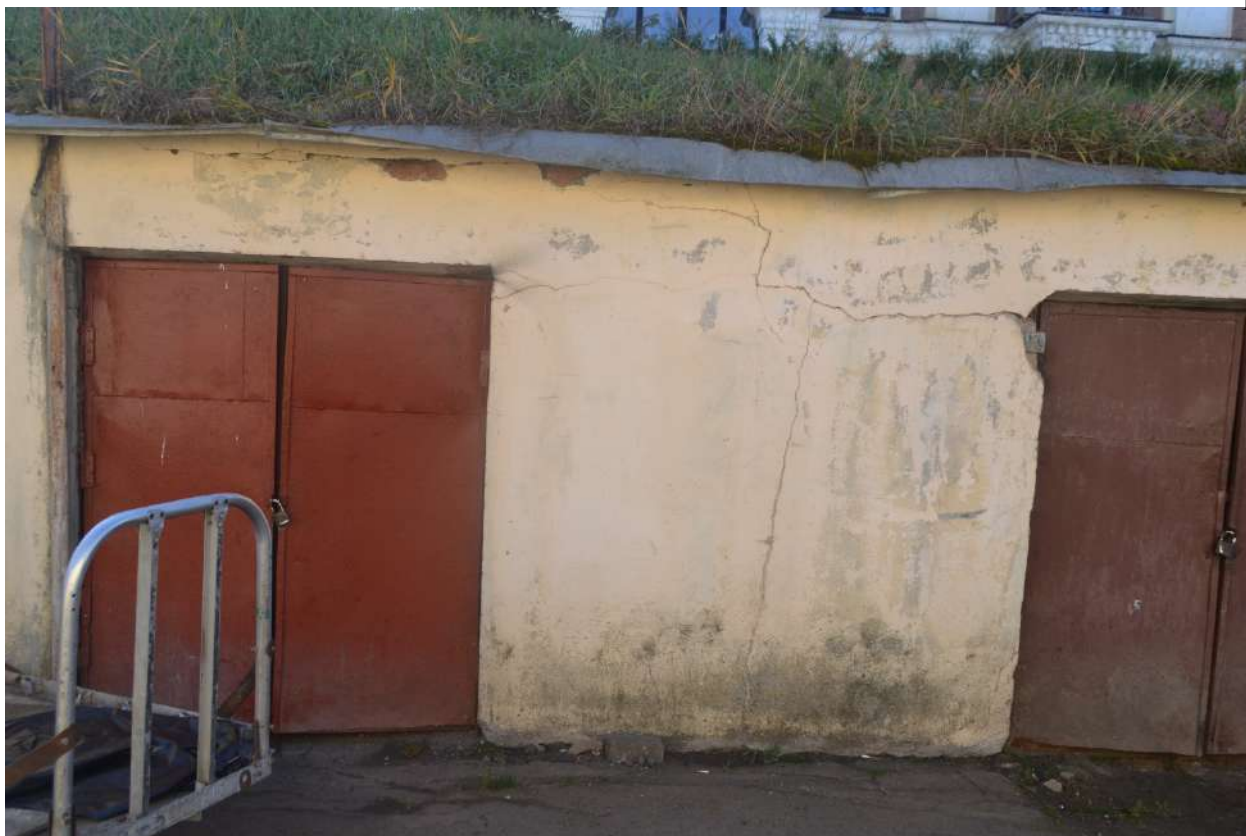
Фото 7. Общий вид на объект.
