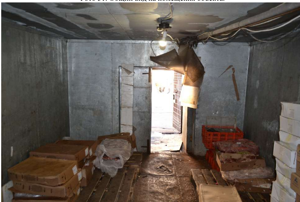
Фото 52. Общий вид на помещения объекта.
