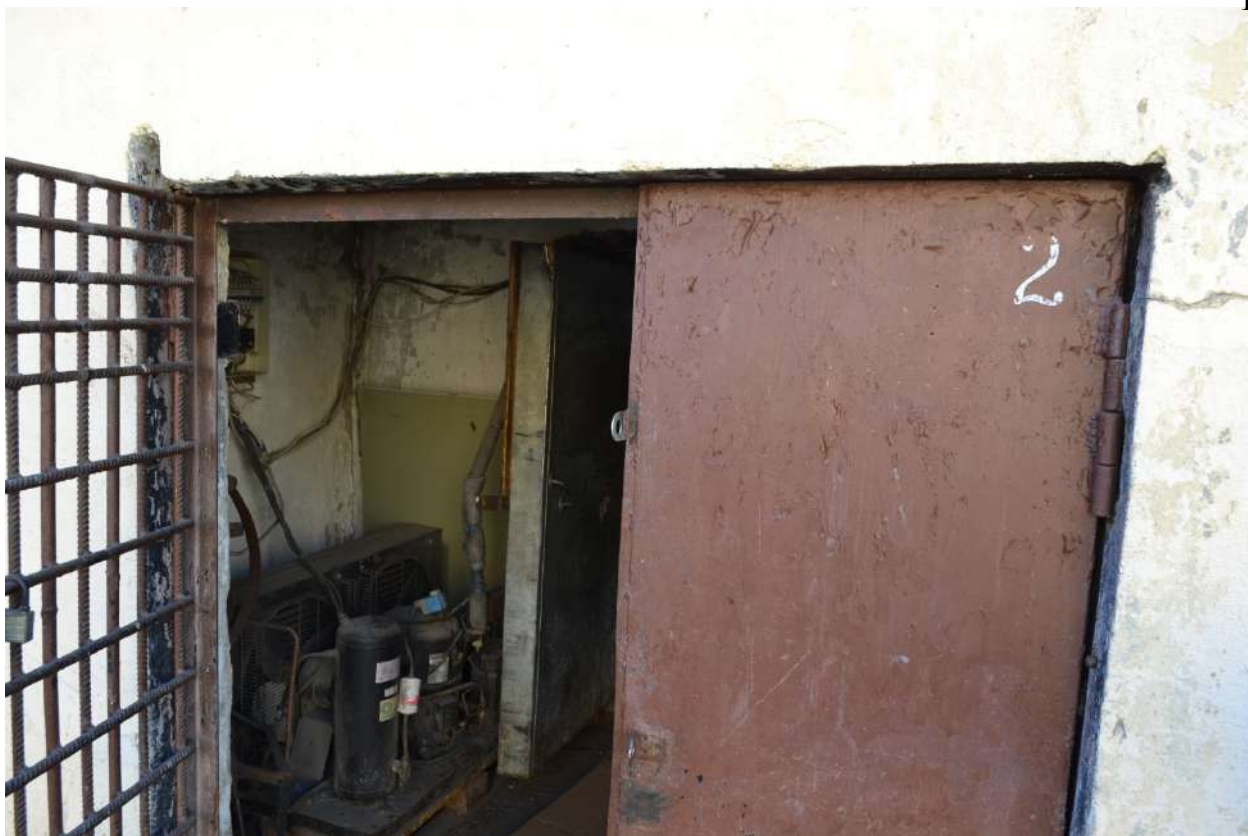
Фото 45. Общий вид на помещения объекта.
