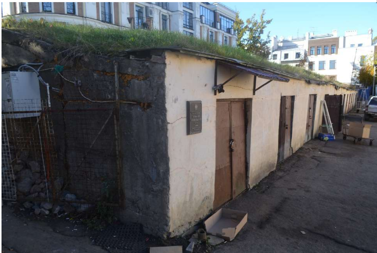
Фото 1. Общий вид на объект.
