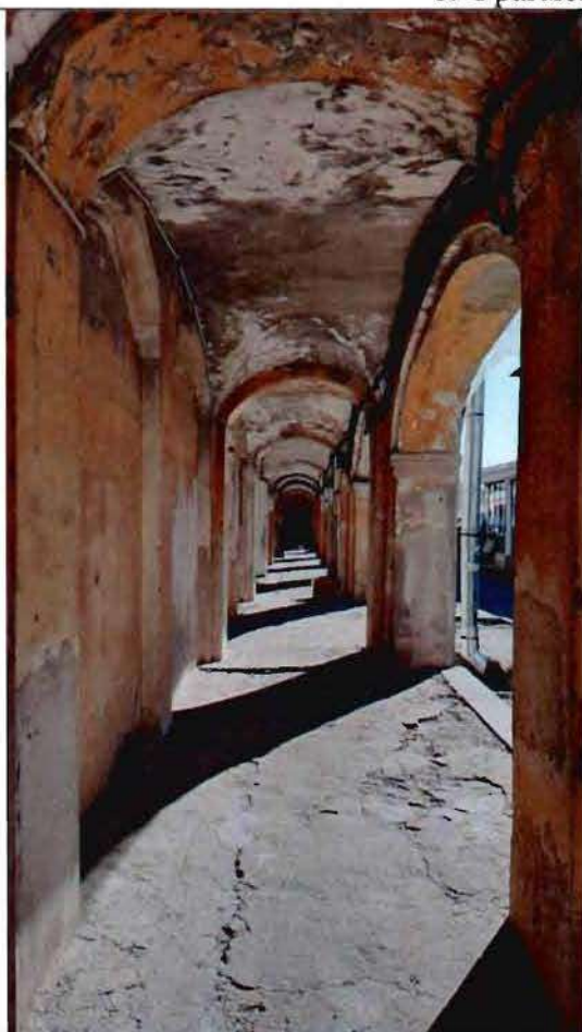
7. Фрагмент обходной галереи со стороны дворового фасада
