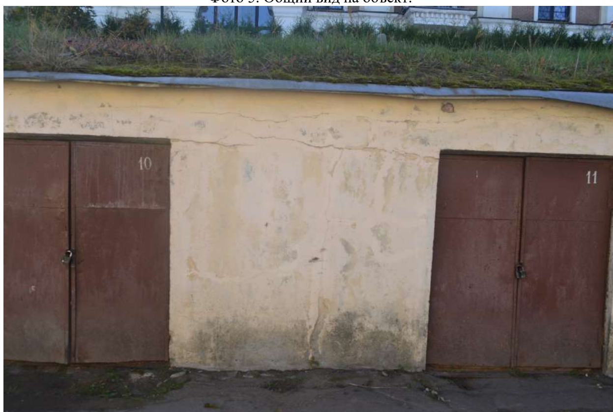
Фото 6. Общий вид на объект.
