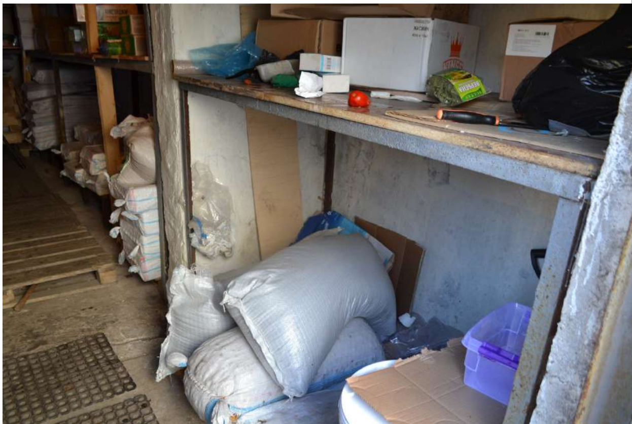
Фото 65. Общий вид на помещения объекта.
