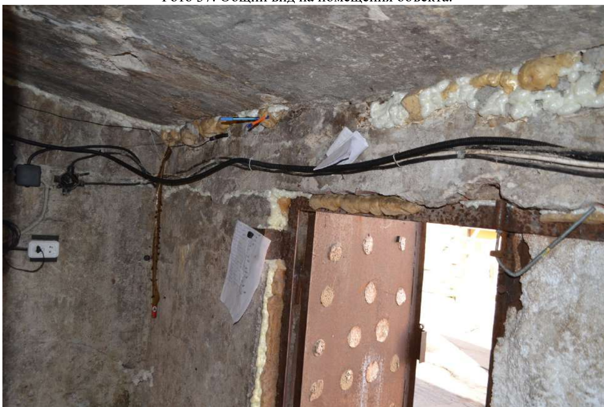
Фото 38. Общий вид на помещения объекта.
