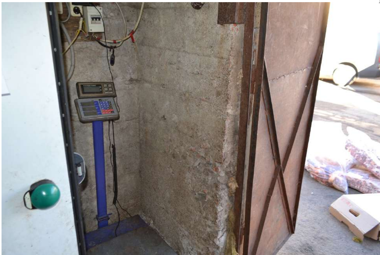
Фото 43. Общий вид на помещения объекта.
