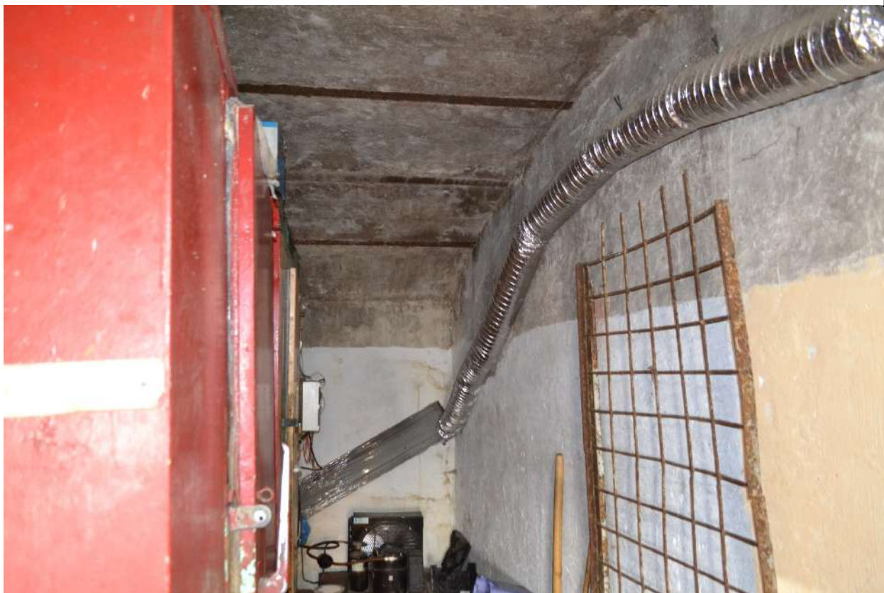
Фото 63. Общий вид на помещения объекта.
