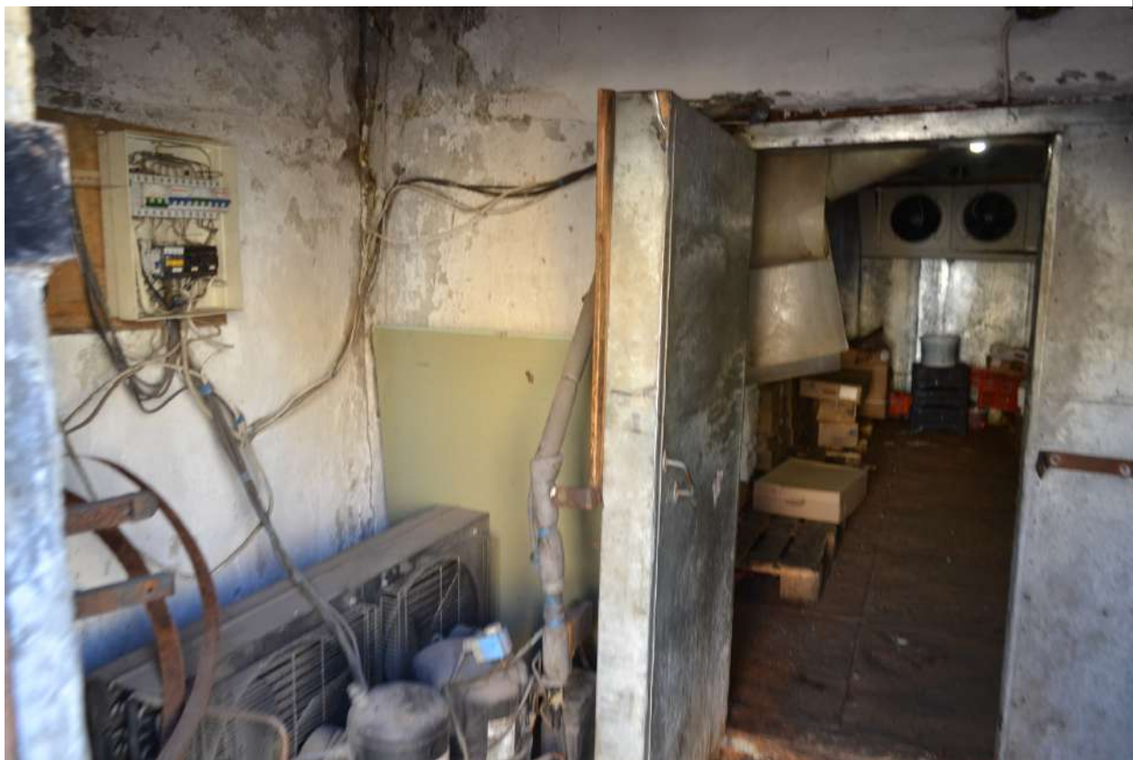
Фото 47. Общий вид на помещения объекта.
