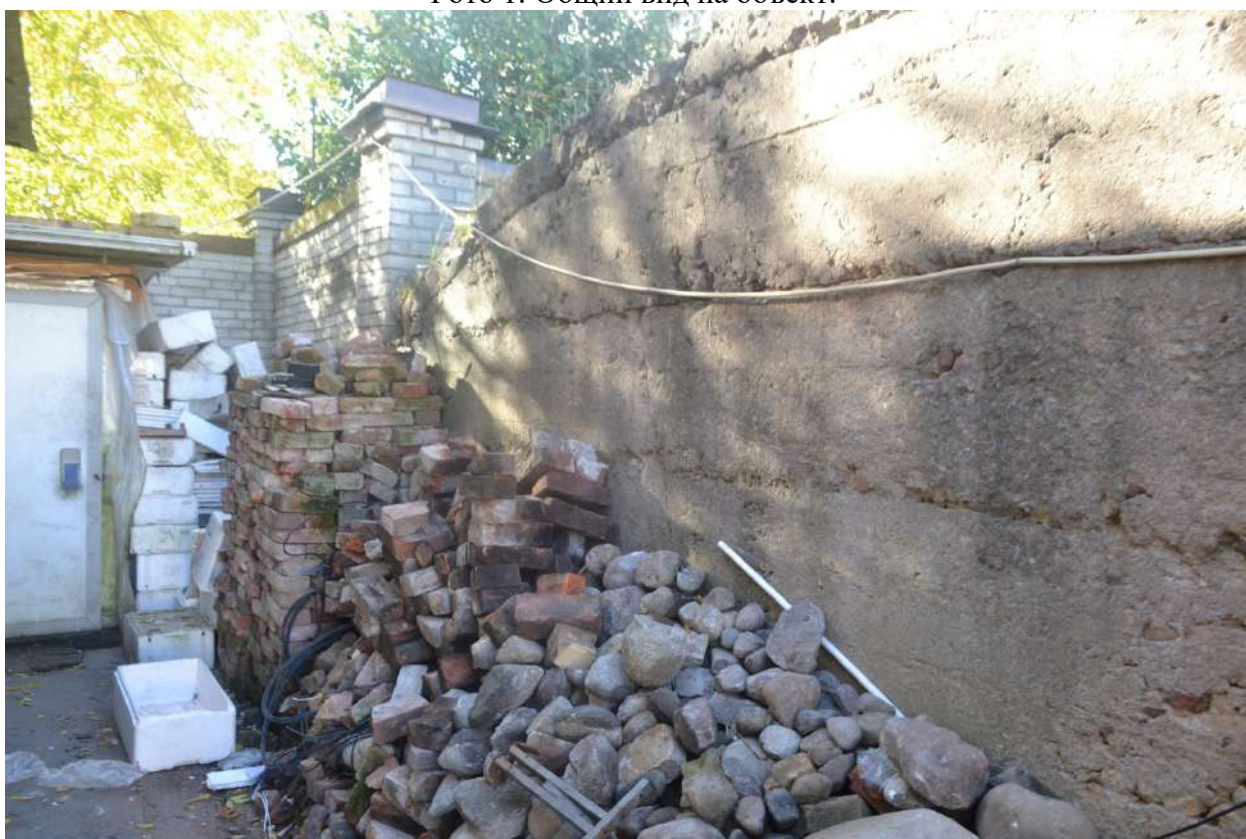
Фото 2. Общий вид на объект.
