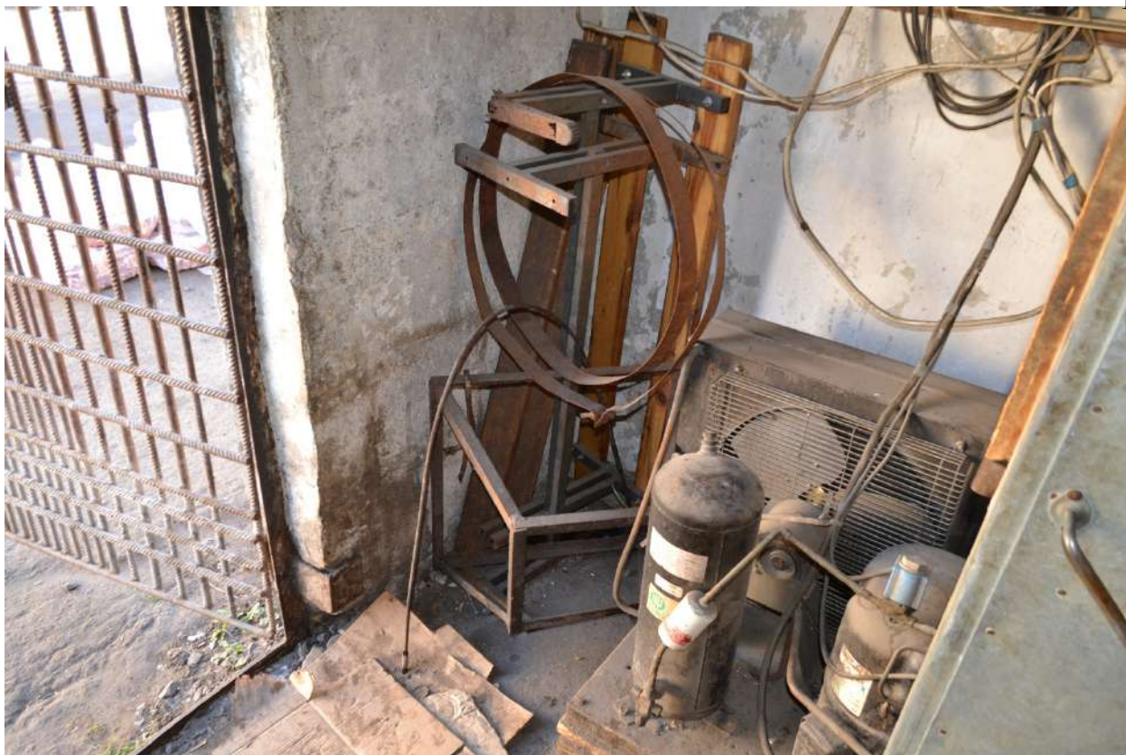
Фото 49. Общий вид на помещения объекта.
