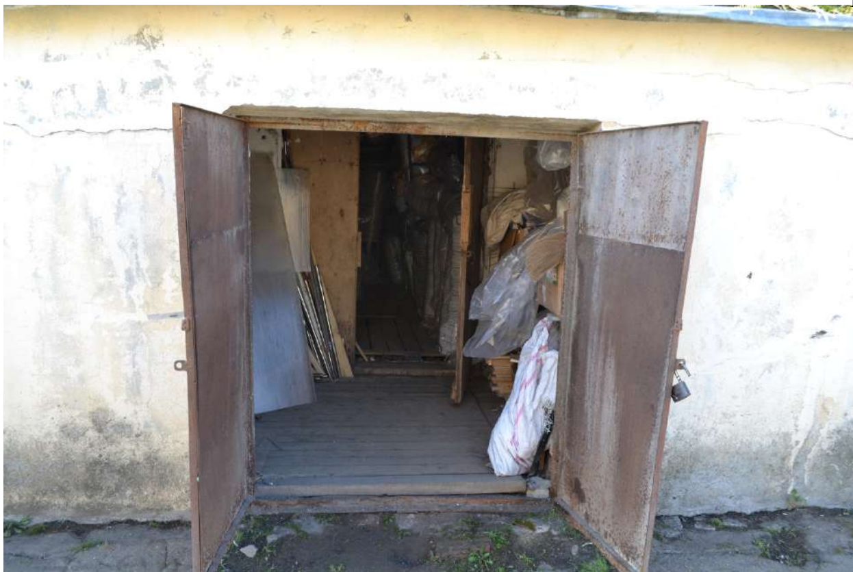
Фото 19. Общий вид на помещения объекта.
