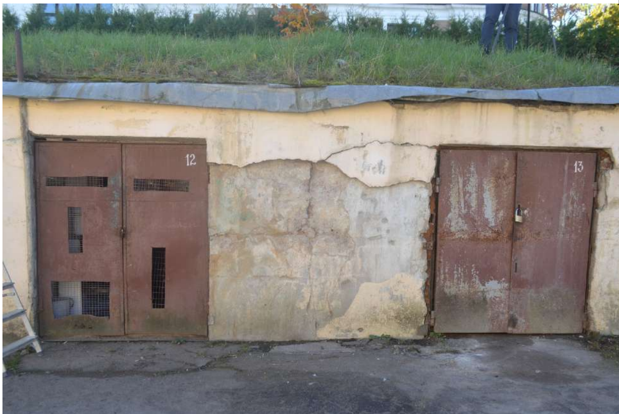
Фото 5. Общий вид на объект.
