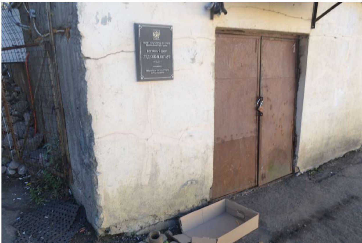
Фото 3. Общий вид на объект.
