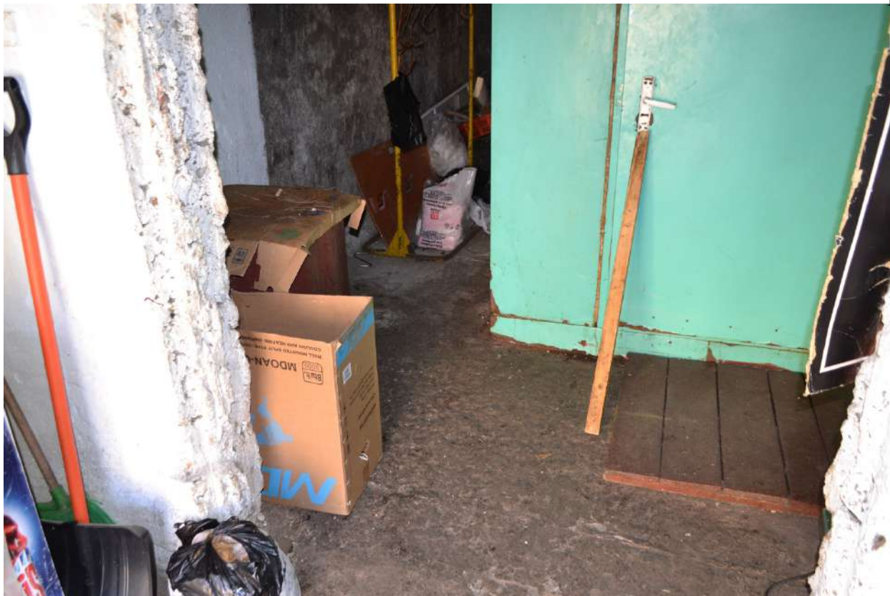
Фото 27. Общий вид на помещения объекта.
