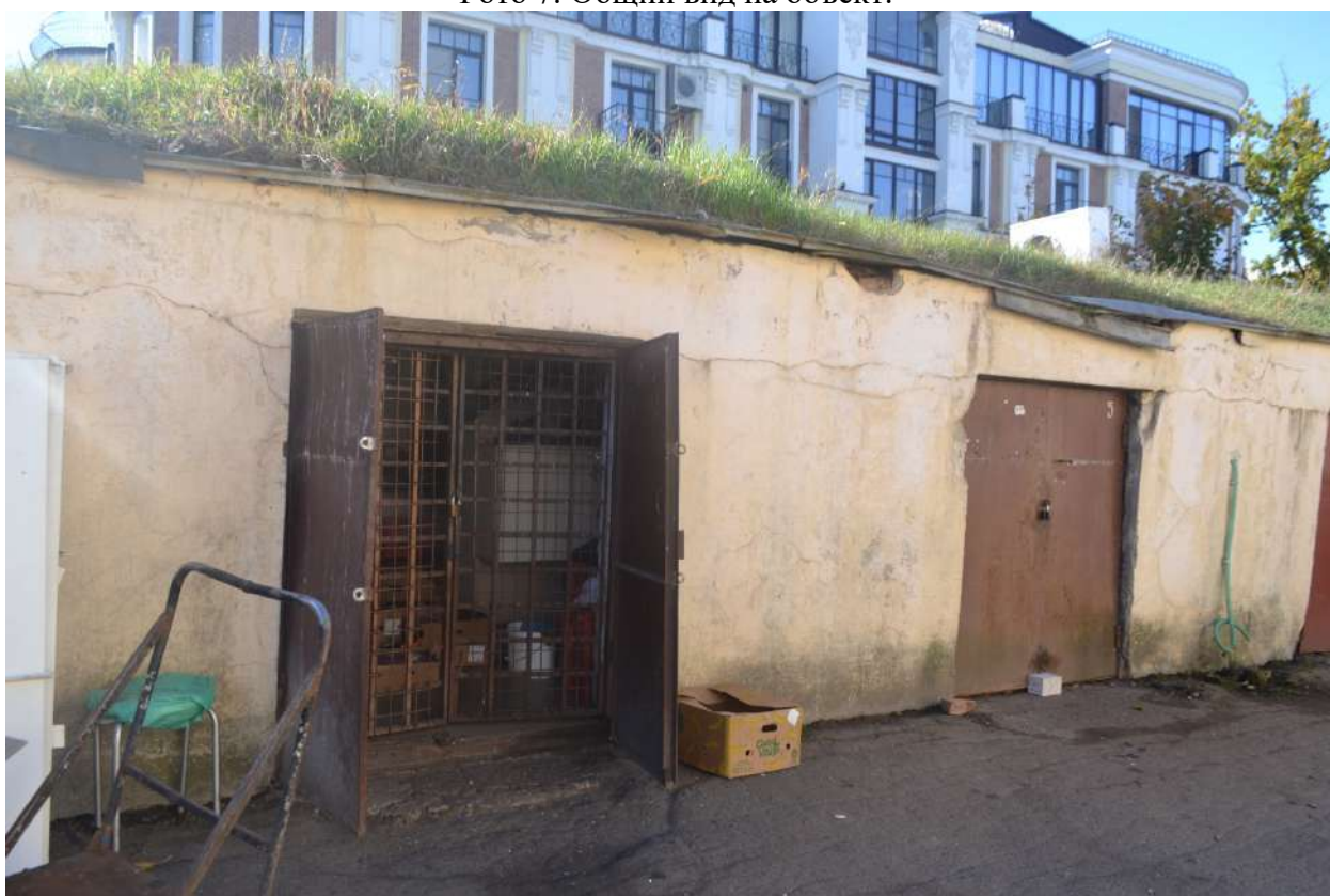
Фото 8. Общий вид на объект.
