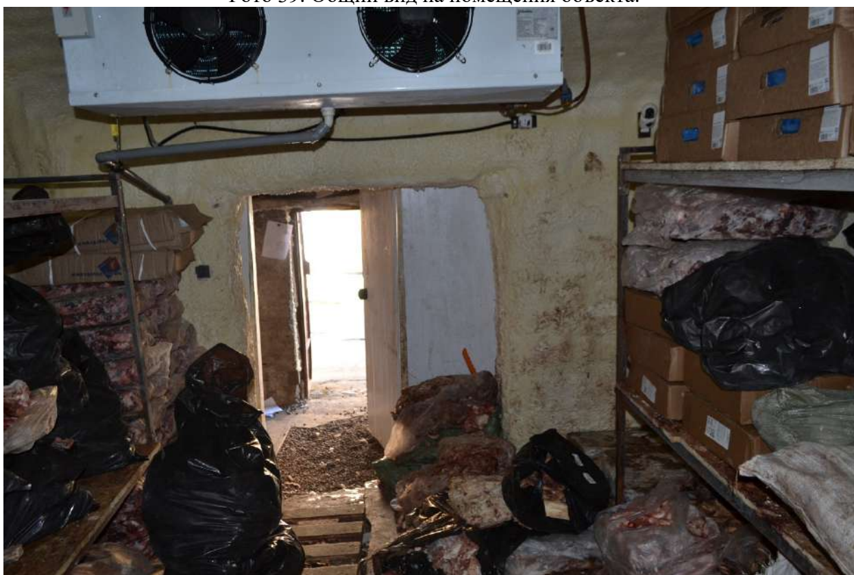
Фото 40. Общий вид на помещения объекта.
