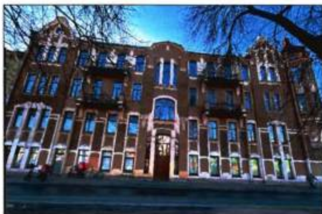
1. Общий вид на северо-западный лицевой фасад.
