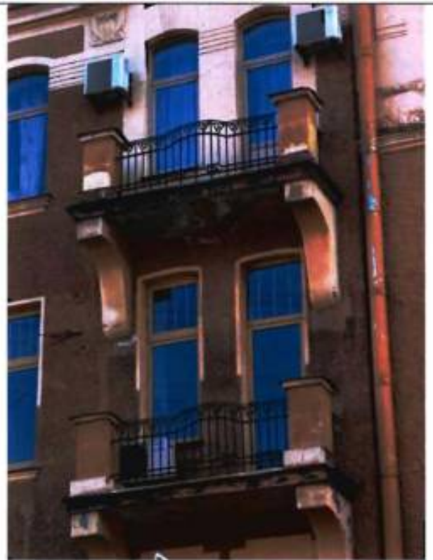
8. Фрагмент юго-западного лицевого фасада. Балкон.
