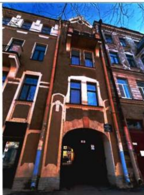
4. Фрагмент юго-западного лицевого фасада.
