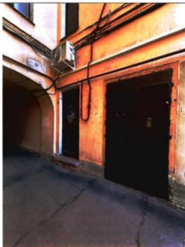
34. Фрагмент дворового фасада. Вход в помещение 7-Н и на лестницу 5ЛК.
