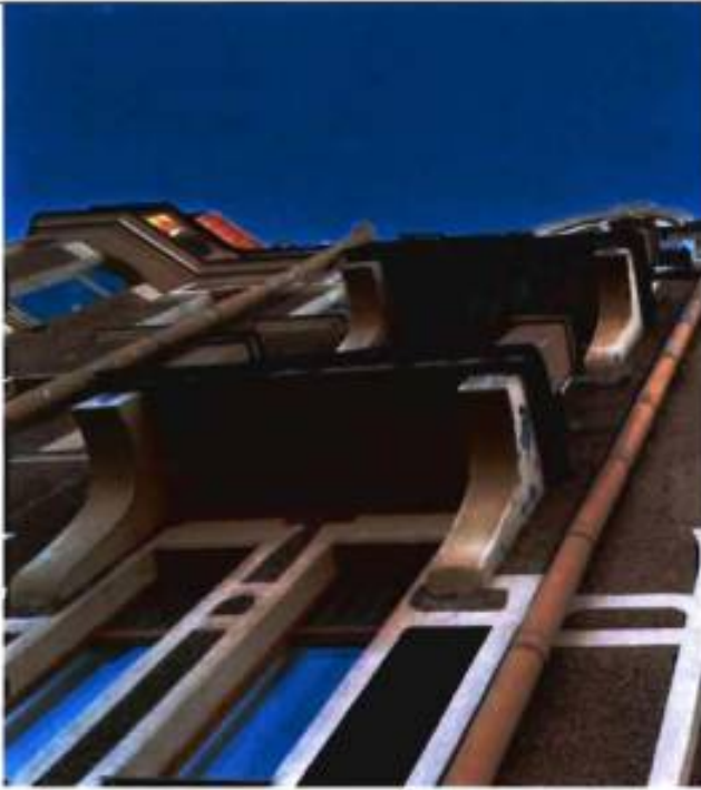
5. Фрагмент юго-западного лицевого фасада. Балконы.
