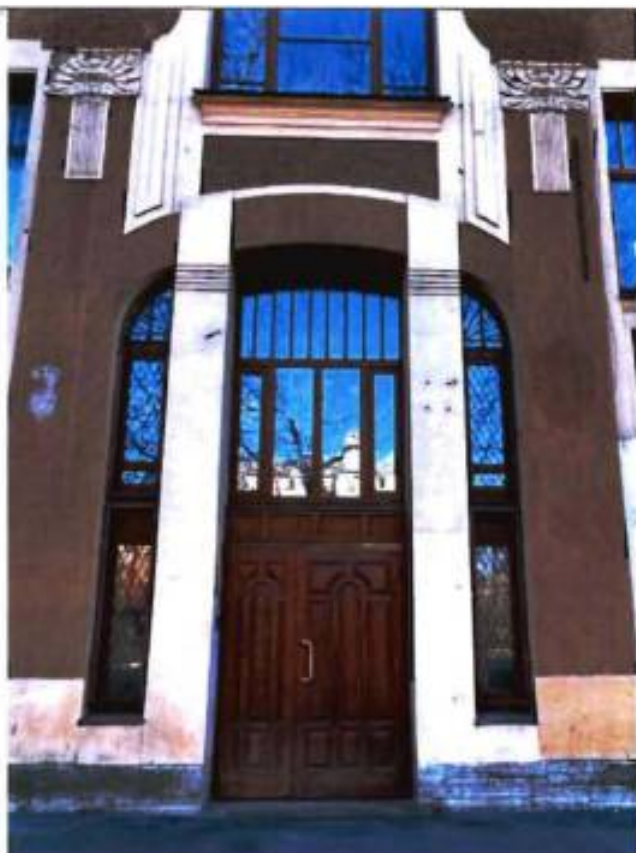
19. Фрагмент северо-западного лицевого фасада. Вход на лестницу 1ЛК.
