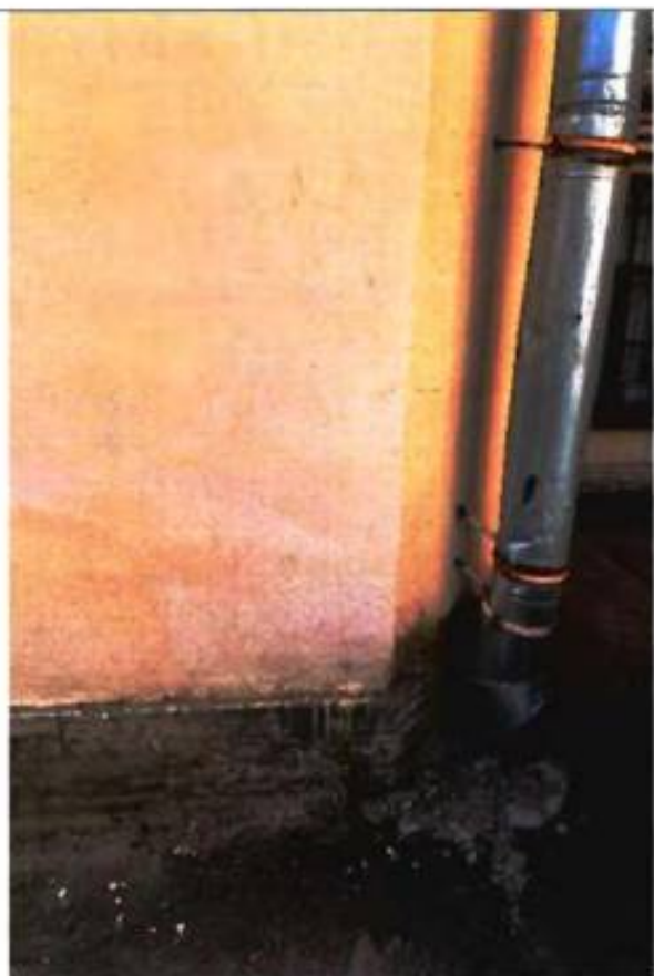
31. Фрагмент северо-восточного дворового фасада. Цоколь.
