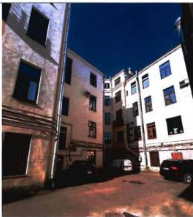
25. Общий вид на дворовые фасады объекта культурного наследия.
