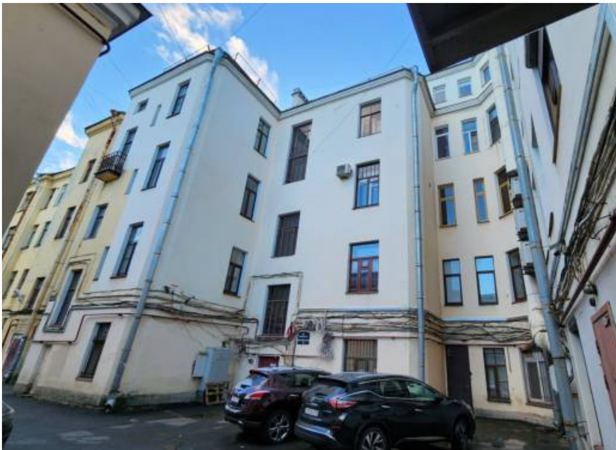
Фото 15. Дворовой восточный фасад.
