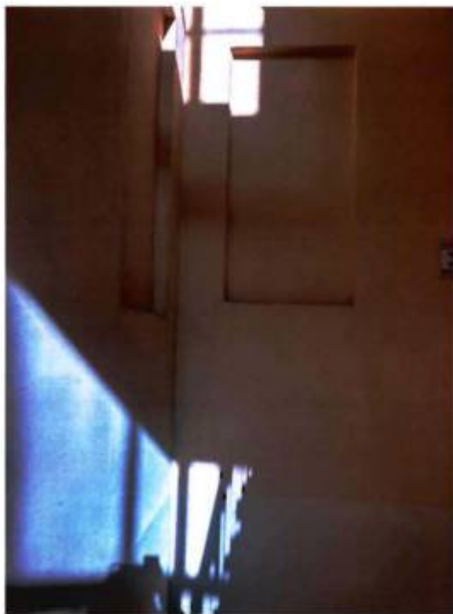
51. Лестница 3ЛК. Оконные проемы.
