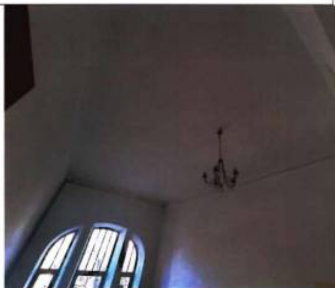
38. Лестница 1ЛК. Потолок.
