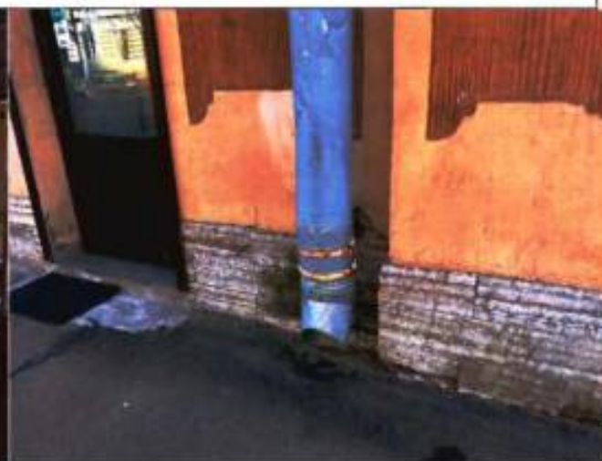
12. Фрагмент юго-западного лицевого фасада. Цоколь.
