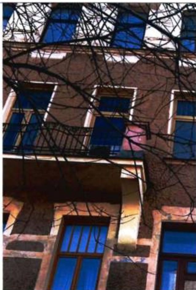
10. Фрагмент северо-западного лицевого фасада. Балкон.
