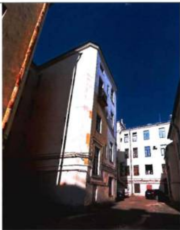
23. Общий вид на дворовые фасады объекта культурного наследия.
