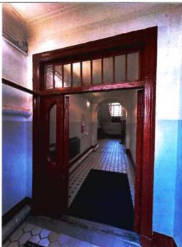
39. Лестница 4ЛК. Дверной проем.
