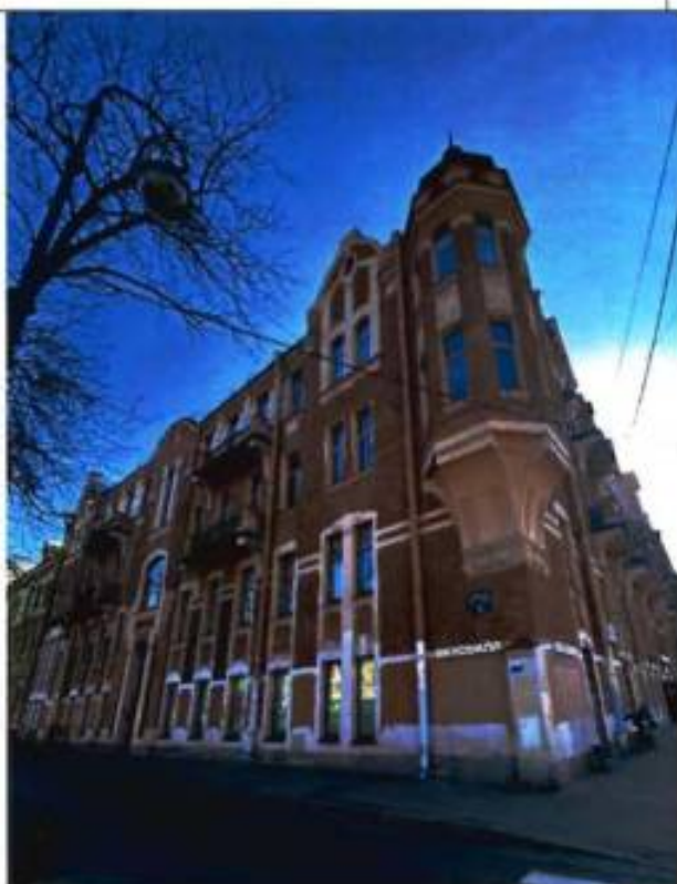
3. Общий вид на объект культурного наследия.
