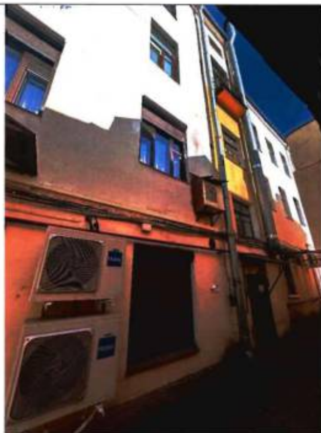
27. Фрагмент юго-восточного дворового фасада. Вход на лестницу 2ЛК.
