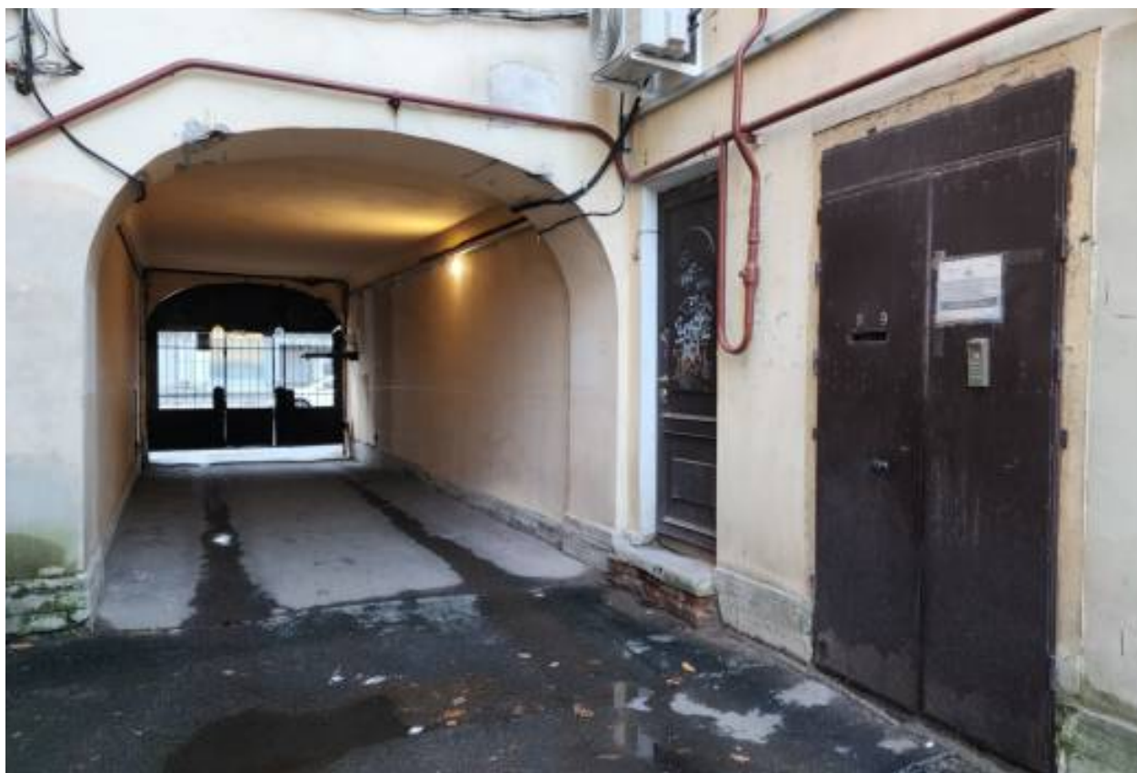
Фото 18. Воротный проезд. Дворовой восточный фасад.
