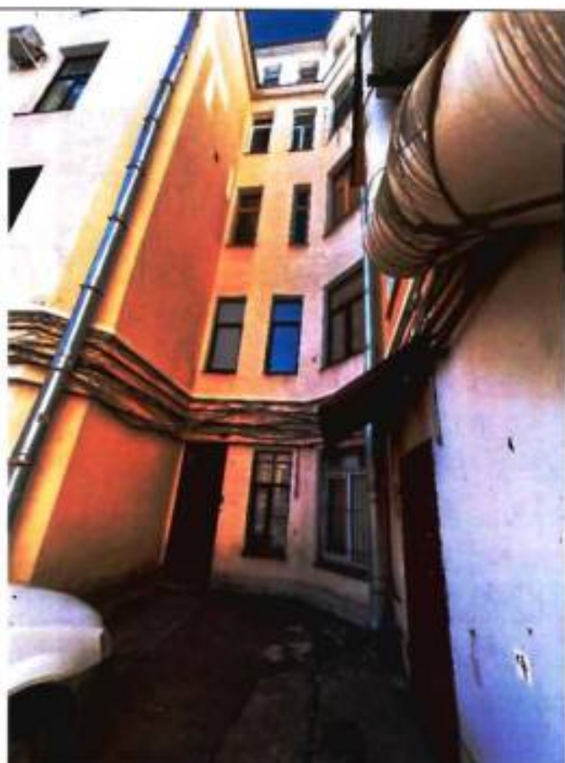
28. Фрагмент дворового фасада. Вход в помещение 8-Н и на лестницу 3ЛК.
