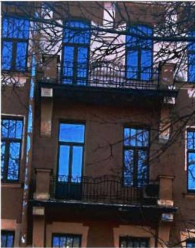
7. Фрагмент северо-западного лицевого фасада. Балкон.
