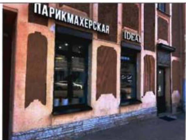
17. Фрагмент юго-западного лицевого фасада. Вход в помещение 7-Н.
