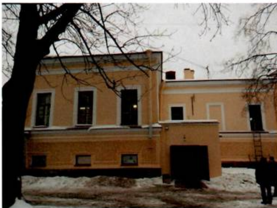
15. Северный дворовый фасад здания.
