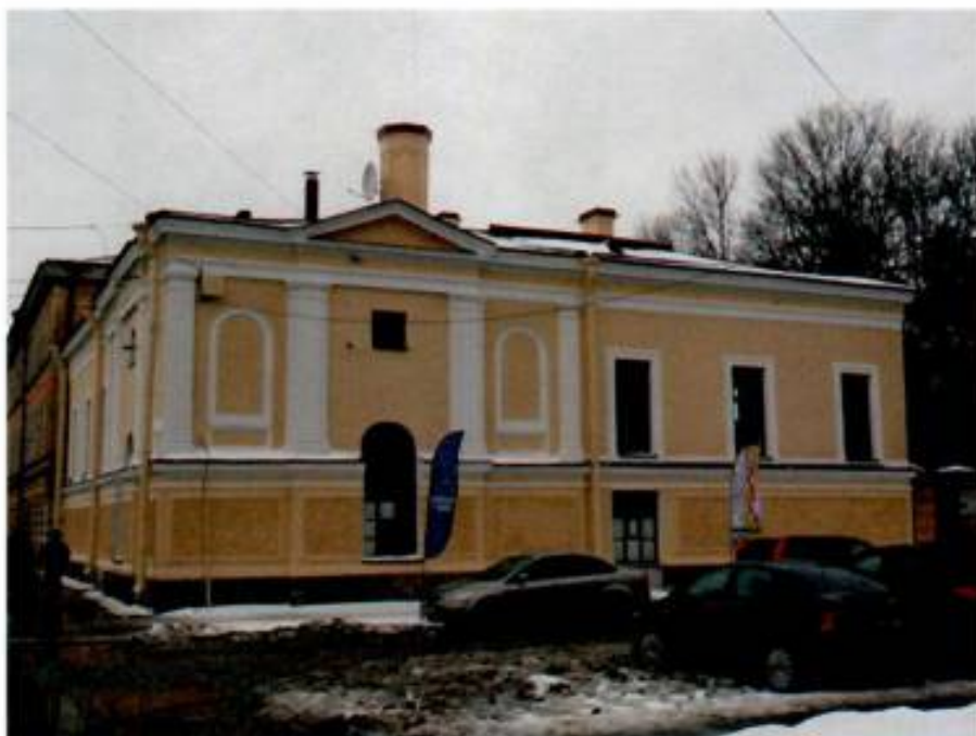
14. Восточный лицевой фасад здания.
