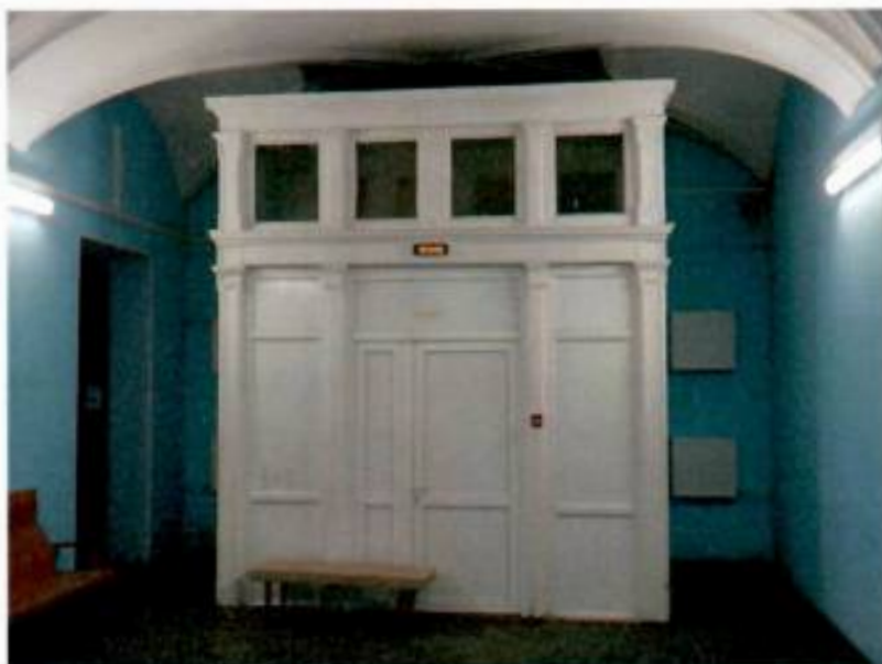
3. Тамбур парадного входа в здание.
