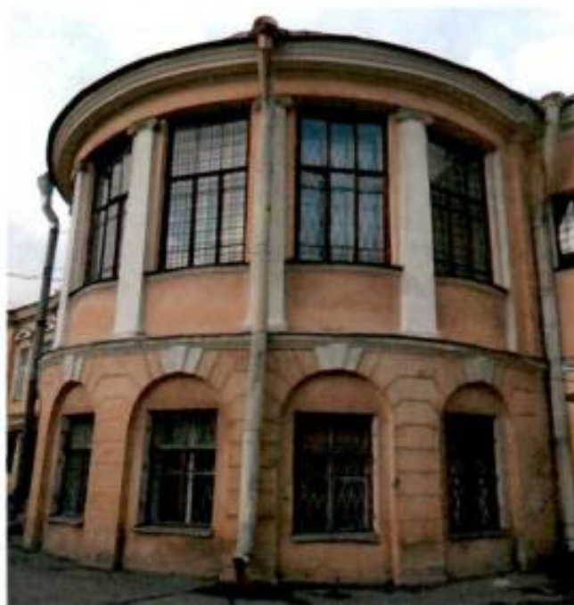
9. Фрагмент южного лицевого фасада здания.
