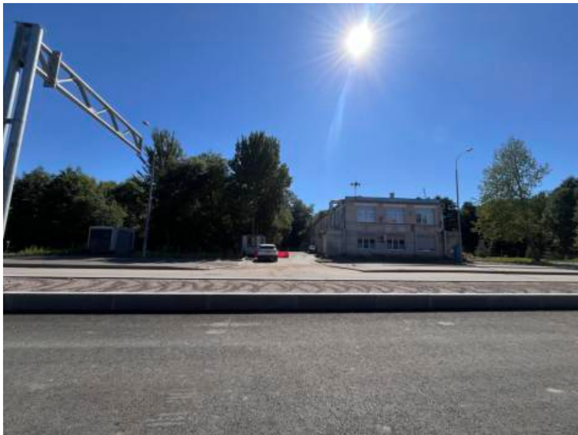
Фото 4. Общий вид окружающей застройки, здание по адресу: Санкт-Петербург, город Кронштадт, Цитадельское шоссе, дом 30, литера А
