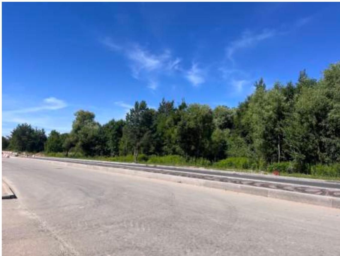
Фото 2. Фрагмент Цитадельского шоссе, г. Кронштадт. Объект культурного наследия регионального значения «Участок дворца Петра I». Общий вид с юга.
