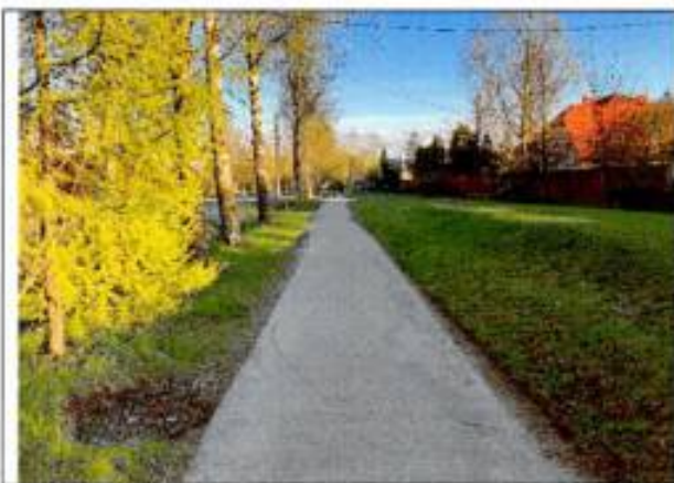
Фото 83. Пушкин, трасса водовода по ул. Ломоносова
