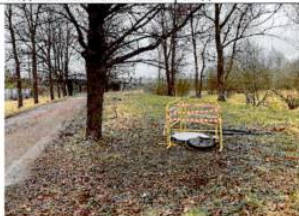
Фото 74. Трасса подземного участка Павловского водовода
