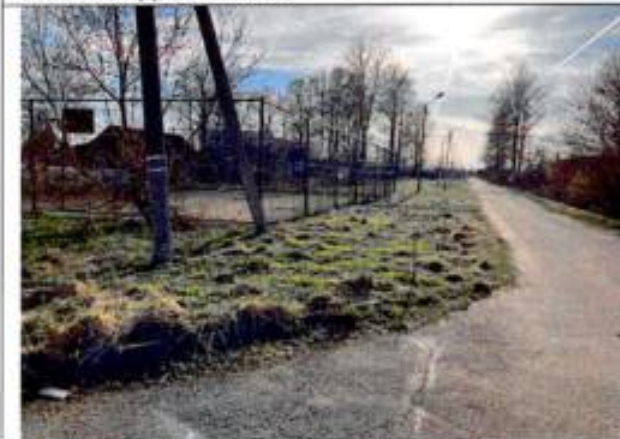
Фото 13. Трасса подземного водовода на территории Новокондакопшино
