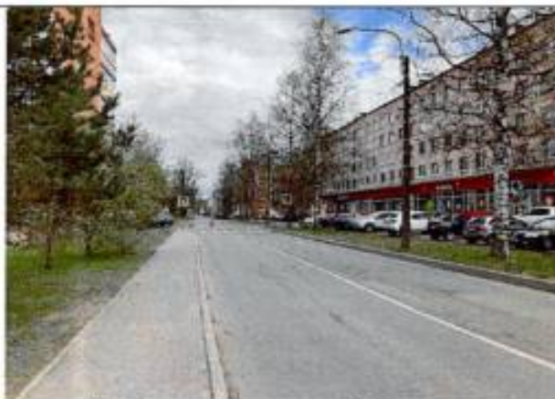
Фото 89. Трасса водовода. Павловск, ул. Березовая
