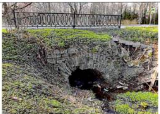
Фото 104. Павловск, ул. Красного курсанта. Мост на ручье, восточный фасад
