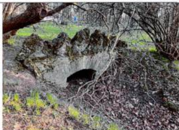
Фото 60. Портал выпуска Таицкого водовода в Екатерининском парке
