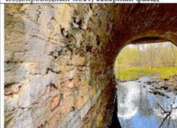
Фото 99. Павловск, ул. Правды. Водопроводный мост, свод
