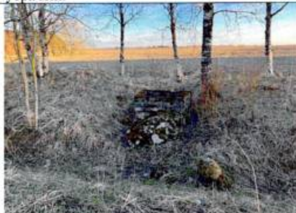
Фото 9. Обетонированный колодец для обслуживания водовода у базы СПБГУ в Новокондакопшино
