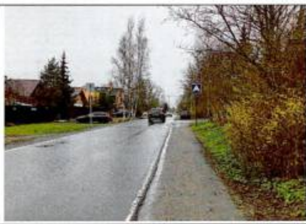
Фото 84. Пушкин, трасса водовода по ул. Ломоносова
