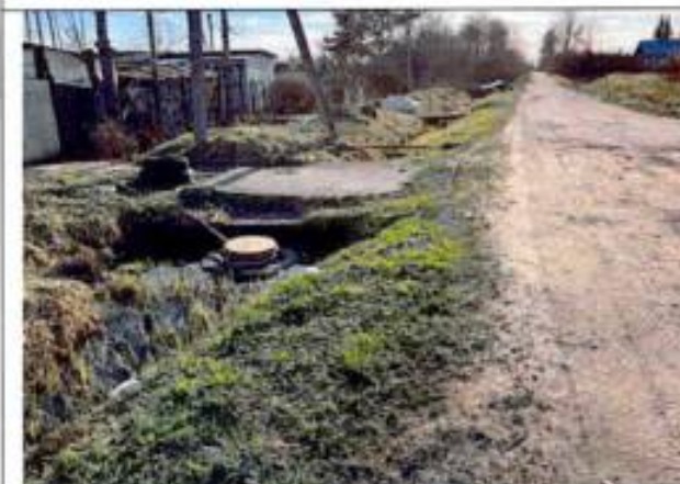
Фото 15. Открытый канал в Новокондакопшино
