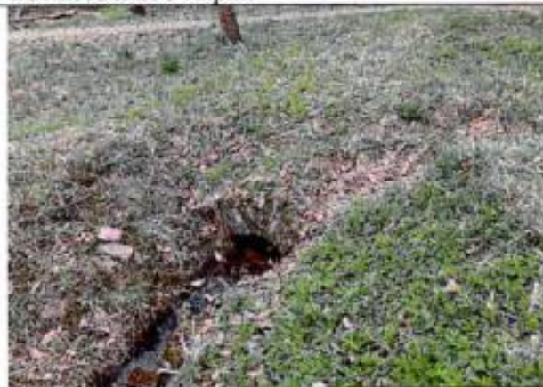
Фото 40. Выпуск из закрытого коллектора в открытую канаву
