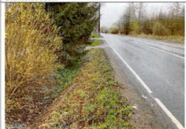
Фото 85. Пушкин, трасса открытого водовода по ул. Ломоносова.
