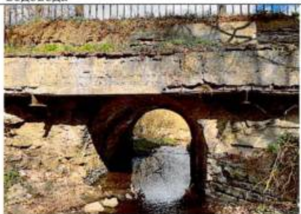
Фото 98. Павловск, ул. Правды. Водопроводный мост, южный фасад
