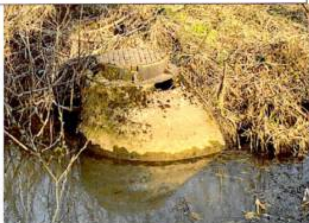
Фото 110. Павловск, парк Мариенталь. Колодец в пойме р. Славянки на трассе водовода
