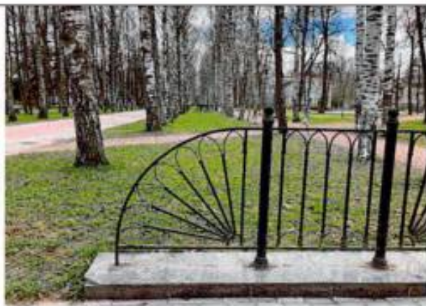
Фото 90. Трасса водовода. Павловск, ул. Березовая
