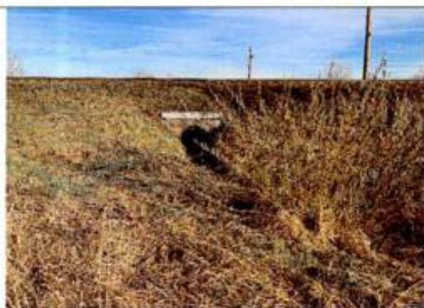
Фото 17. Труба под ж/д веткой на трассе водовода
