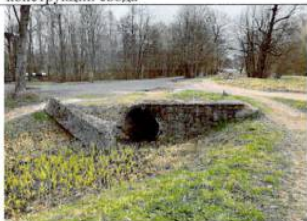
Фото 55. Ж/б входной портал участка подземной трубы от Баурского канала до гранитного бассейна
