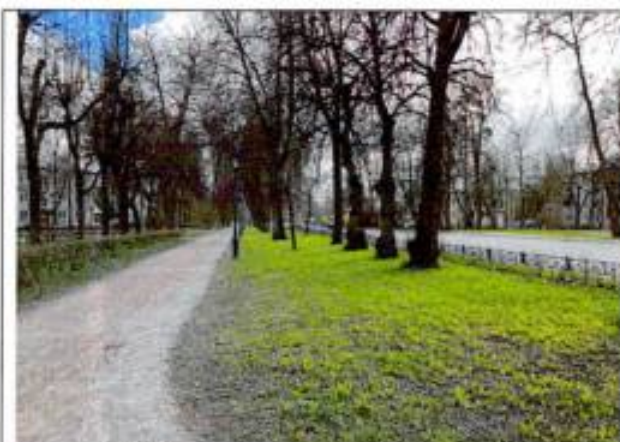
Фото 95. Павловск, ул. Мичурина. Трасса водовода
