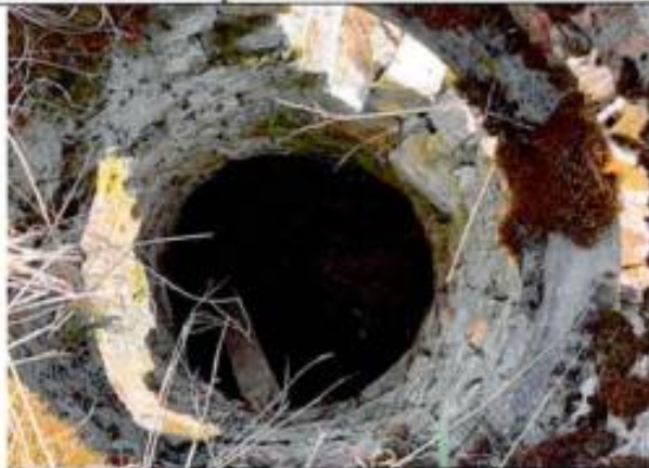
Фото 32. Кирпичный колодец с гранитным обрамлением на кирпичной галерее (вид внутри)
