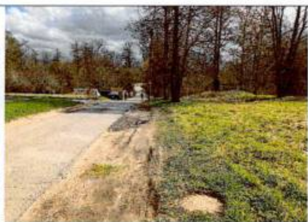
Фото 96. Павловск, ул. Правды. Трасса водовода
