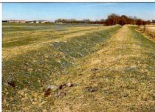
Фото 18. Подземный водовод в полях восточнее ж/д ветки.
