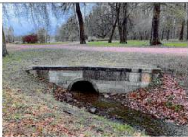
Фото 66. Водовыпуск в канал с облицовкой известняком
