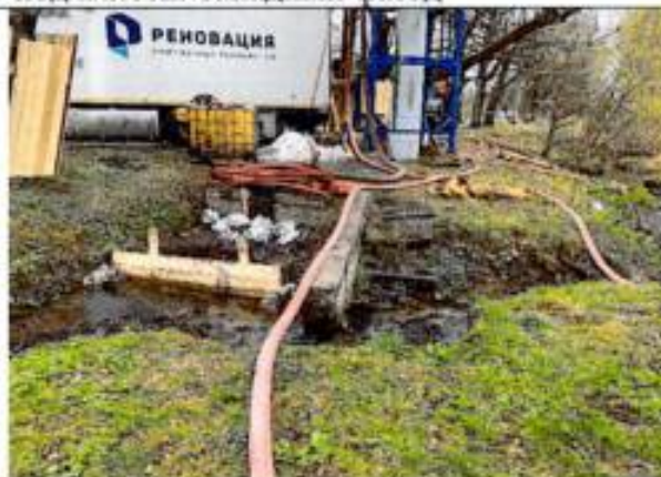
Фото 73. Входной портал в трубопровод. Ведутся работы по реставрации и приспособлению объекта культурного наследия «Водовод Павловский (часть Таицкого)» в соответствии с разрешением КГИОП
