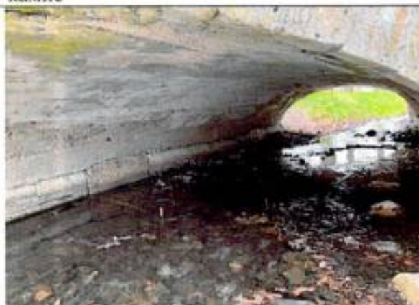
Фото 69. Свод мостика обетонирован
