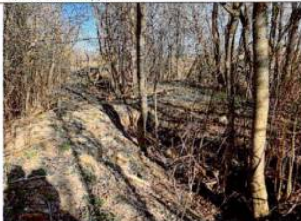
Фото 20. Трасса полуподземного водовода в поле южнее Красносельского шоссе
