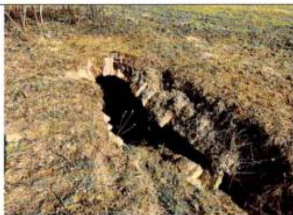
Фото 35. Провалы полуподземной кирпичной галереи в поле южнее Красносельского шоссе
