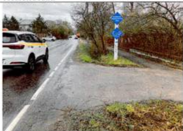
Фото 86. Пушкин, трасса открытого водовода по Садовой ул.
