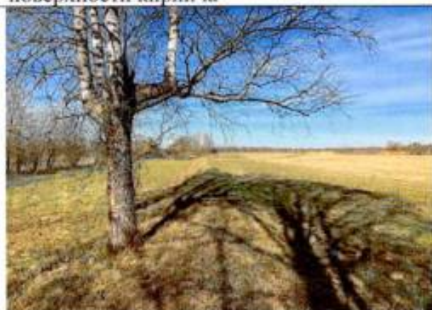
Фото 27. Трасса подземного кирпичного водовода в поле южнее Красносельского шоссе
