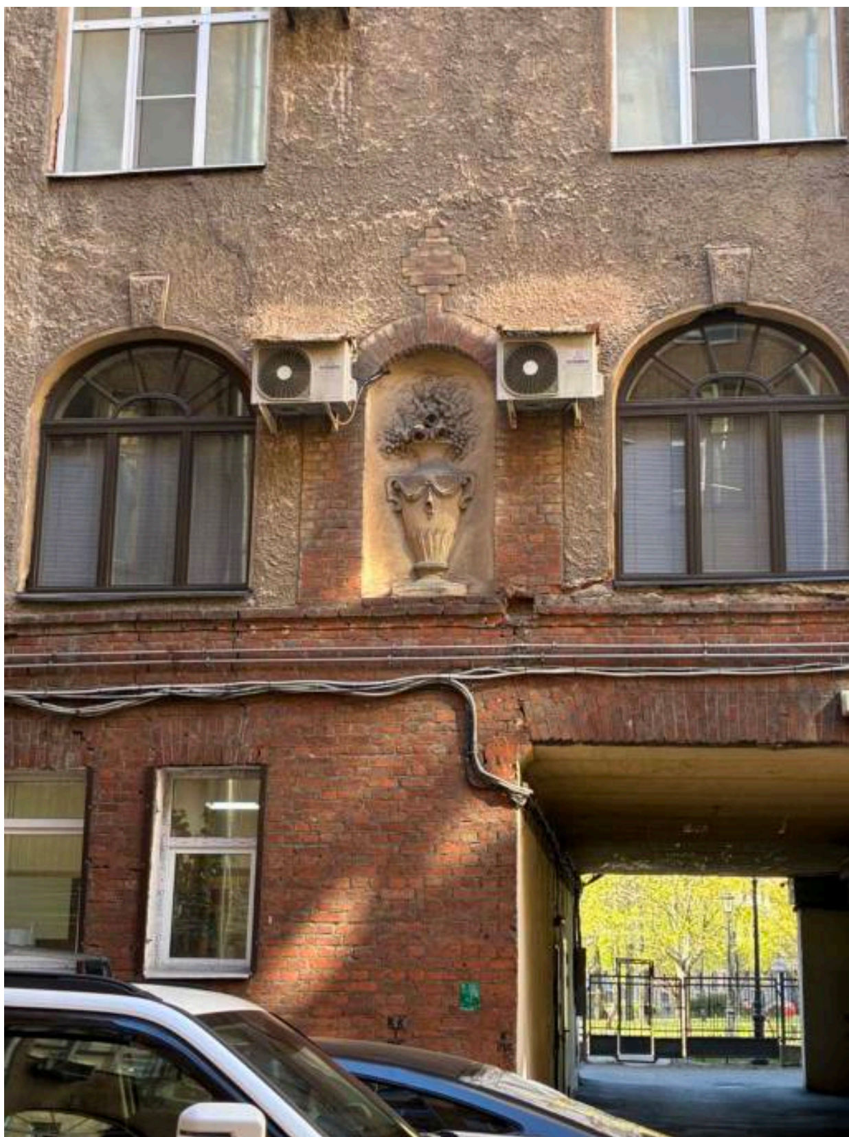
36. Внутренний двор. Юго-восточный фасад. Проезд со стороны сквера. Дата съемки: 06.05.2026
