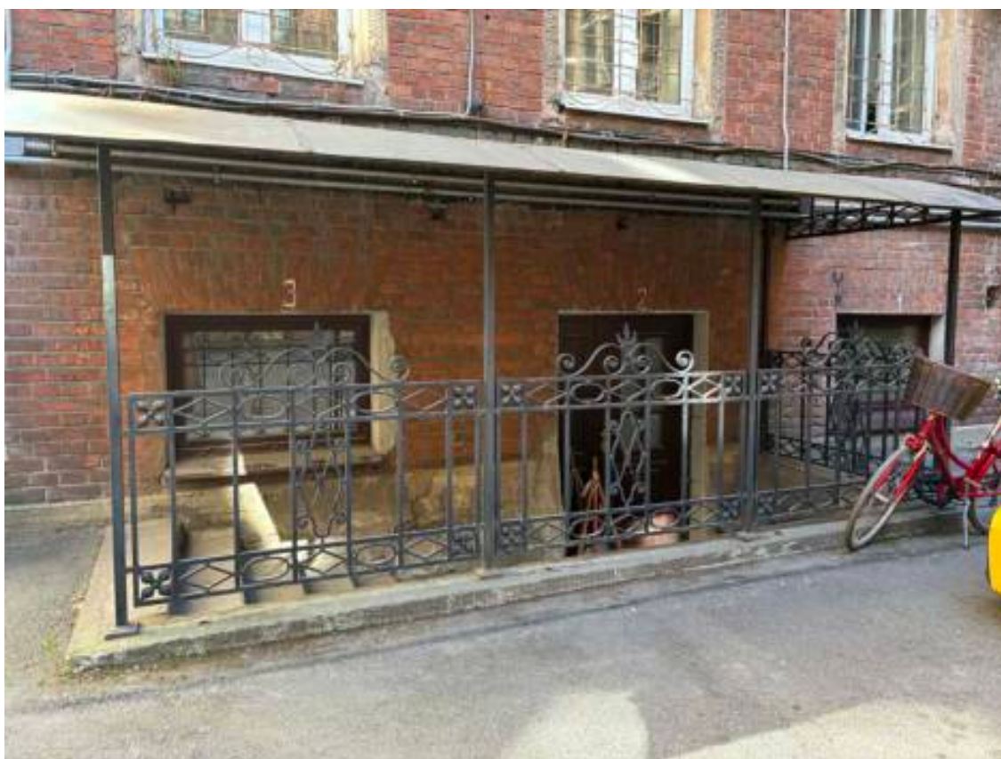
32. Внутренний двор. Юго-западный фасад. Фрагмент. Прямо́к. Дата съемки: 06.05.2026
