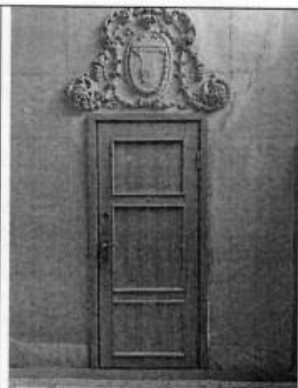
21. Лестничная клетка Л-1.
