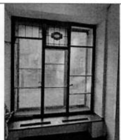
33. Лестничная клетка Л-1.
