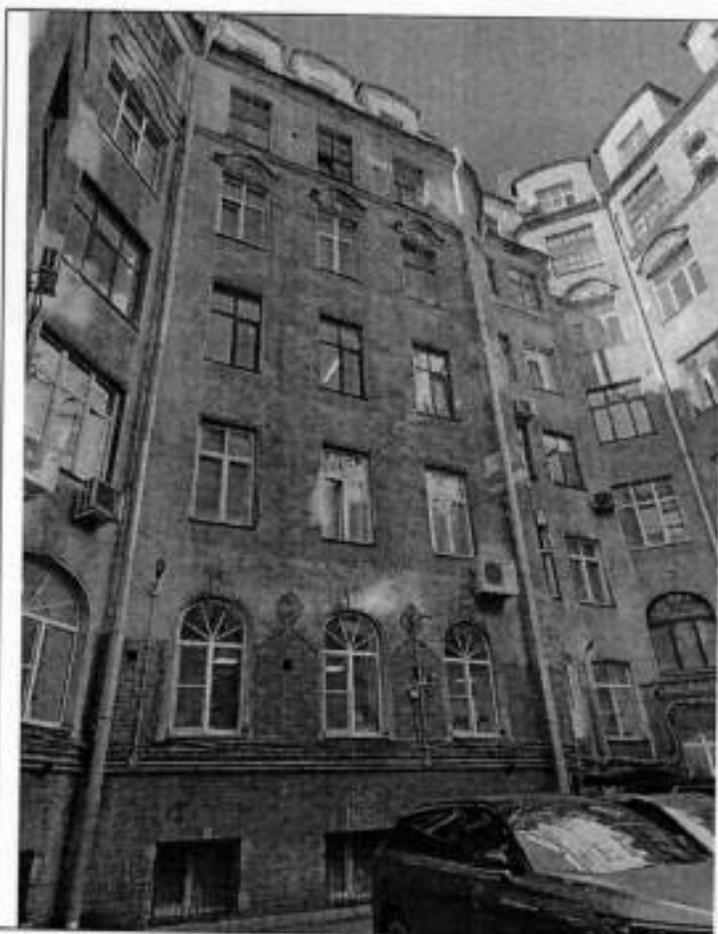
15. Восточный дворовой фасад.
