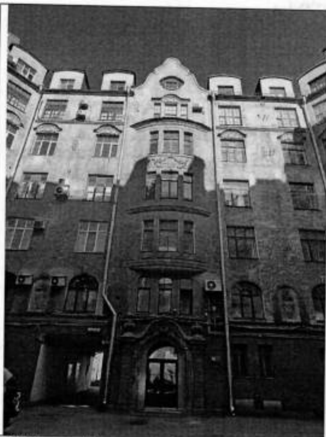
13. Северный дворовой фасад.
