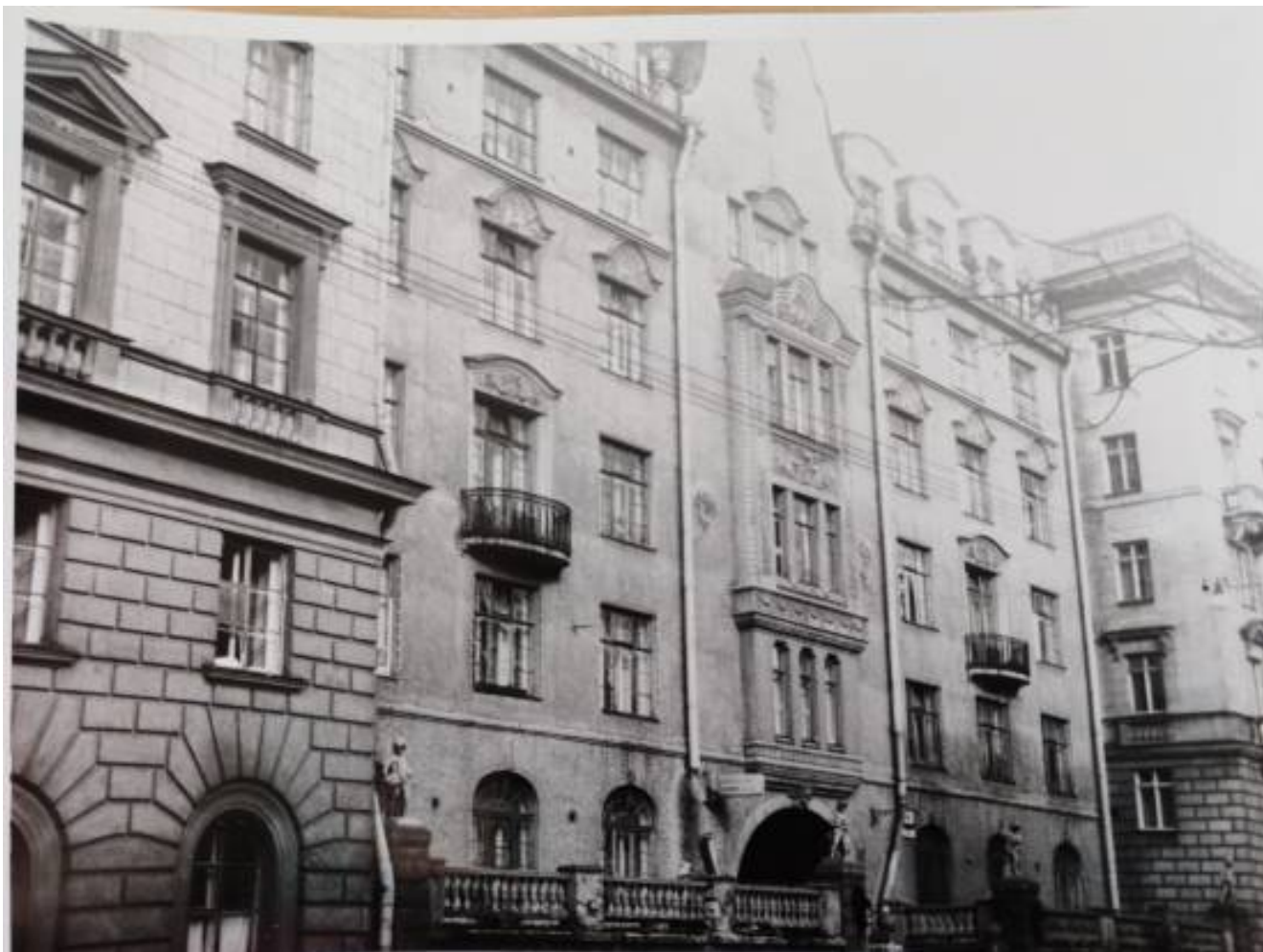
40. Ленинград. Улица Рентгена. Фасад дома № 4. Архив КГИОП. 1983 г.
