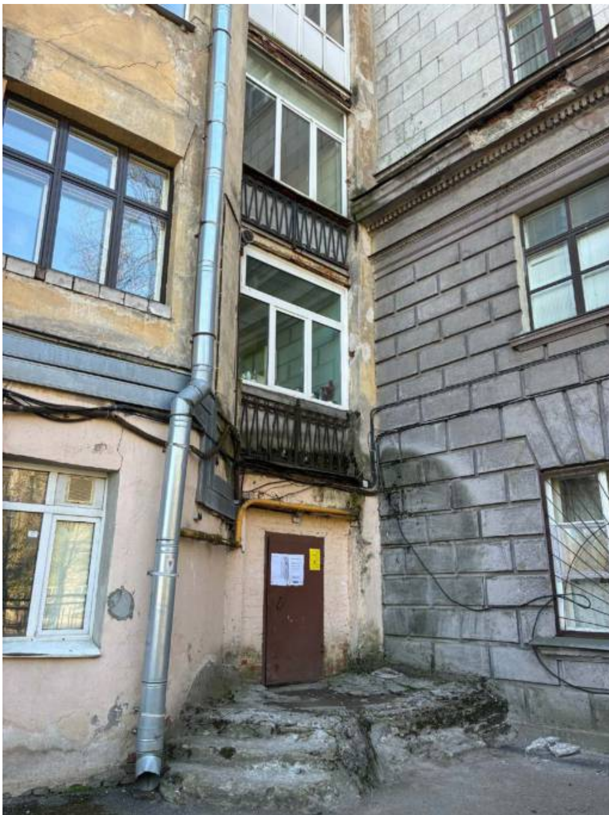
45. Северо-западный фасад со стороны сквера. Крыльцо. Дата съемки: 06.05.2026
