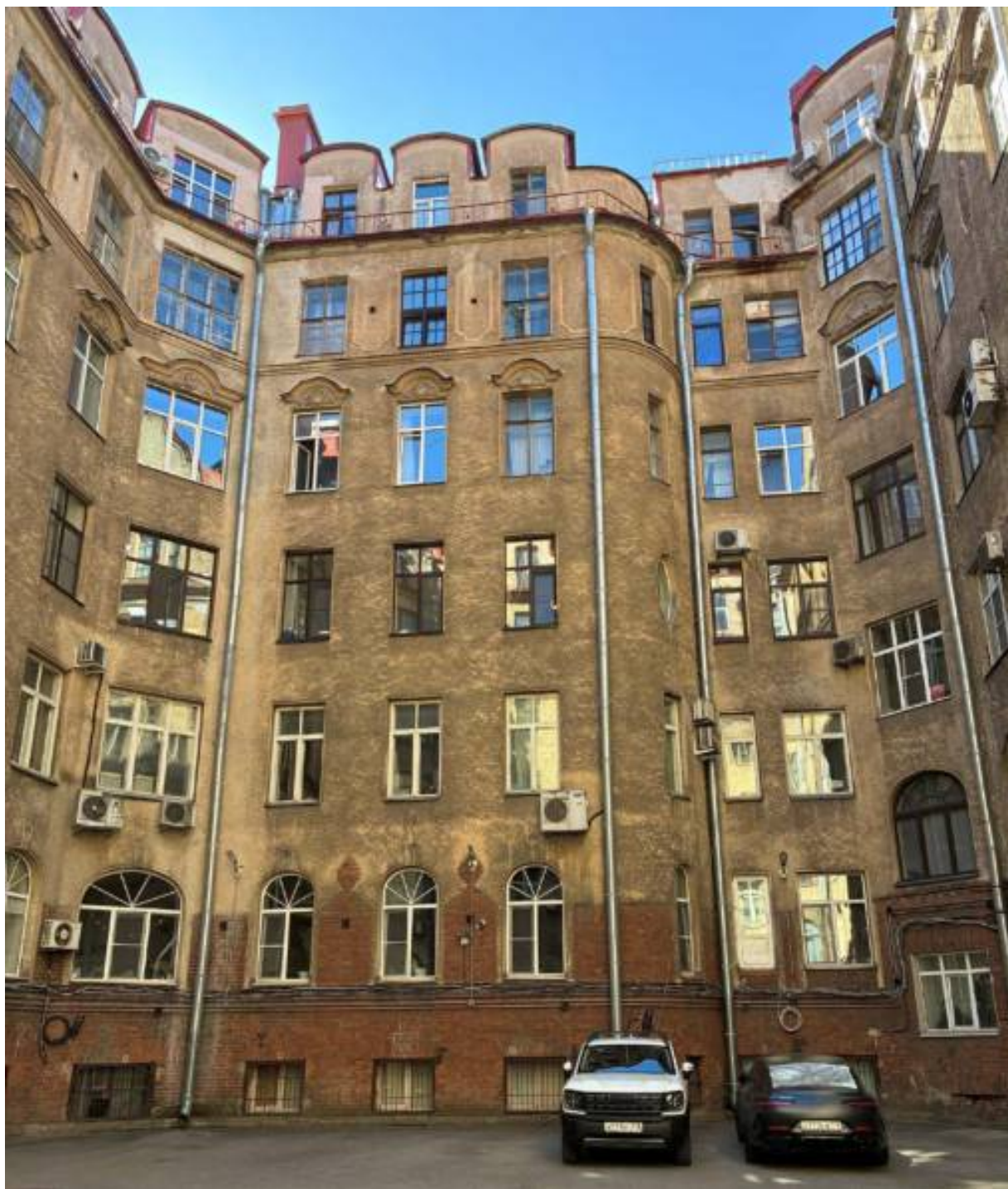
40. Внутренний двор. Северо-восточный фасад. Общий вид. Дата съемки: 06.05.2026
