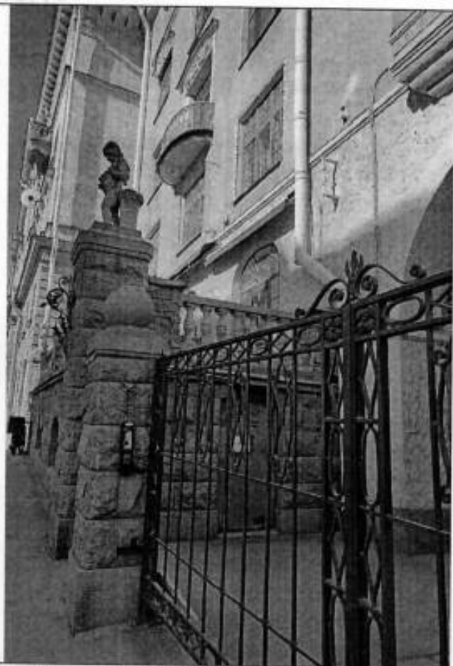
3. Фрагмент северного фасада.
