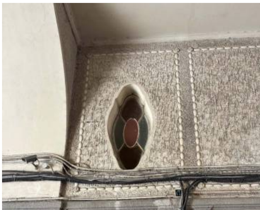
24. Проезд во двор со стороны лицевого фасада. Витражное заполнение фигурного оконного проема. Дата съемки: 06.05.2026
