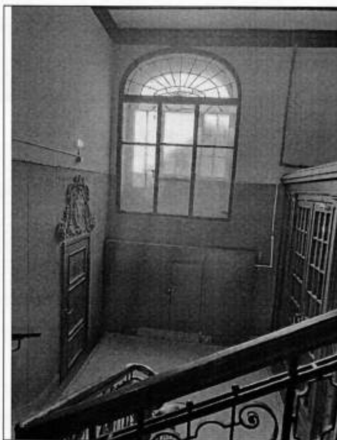
25. Лестничная клетка Л-1.
