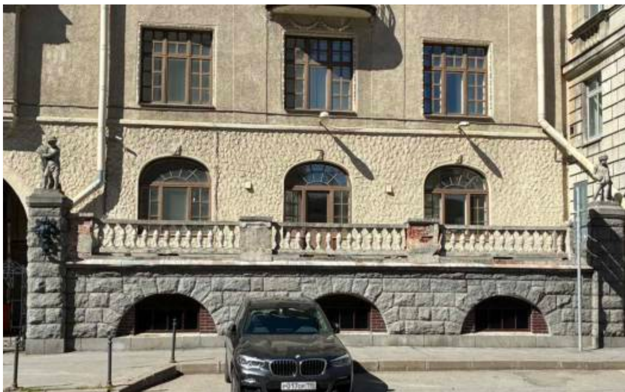
7. Лицевой фасад. Фрагмент. Терраса. Дата съемки: 06.05.2026
