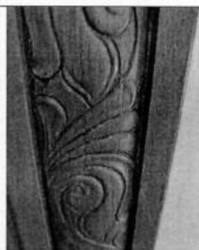
31. Лестничная клетка Л-1.
