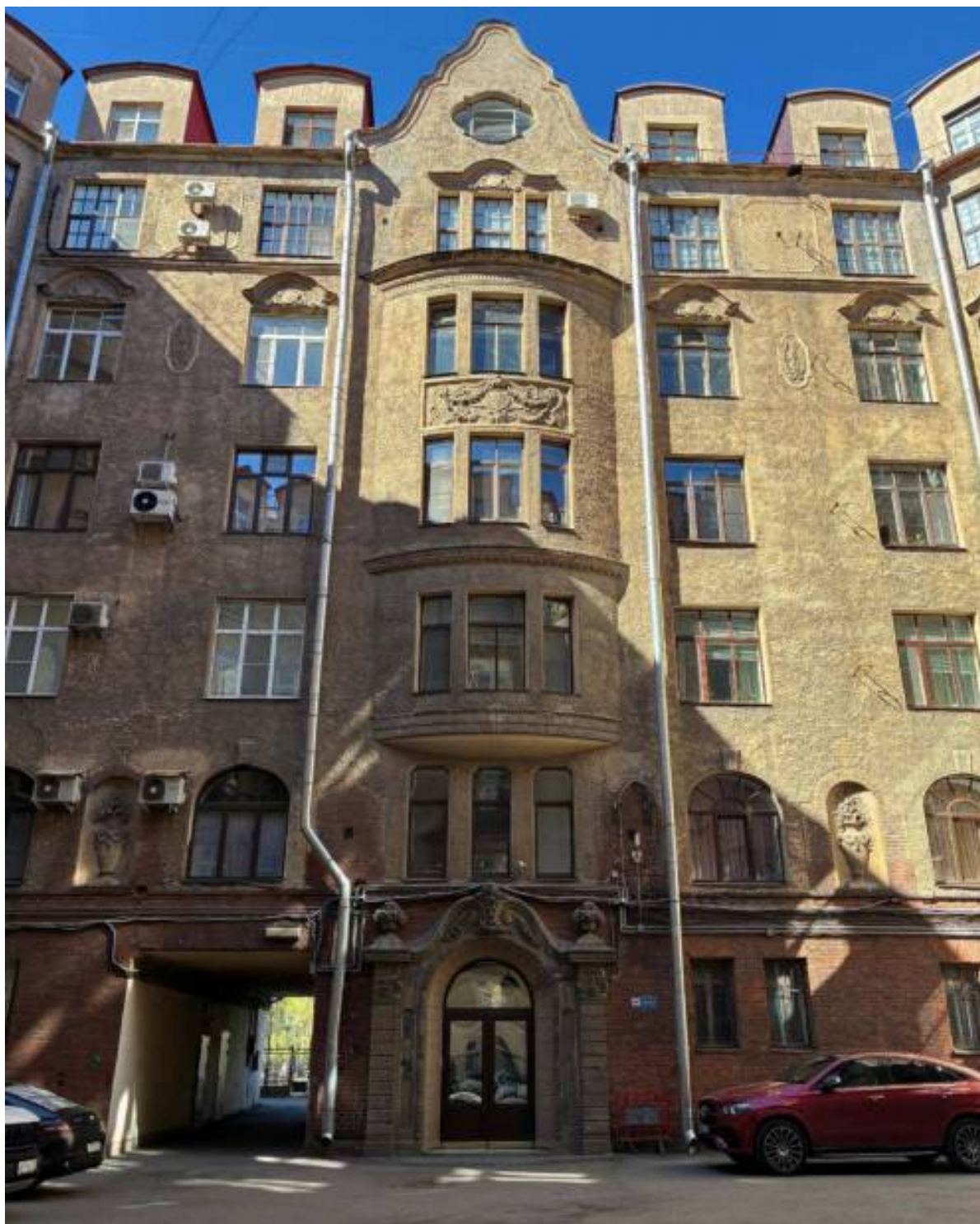
33. Внутренний двор. Юго-восточный фасад. Общий вид. Дата съемки: 06.05.2026
