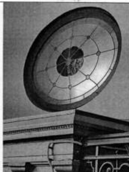
23. Лестничная клетка Л-1.
