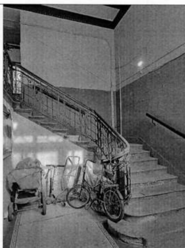
26. Лестничная клетка Л-1.
