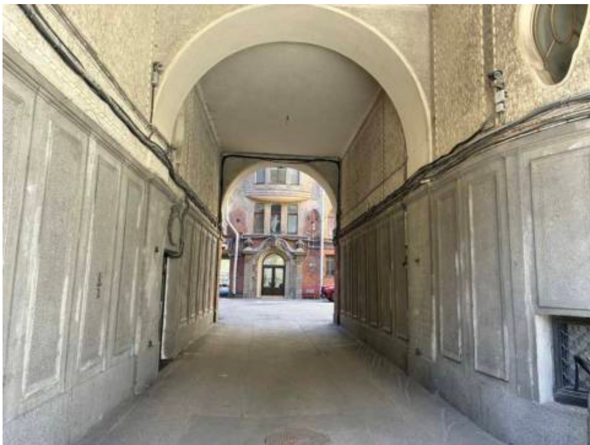
19. Проезд во двор со стороны лицевого фасада. Дата съемки: 06.05.2026
