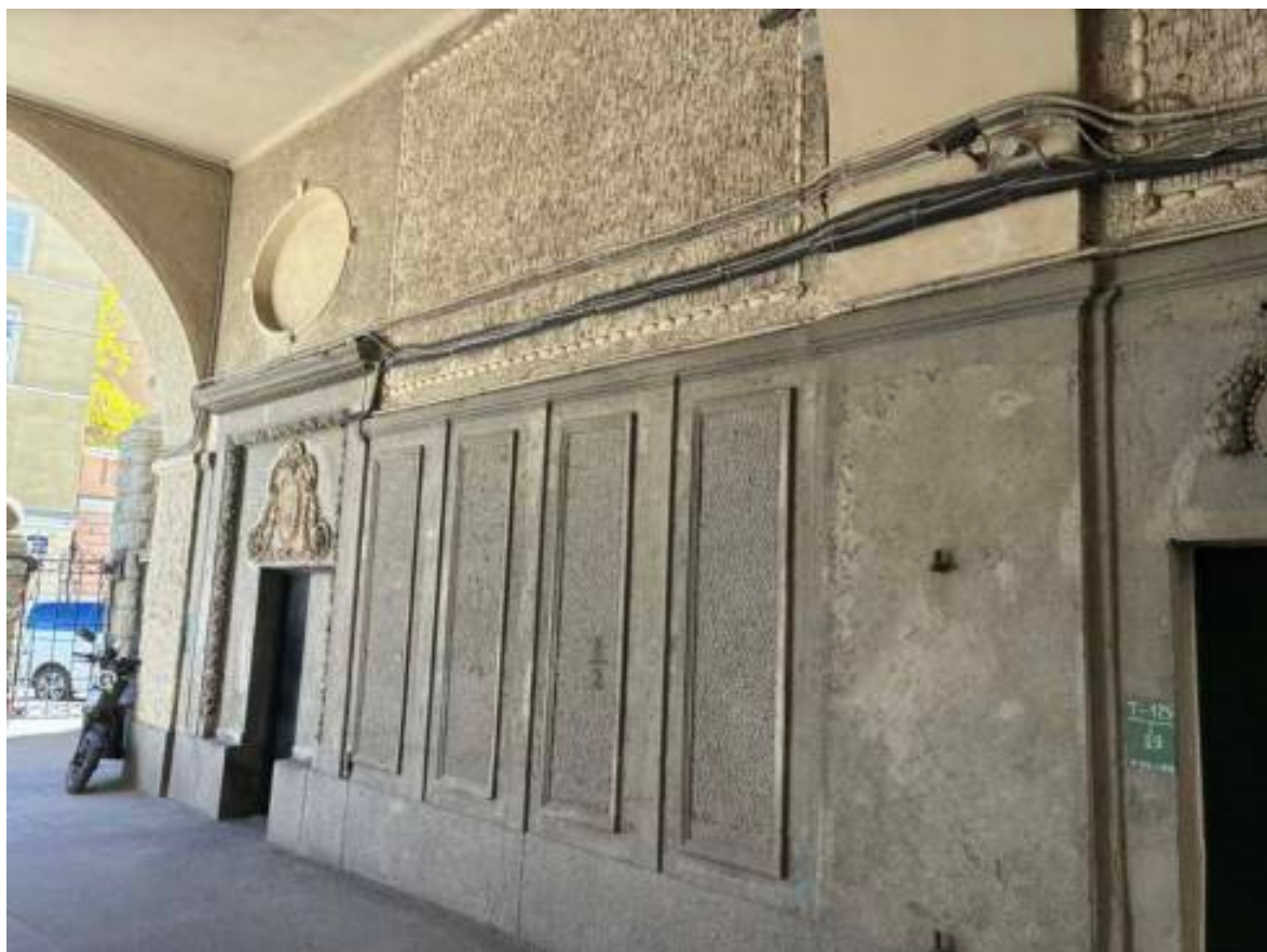
22. Проезд во двор со стороны лицевого фасада. Оформление стены фактурной штукатуркой и лепным декором. Дата съемки: 06.05.2026
