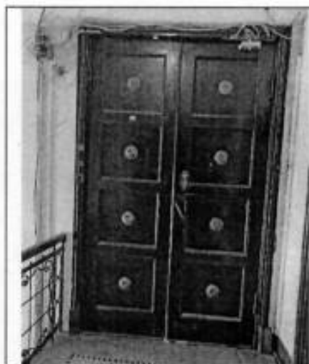
29. Лестничная клетка Л-1.
