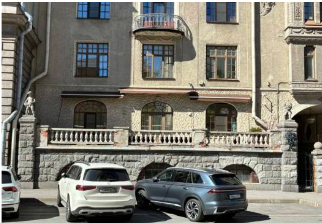
4. Лицевой фасад. Фрагмент. Терраса. Дата съемки: 06.05.2026
