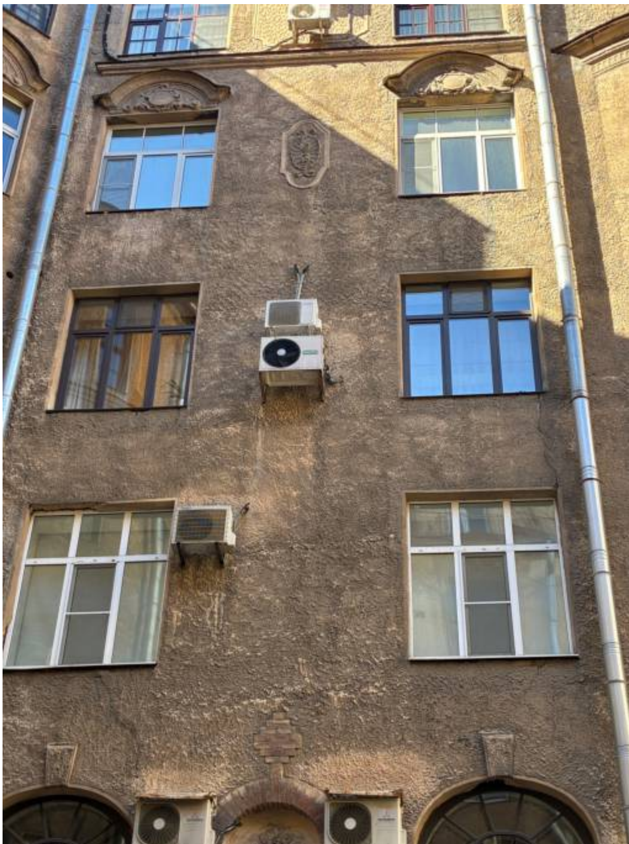
34. Внутренний двор. Юго-восточный фасад. Фрагмент. Оформление оконных проемов. Дата съемки: 06.05.2026
