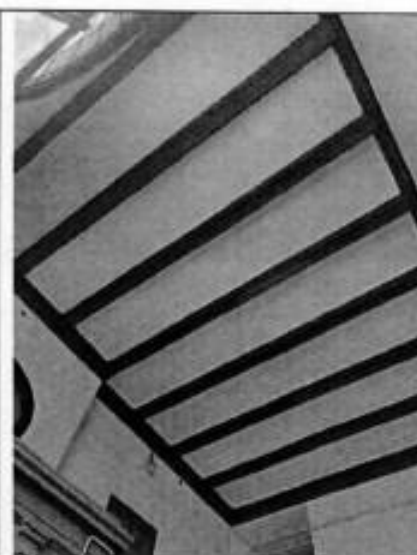
24. Лестничная клетка Л-1.
