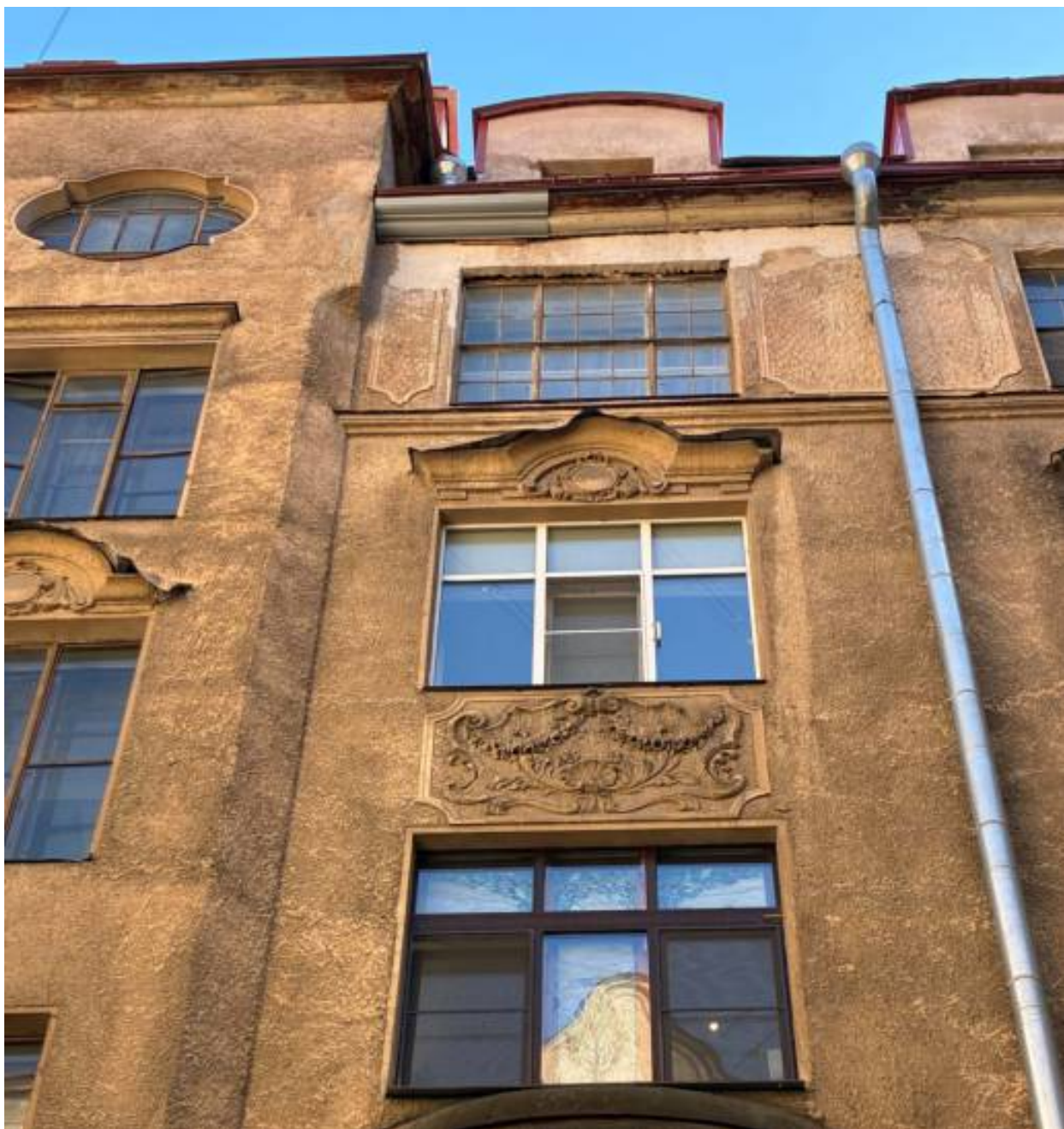
28. Внутренний двор. Северо-западный фасад. Фрагмент. Оформление оконного проема. Дата съемки: 06.05.2026
