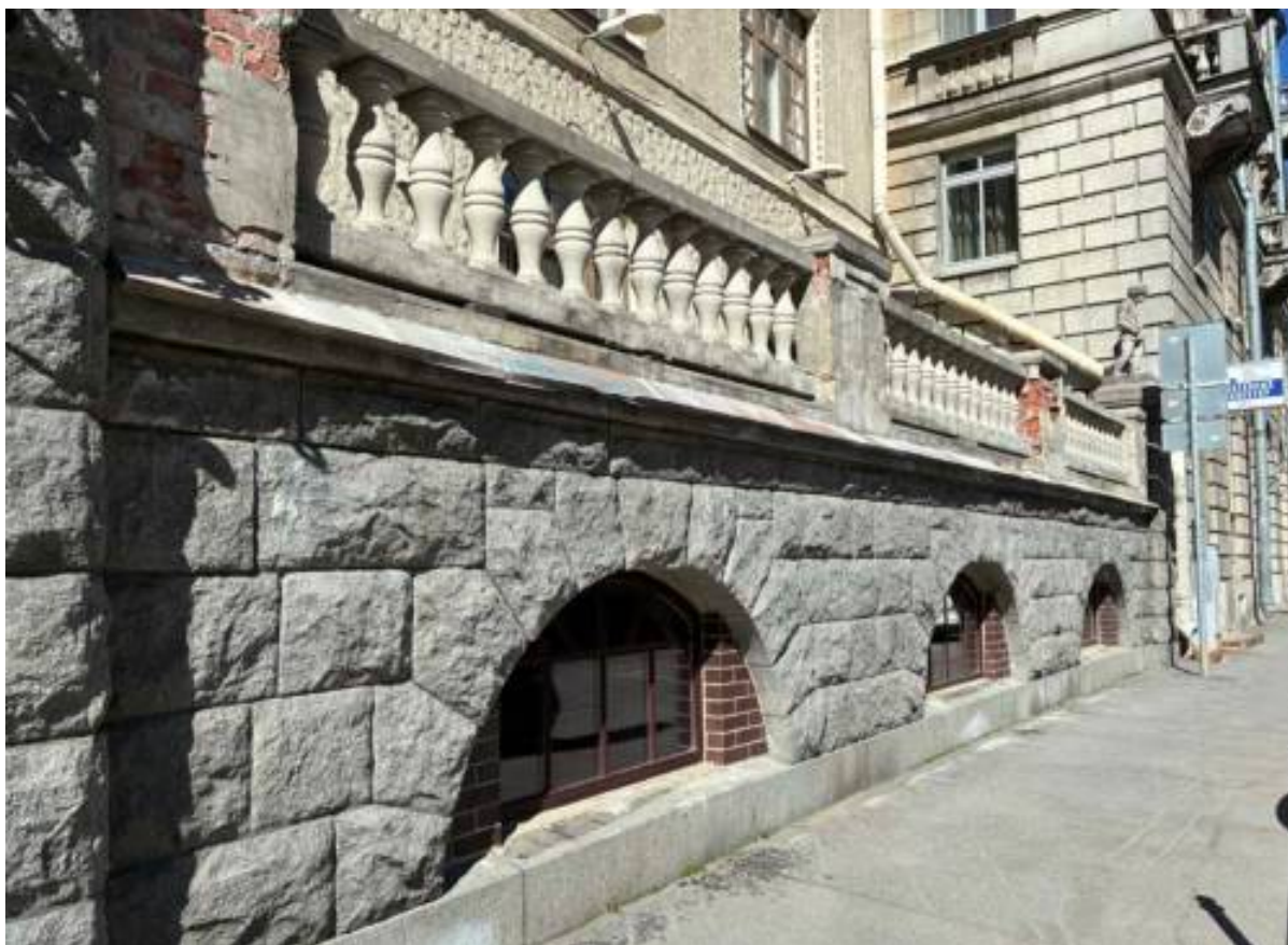
10. Лицевой фасад. Терраса. Фрагмент. Арочные проемы. Дата съемки: 06.05.2026
