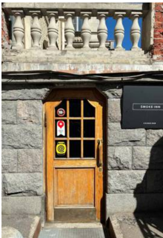
15. Терраса. Фрагмент. Запълнение дверного проема. Дата съемки: 06.05.2026
