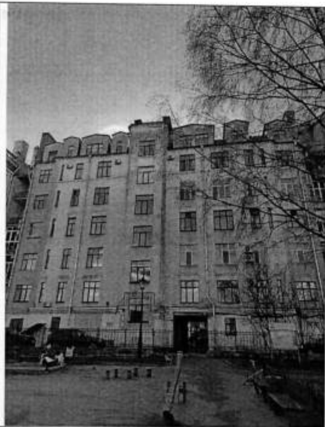
18. Фрагмент южного фасада.
