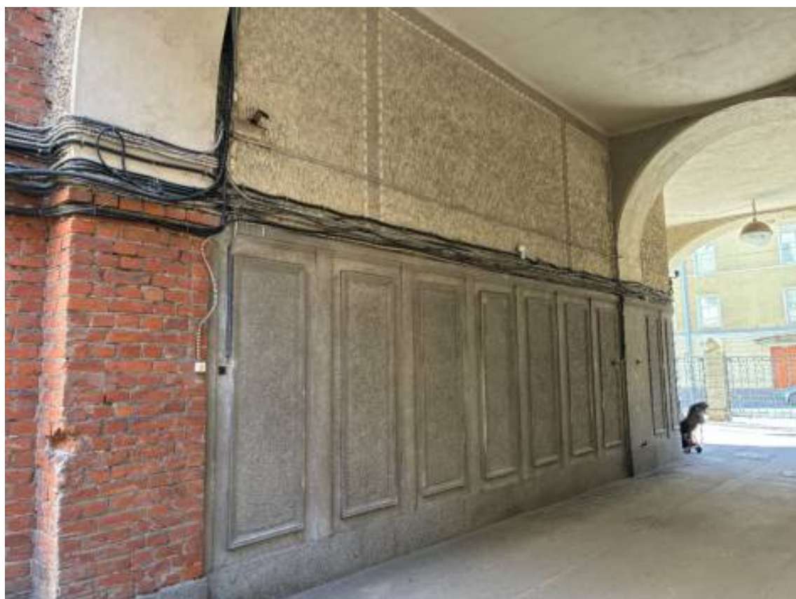
20. Проезд во двор со стороны лицевого фасада. Оформление стен фактурной штукатуркой. Дата съемки: 06.05.2026
