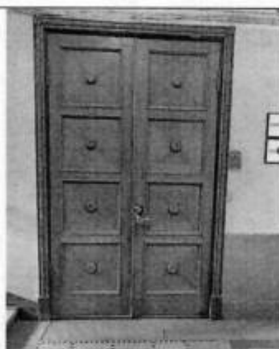
30. Лестничная клетка Л-1.
