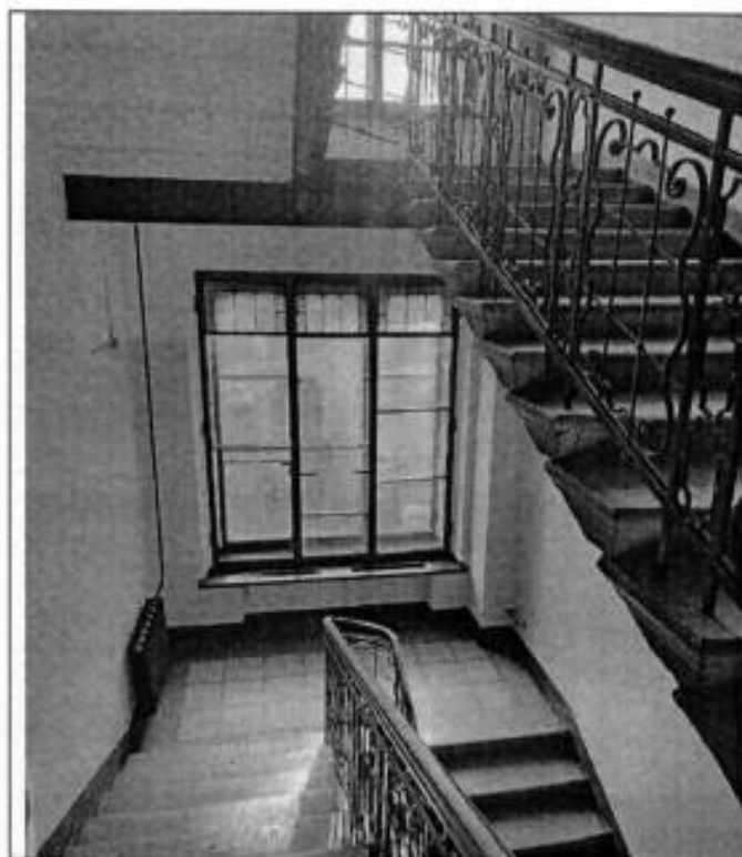
27. Лестничная клетка Л-1.
