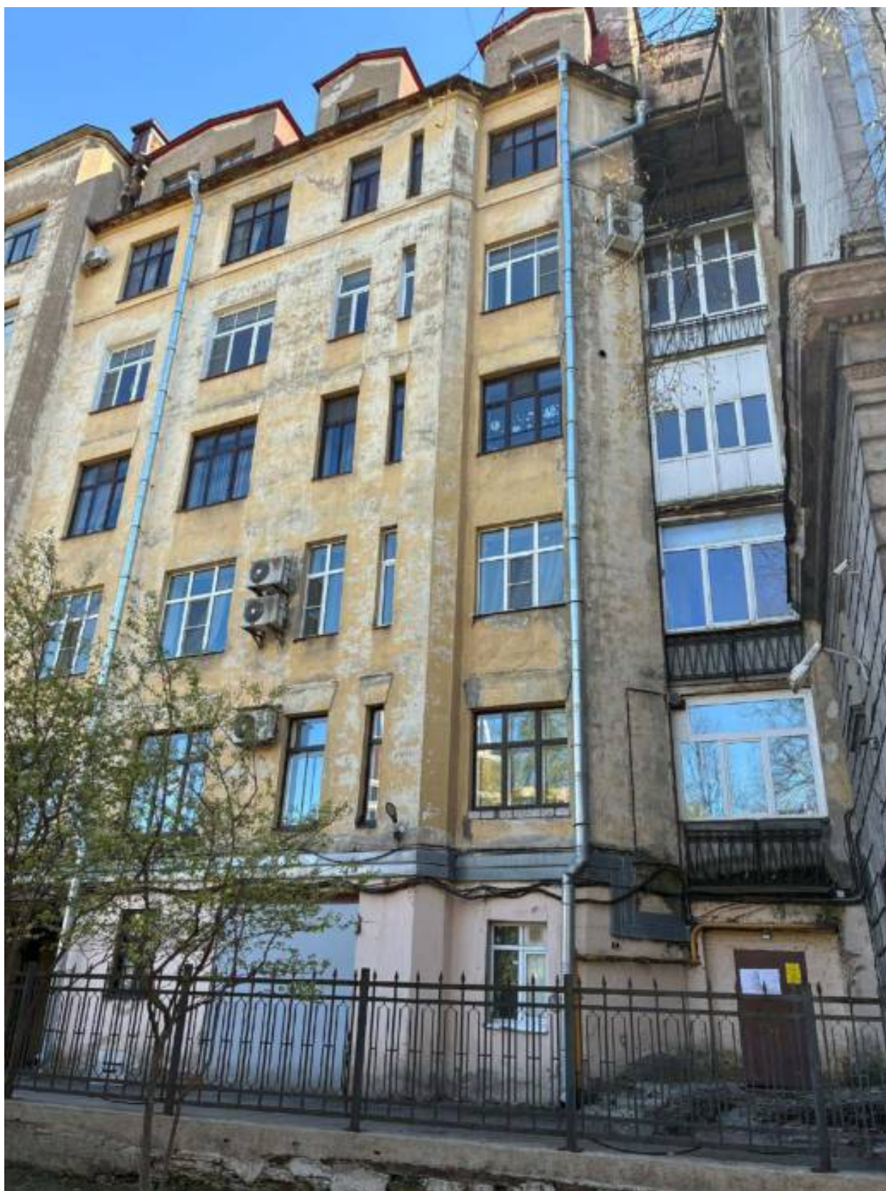
44. Северо-западный фасад со стороны сквера. Фрагмент. Дата съемки: 06.05.2026
