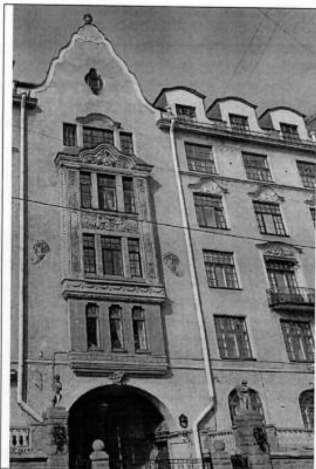
2. Фрагмент северного фасада.
