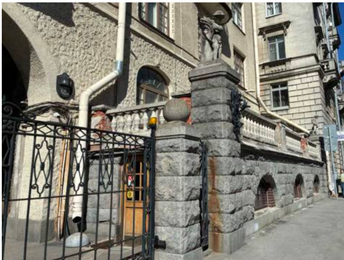
8. Лицевой фасад. Фрагмент. Терраса. Дата съемки: 06.05.2026
