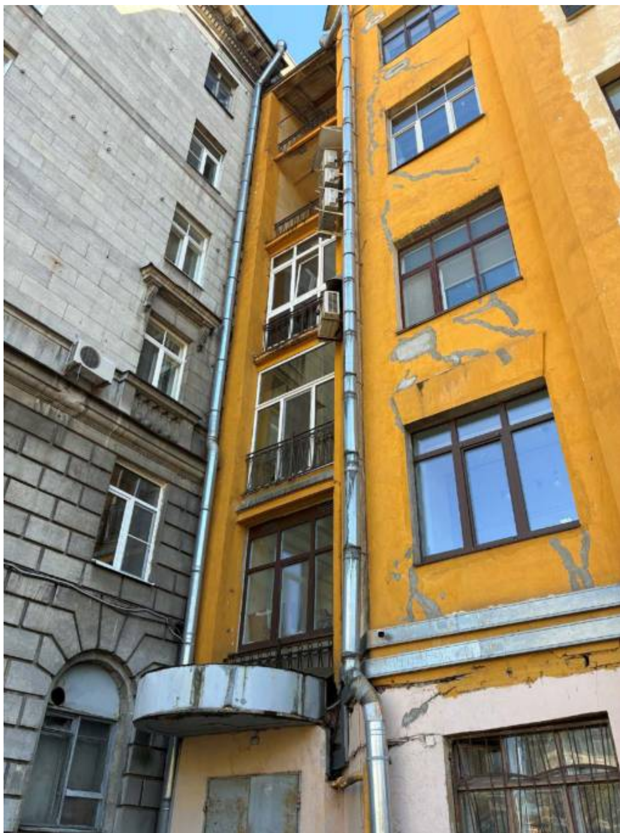
46. Северо-западный фасад со стороны сквера. Фрагмент. Дата съемки: 06.05.2026
