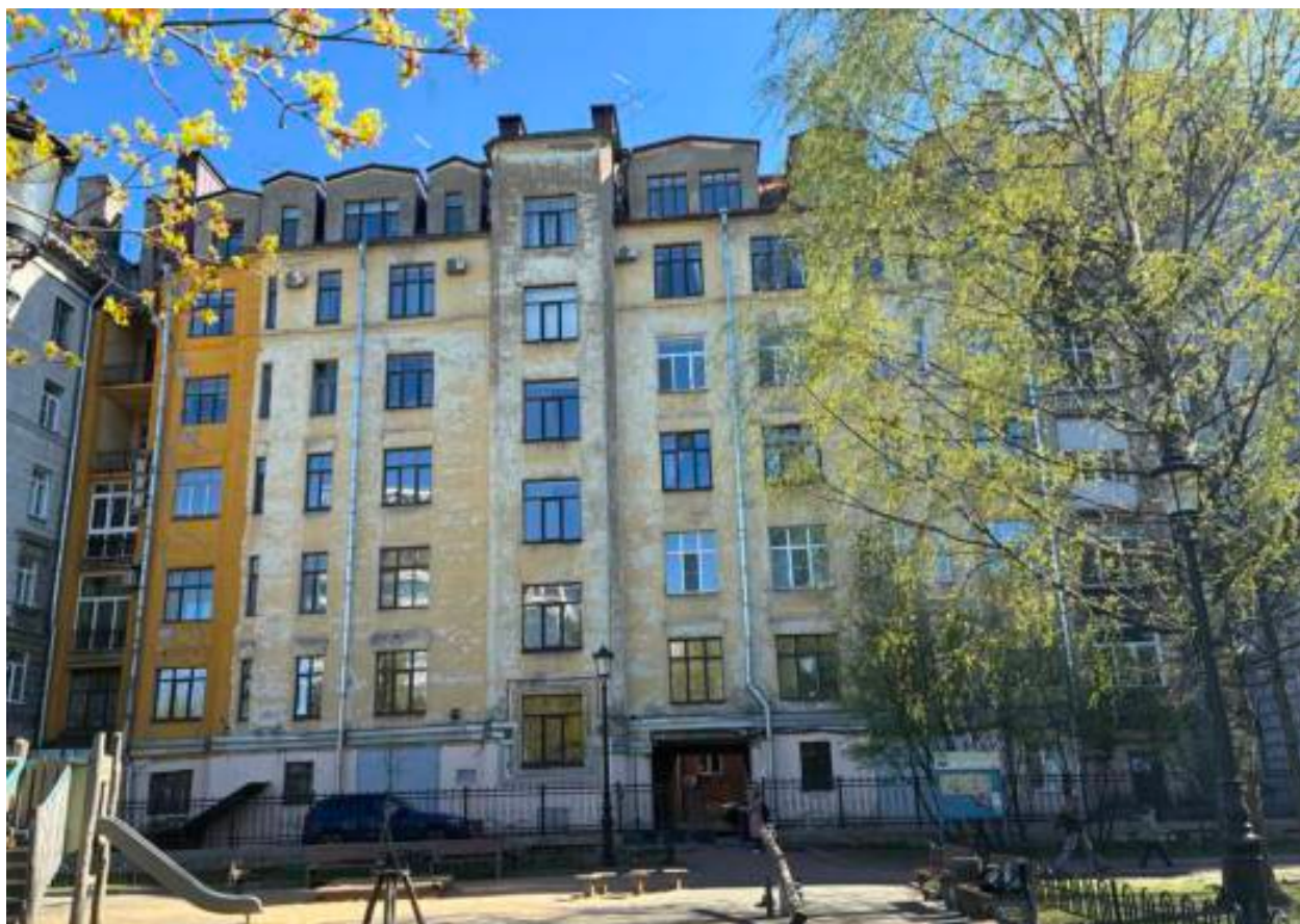
43. Северо-западный фасад со стороны сквера. Общий вид. Дата съемки: 06.05.2026
