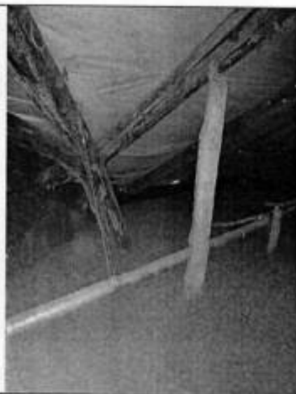
20. Фрагмент стропильной системы.
