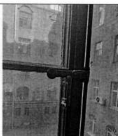
34. Лестничная клетка Л-1.
