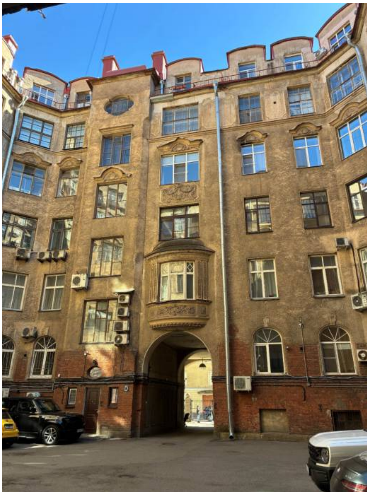
26. Внутренний двор. Северо-западный фасад. Общий вид. Дата съемки: 06.05.2026
