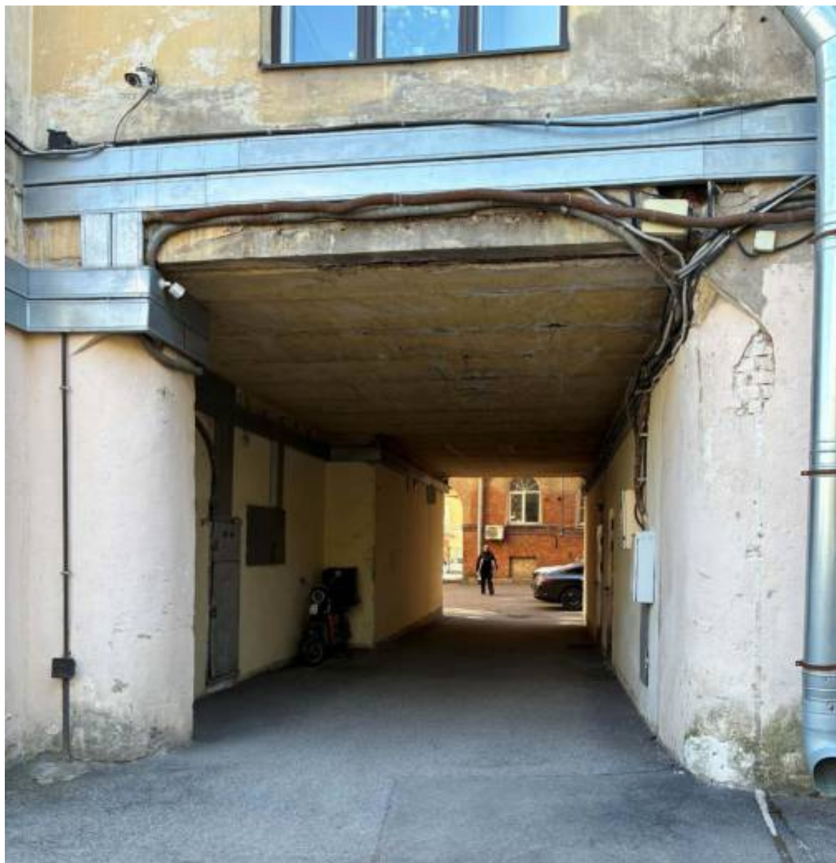
39. Проезд со стороны сквера. Дата съемки: 06.05.2026
