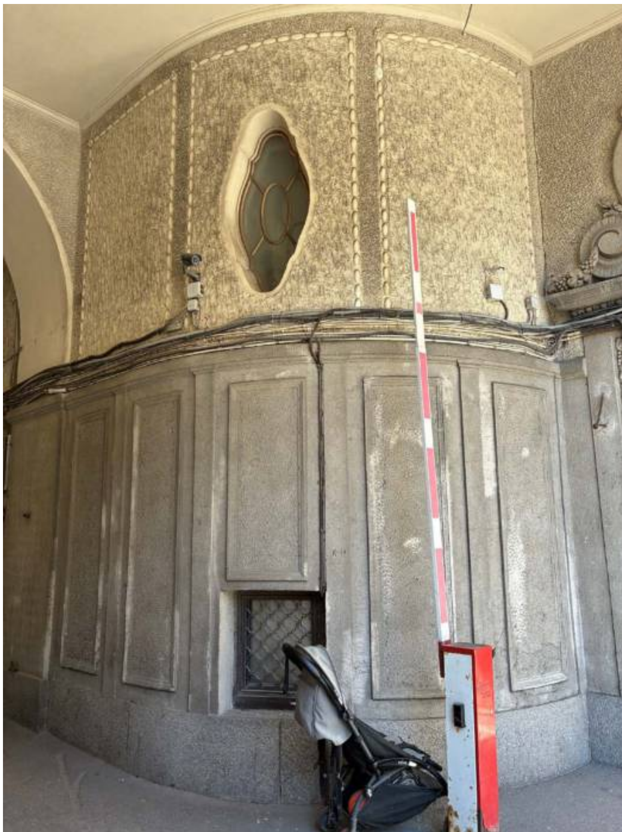
18. Проезд во двор со стороны лицевого фасада. Витражное заполнение фигурного оконного проема. Дата съемки: 06.05.2026
