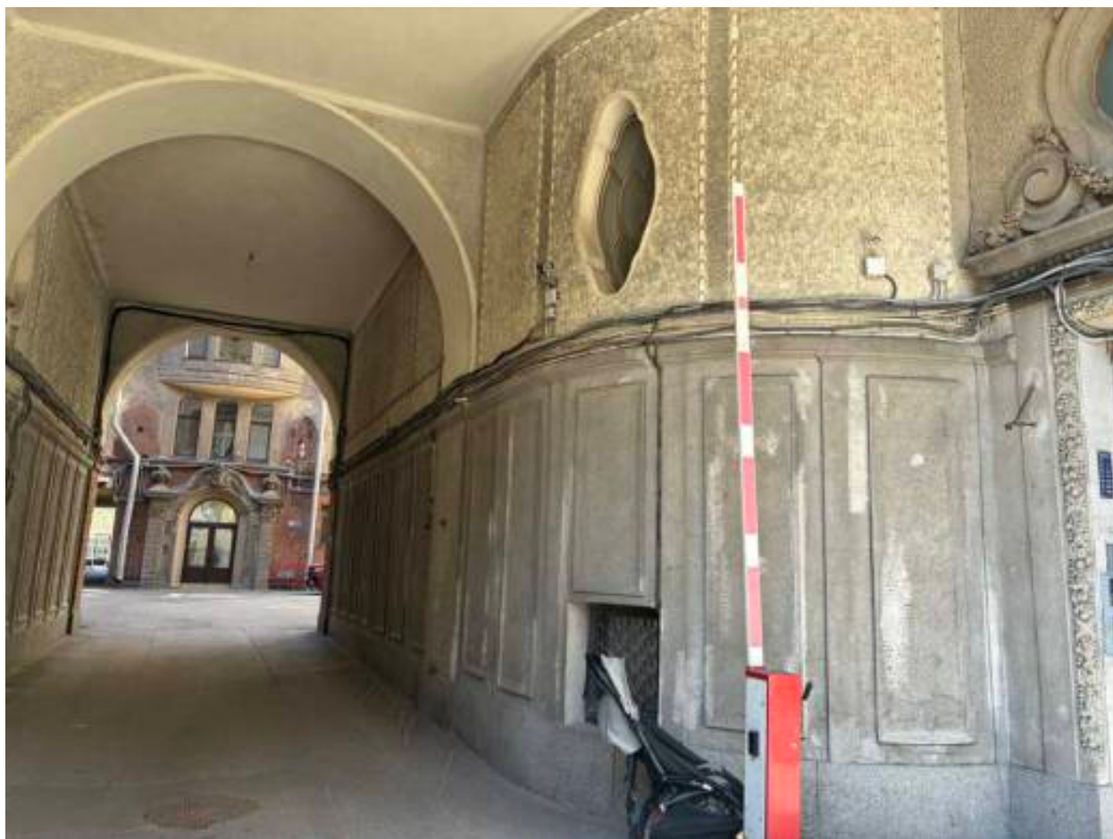
17. Проезд во двор со стороны лицевого фасада. Оформление стен фактурной штукатуркой. Дата съемки: 06.05.2026
