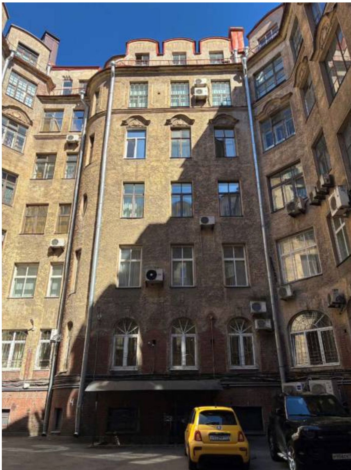
30. Внутренний двор. Юго-западный фасад. Общий вид. Дата съемки: 06.05.2026
