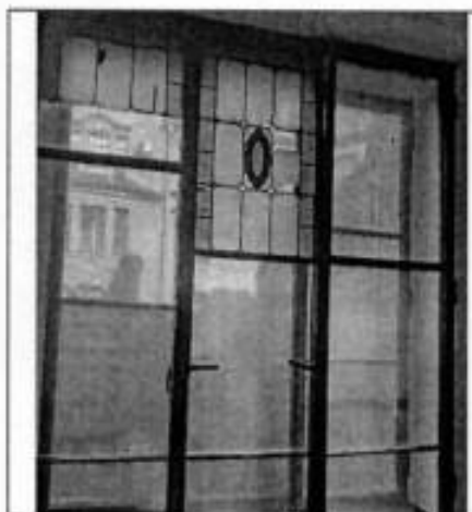
32. Лестничная клетка Л-1.
