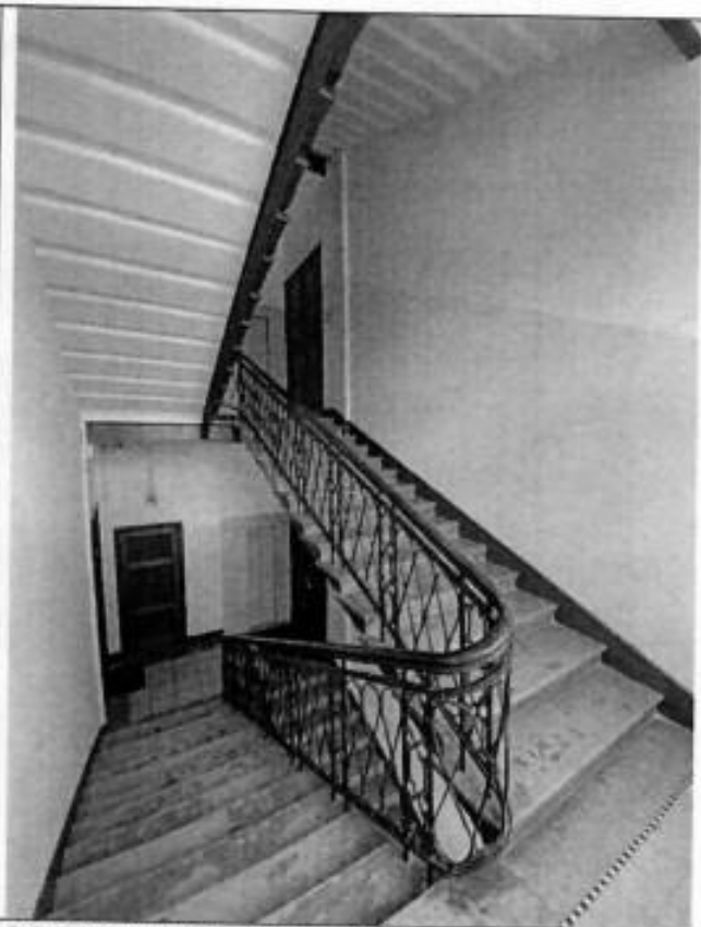
36. Лестничная клетка Л-2.
