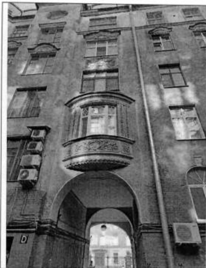
17. Фрагмент южного дворового фасада.
