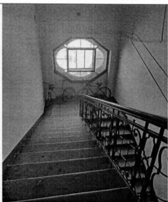
28. Лестничная клетка Л-1.
