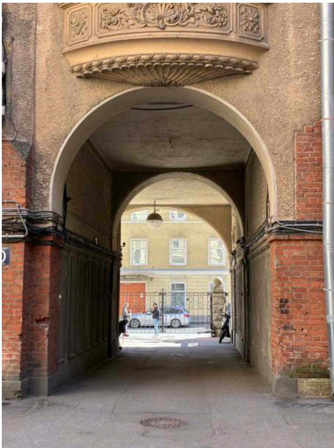
25. Проезд во двор со стороны лицевого фасада. Вид со стороны двора. Дата съемки: 06.05.2026
