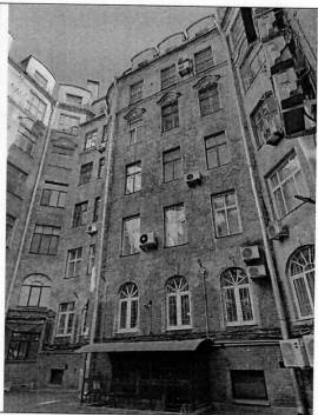
16. Западный дворовой фасад.
