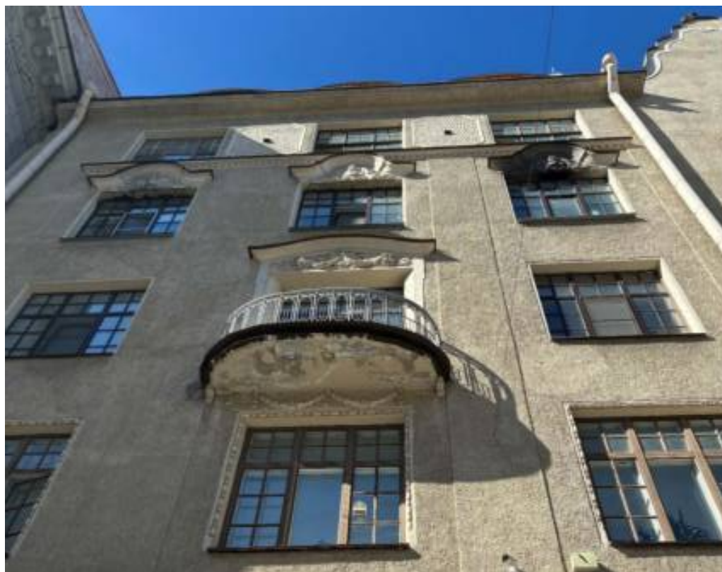
2. Лицевой фасад. Фрагмент. Дата съемки: 06.05.2026
