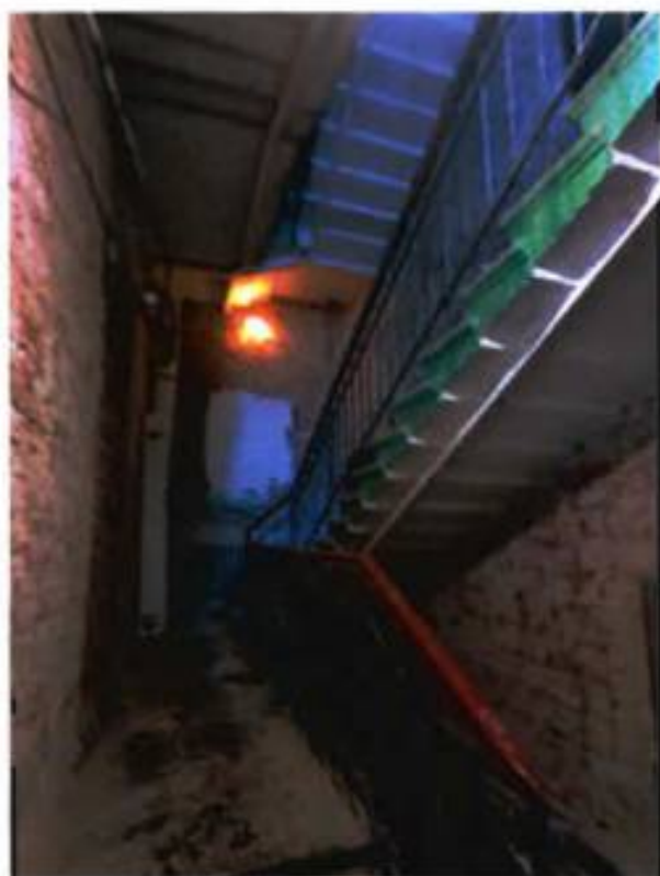
9. Лестничная клетка 2ЛК.
