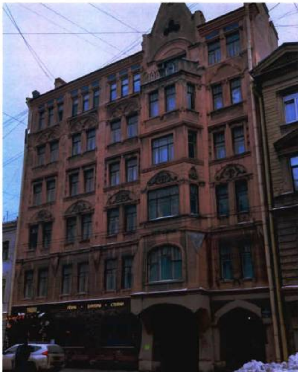
1. Лицевой фасад объекта культурного наследия.
