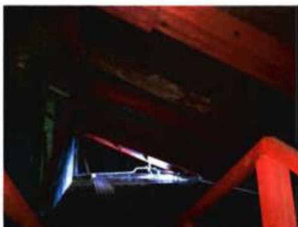
4. Фрагмент стропильной системы.
