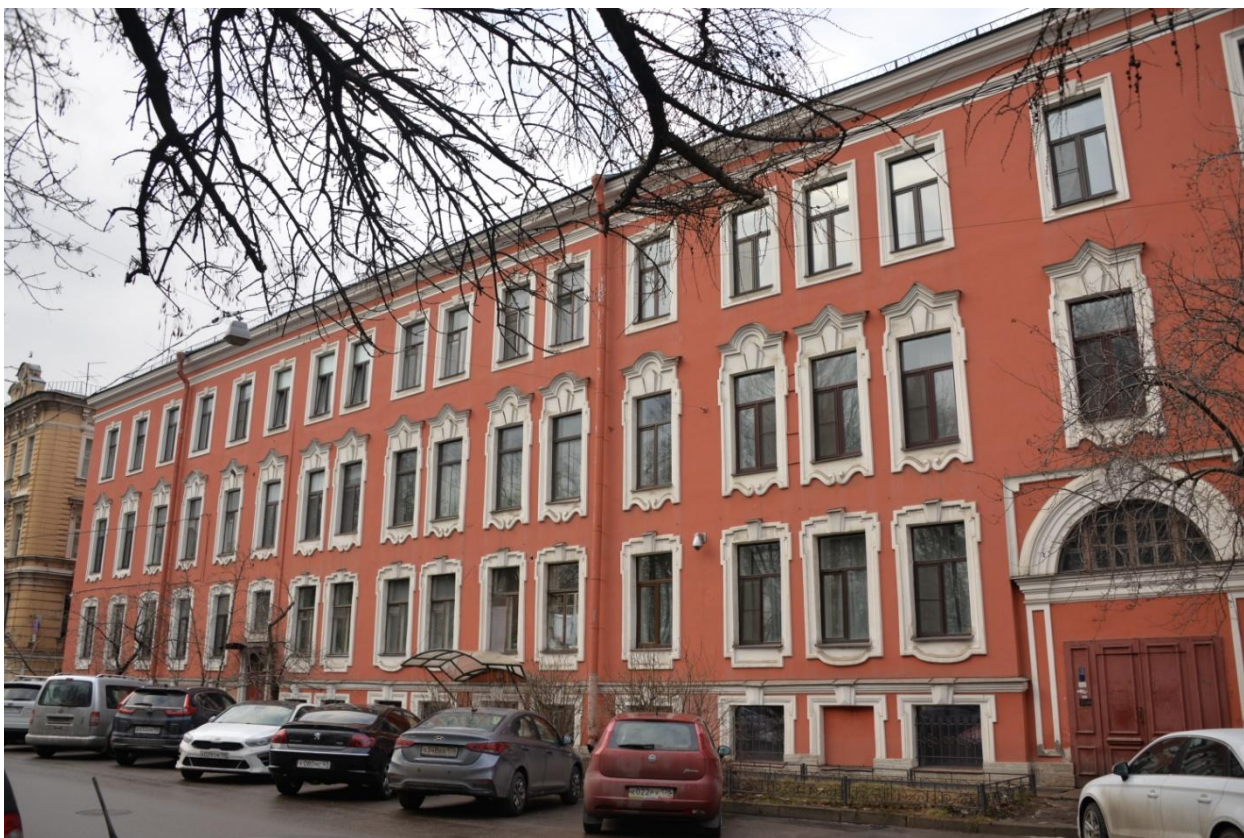
3. Фрагмент фасада выявленного объекта культурного наследия «Дом А.В. Макарова (Г.Ю. Урлауб)» со стороны Румянцевской площади
