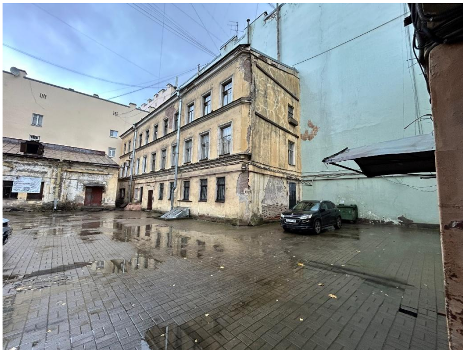
Фото №14. Вид на дворовый флигель дома №18 (сейчас: ул. Гончарная, 18, лит. В)
