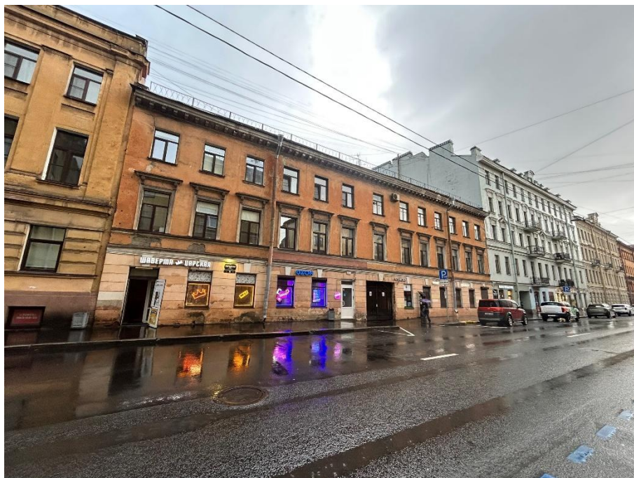
Фото №1. Общий вид на лицевой фасад Объекта с ул. Гончарной.
