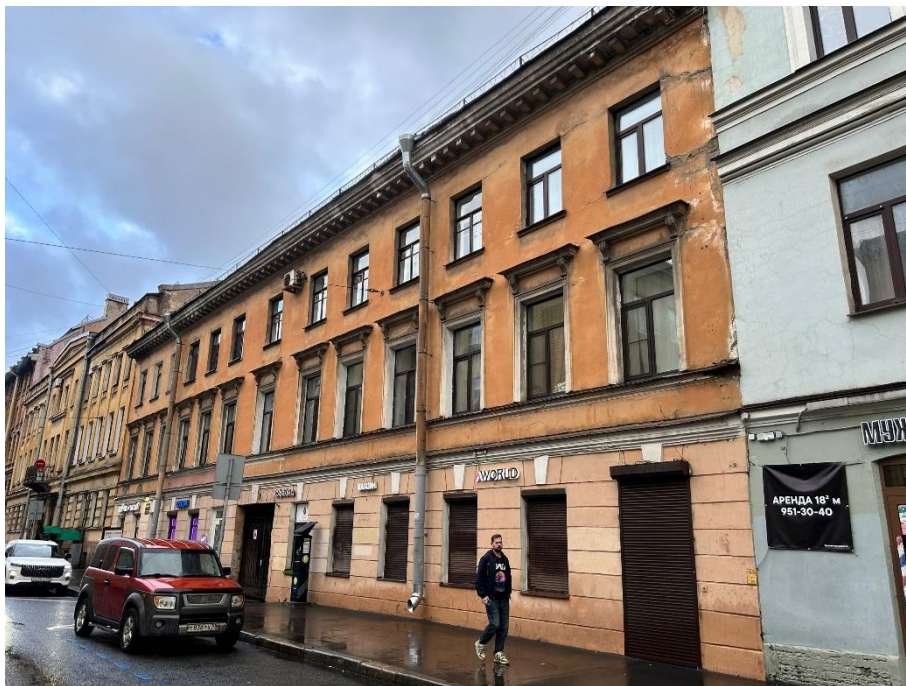
Фото №4. Общий вид на лицевой фасад Объекта с ул. Гончарной.
