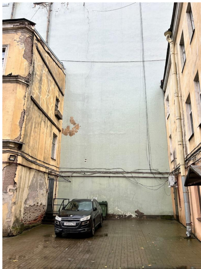
Фото №17. Территория между Объектом и домом №18 литера В по ул. Гончарной.
