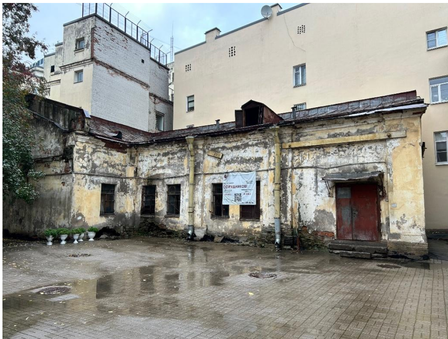
Фото №16. Вид на здание бывших дворовых служб дома №18 (сейчас: ул. Гончарная, 18, лит. Б)
