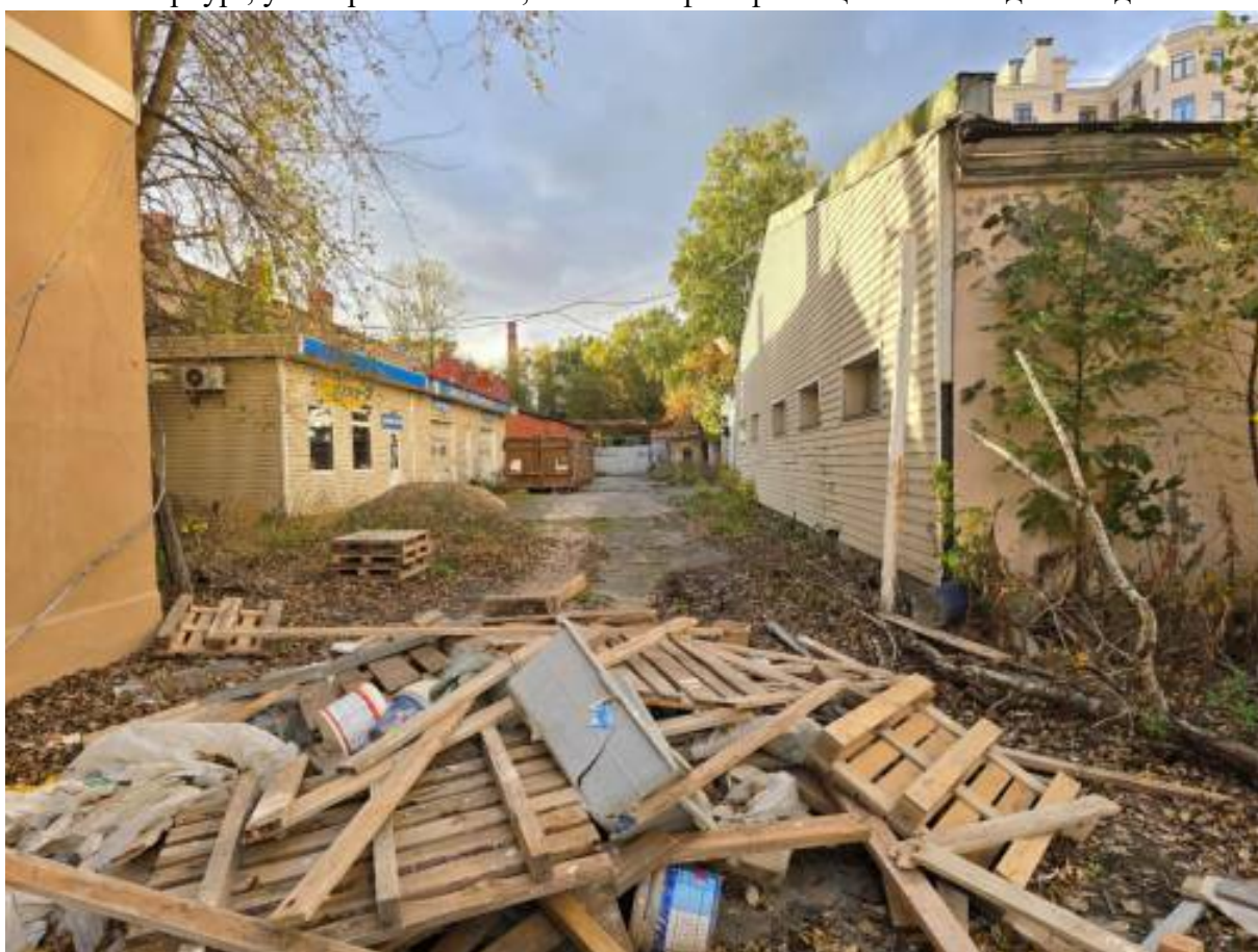
Санкт-Петербург, ул. Черняховского, 21. Точка фотофиксации № 5. Вид с востока.
