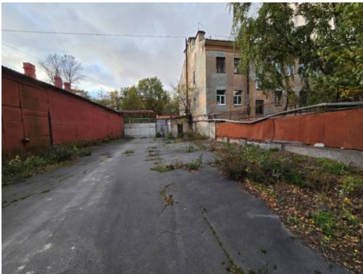
Санкт-Петербург, ул. Черняховского, 21. Точка фотофиксации № 14. Вид с востока.
