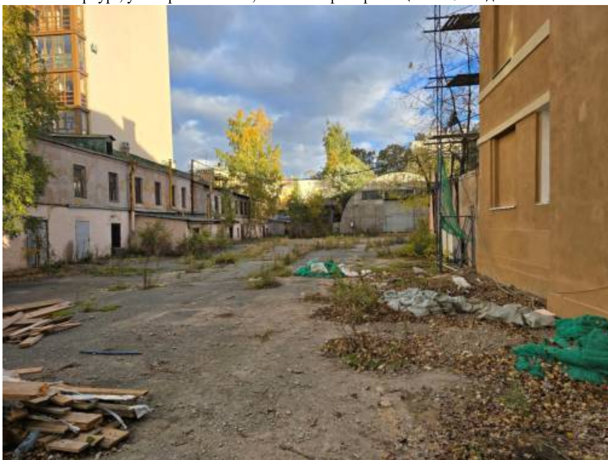
Санкт-Петербург, ул. Черняховского, 21. Точка фотофиксации № 7. Вид с запада.
