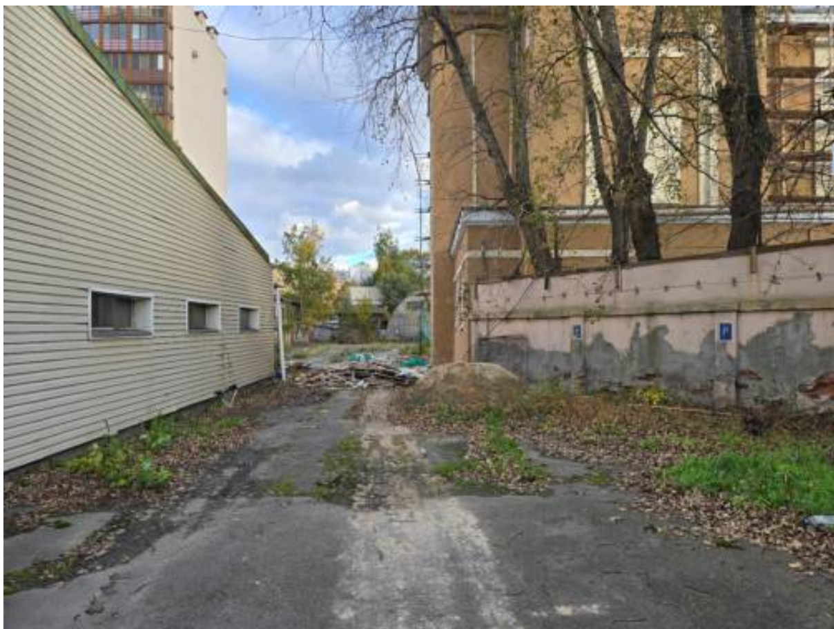
Санкт-Петербург, ул. Черняховского, 21. Точка фотофиксации № 4. Вид с запада.
