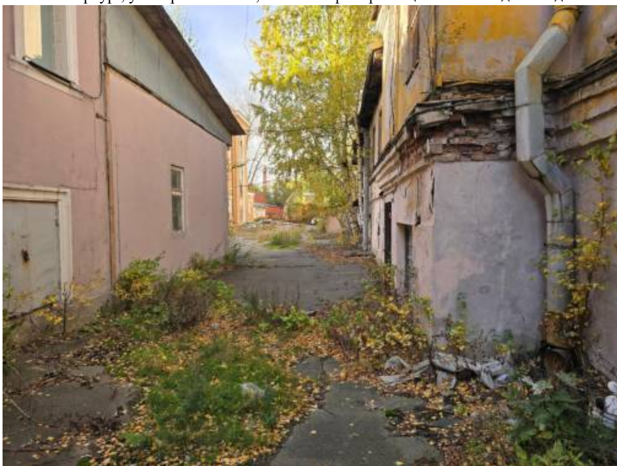
Санкт-Петербург, ул. Черняховского, 21. Точка фотофиксации № 13. Вид с востока.
