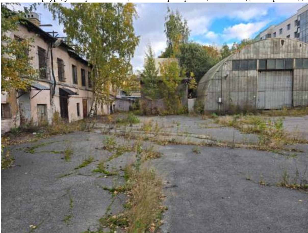
Санкт-Петербург, ул. Черняховского, 21. Точка фотофиксации № 9. Вид с запада.
