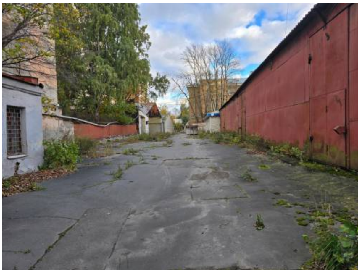
Санкт-Петербург, ул. Черняховского, 21. Точка фотофиксации № 1. Вид с запада.
