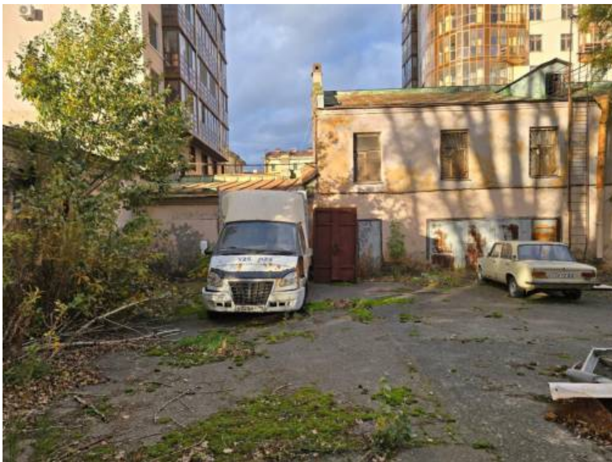
Санкт-Петербург, ул. Черняховского, 21. Точка фотофиксации № 6. Вид с юга.
