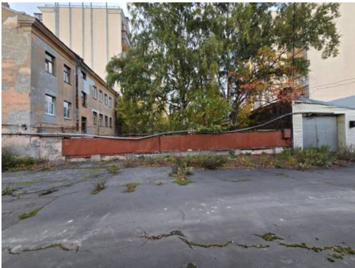
Санкт-Петербург, ул. Черняховского, 21. Точка фотофиксации № 2. Вид с юга.
