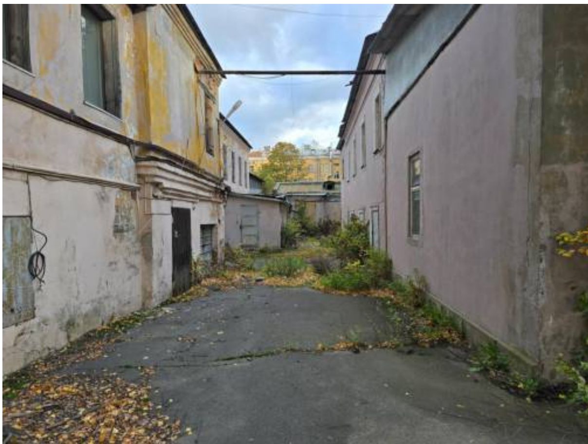
Санкт-Петербург, ул. Черняховского, 21. Точка фотофиксации № 12. Вид с запада.
