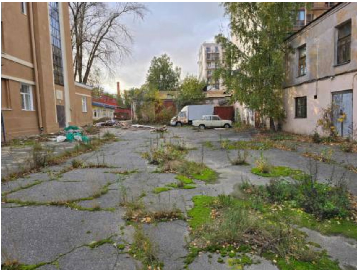
Санкт-Петербург, ул. Черняховского, 21. Точка фотофиксации № 10. Вид с востока.
