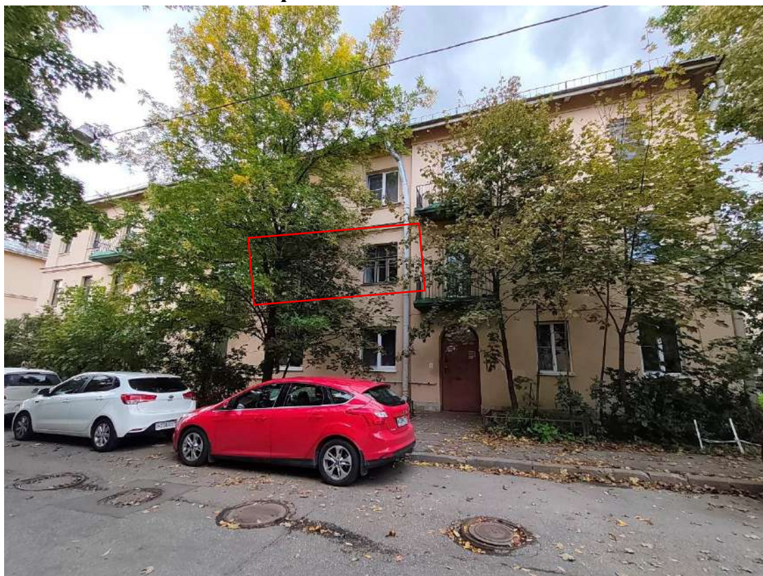
Фото 1. Вид на юго-восточный фасад выявленного объекта культурного наследия «Жилой дом». Красным отмечен балкон и оконный проем квартиры № 9.
