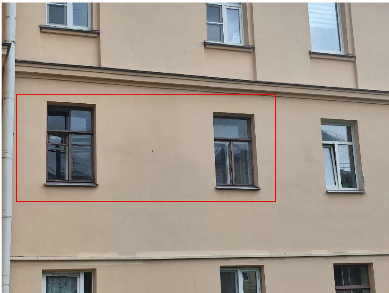
Фото 7. Вид на северо-западный фасад выявленного объекта культурного наследия «Жилой дом». Красным отмечены оконные проемы квартиры № 9.
