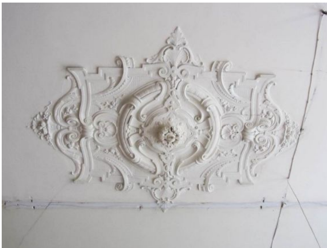
26. ОКН регионального значения «Жилой дом страхового общества “Россия” с садом и оградами» (г. Санкт-Петербург, Моховая ул., 27-29). Квартира № 34.
