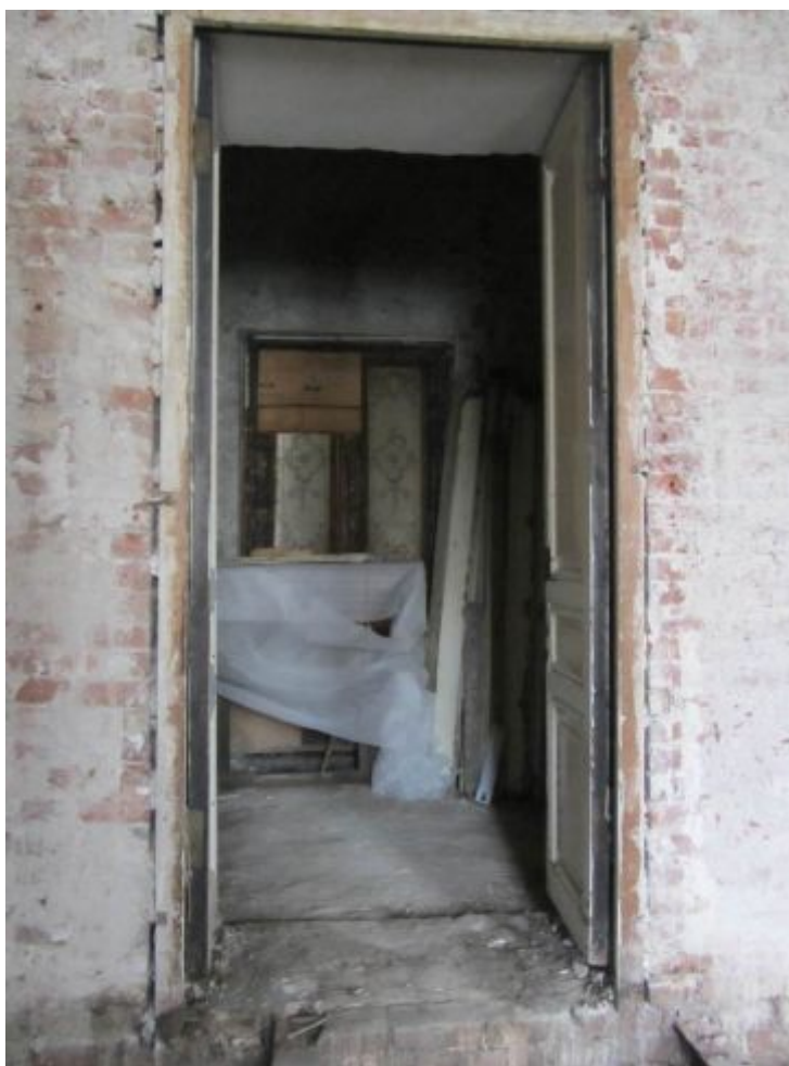
41. ОКН регионального значения «Жилой дом страхового общества “Россия” с садом и оградами» (г. Санкт-Петербург, Моховая ул., 27-29). Квартира № 34.
