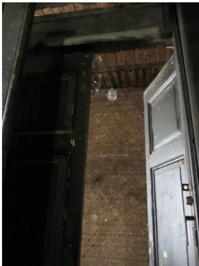
9. ОКН регионального значения «Жилой дом страхового общества «Россия» с садом и оградами» (г. Санкт-Петербург, Моховая ул., 27-29). Квартира № 34.
