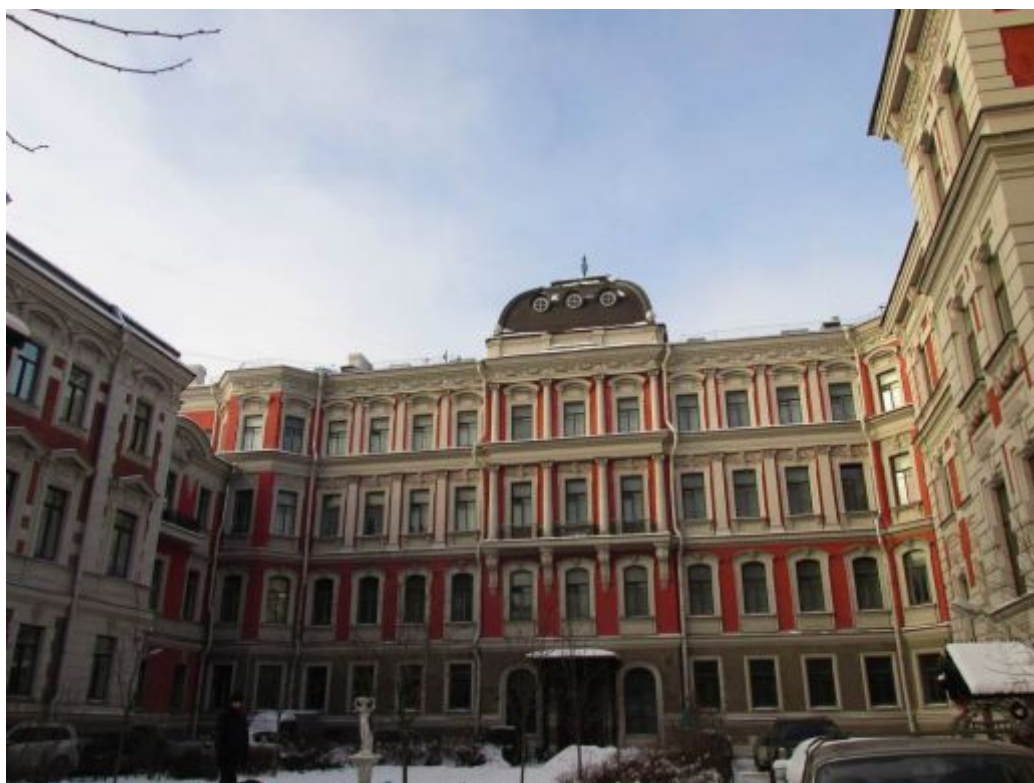
2. ОКН регионального значения «Жилой дом страхового общества “Россия” с садом и оградами» (г. Санкт-Петербург, Моховая ул., 27-29) Лицевой фасад. Курдонер.
