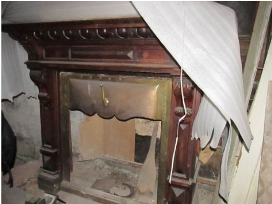
39. ОКН регионального значения «Жилой дом страхового общества «Россия» с садом и оградой» (г. Санкт-Петербург, Моховая ул., 27-29). Квартира № 34. Каминный портал демонтирован на время реставрационных работ.
