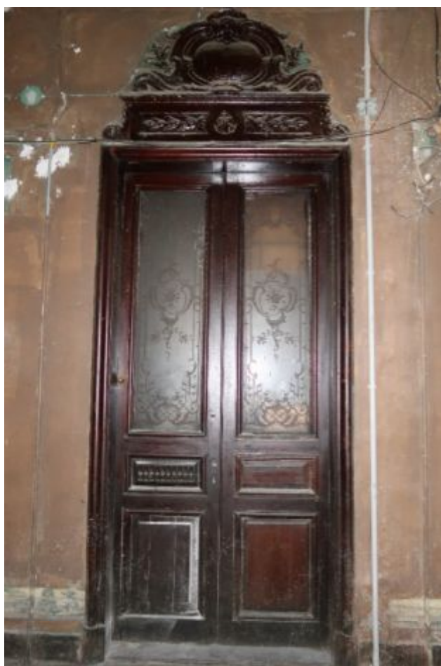
8. ОКН регионального значения «Жилой дом страхового общества “Россия” с садом и оградой» (г. Санкт-Петербург, Моховая ул., 27-29) Парадная лестница. Вход в кв. №34.
