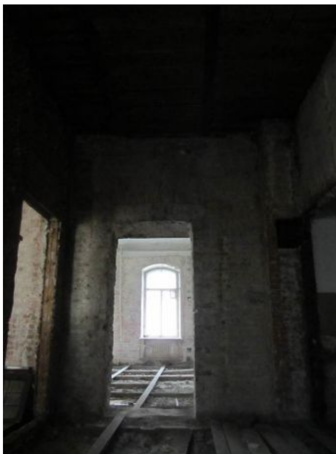
44. ОКН регионального значения «Жилой дом страхового общества “Россия” с садом и оградами» (г. Санкт-Петербург, Моховая ул., 27-29). Квартира № 34.
