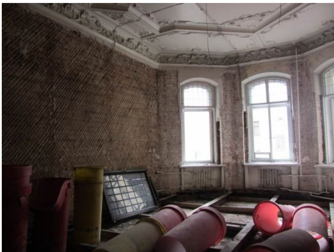
19. ОКН регионального значения «Жилой дом страхового общества “Россия” с садом и оградами» (г. Санкт-Петербург, Моховая ул., 27-29). Квартира № 34.
