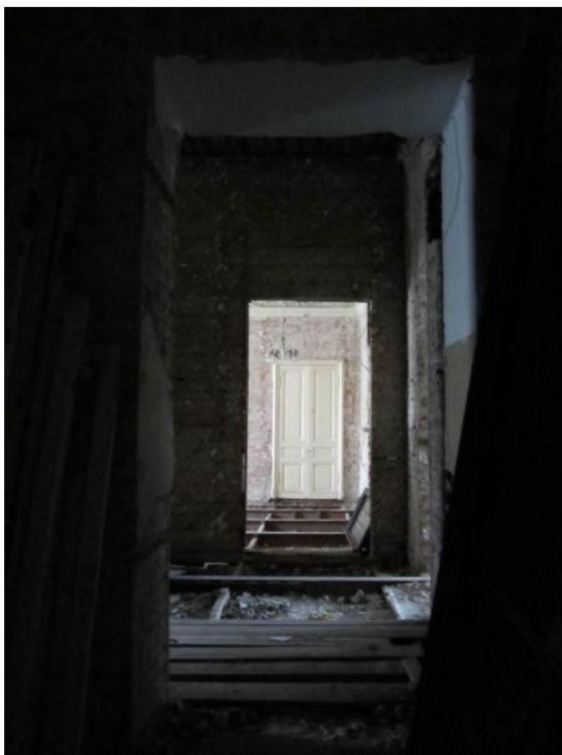
15. ОКН регионального значения «Жилой дом страхового общества “Россия” с садом и оградами» (г. Санкт-Петербург, Моховая ул., 27-29). Квартира № 34.
