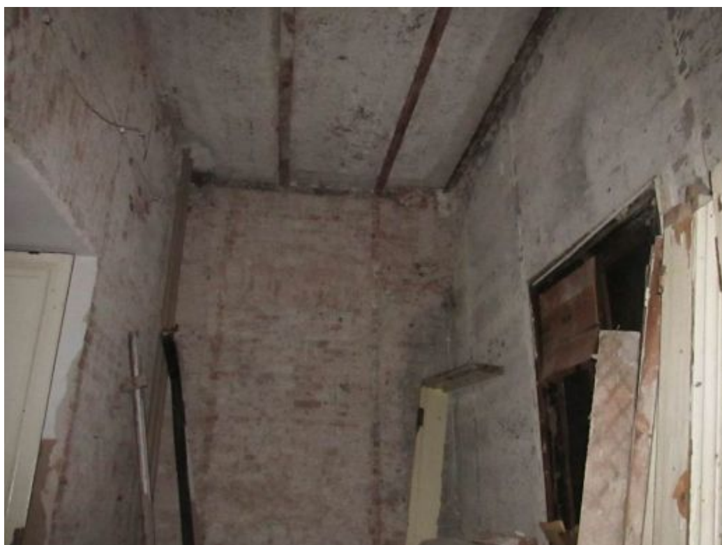
42. ОКН регионального значения «Жилой дом страхового общества “Россия” с садом и оградами» (г. Санкт-Петербург, Моховая ул., 27-29). Квартира № 34.
