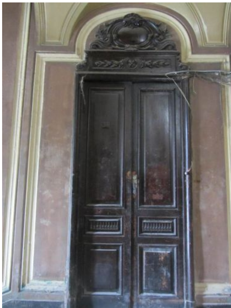
7. ОКН регионального значения «Жилой дом страхового общества “Россия” с садом и оградой» (г. Санкт-Петербург, Моховая ул., 27-29) Парадная лестница. Вход в кв. №34.
