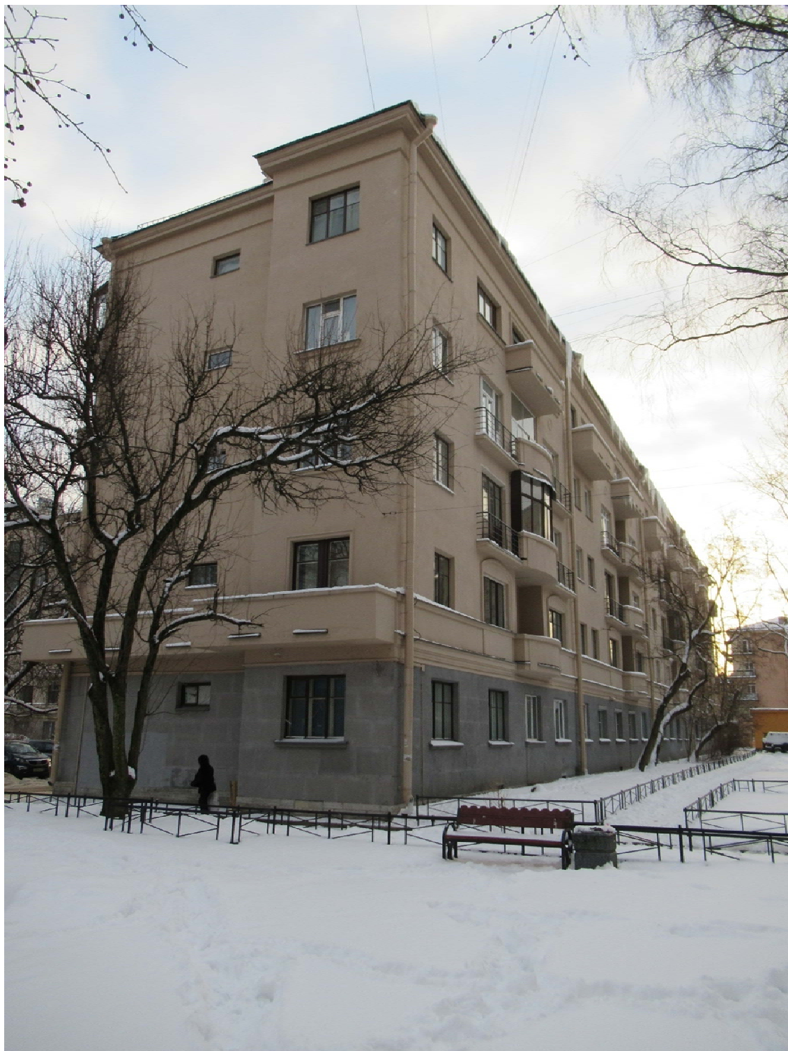
2. Вид на северный фасад. Дата съемки: 01.12.2021
