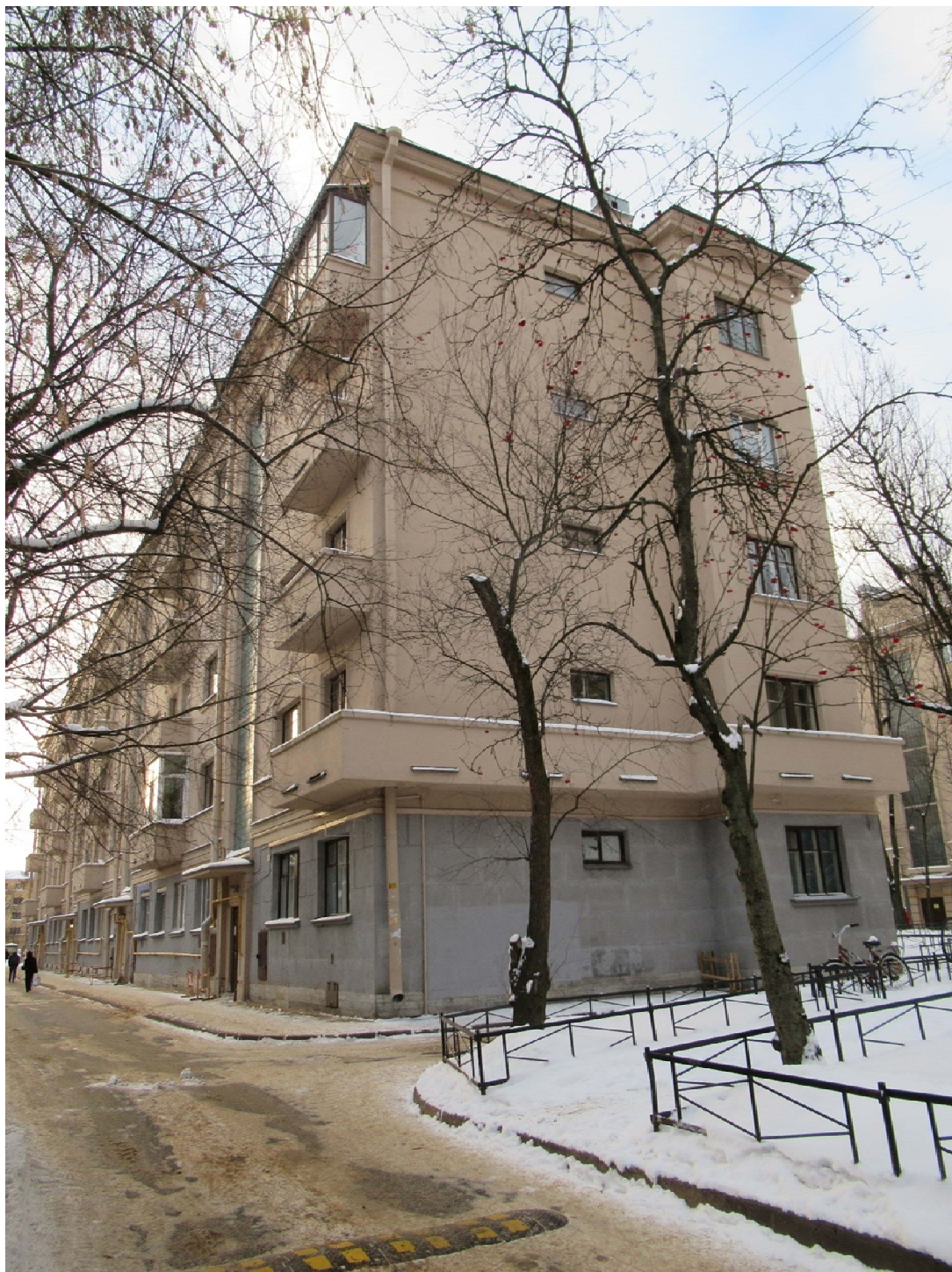
3. Вид на северный фасад. Дата съемки: 01.12.2021
