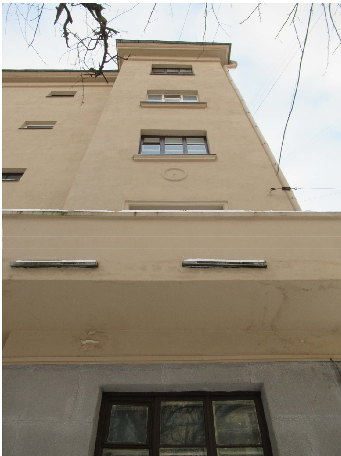
4. Вид на северный фасад. Дата съемки: 01.12.2021
