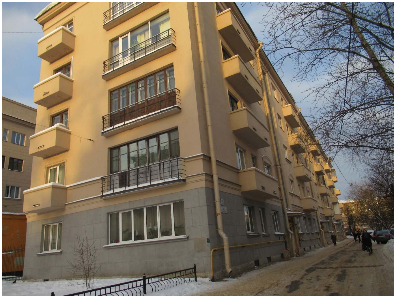
12. Вид на восточный фасад. Дата съемки: 01.12.2021
