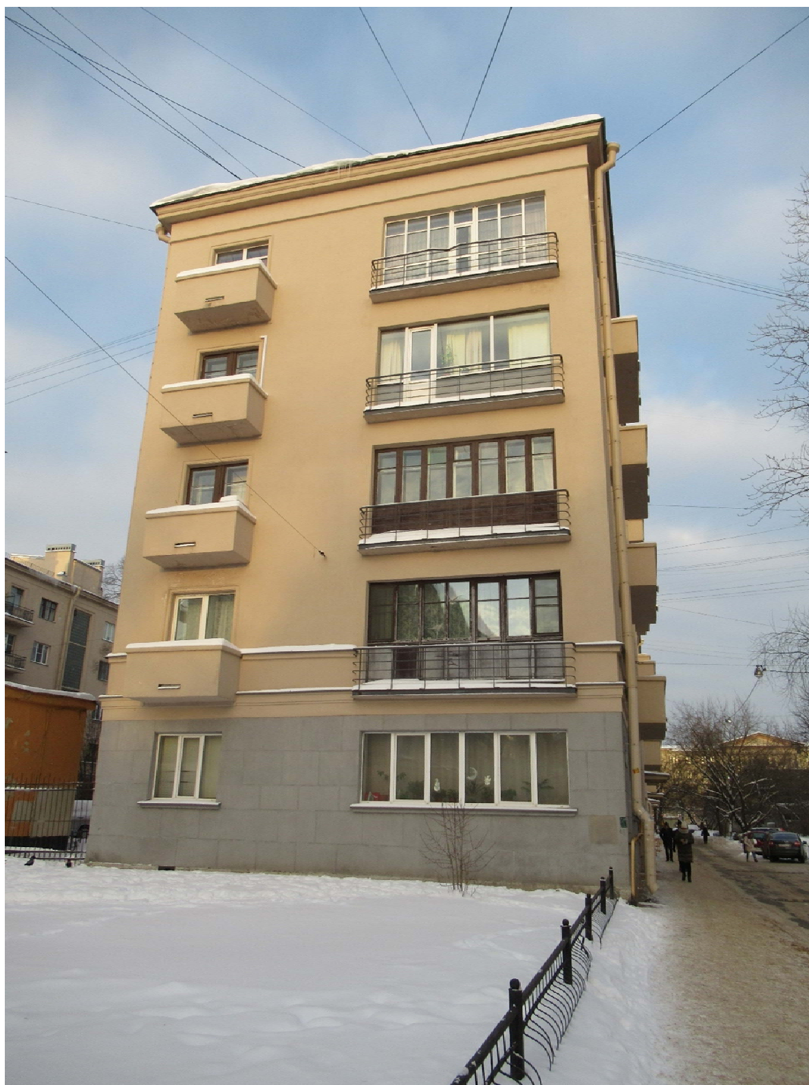
13. Вид на южный фасад. Дата съемки: 01.12.2021
