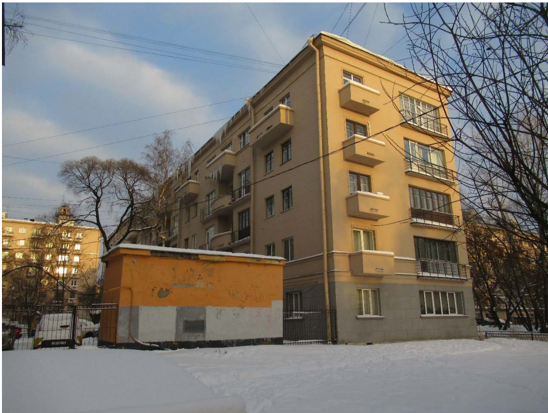
16. Вид на южный фасад. Дата съемки: 01.12.2021
