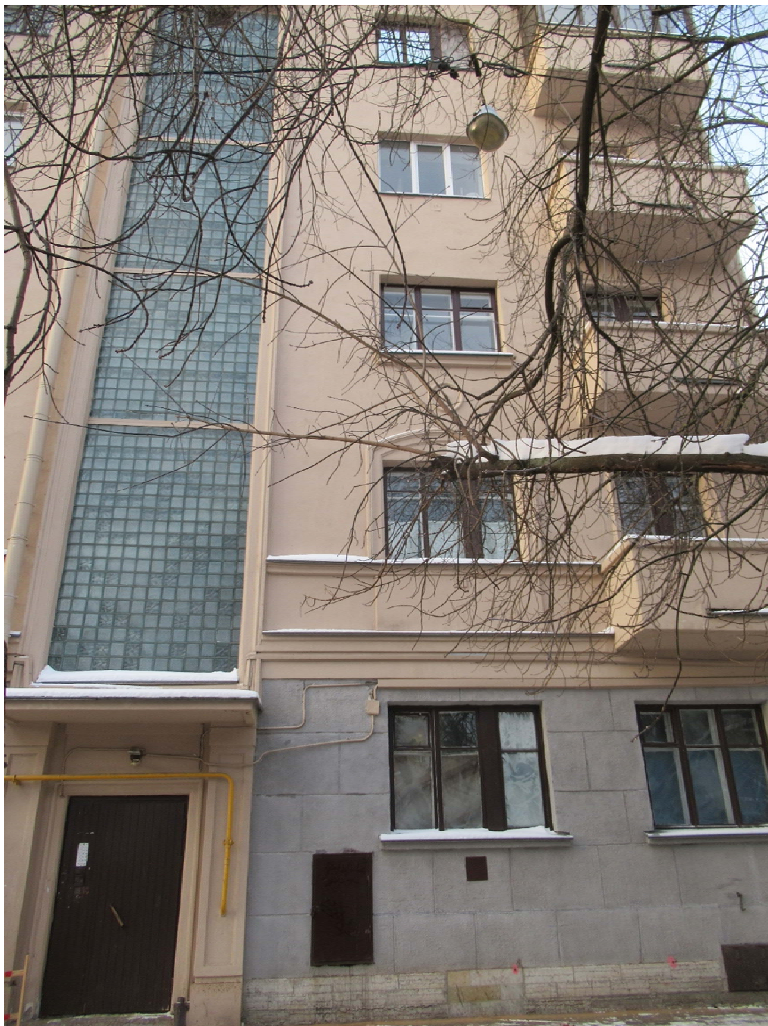
7. Вид на восточный фасад. Дата съемки: 01.12.2021
