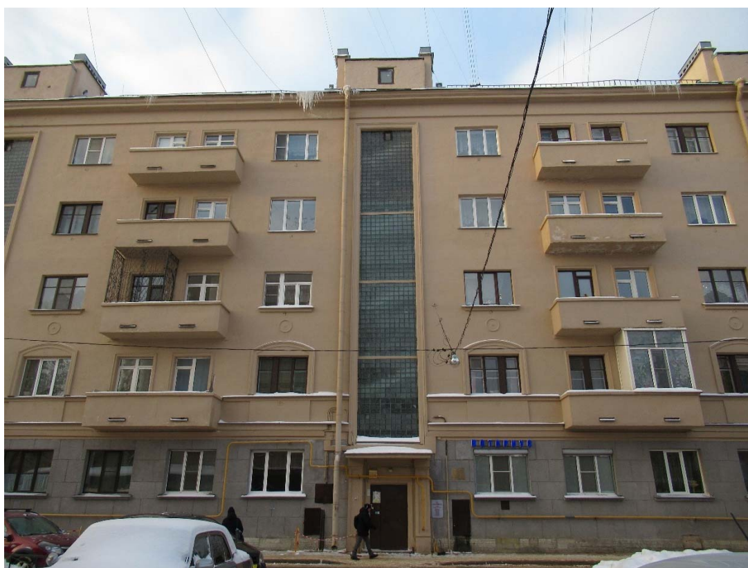
9. Вид на восточный фасад. Дата съемки: 01.12.2021
