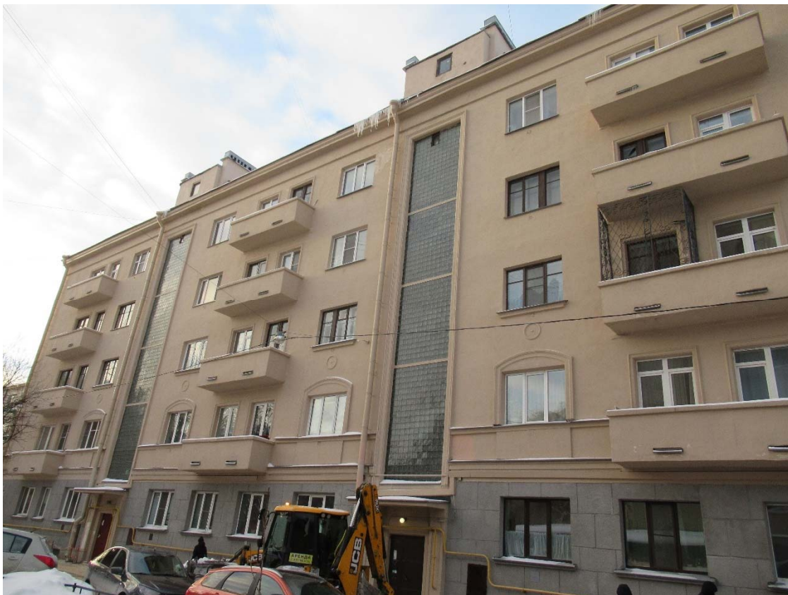
10. Вид на восточный фасад. Дата съемки: 01.12.2021
