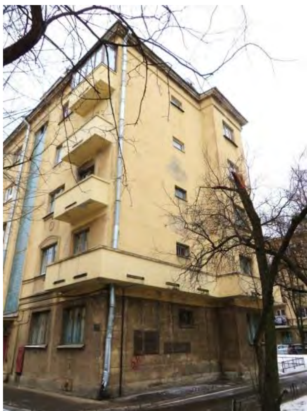
48. 2010-е гг. Северный торец дома №61 корп.2 на Лесном пр. Частное фото. ( http://www.citywalls.ru/photo185739.html ).
