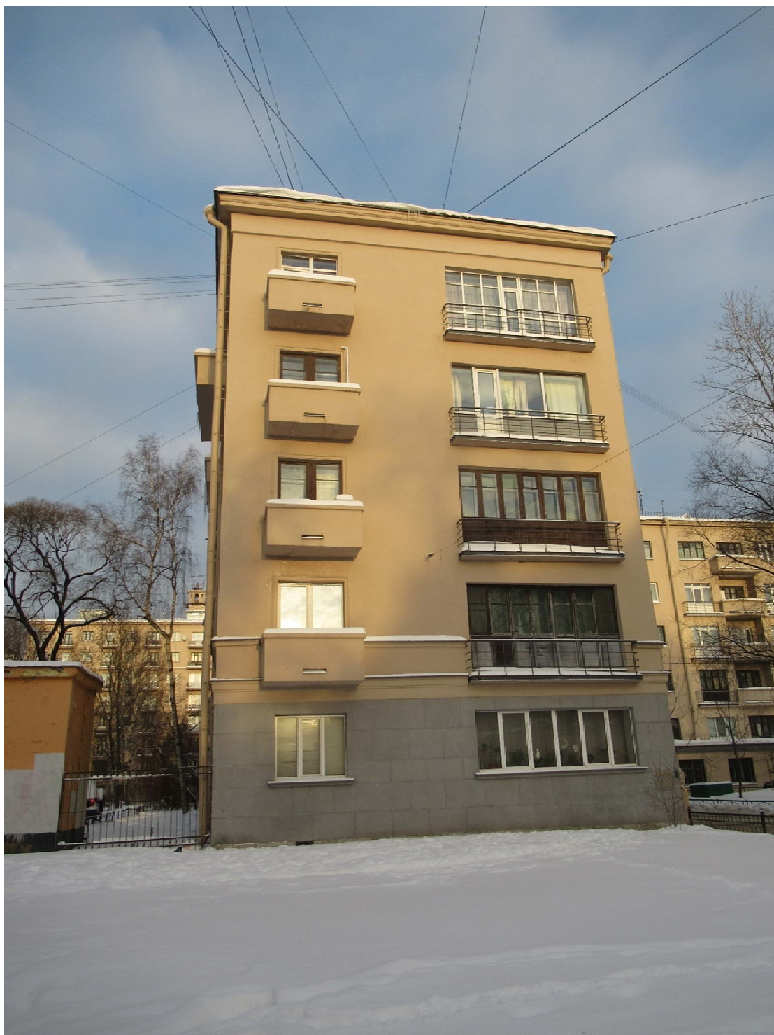
14. Вид на южный фасад. Дата съемки: 01.12.2021
