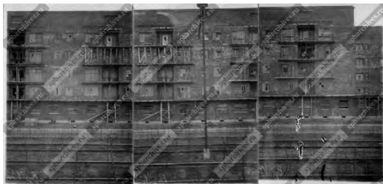
22. 1934-1937 гг. Фасад корп.№1 Дома специалистов на Лесном пр., 61 на этапе строительства. (ЦГАКФФД).
