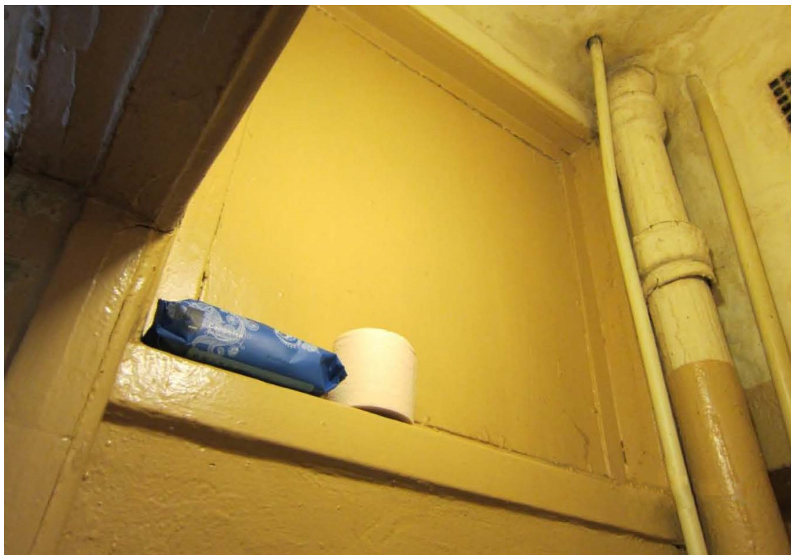
9. Помещение №8. Фото: 01.12.2021 г.
