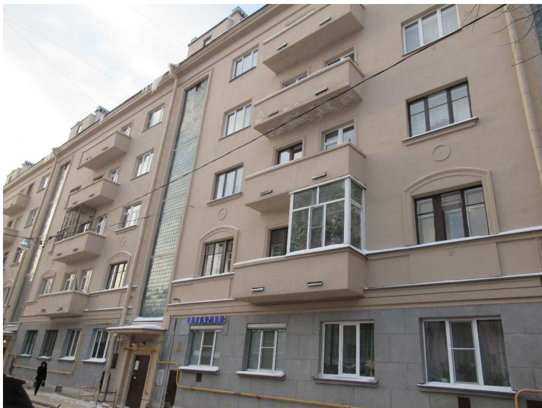
8. Вид на восточный фасад. Дата съемки: 01.12.2021
