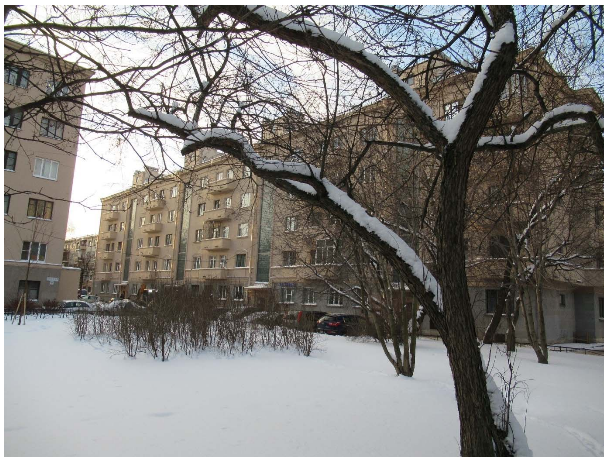
6. Вид на северный фасад. Дата съемки: 01.12.2021
