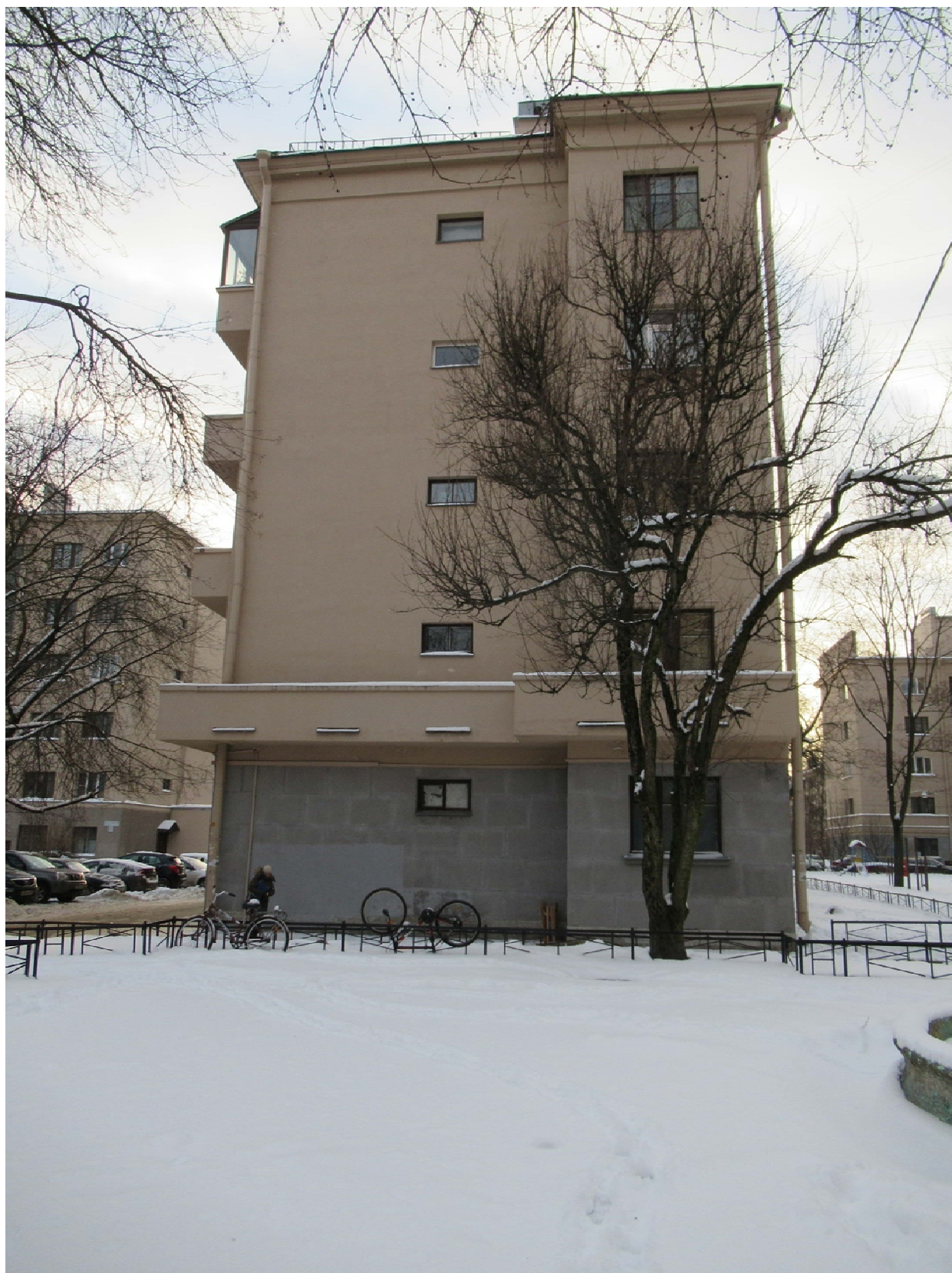
1. Вид на северный фасад. Дата съемки: 01.12.2021
