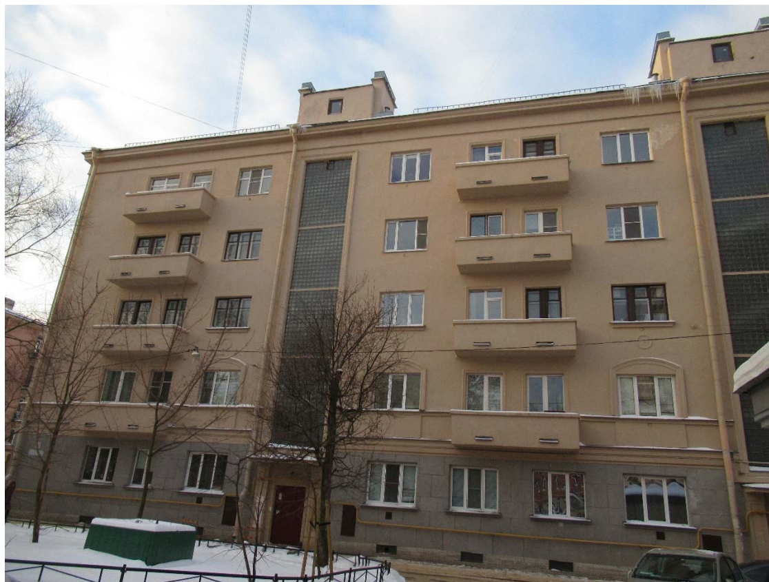
11. Вид на восточный фасад. Дата съемки: 01.12.2021
