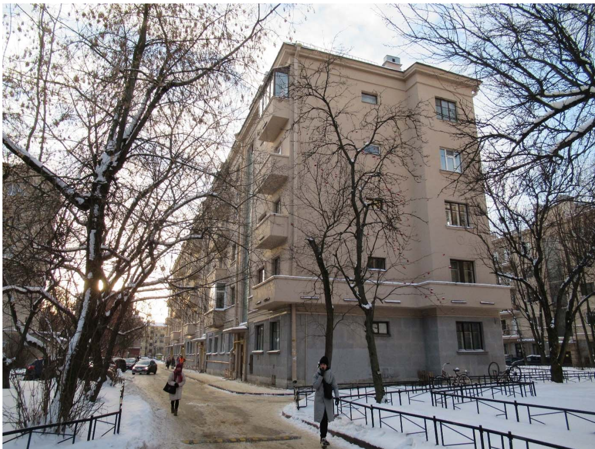
5. Вид на северный фасад. Дата съемки: 01.12.2021
