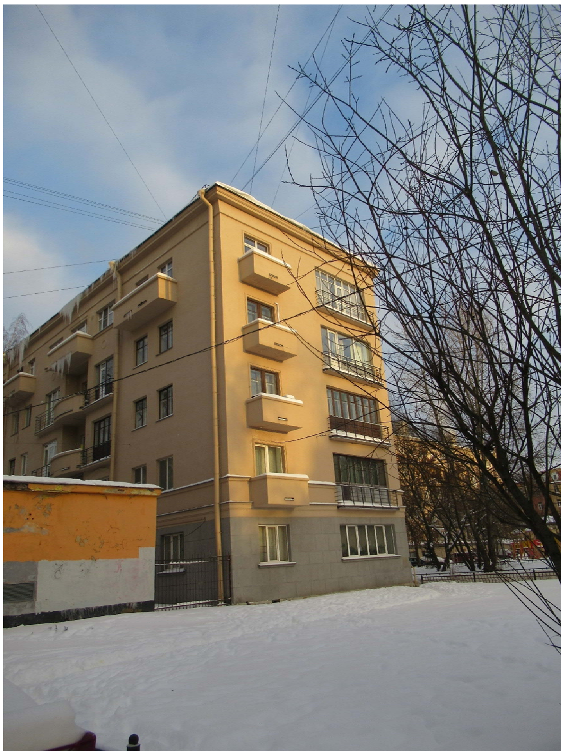
15. Вид на южный фасад. Дата съемки: 01.12.2021
