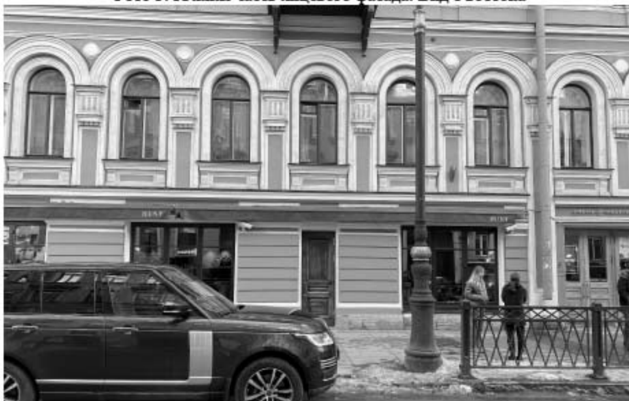
Фото 4. Южная часть лицевого фасада. Место установки мемориальной доски в простенке между 5 и 6 проемами в уровне 1-го этажа (справа от дверного проема). Вид с юго-востока
