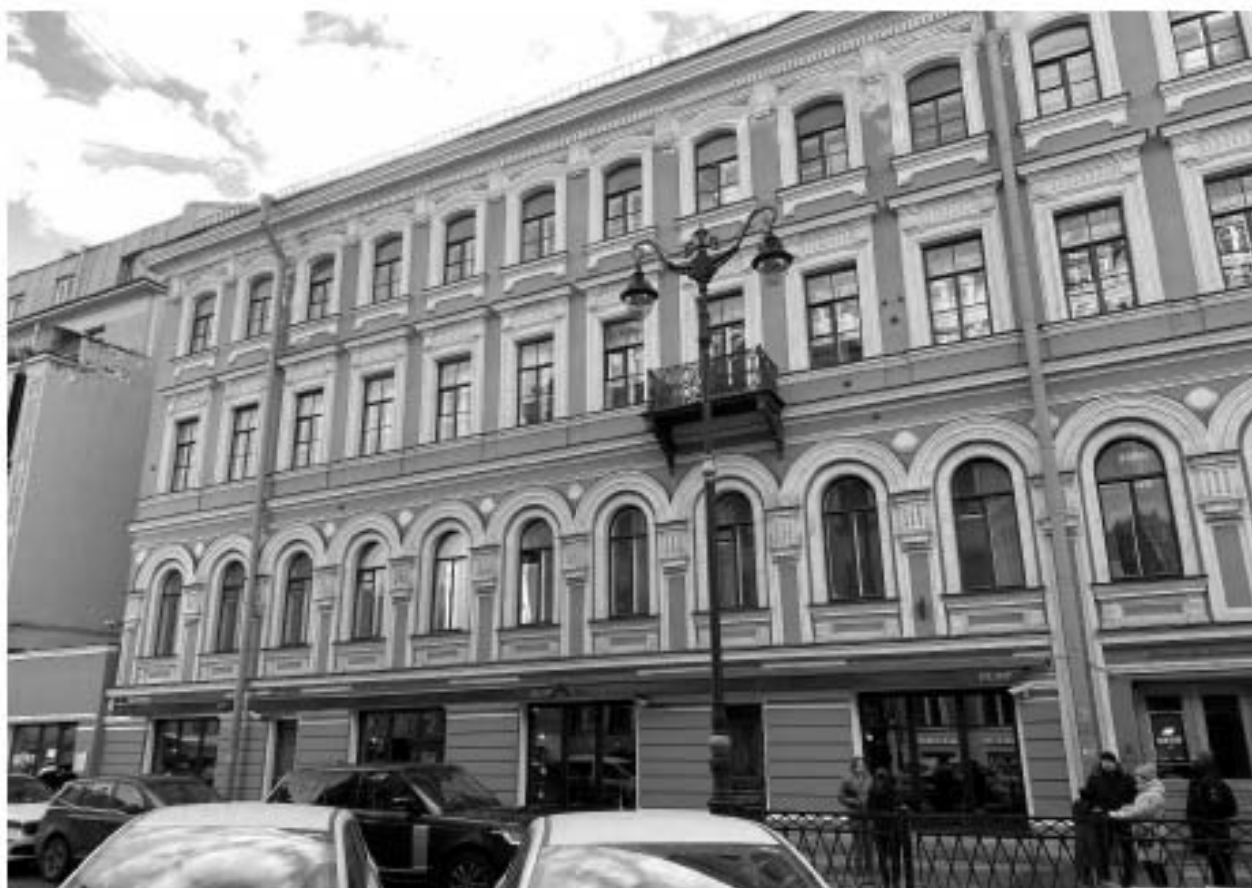
Фото 3. Южная часть лицевого фасада. Вид с востока
