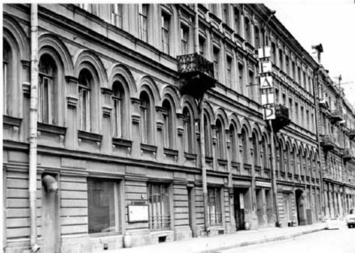
Илл. 8. Лицевой фасад дома № 13 по ул. Рубинштейна. 1977 г. // Госкаталог РФ. № 3691284
