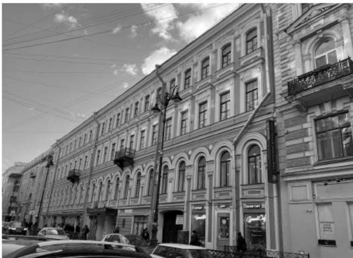
Фото 1. Общий вид на лицевой фасад с северо-востока
