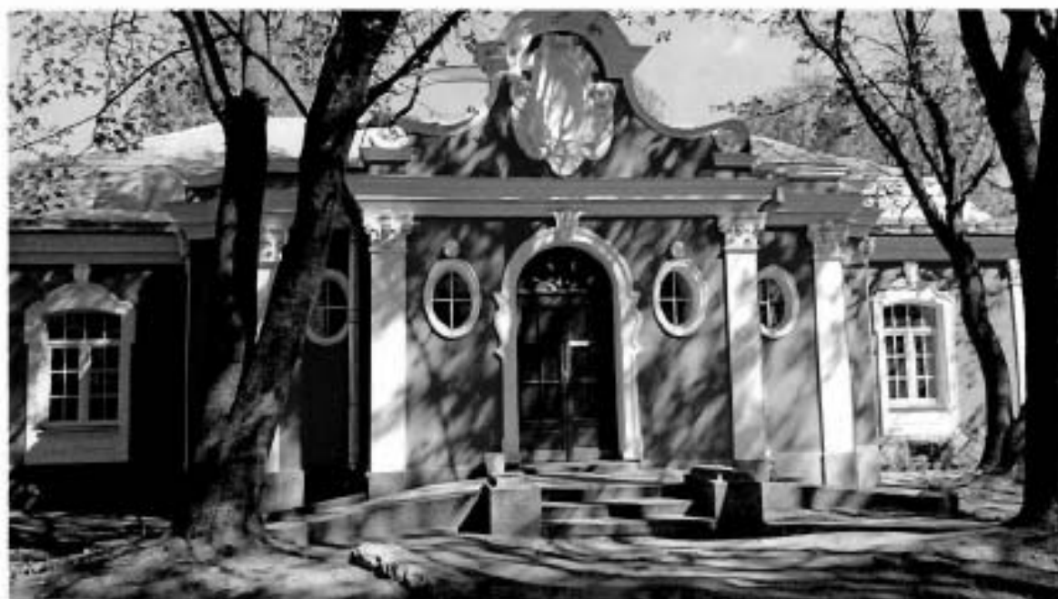
8. Корпус 12-14 (литт. И).
