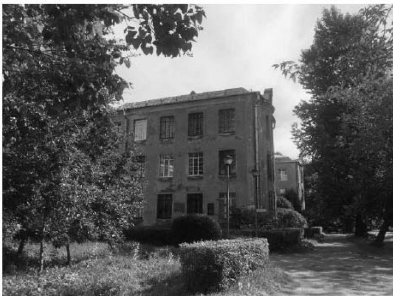
Фото №1. Фрагмент западного фасада.
