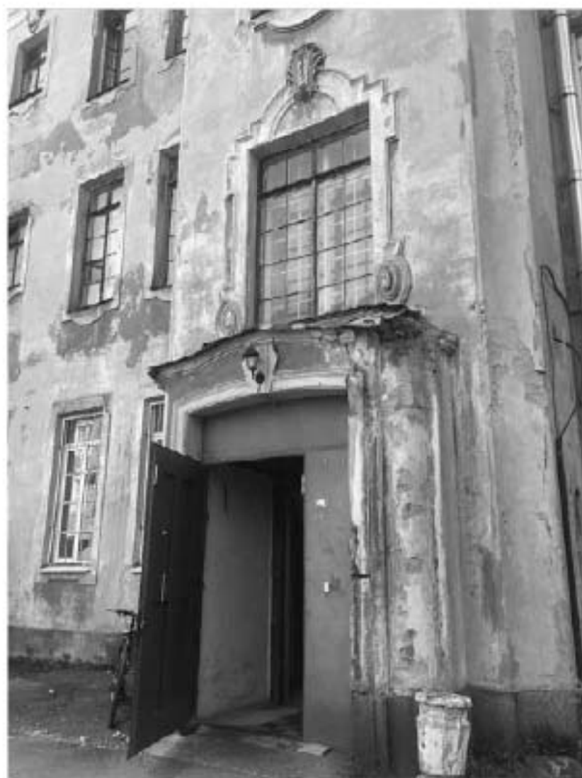
Фото №6. Фрагмент западного фасада, вход в помещение лестничной клетки.
