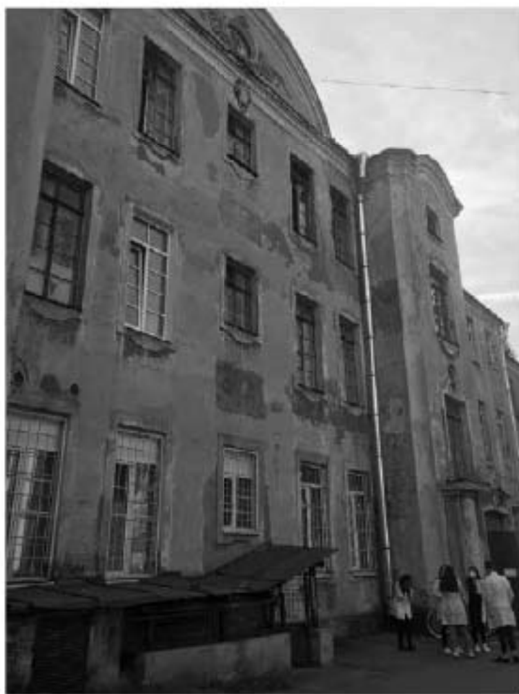
Фото №4. Фрагмент западного фасада.
