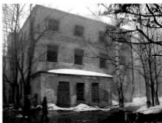
XXI. Корпус 30, расположенный по адресу: г. Санкт-Петербург, Пискаревский пр., дом 47, литера БО
