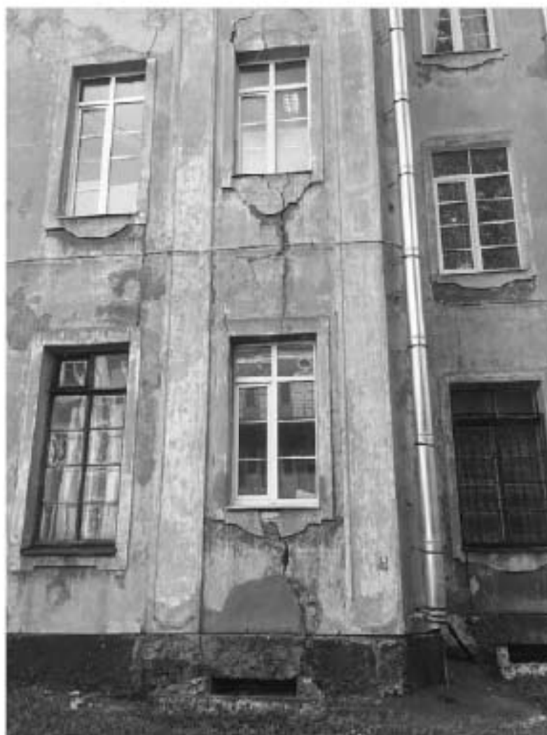
Фото №3. Фрагмент западного фасада.
