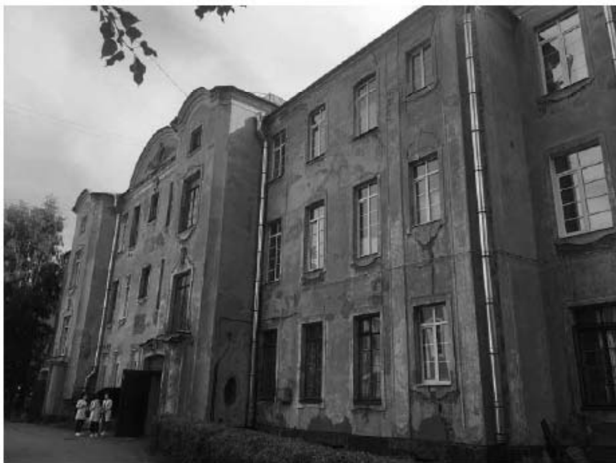
Фото №2. Западный фасад.
