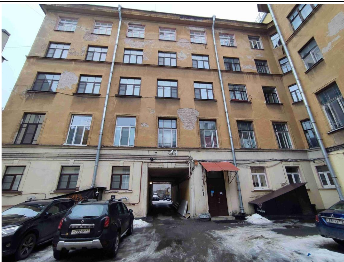
9. Восточный дворовый корпус объекта культурного наследия регионального значения «Дом Лесникова (Комитета попечительства о русской иконописи)». Общий вид южного дворового фасада.
