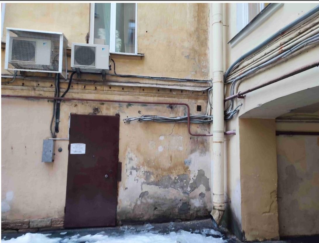
7. Южный дворовый флигель лицевого корпуса объекта культурного наследия регионального значения «Дом Лесникова (Комитета попечительства о русской иконописи)». Фрагмент северного дворового фасада в месте проектируемого монтажа видеокамеры SCAM2 на высотной отметке +2.800.
