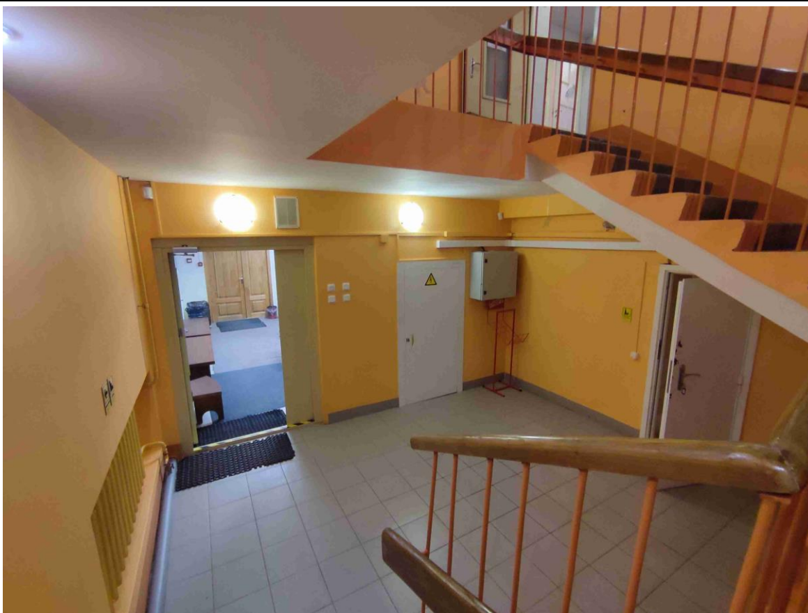
14. Общий вид пом. 3-Н (7) в уровне цокольного этажа.
