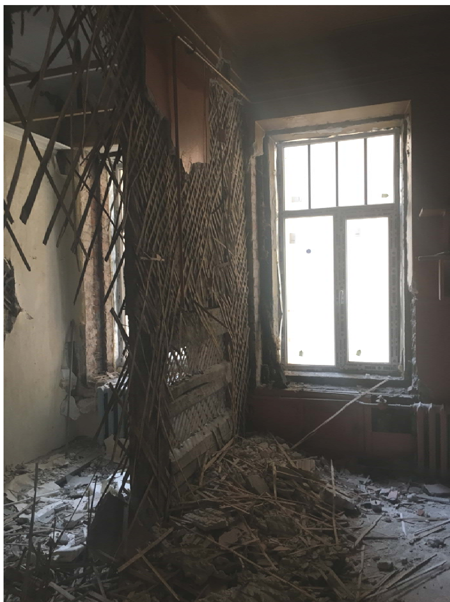
Фото №8. Квартира №15, общий вид помещения.
