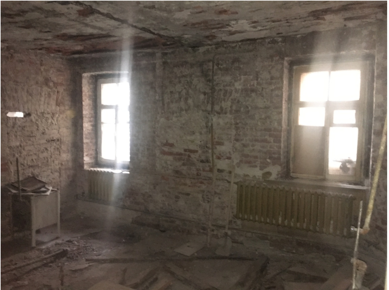
Фото №25. Квартира №45, общий вид помещения.
