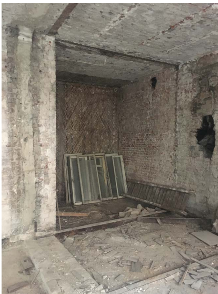
Фото №6. Квартира №15, общий вид помещения.
