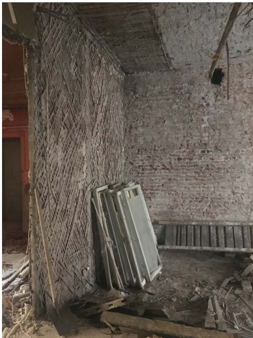
Фото №5. Квартира №15, общий вид помещения.
