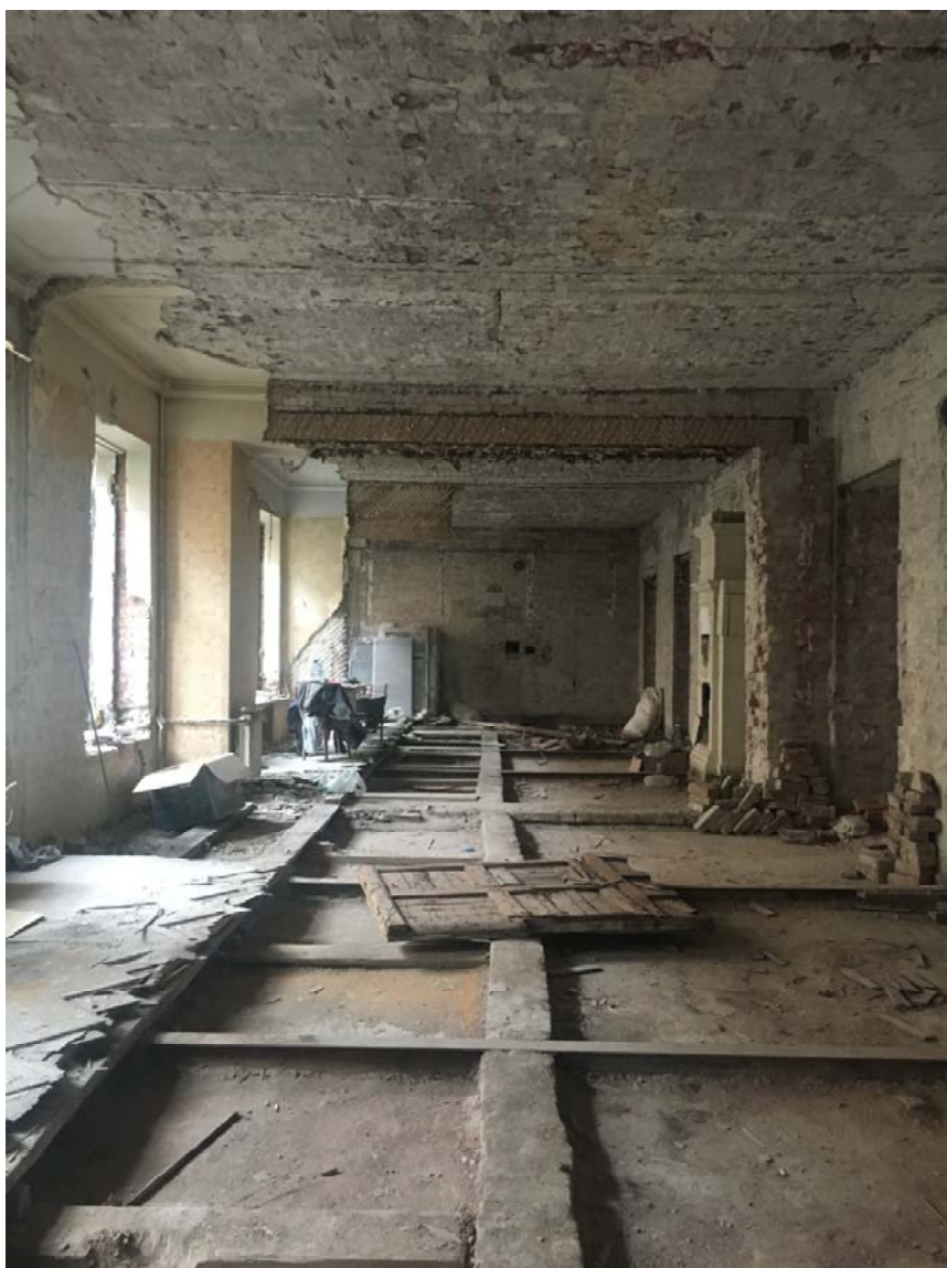
Фото №1. Квартира №15, общий вид помещения.
