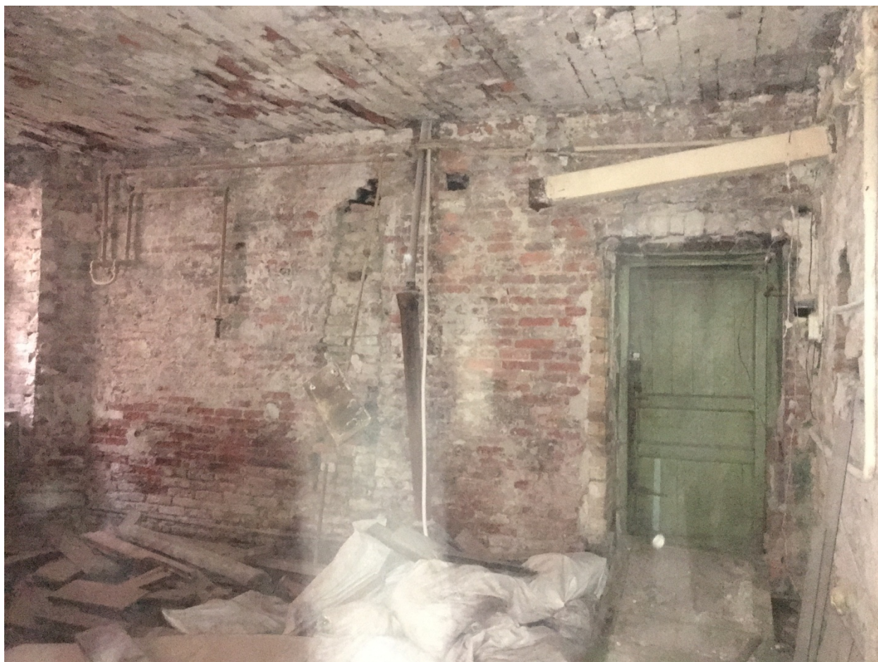
Фото №23. Квартира №45, общий вид помещения.
