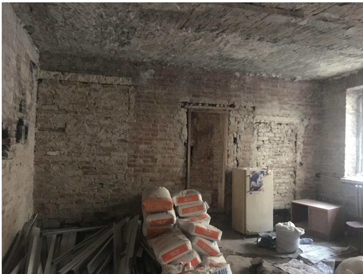
Фото №21. Квартира №45, общий вид помещения.
