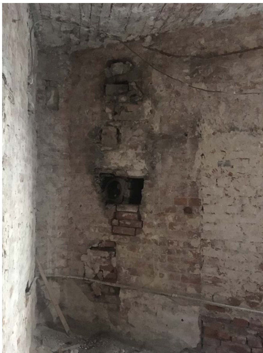
Фото №19. Квартира №45, общий вид помещения.
