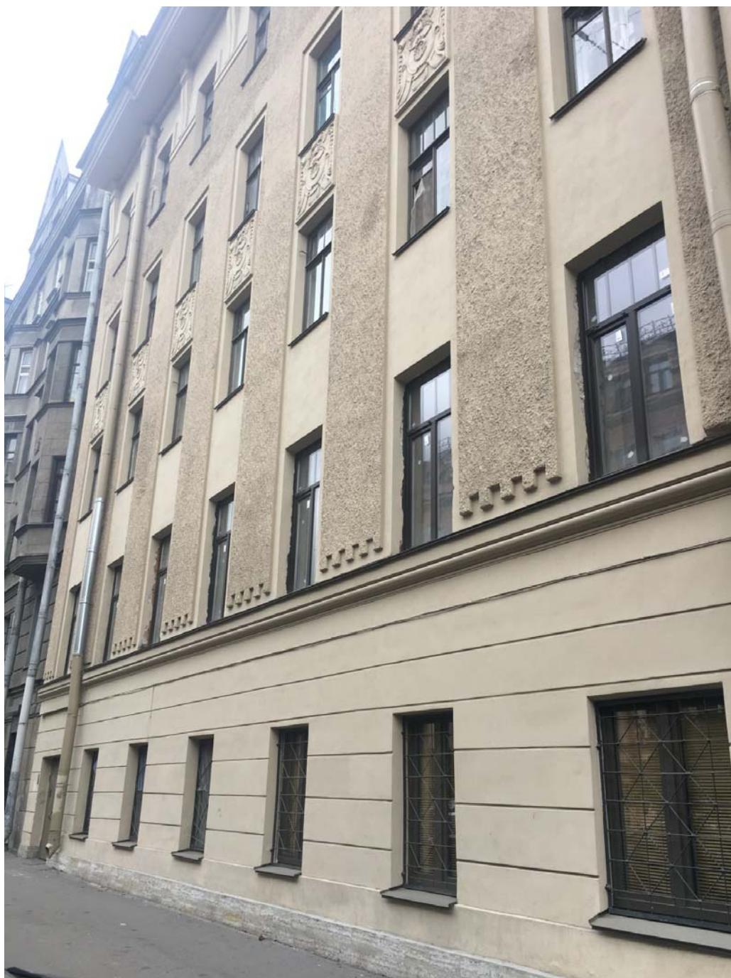
Фото №16. Лицевой фасад.
