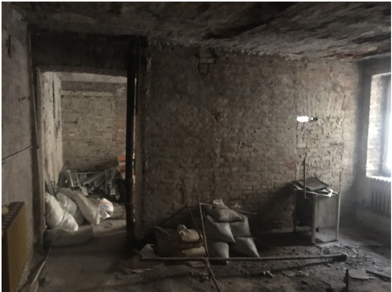
Фото №24. Квартира №45, общий вид помещения.
