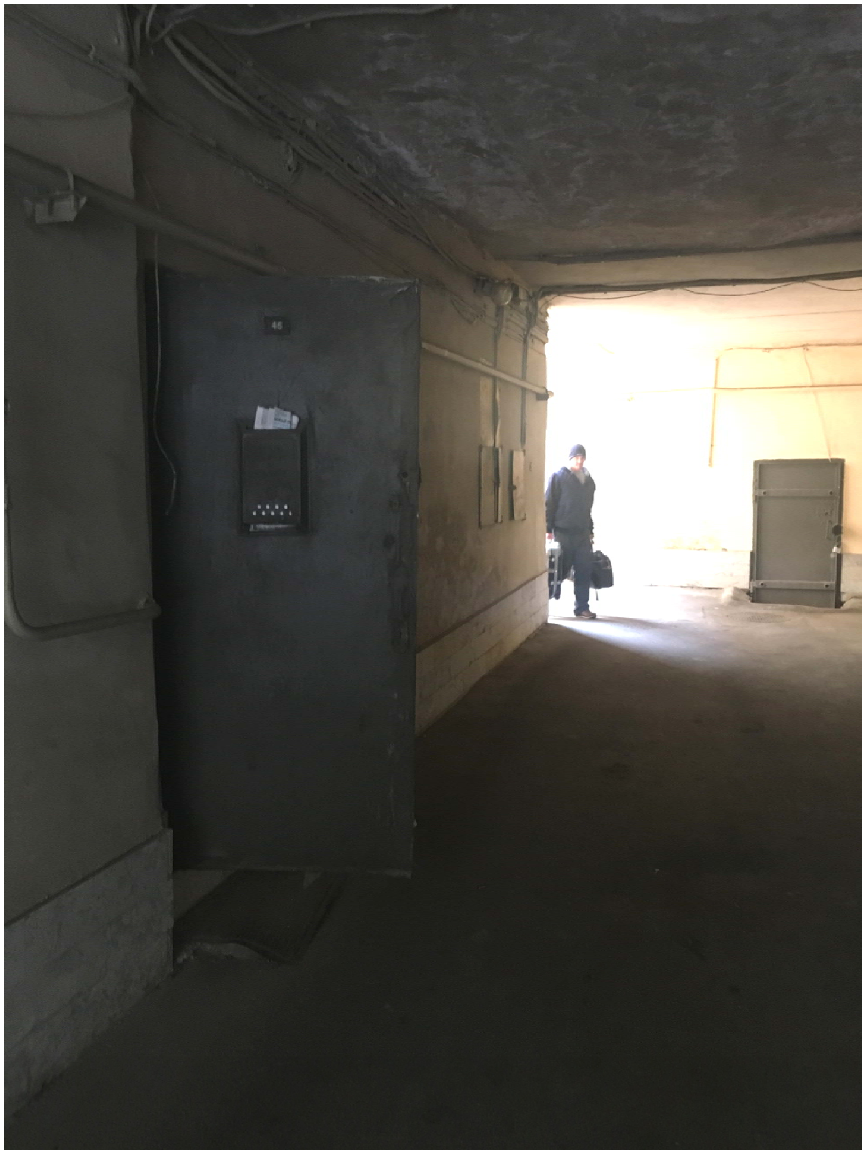
Фото №17. Арочный проезд. Вход в квартиру №45.
