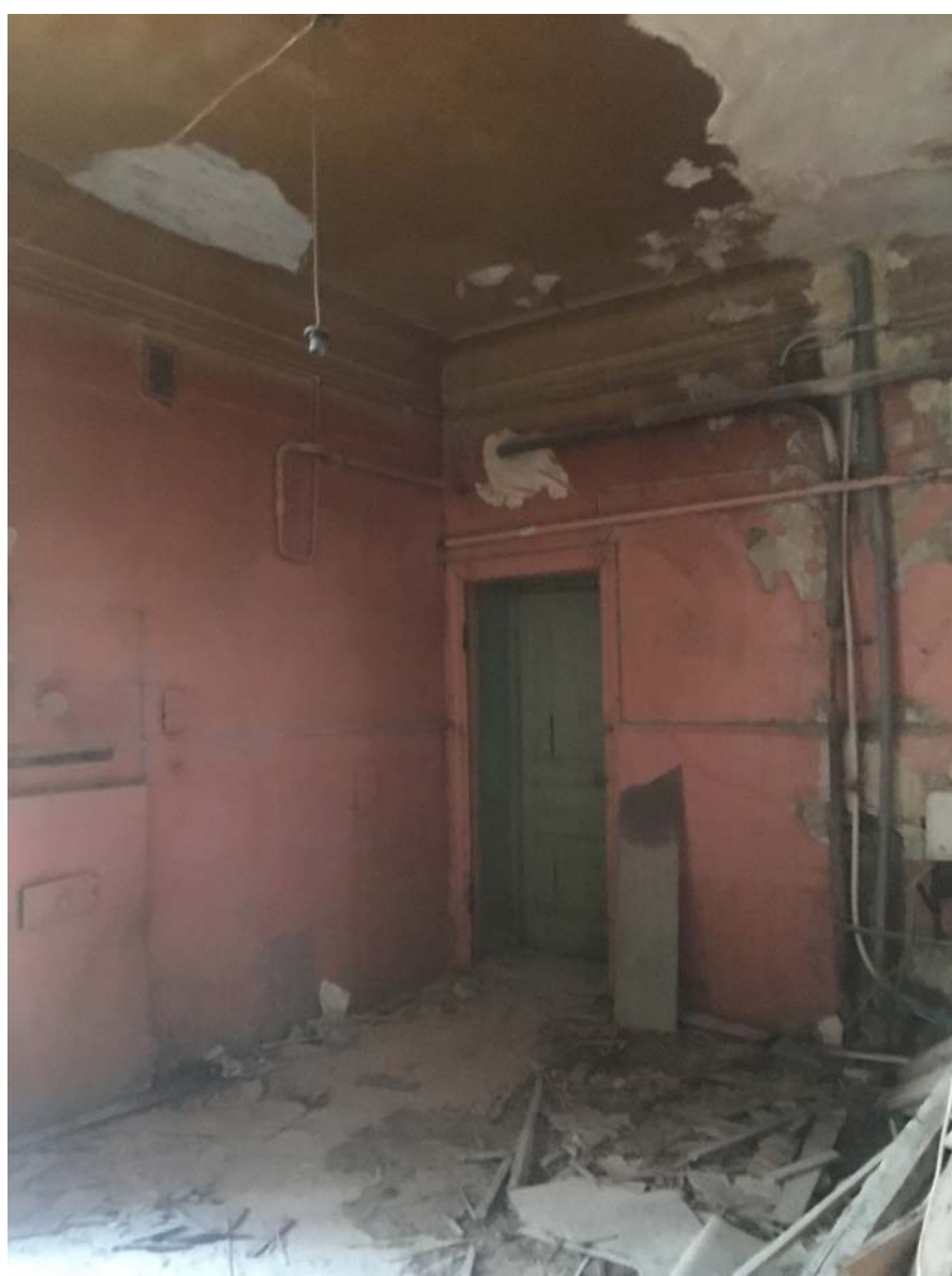
Фото №7. Квартира №15, общий вид помещения. Кухня. Выход на черную лестницу.
