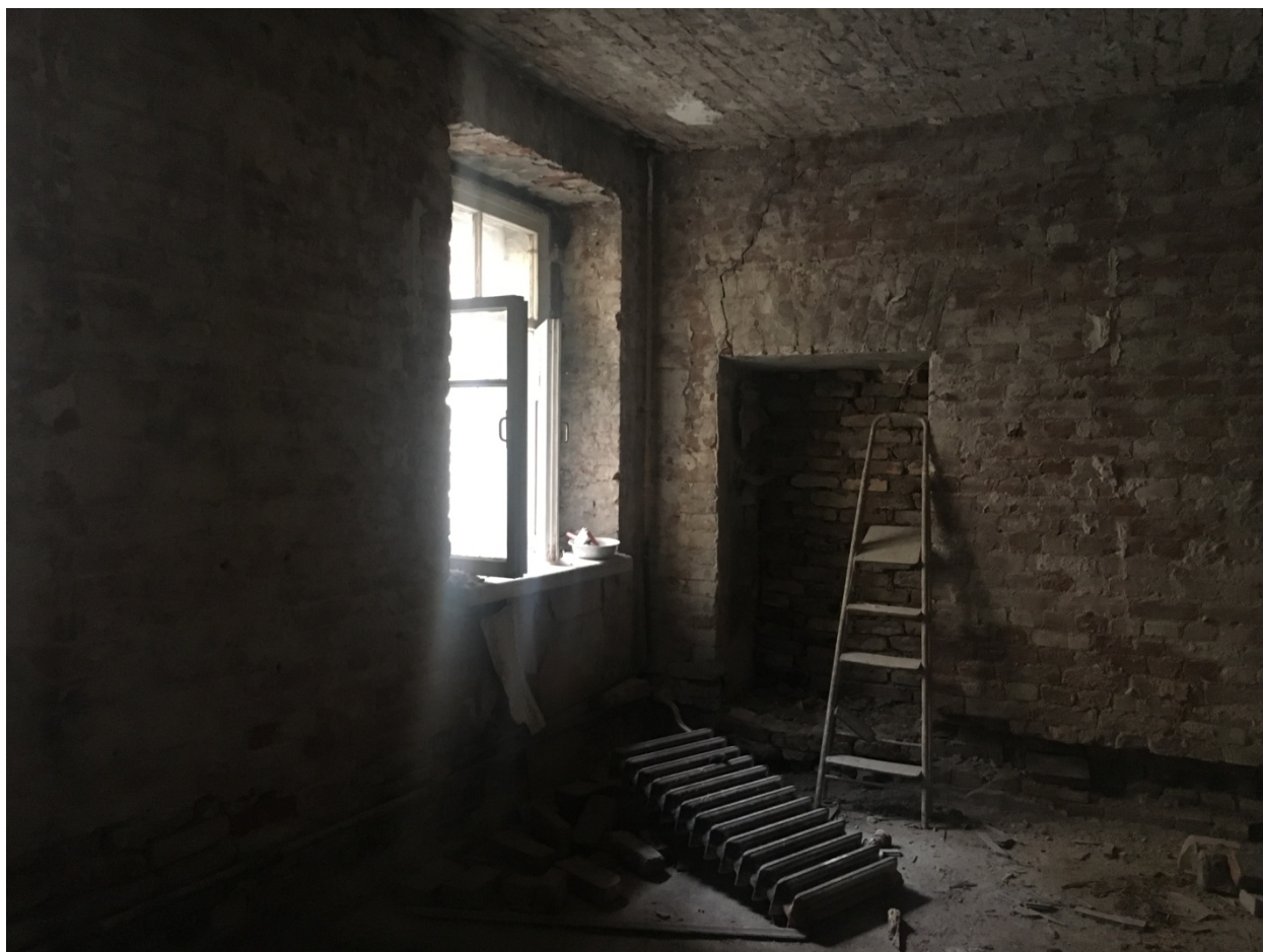
Фото №20. Квартира №45, общий вид помещения.
