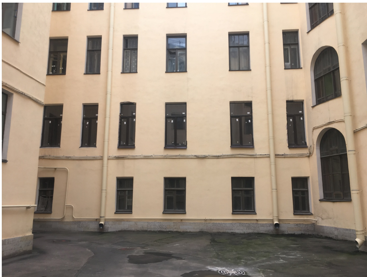
Фото №15. Дворовый фасад.
