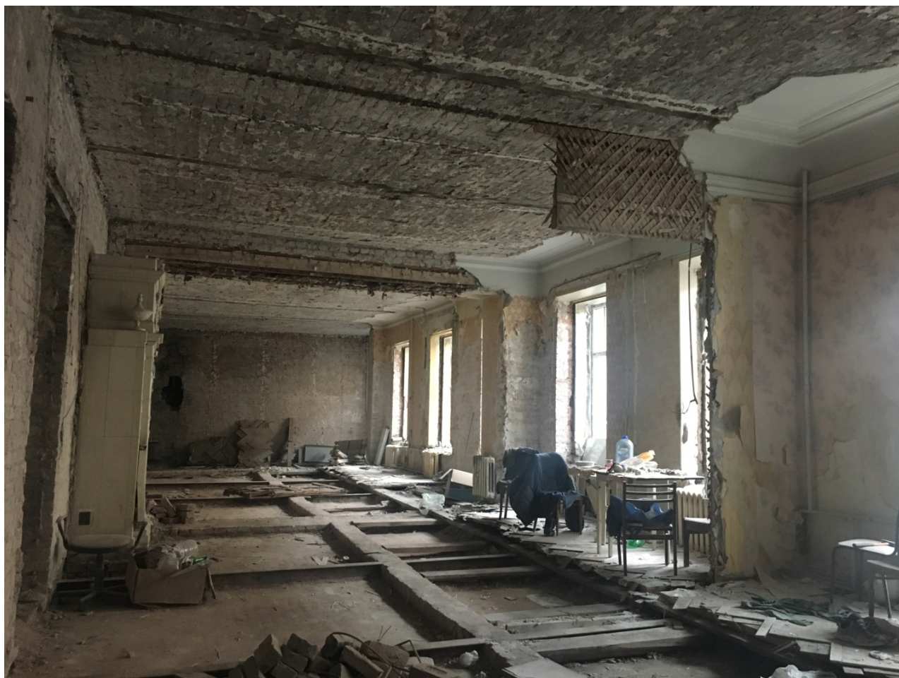
Фото №3. Квартира №15, общий вид помещения.
