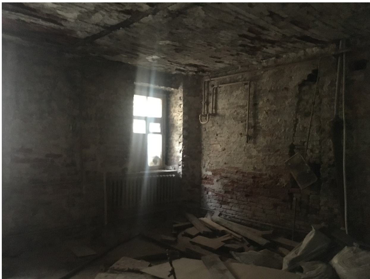
Фото №22. Квартира №45, общий вид помещения.
