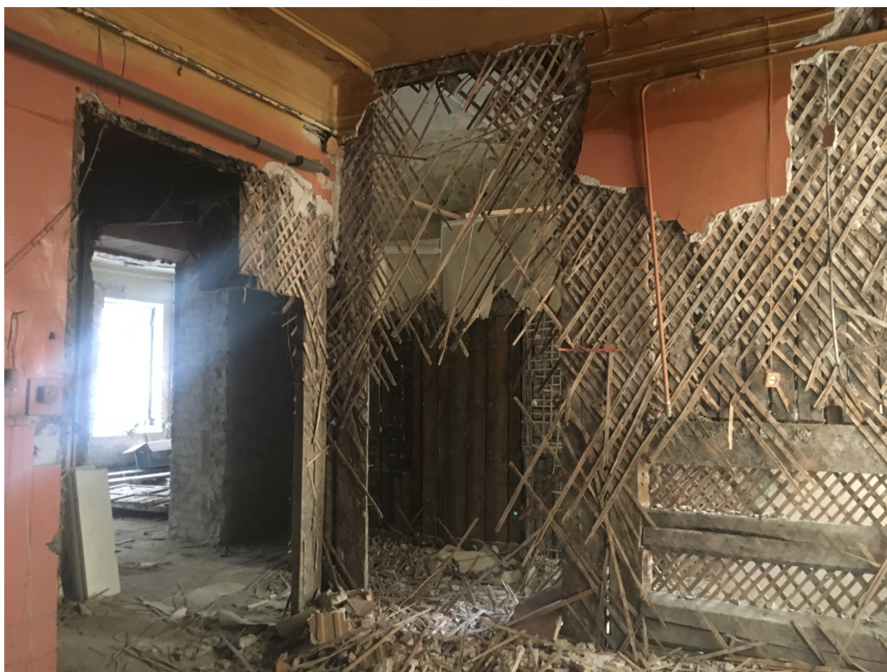
Фото №13. Квартира №15, общий вид помещения.
