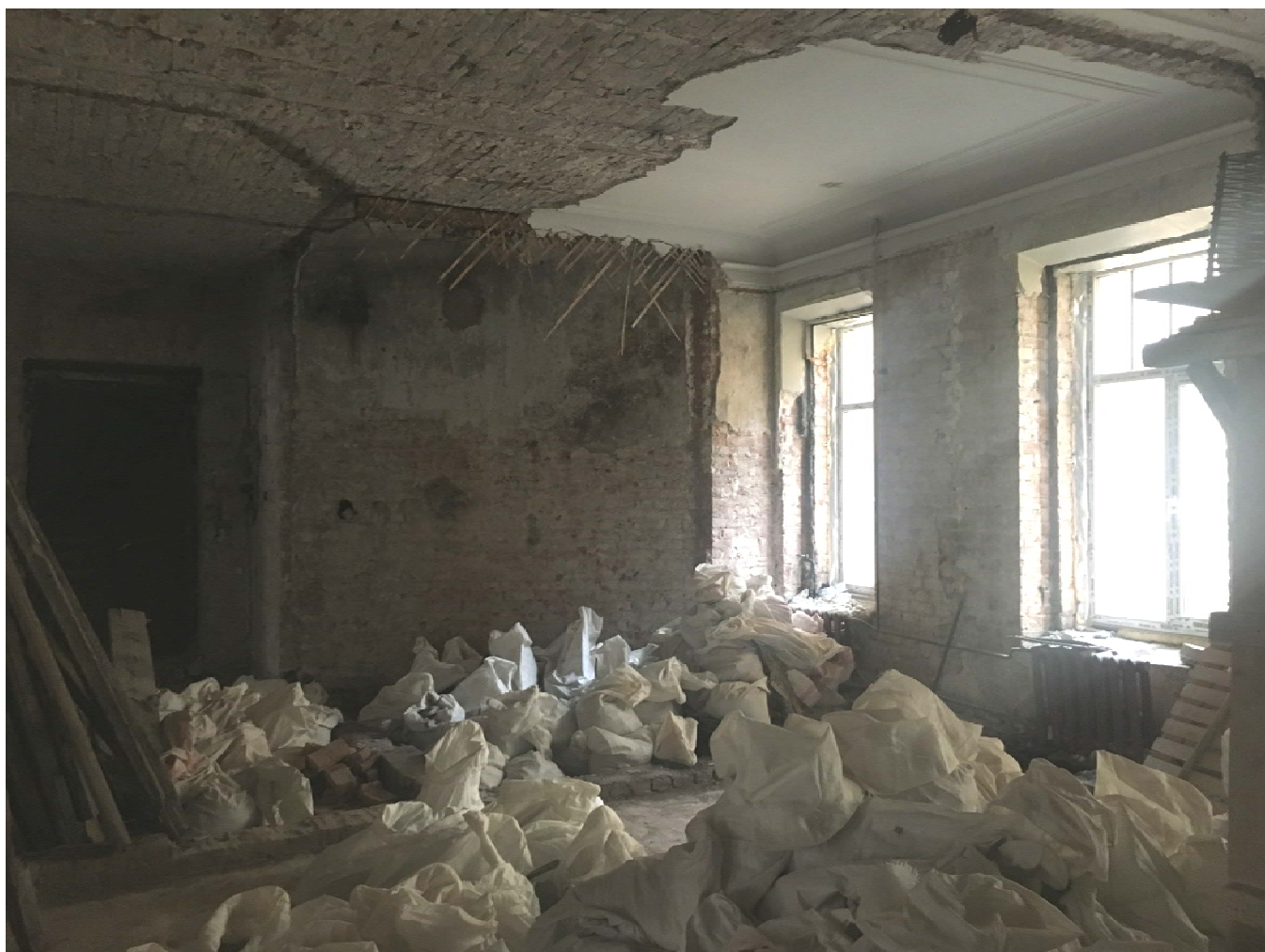
Фото №11. Квартира №15, общий вид помещения.
