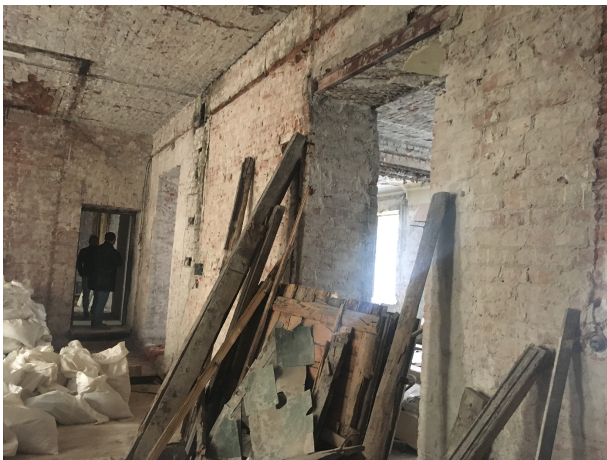
Фото №12. Квартира №15, общий вид помещения.
