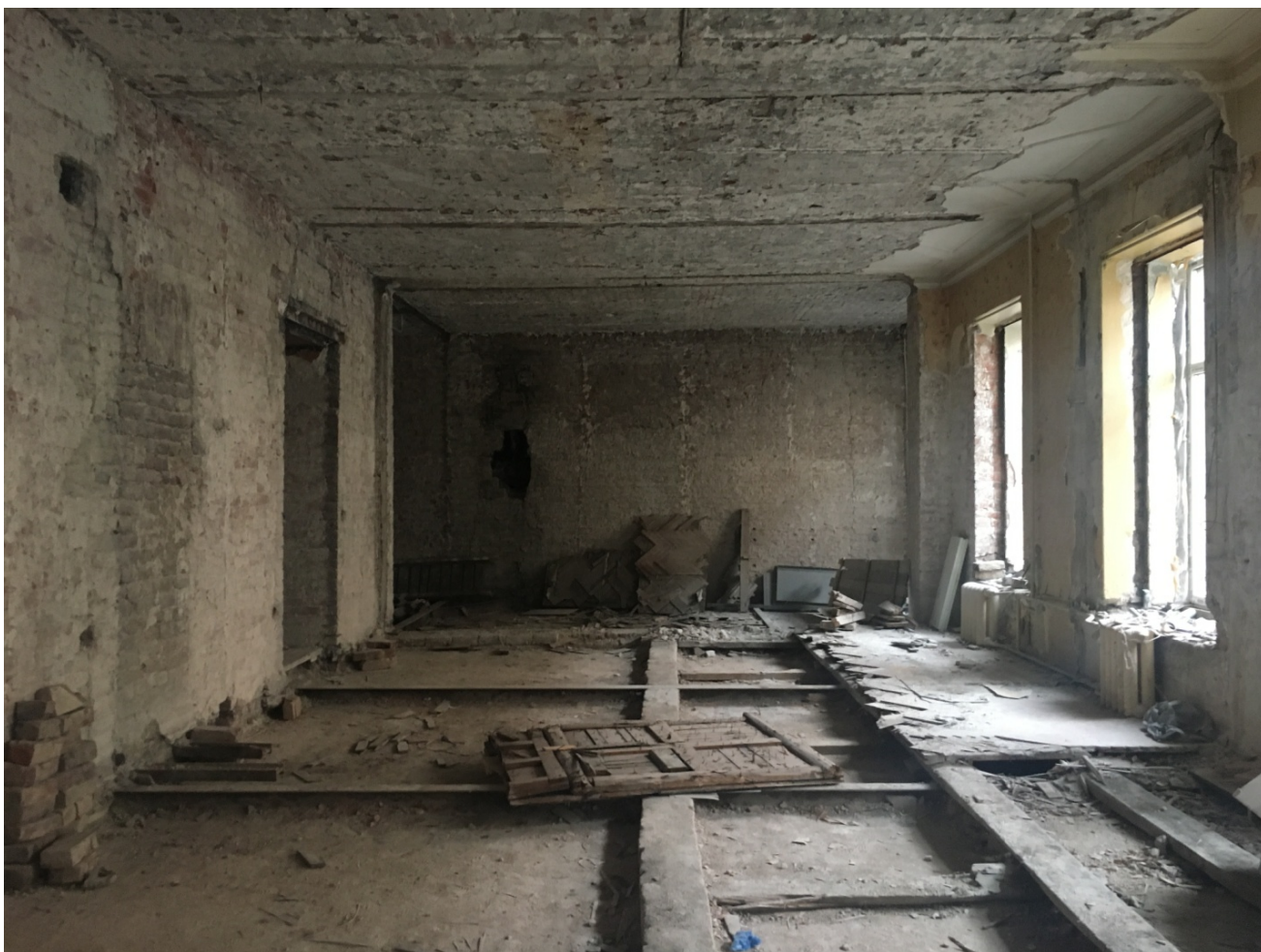
Фото №2. Квартира №15, общий вид помещения.
