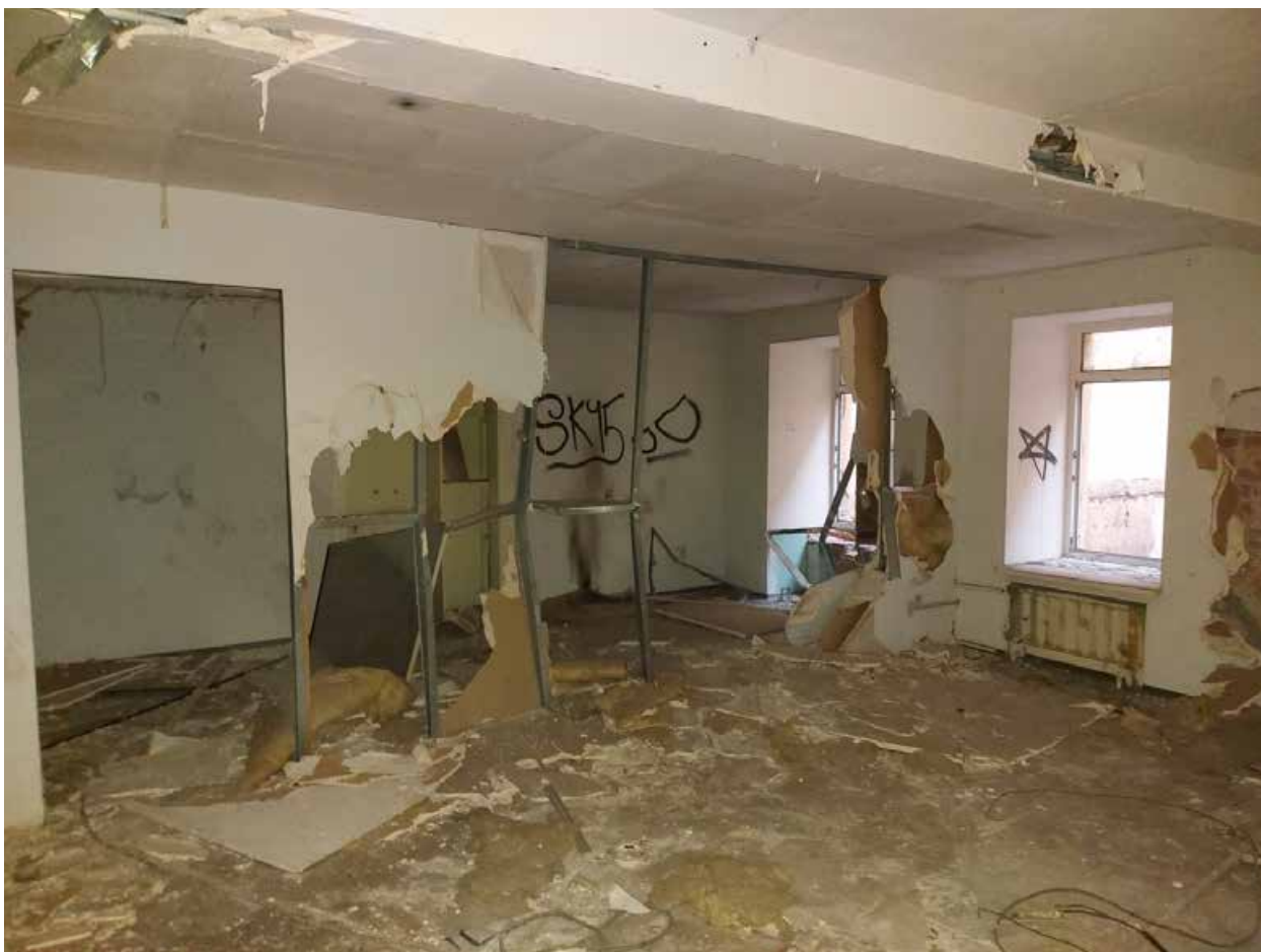
Фото 14. Помещения второго этажа южного корпуса.
