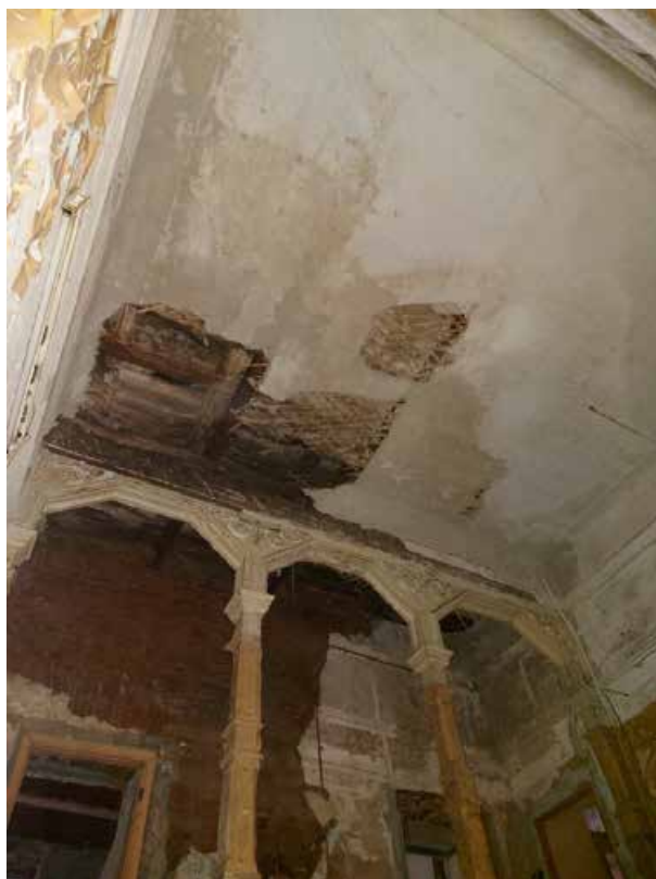
Фото 22. Перекрытие парадной лестницы.
