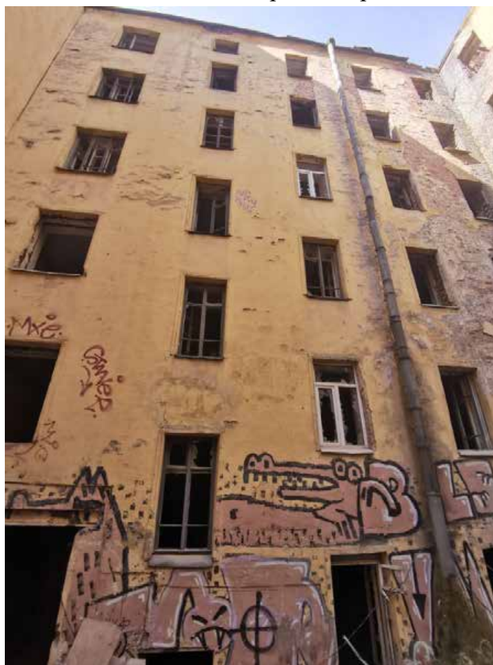
Фото 6. Южный фасад центрального корпуса.
