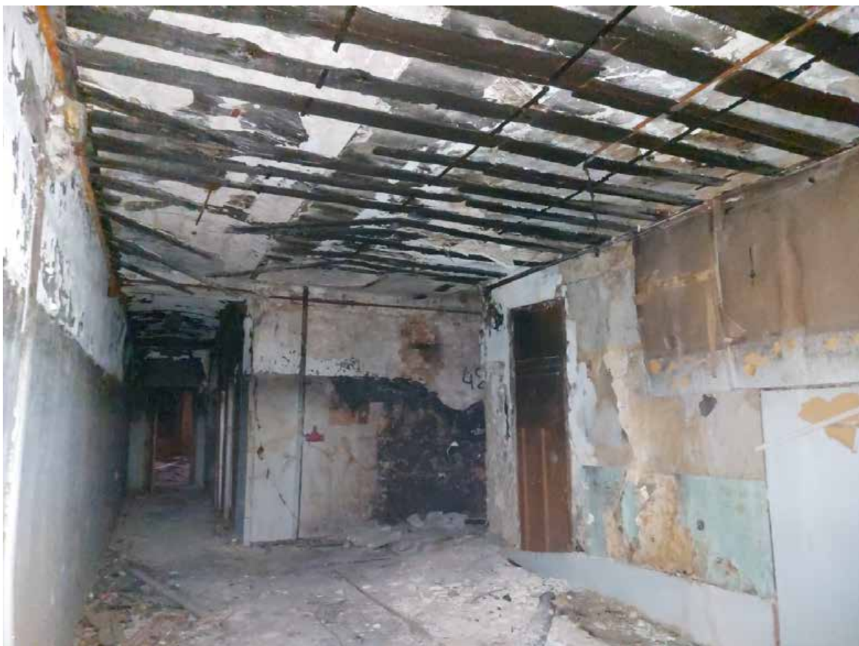
Фото 50. Помещение центрального корпуса.
