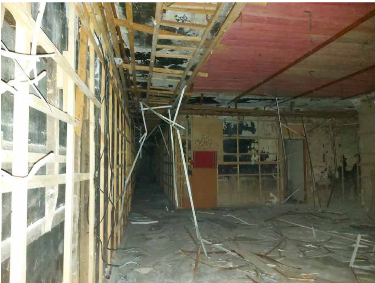
Фото 33. Северо-восточное помещение центрального корпуса.
