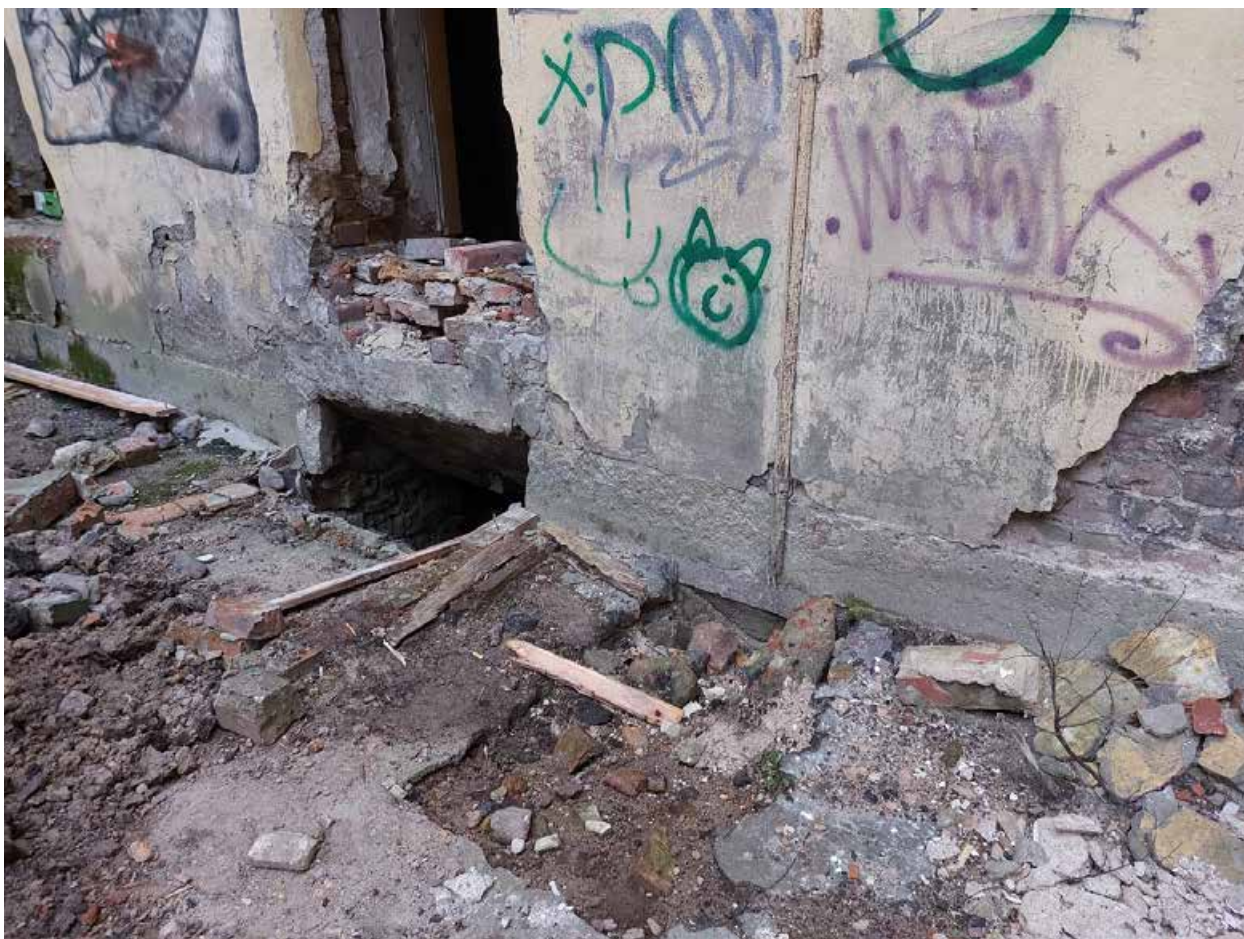
Фото 3. Проем в подвал центрального корпуса.
