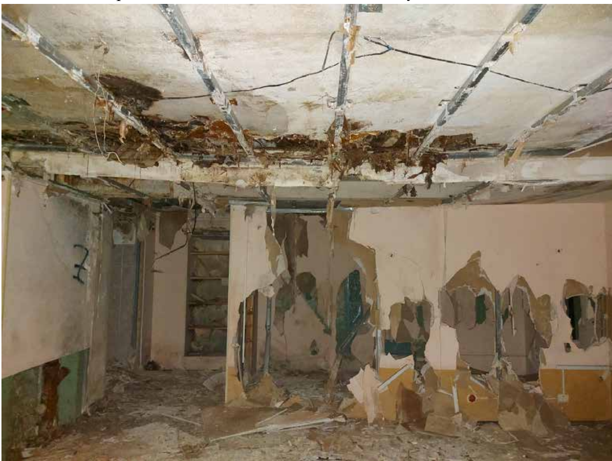
Фото 13. Помещение 1, южного корпуса.
