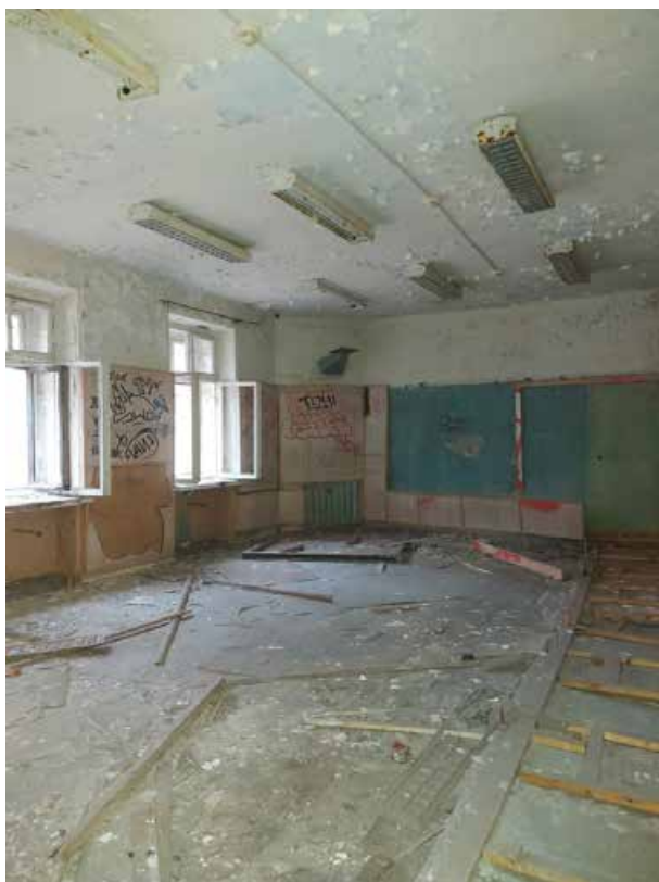
Фото 52. Помещение северное (6 этаж).
