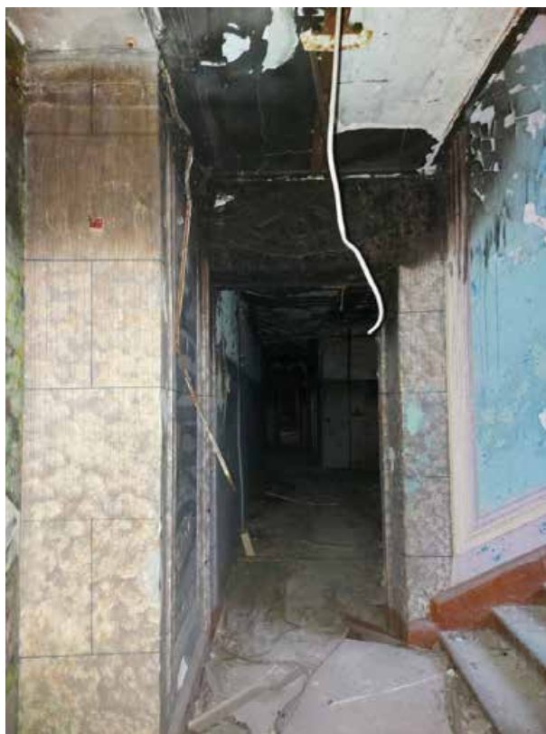
Фото 47. Северная лестница, пятый этаж.
