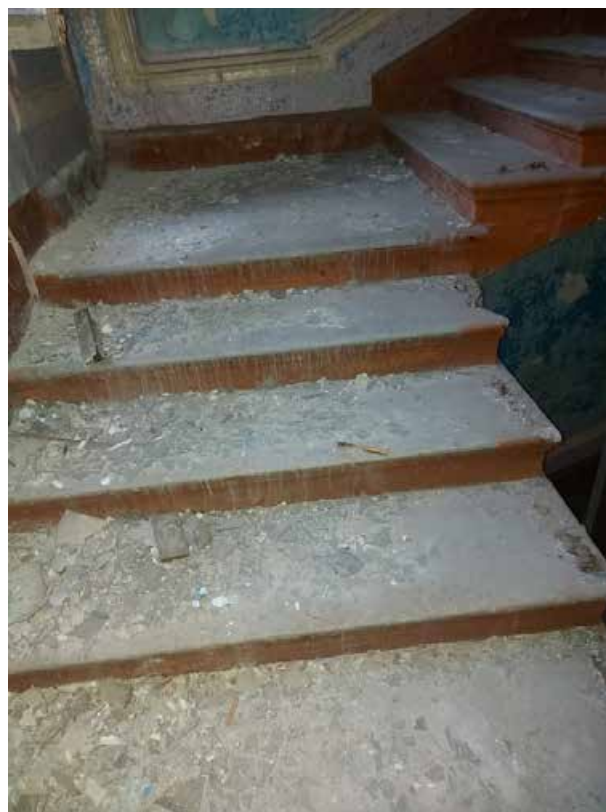
Фото 53. Лестничные марши северной лестницы.
