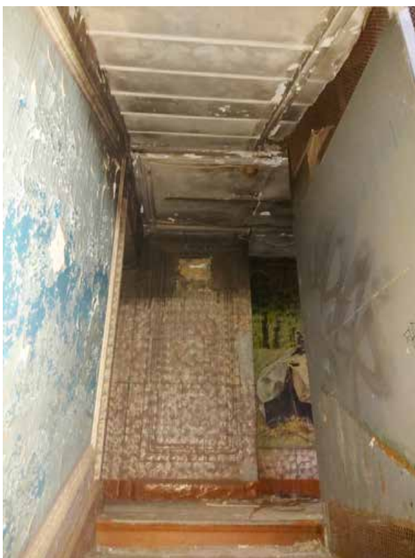
Фото 48. Северная лестница на 5 этаж.
