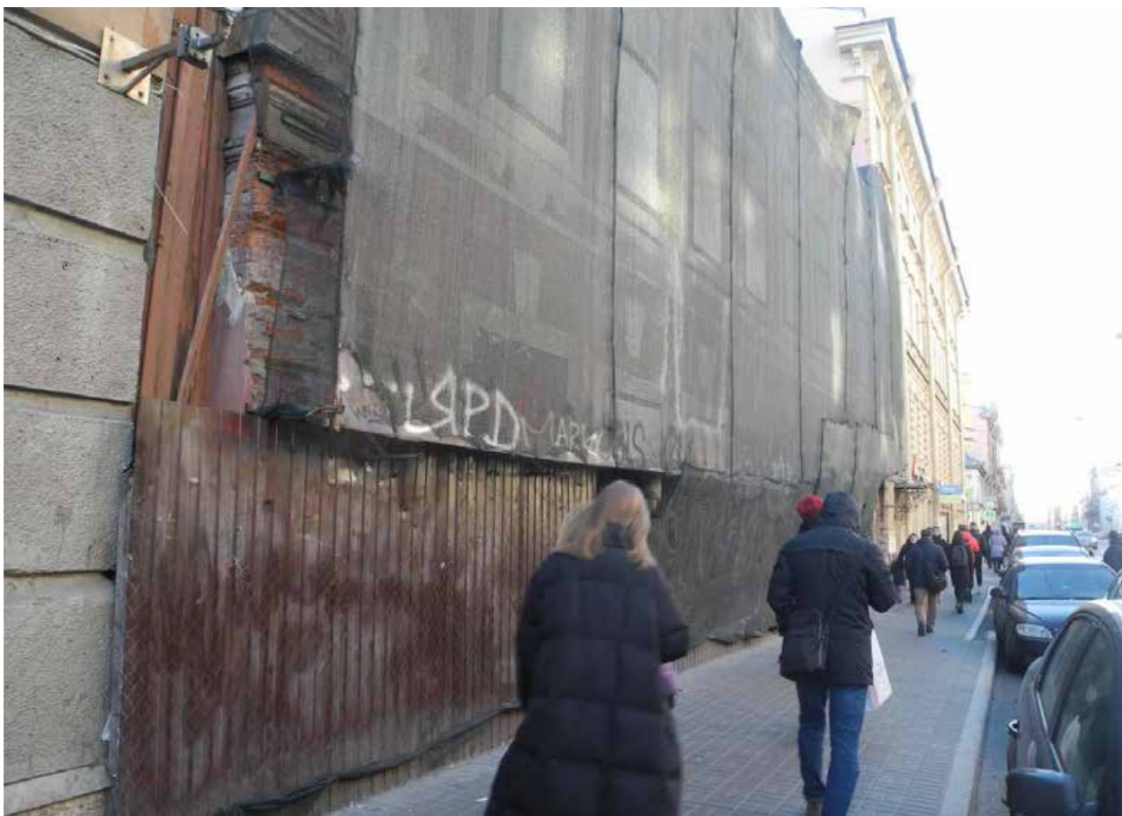
Фото 4. Лицевой фасад с северо-востока.
