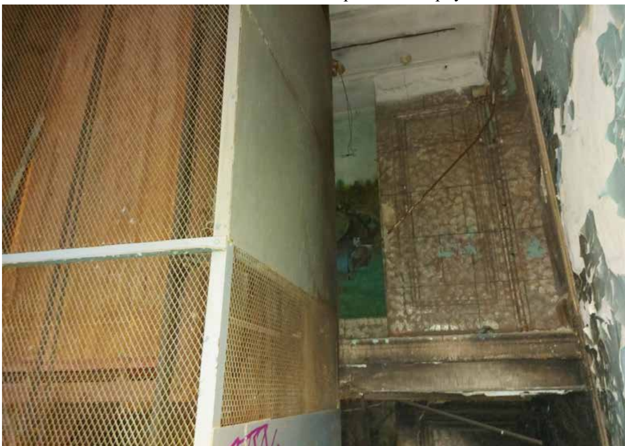
Фото 51. Вид на 6 этаж северной лестницы.
