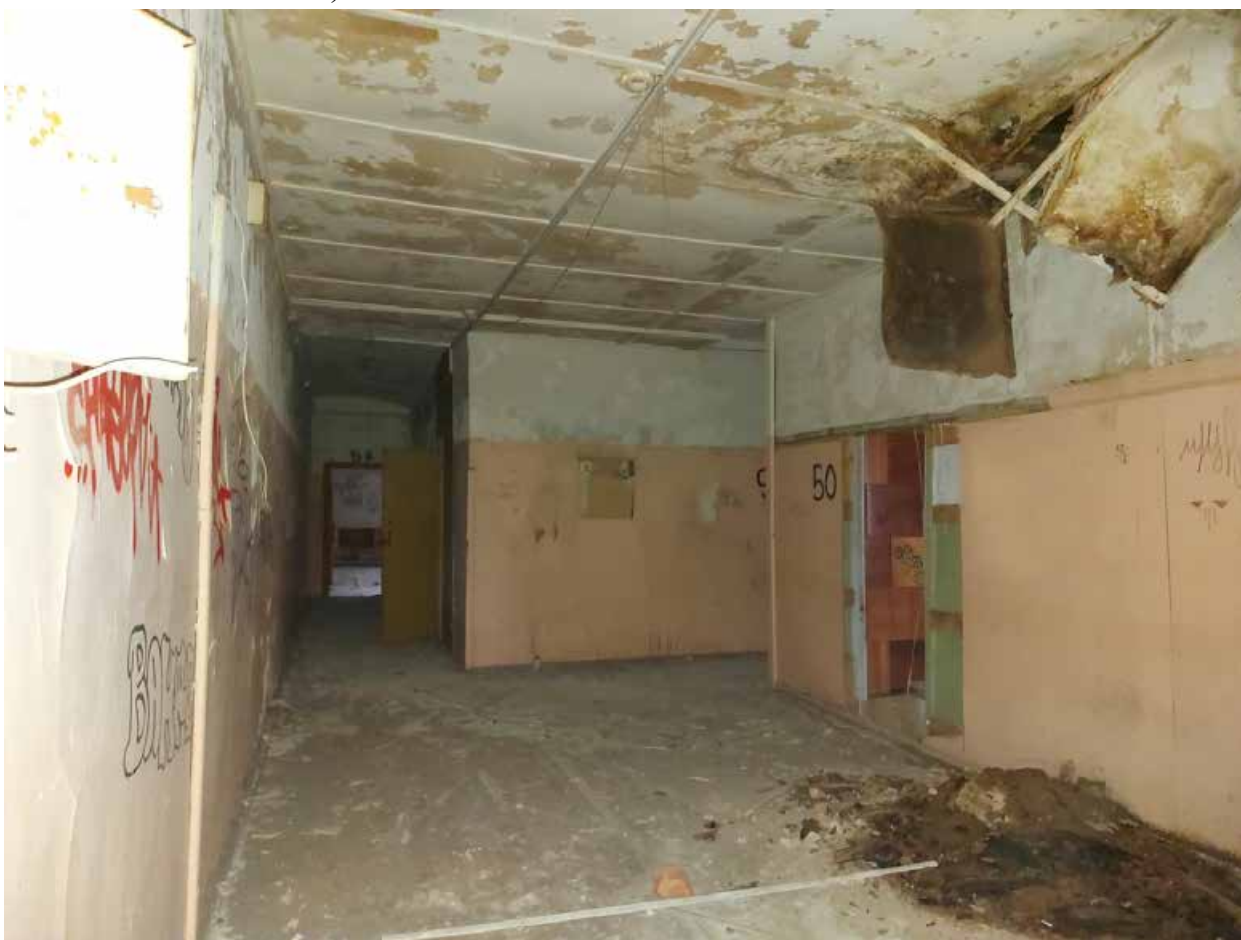
Фото 54. Помещение центрального корпуса на 6 этаже.
