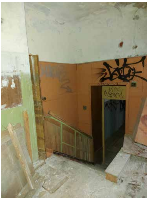
Фото 33. Юго-восточное помещение с лестницей на третий этаж.
