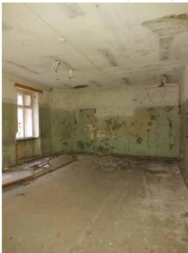
Фото 42. Помещение 1 (северная часть).
