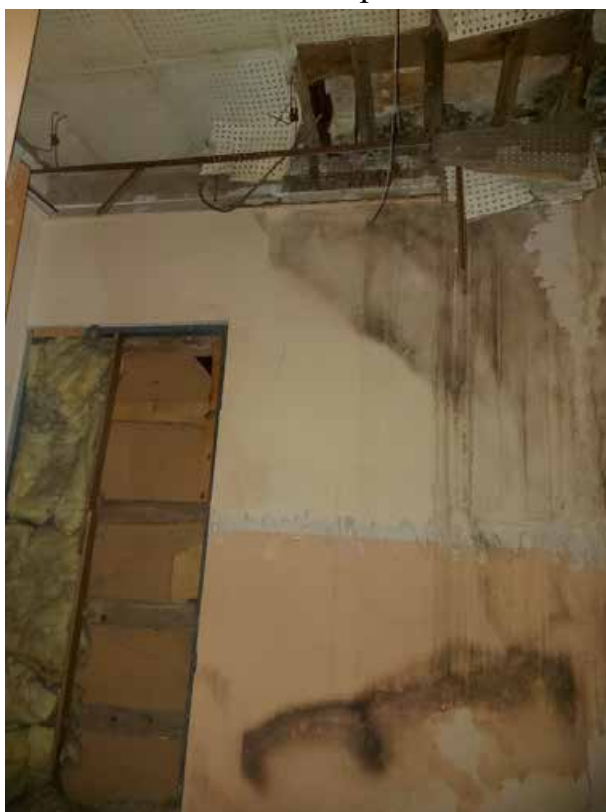
Фото 34. Площадка третьего этажа.
