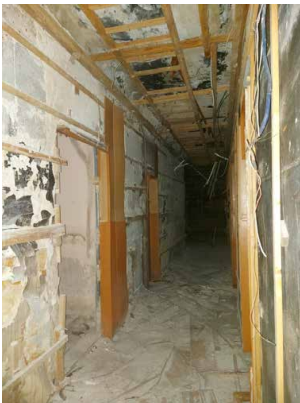
Фото 29. Коридор центрального корпуса.
