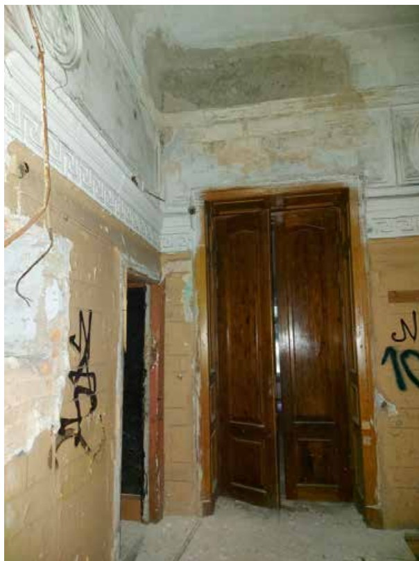
Фото 24. Площадка второго этажа.
