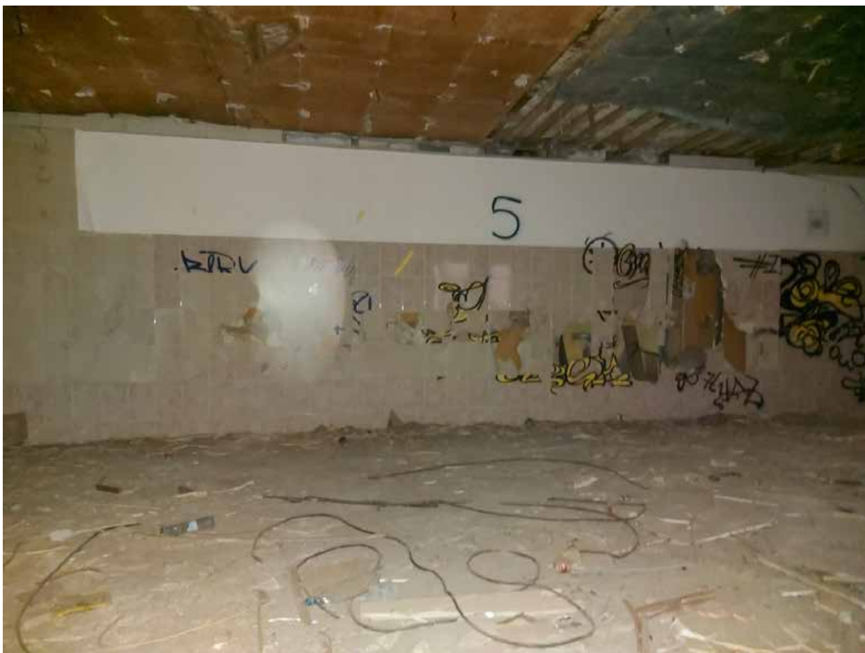
Фото 17. Помещение первого этажа восточного корпуса второго двора.
