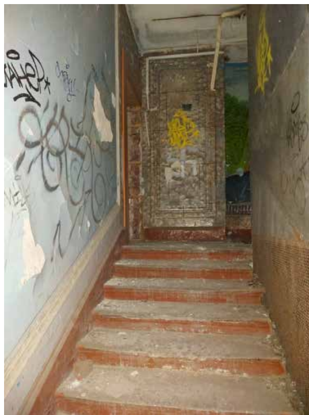
Фото 30. Лестница северная, марш на второй этаж.
