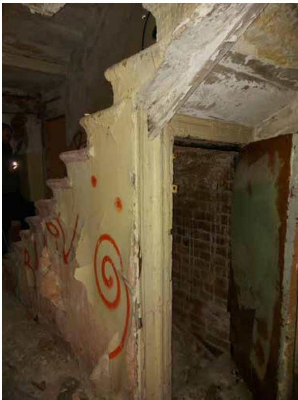
Фото 11. Лестница южного корпуса, первый этаж.
