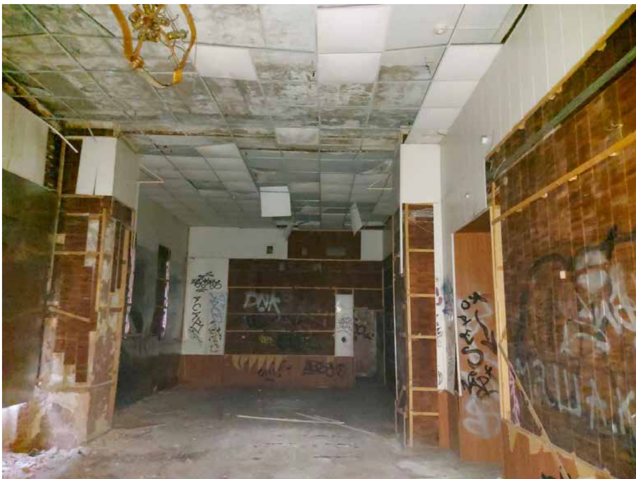
Фото 25. Восточная и центральная часть помещения 14.
