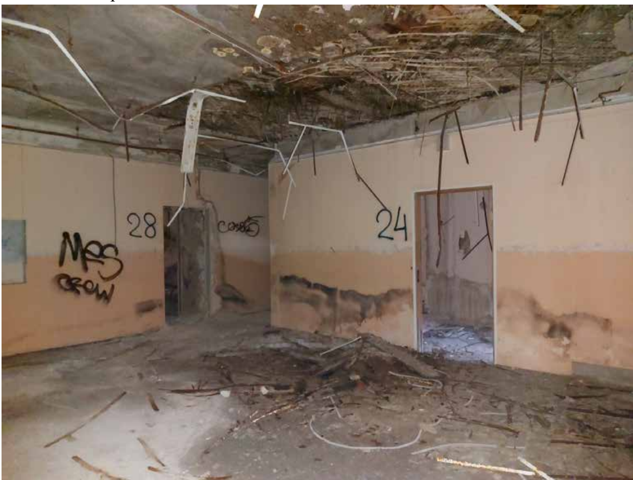
Фото 38. Помещение 1 центрального корпуса.
