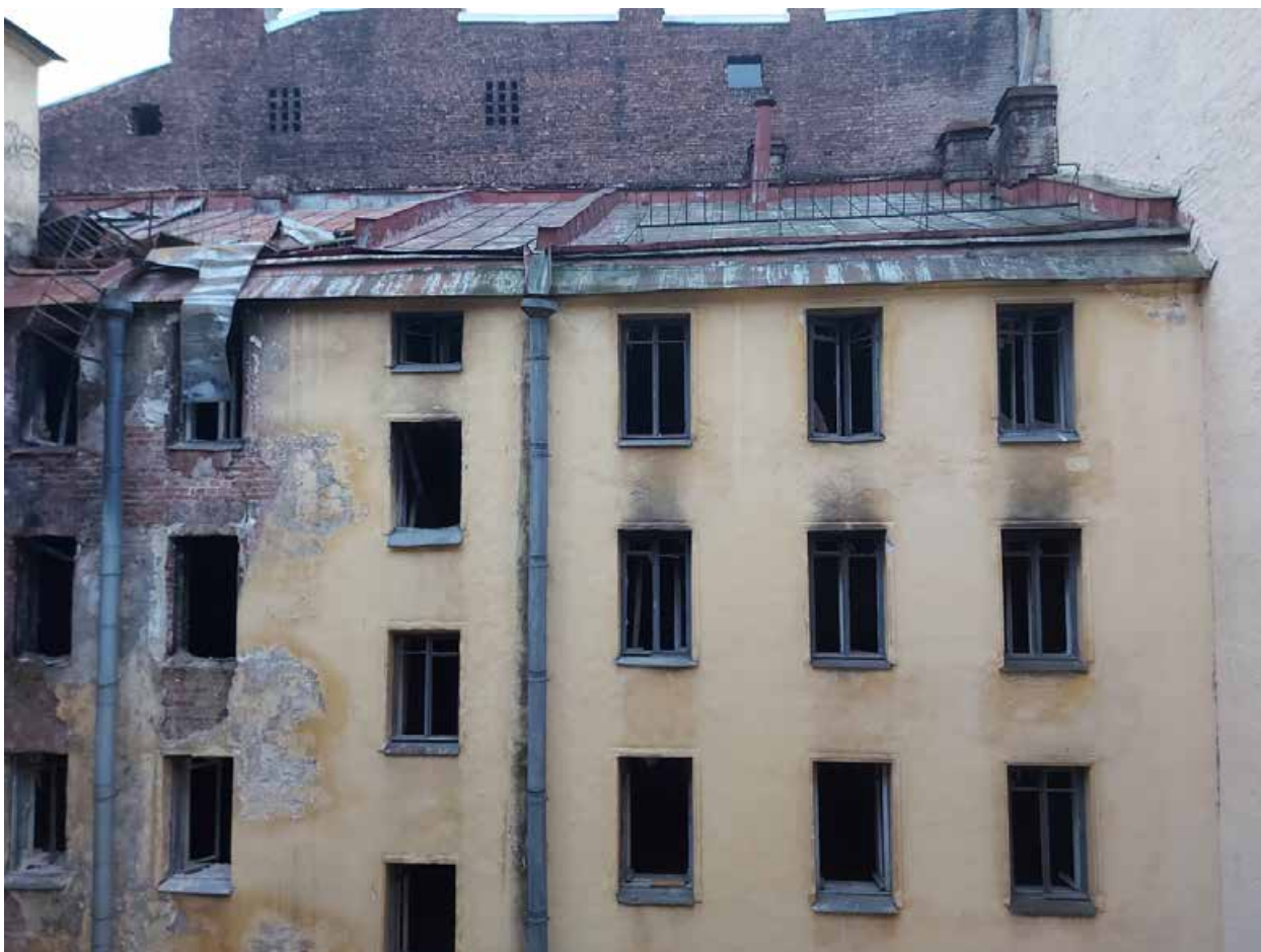
Фото 10. Фасад южного корпуса.
