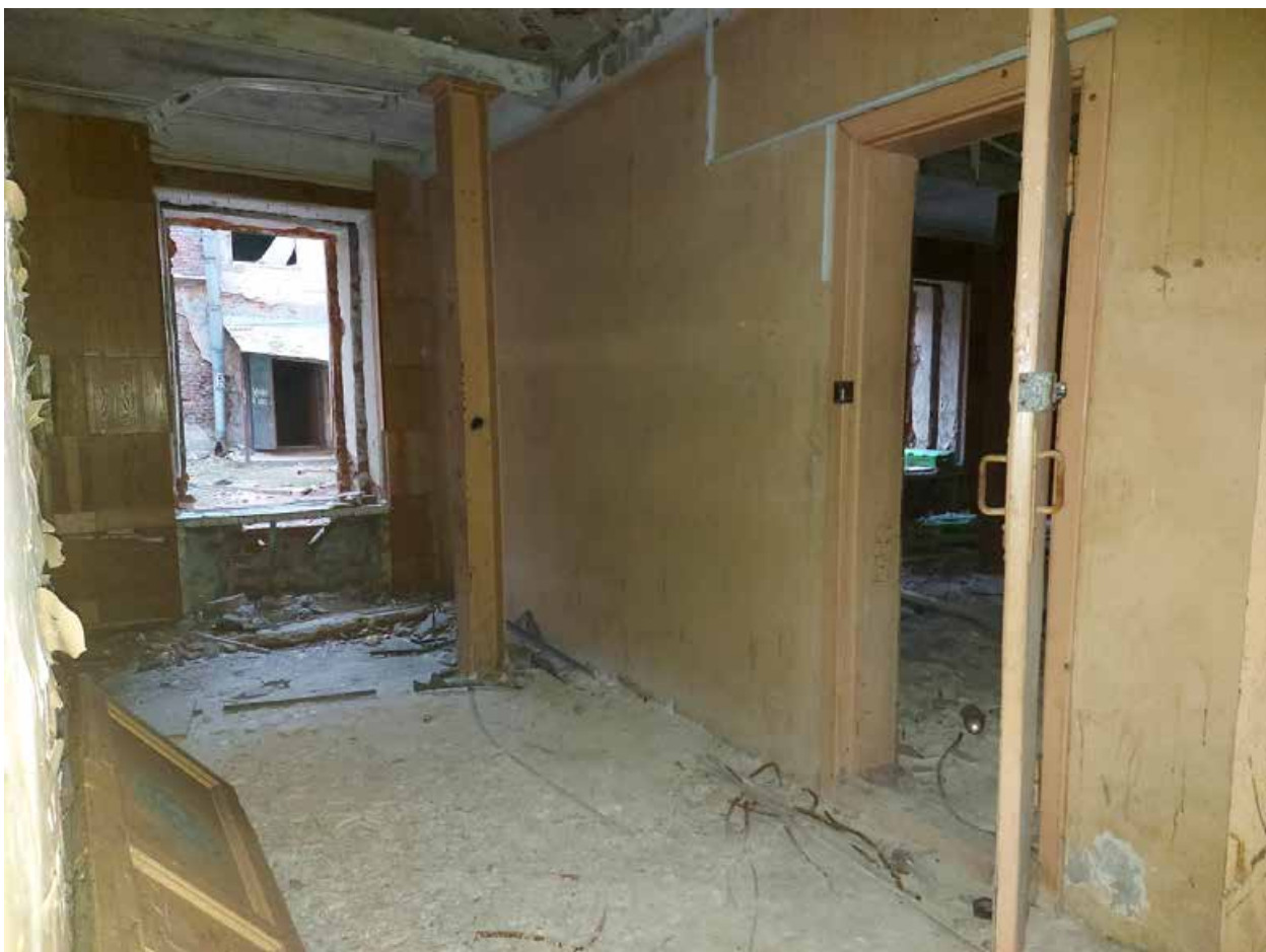
Фото 20. Помещение первого этажа центрального корпуса.
