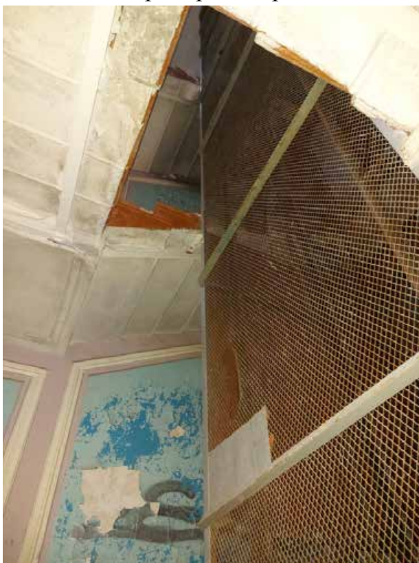
Фото 41. Северная лестничная клетка и лифт.
