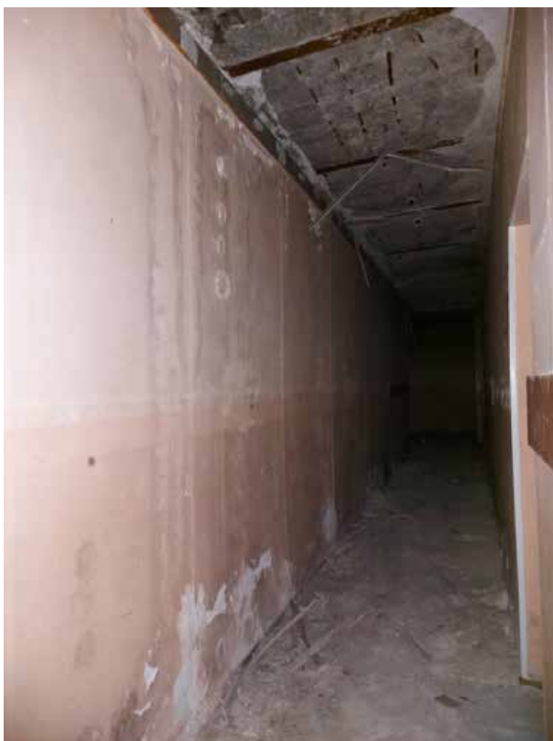
Фото 39. Коридор четвертого этажа.
