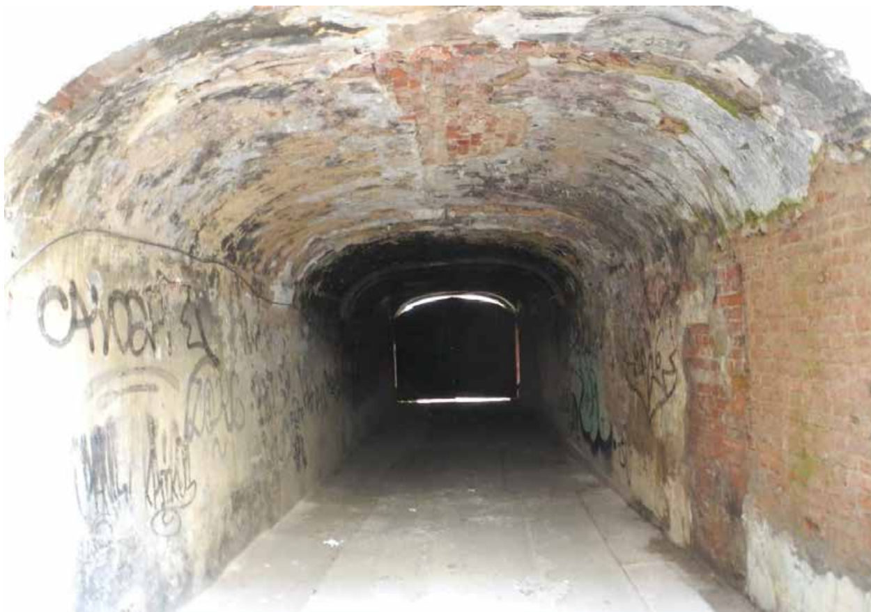
Фото 6. Проездная арка, вид со двора.
