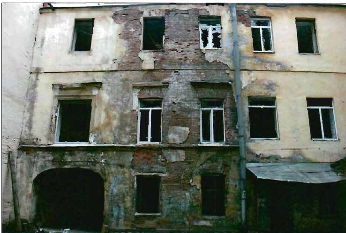
2. Дворовый фасад. Общий вид.
