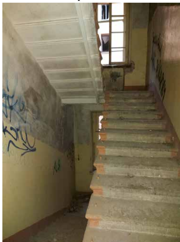
Фото 32. Лестница центрального корпуса со второго этажа.
