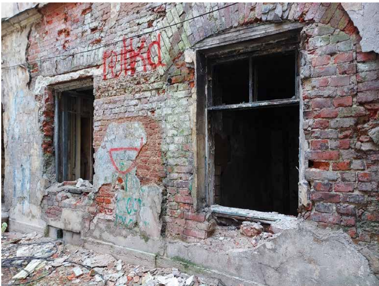
Фото 8. Проемы первого этажа.
