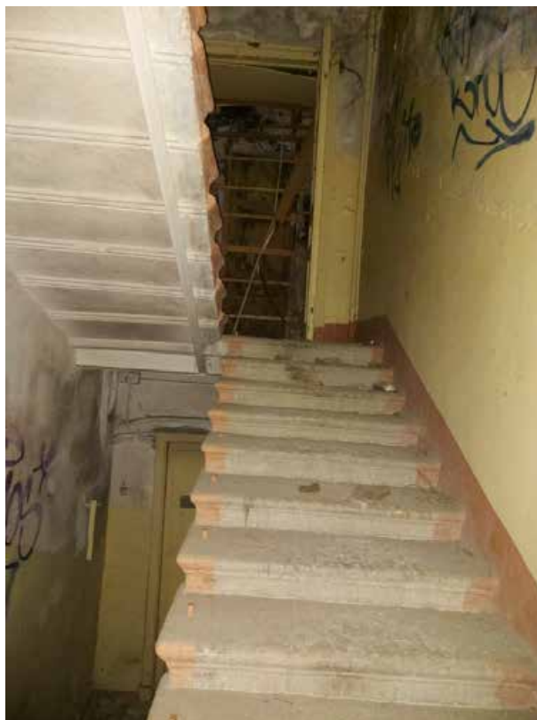
Фото 28. Лестница, вид с междуэтажной площадки.
