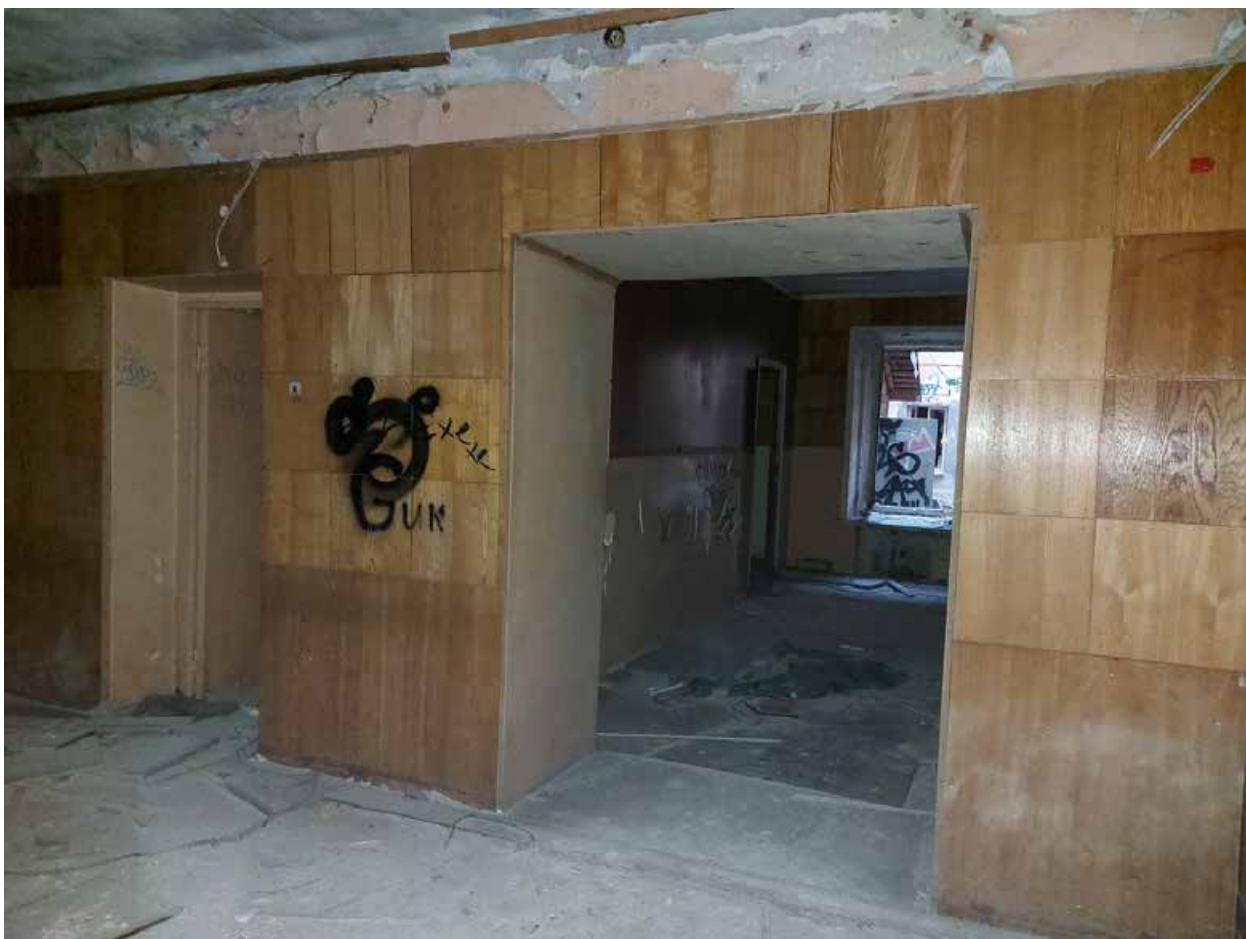
Фото 22. Проемы в помещении 10.
