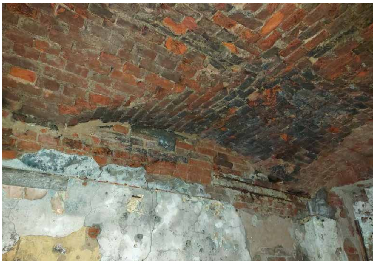
Фото 12. Фрагмент перекрытия, заложенные проемы.
