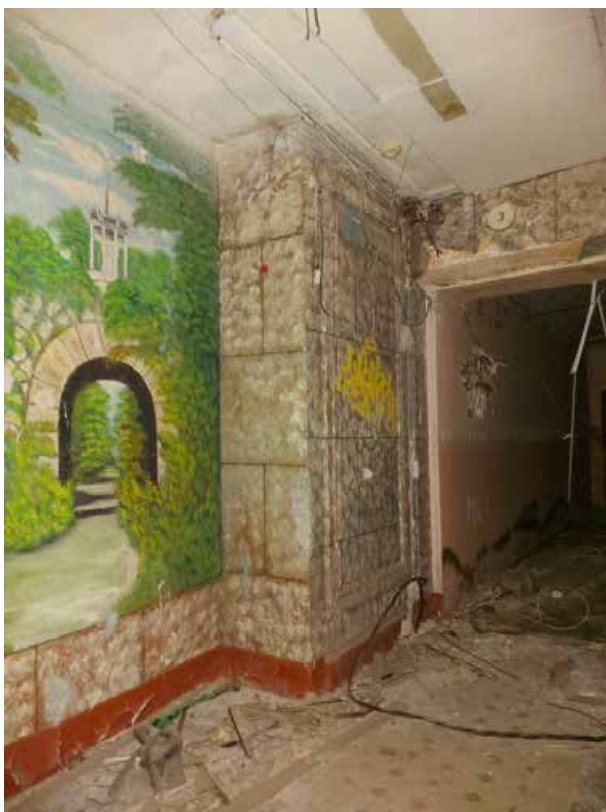
Фото 36. Площадка третьего этажа северной лестницы.
