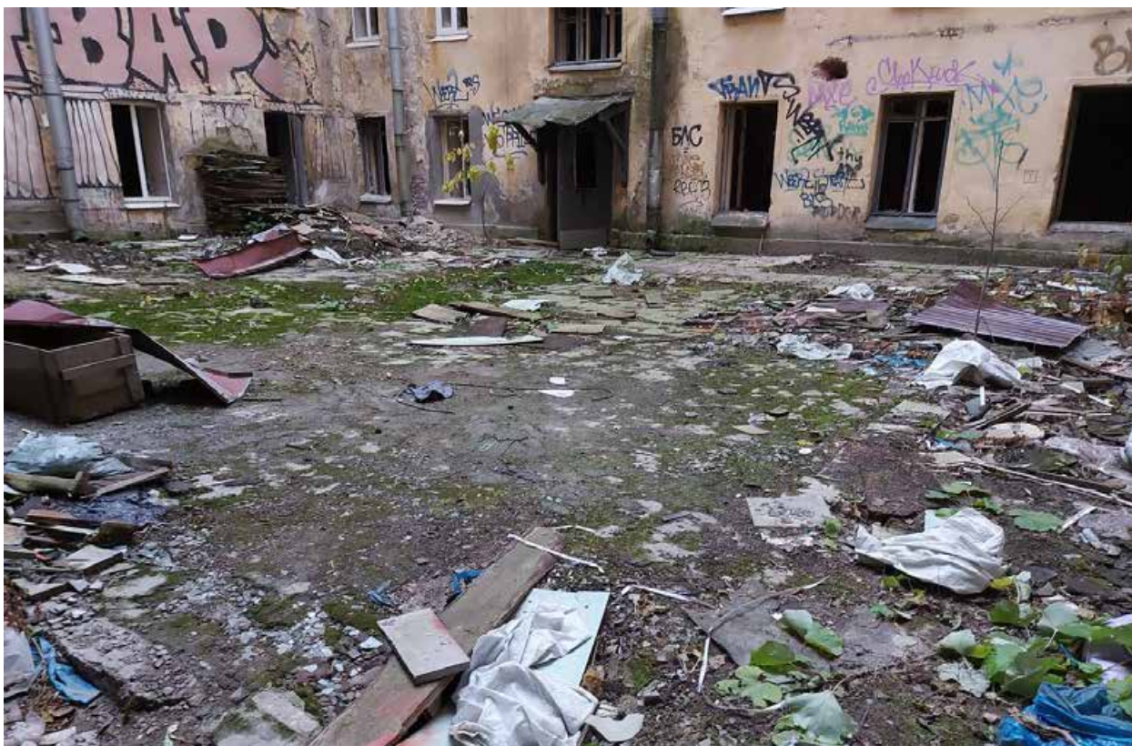
Фото 5. Общий вид второго двора с запада.
