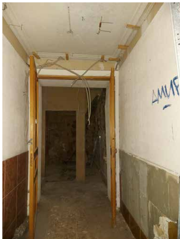
Фото 19. Коридор западного входа.
