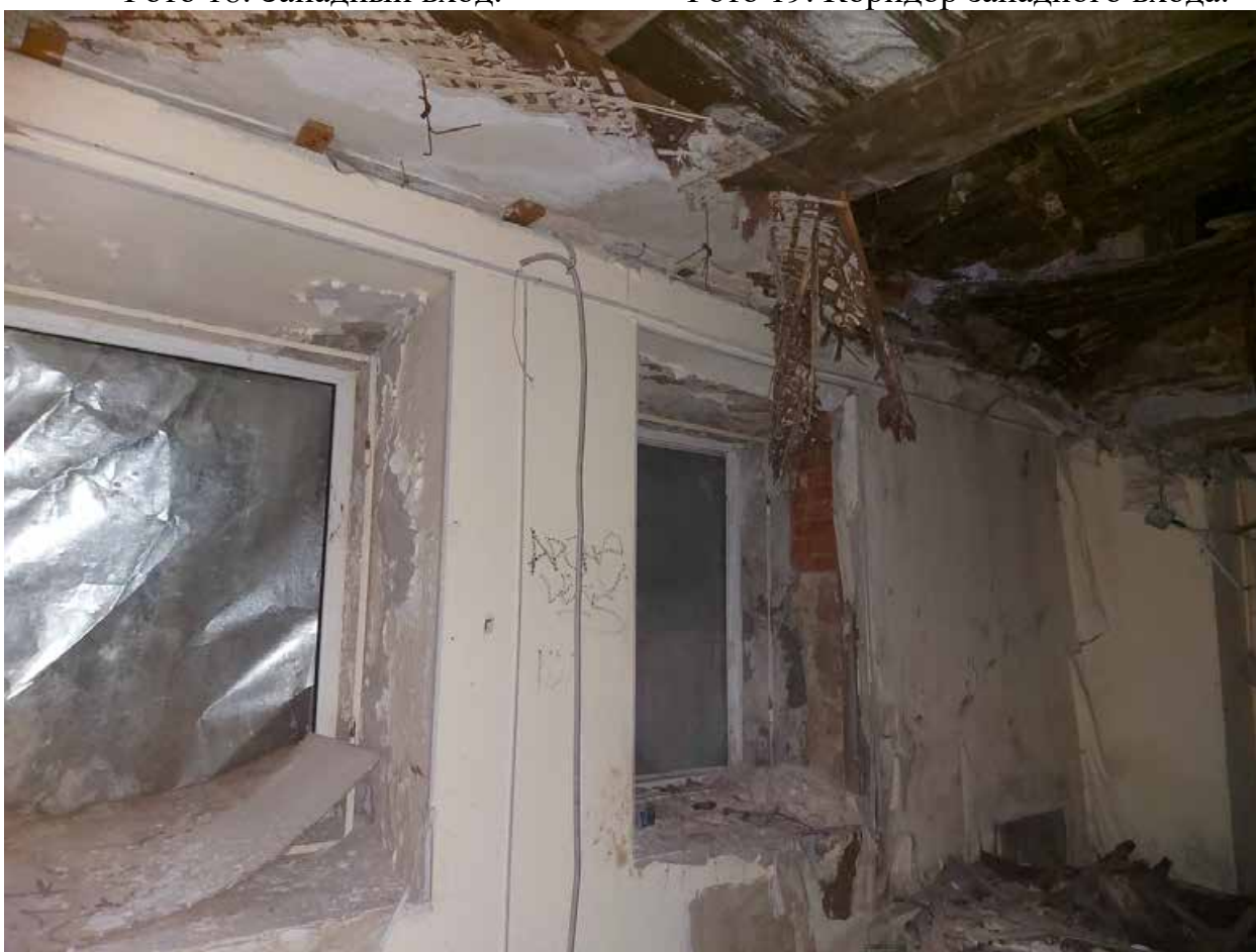
Фото 20. Проемы лицевого фасада.
