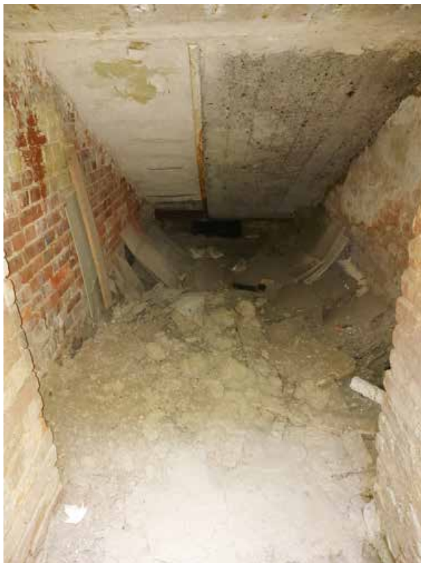
Фото 18. Помещение под лестницей центрального корпуса.
