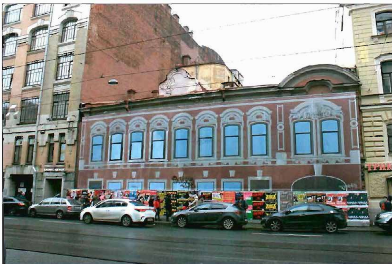
1. Общий вид со стороны лицевого фасада.
