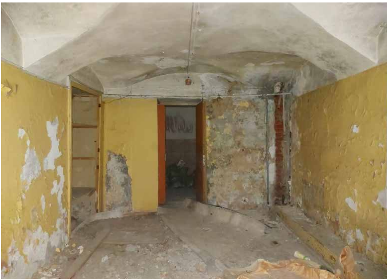
Фото 13. Помещение 5, по дворовому фасаду.
