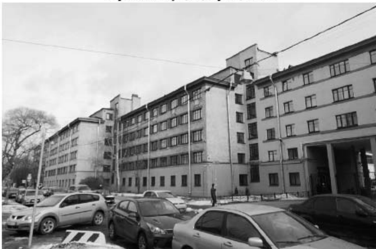
Фото 62. Вид на жилой корпус с юго-запада. Лицевой фасад. Адрес: СПб, Парголовская ул., 11, корп. 1, лит. А
