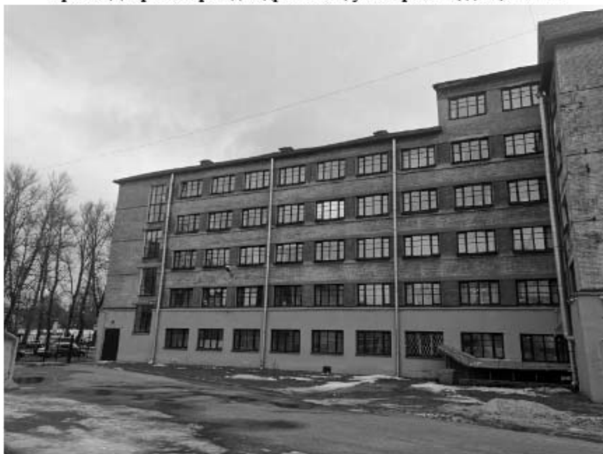
Фото 4. Общий вид на общежитие №6 с запада. Крайний корпус северного крыла. Дворовый фасад. Адрес: СПб, ул. Харченко, д 16, лит. А
