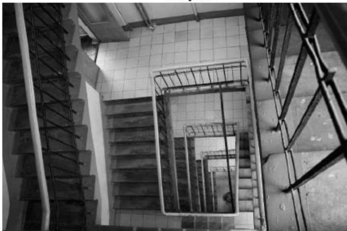
Фото 168. Общий вид типовую лестничную клетку. 5-й этаж. Здание общежития №4 (южные корпуса). Адрес: СПб, Парголово, улица, дом 11, корпус 1, литера А.
