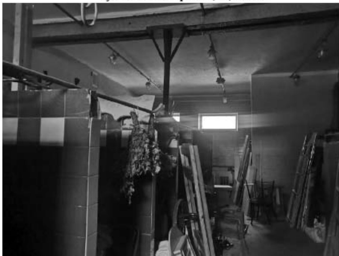
Фото 110. Общий вид на помещение 19. Здание прачечной. Адрес: СПб, ул. Капитана Воронина, 11, лит. А.
