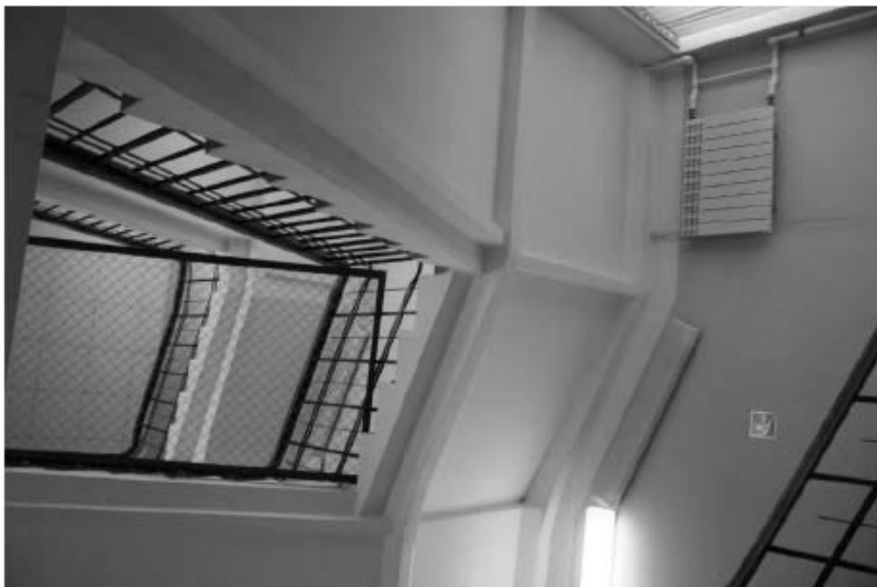
Фото 215. Общий вид на лестничную клетку общежития. Здание общежития № 1. Адрес: СПб, Лесной пр., дом 65, корпус 1, лит. А.
