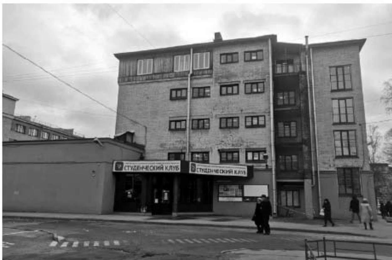
Фото 45. Вид на восточный жилой корпус с севера. Адрес: СПб, Парголовская ул., 11, корп. 2, лит. А
