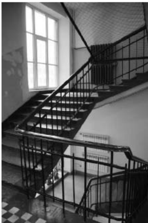
Фото 131. Общий вид на лестничную клетку. 4-й этаж. Адрес: СПб, ул. Харченко, 16.
