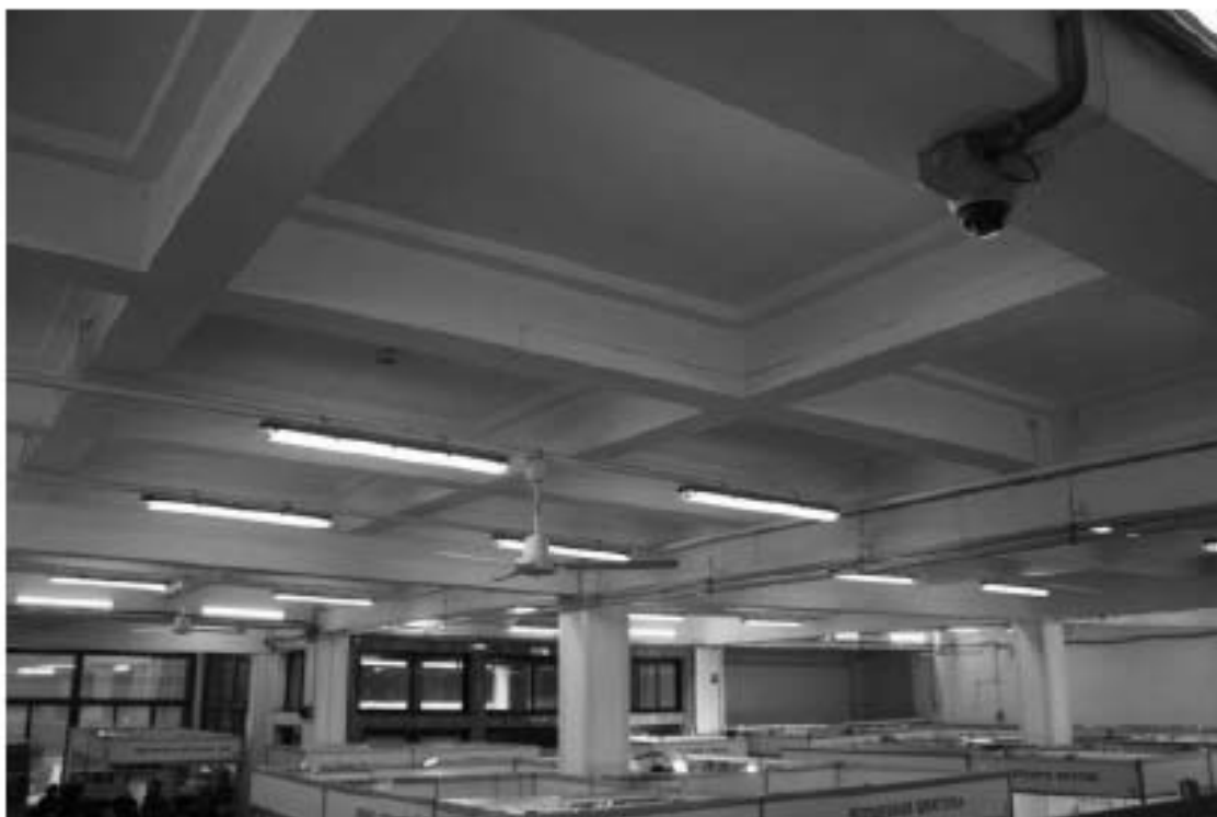
Фото 101. Общий вид на помещение 12. 1-й этаж. Здание фабрики-кухни. Адрес: СПб, ул. Капитана Воронина, 13, лит. А.
