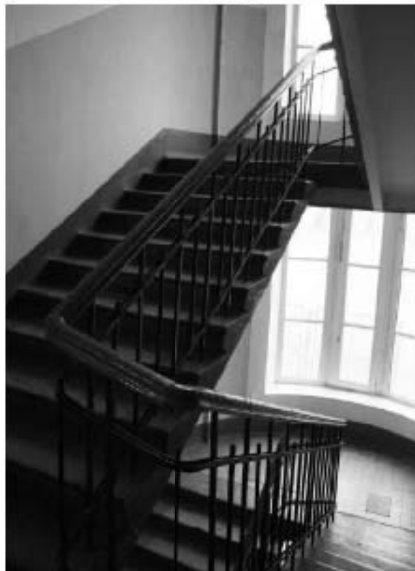
Фото 194. Общий вид на типовую лестничную клетку общежития. Здание общежития № 3. Адрес: СПб, Лесной пр., дом 65, корпус 3, лит. В.
