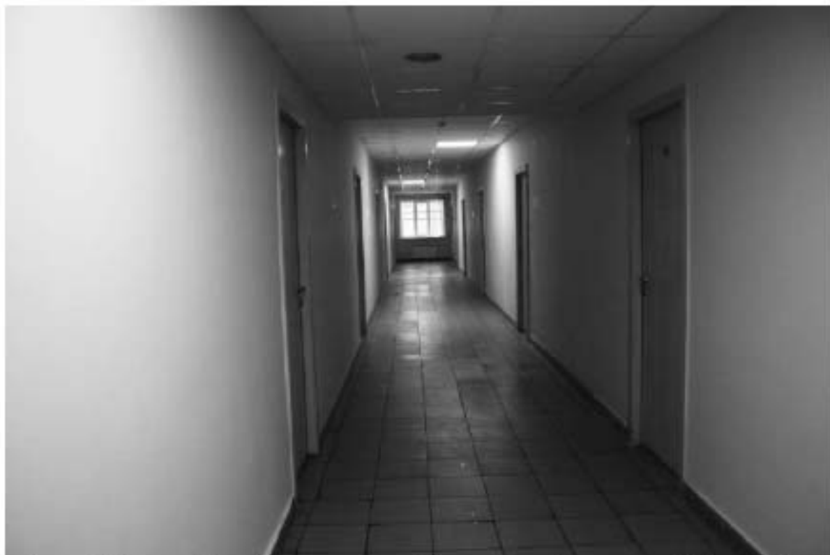
Фото 217. Общий вид на типовой коридор общежития. 3-й этаж. Здание общежития № 1. Адрес: СПб, Лесной пр., дом 65, корпус 1, литера А.
