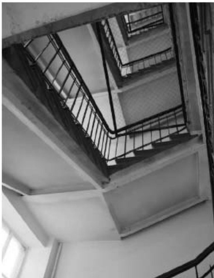
Фото 121. Общий вид на лестничную клетку. 1-й этаж. Адрес: СПб, ул. Харченко, 16.
