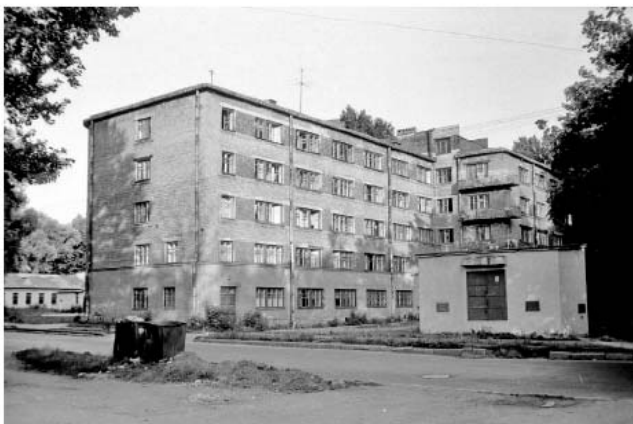
Илл. 53. Ленинград. Общежитие №3 Политехнического института - Лесной проспект, д. 65, корп. 3, лит. В. Вид с улицы Капитана Воронина. Июль 1988 г. Автор: Фролов Александр. (Источник: https://pastvu.com/p/301330 )
