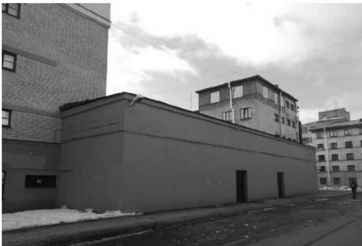
Фото 53. Вид на здание клуба с двумя жилыми корпусами с северо-востока. Адрес: СПб, Парголовская ул., 11, корп. 2, лит. А
