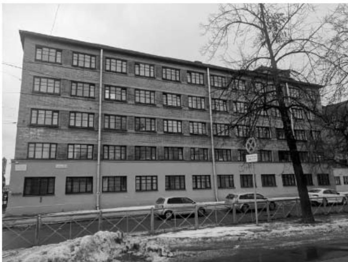
Фото 11. Общий вид на общежитие №6 с востока. Крайний корпус южного крыла. Лицевой фасад. Адрес: СПб, ул. Харченко, д 16, лит. А
