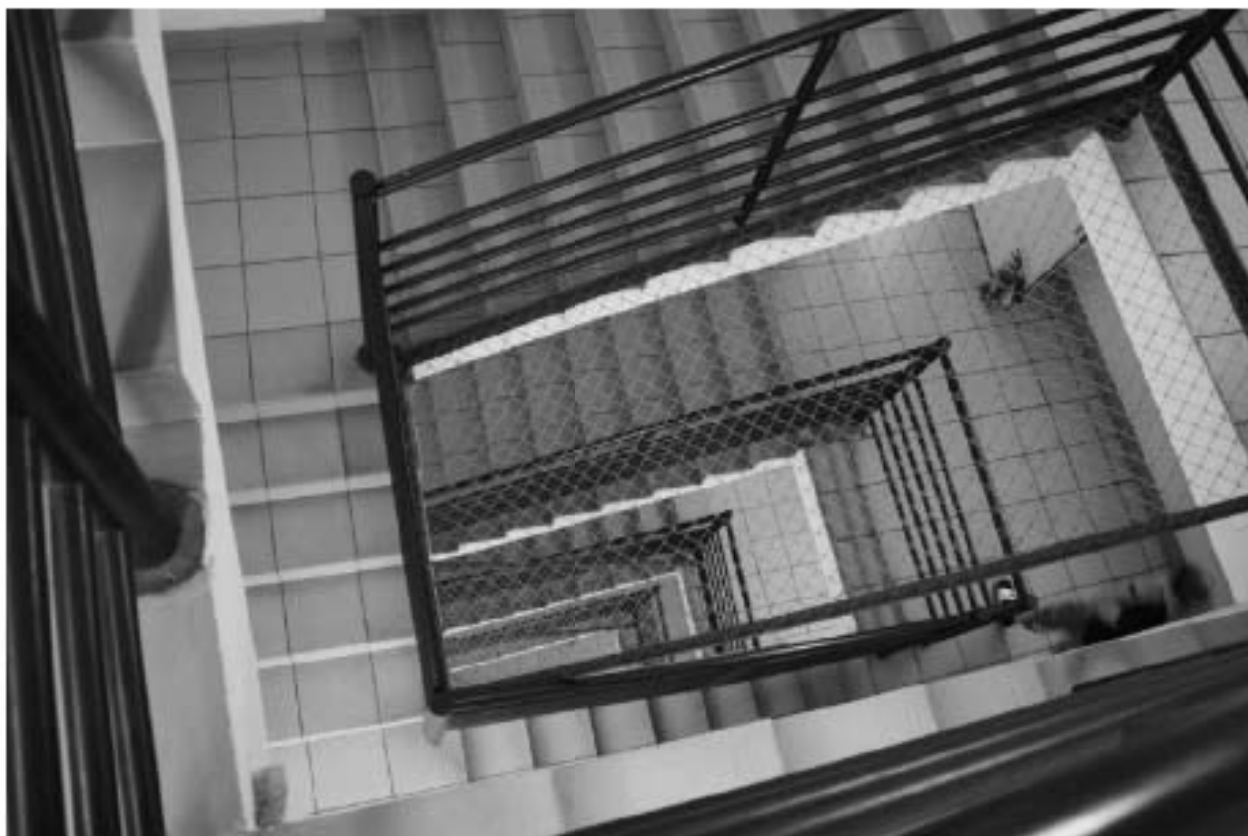
Фото 219. Общий вид на лестничную клетку общежития. 5-й этаж. Здание общежития № 1. Адрес: СПб, Лесной пр., дом 65, корпус 1, лит. А.
