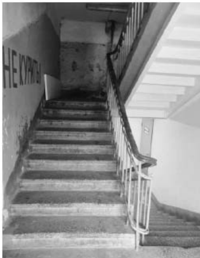
Фото 95. Общий вид на помещение 90 (лестничная клетка). 3-й этаж. Здание фабрики-кухни. Адрес: СПб, ул. Капитана Воронина, 13, лит. А.
