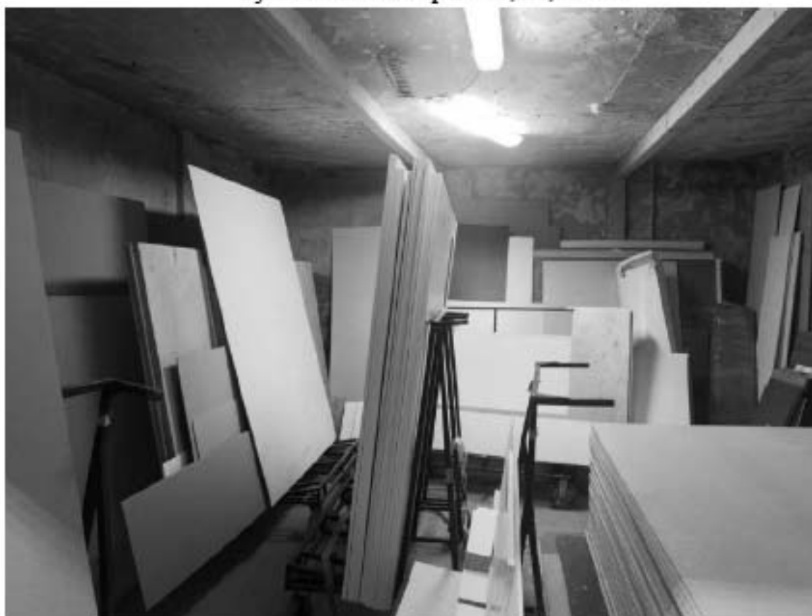
Фото 116. Общий вид на помещение 3. Здание прачечной. Адрес: СПб, ул. Капитана Воронина, 13, лит. В.
