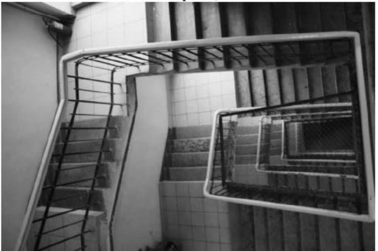
Фото 136. Общий вид на лестничную клетку. 5-й этаж. Адрес: СПб, ул. Харченко, 16.
