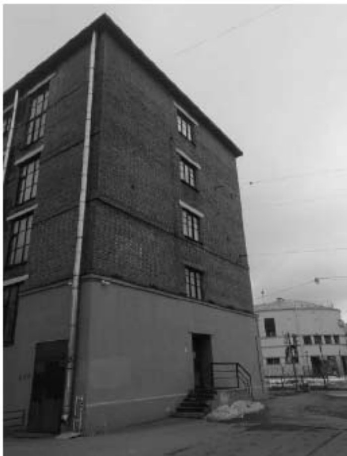
Фото 9. Общий вид на общежитие №6 с юга. Торцевой фасад. Адрес: СПб, ул. Харченко, д 16, лит. А
