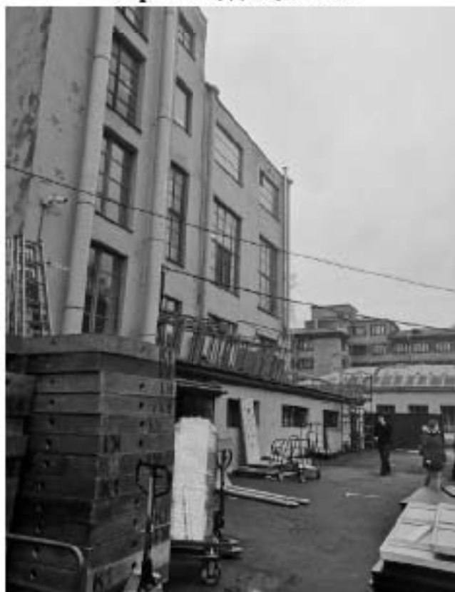
Фото 30. Вид на дворовый фасад КВЦ «Евразия». Адрес: СПб, ул. Капитана Воронина, д 13, лит. А
