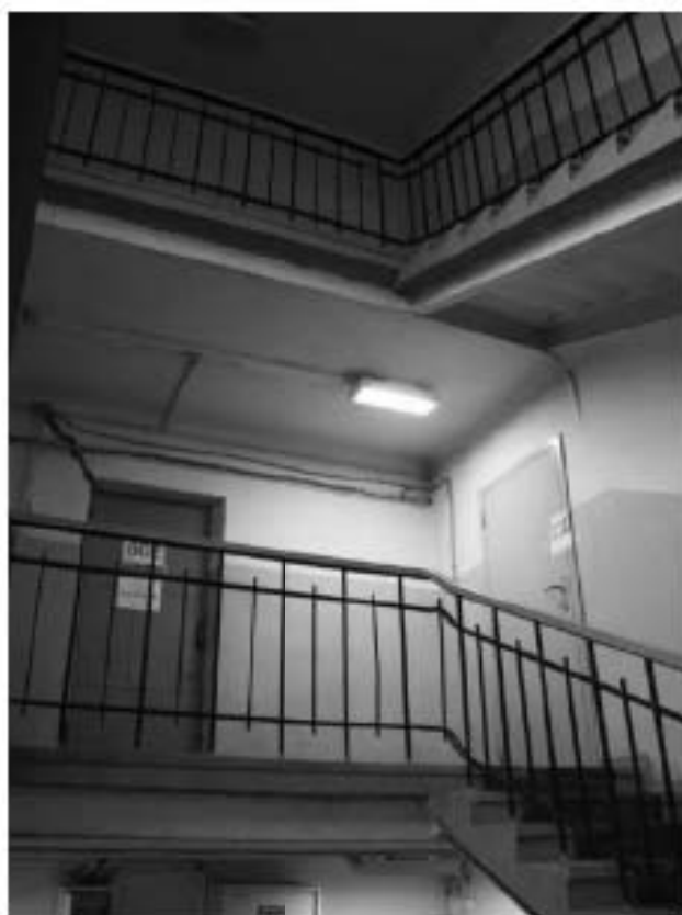
Фото 189. Общий вид типовую лестничную клетку. 4-й этаж. Здание общежития №4а (северные корпуса). Адрес: СПб, Парголовская улица, дом 11, корпус 1, литера А.
