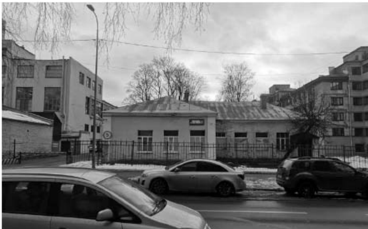
Фото 31. Вид на бывшую прачечную с северо-запада. Главный фасад. Адрес: СПб, ул. Капитана Воронина, д 11.
