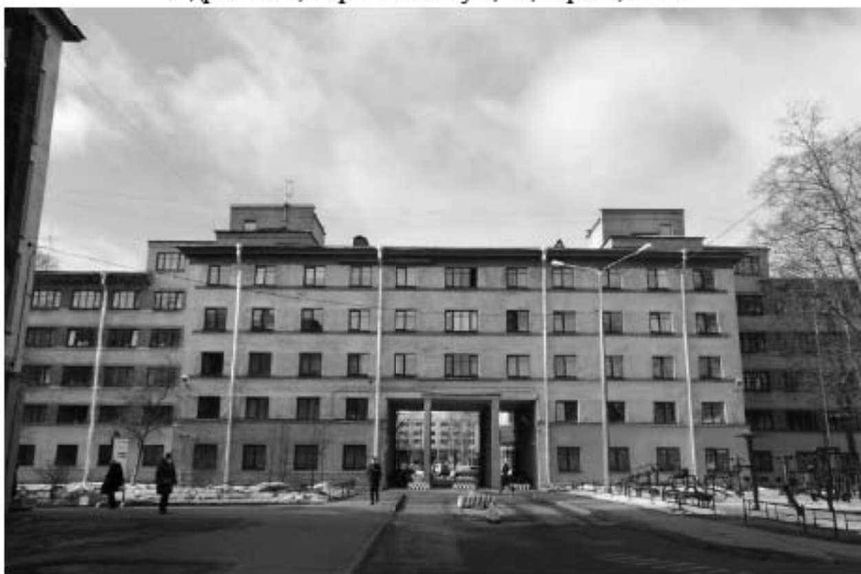
Фото 54. Вид на жилой корпус с востока. Дворовый фасад. Адрес: СПб, Парголовская ул., 11, корп. 1, лит. А
