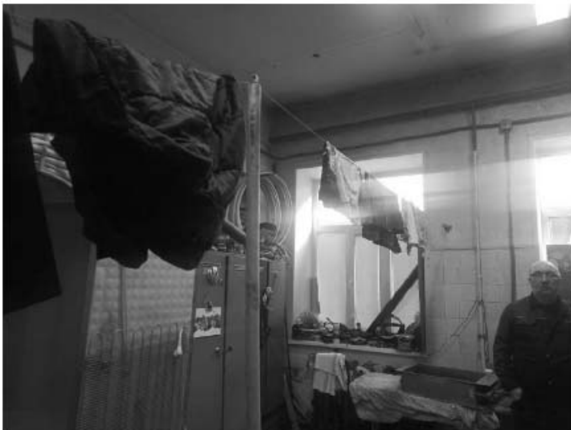
Фото 107. Общий вид на помещение 6. Здание прачечной. Адрес: СПб, ул. Капитана Воронина, 11, лит. А.
