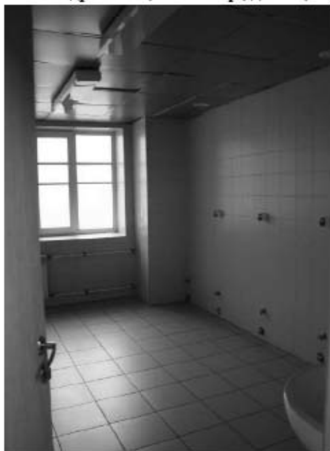
Фото 210. Общий вид на санитарный узел. 1-й этаж. Здание общежития № 1. Адрес: СПб, Лесной пр., дом 65, корпус 1, литера А.
