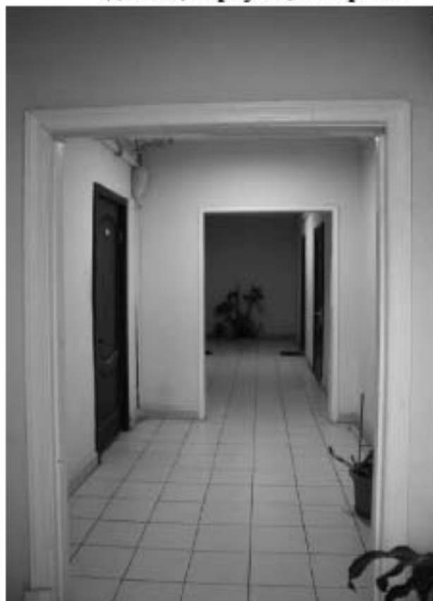
Фото 182. Общий вид на типовой коридор общежития. 1-й этаж. Здание общежития №4а (северные корпуса). Адрес: СПб, Парголовская улица, дом 11, корпус 1, литера А.
