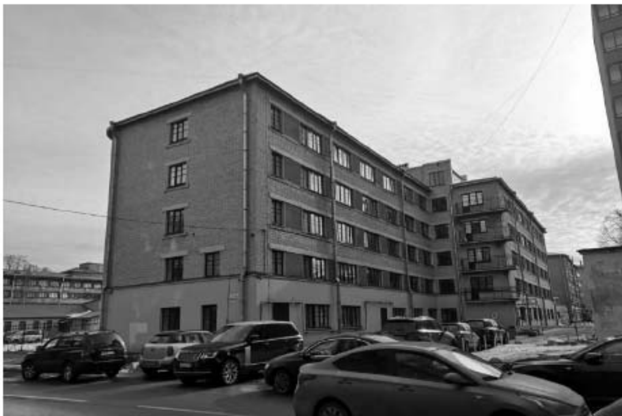
Фото 81. Общий вид на общежитие №3 с северо-запада. Адрес: СПб, Лесной пр., 65, корп. 3, лит. В
