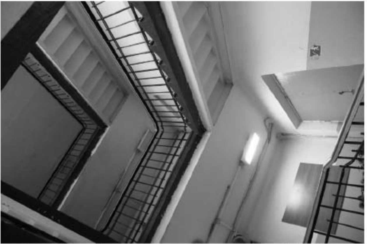
Фото 183. Общий вид типовую лестничную клетку. 3-й этаж. Здание общежития №4а (северные корпуса). Адрес: СПб, Парголовская улица, дом 11, корпус 1, литера А.
