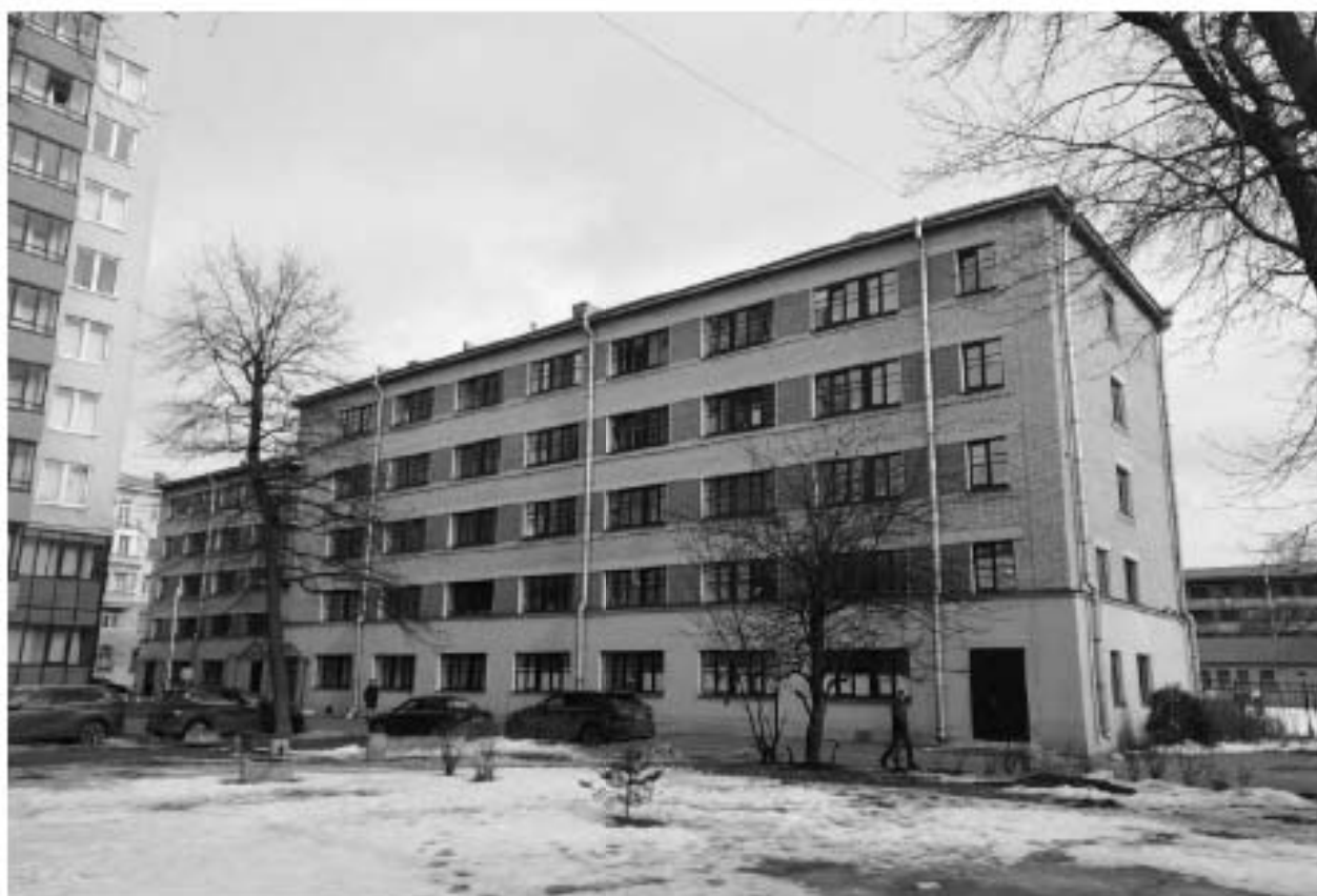
Фото 79. Общий вид на общежитие №3 с юго-запада. Адрес: СПб, Лесной пр., 65, корп. 3, лит. В
