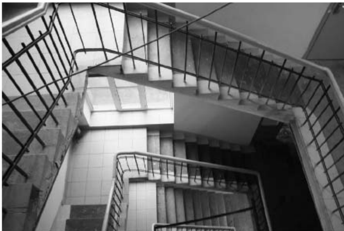
Фото 125. Общий вид на лестничную клетку. 3-й этаж. Адрес: СПб, ул. Харченко, 16.
