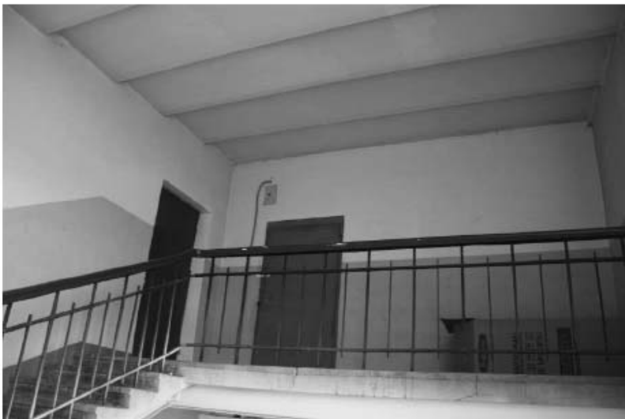
Фото 133. Общий вид на лестничную клетку. 5-й этаж. Адрес: СПб, ул. Харченко, 16.
