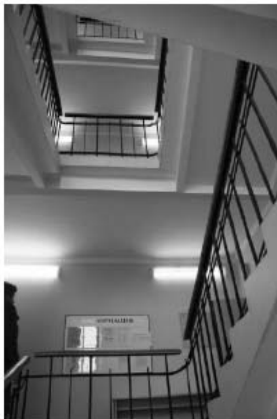
Фото 152. Общий вид на лестничную клетку. 1-й этаж. Здание общежития №56 (восточный корпус). Адрес: СПб, Парголовская улица, дом 11, корпус 2, литера А.
