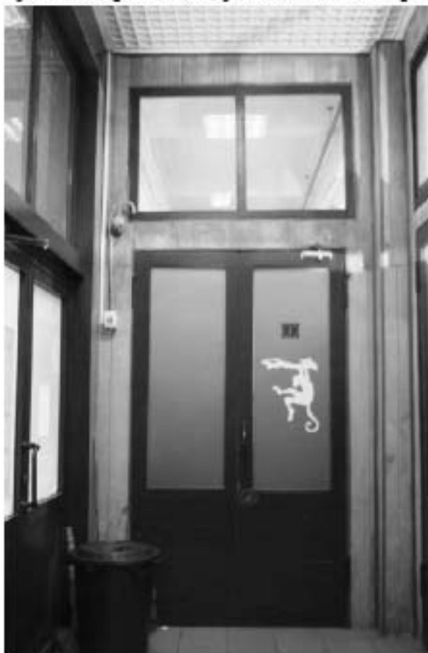
Фото 104. Общий вид на помещение 11. 1-й этаж. Здание фабрики-кухни. Адрес: СПб, ул. Капитана Воронина, 13, лит. А.
