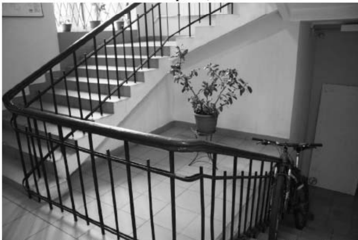
Фото 120. Общий вид на лестничную клетку. 1-й этаж. Адрес: СПб, ул. Харченко, 16.
