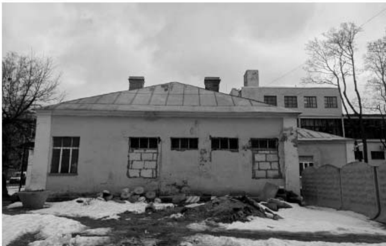
Фото 37. Вид на бывшую прачечную с запада. Торцевой фасад. Адрес: СПб, ул. Капитана Воронина, д 11.
