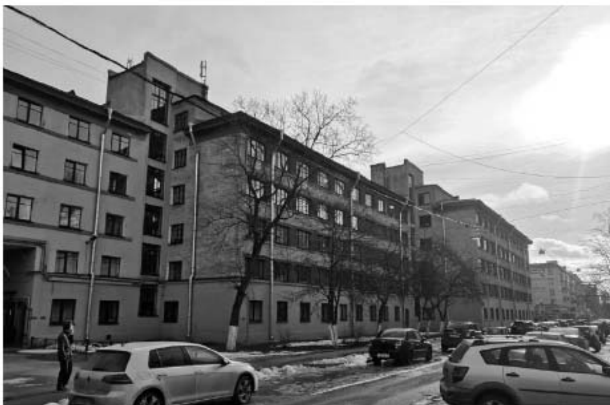
Фото 61. Вид на жилой корпус с северо-запада. Лицевой фасад. Адрес: СПб, Парголовская ул., 11, корп. 1, лит. А
