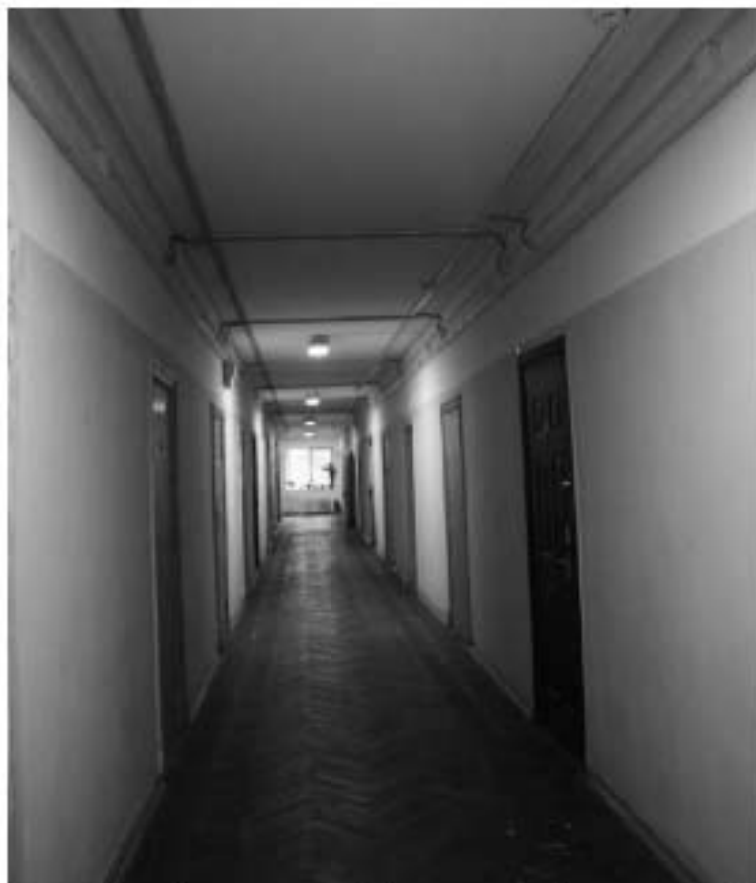
Фото 185. Общий вид типовой коридор общежития. 3-й этаж. Здание общежития №4а (северные корпуса). Адрес: СПб, Парголовская улица, дом 11, корпус 1, литера А.
