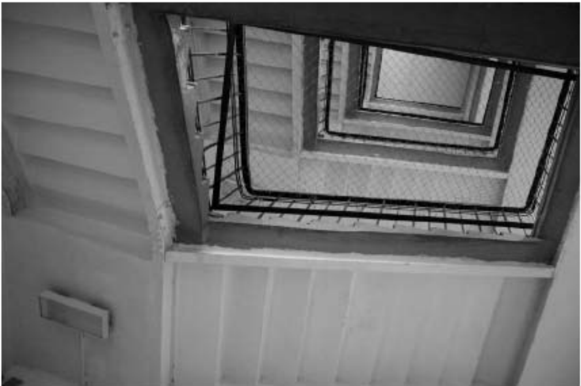
Фото 159. Общий вид на типовую лестничную клетку. Здание общежития №4 (южные корпуса). Адрес: СПб, Парголовская улица, дом 11, корпус 1, литера А.
