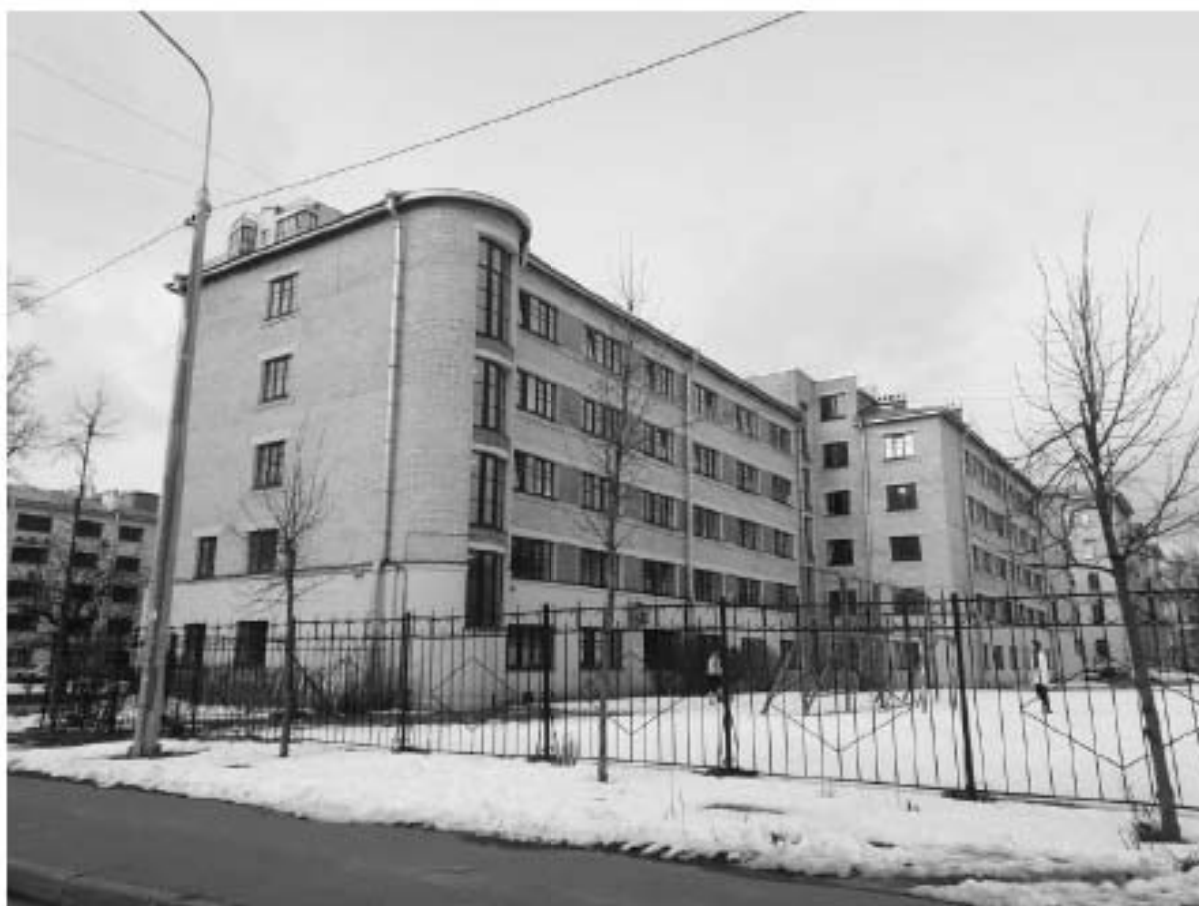
Фото 77. Общий вид на общежитие №3 с юго-востока. Адрес: СПб, Лесной пр., 65, корп. 3, лит. В
