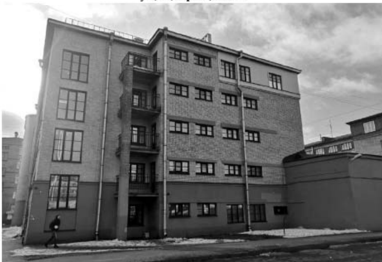
Фото 52. Вид на западный жилой корпус с севера. Адрес: СПб, Парголовская ул., 11, корп. 2, лит. А
