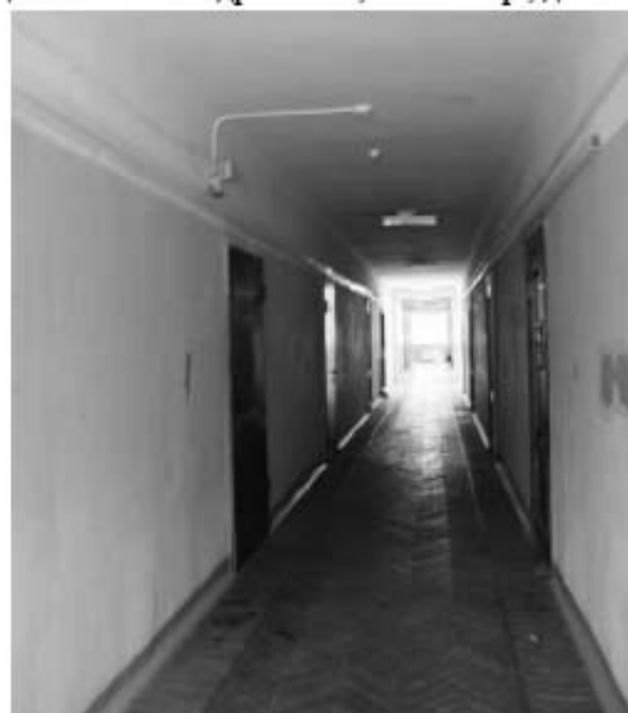
Фото 196. Общий вид на типовой коридор общежития. 1-й этаж. Здание общежития № 3. Адрес: СПб, Лесной пр., дом 65, корпус 3, литера В.
