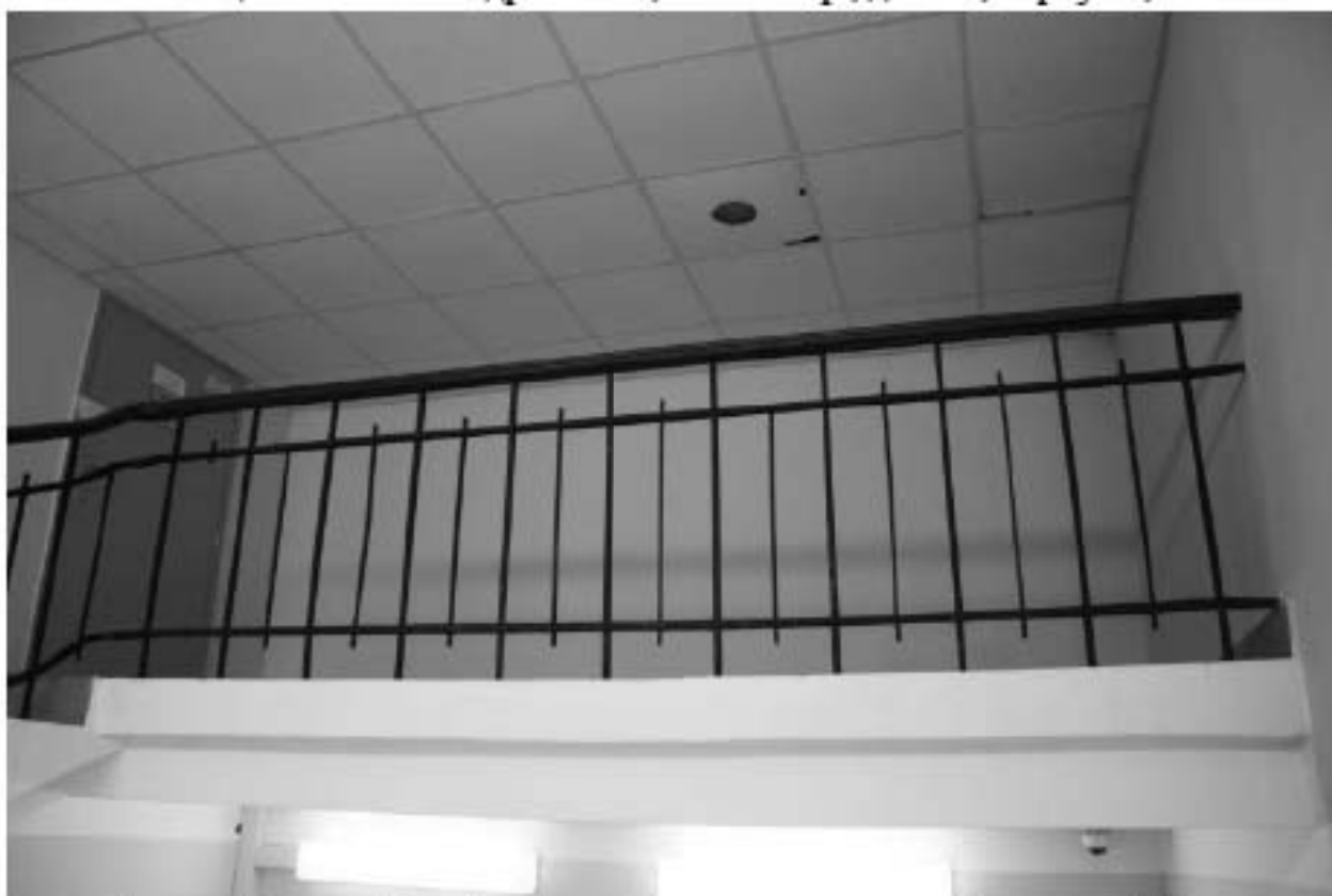
Фото 216. Общий вид на лестничную клетку общежития. 5-й этаж. Здание общежития № 1. Адрес: СПб, Лесной пр., дом 65, корпус 1, лит. А.
