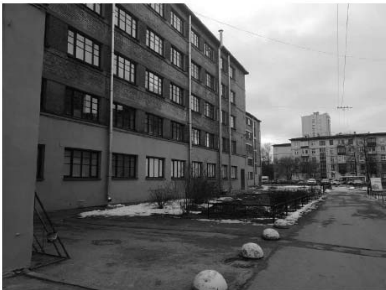
Фото 19. Общий вид на территорию общежития №6 (слева) с юга. Дворовый фасад. Адрес: СПб, ул. Харченко, д 16, лит. А
