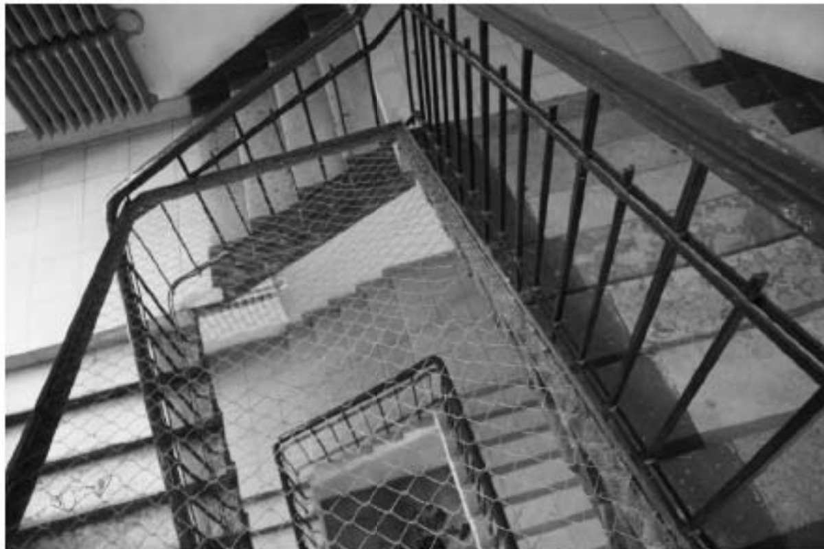
Фото 132. Общий вид на лестничную клетку. 4-й этаж. Адрес: СПб, ул. Харченко, 16.
