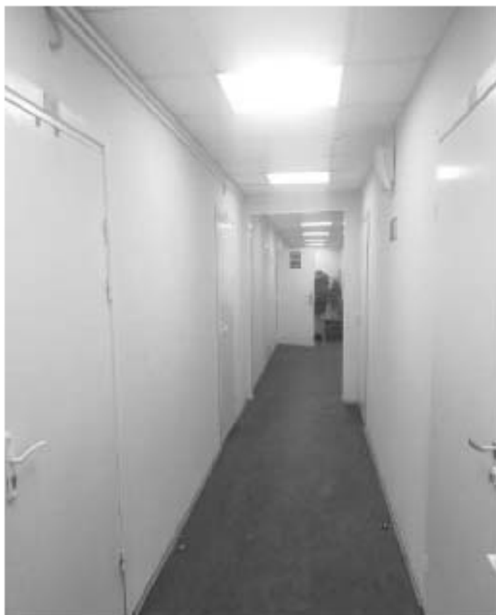
Фото 150. Общий вид на типовой коридор общежития. 1-й этаж. Здание общежития №5 (западный корпус). Адрес: СПб, Парголовская улица, дом 11, корпус 2, литера А.
