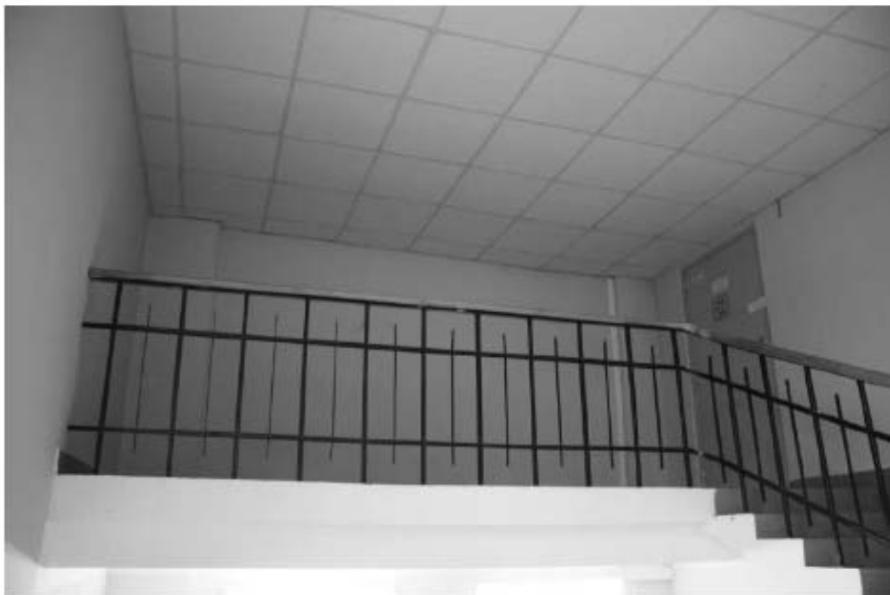
Фото 223. Общий вид на лестничную клетку общежития. 5-й этаж. Здание общежития № 1. Адрес: СПб, Лесной пр., дом 65, корпус 1, лит. А.
