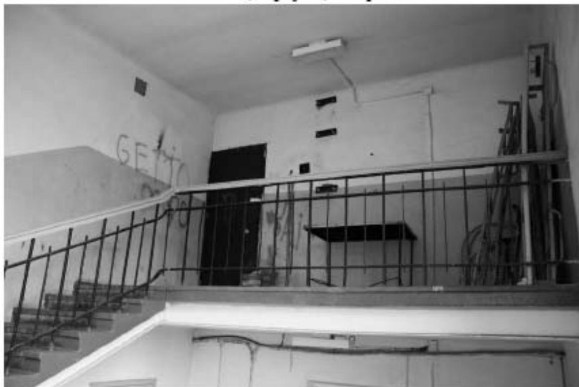
Фото 166. Общий вид типовую лестничную клетку. 6-й этаж. Здание общежития №4 (южные корпуса). Адрес: СПб, Парголовская улица, дом 11, корпус 1, литера А.
