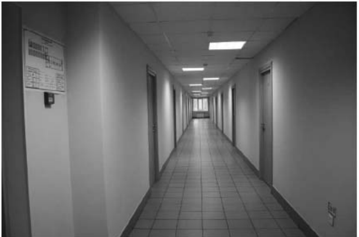
Фото 200. Общий вид на типовой коридор общежития. 2-й этаж. Здание общежития № 3. Адрес: СПб, Лесной пр., дом 65, корпус 3, литера В.
