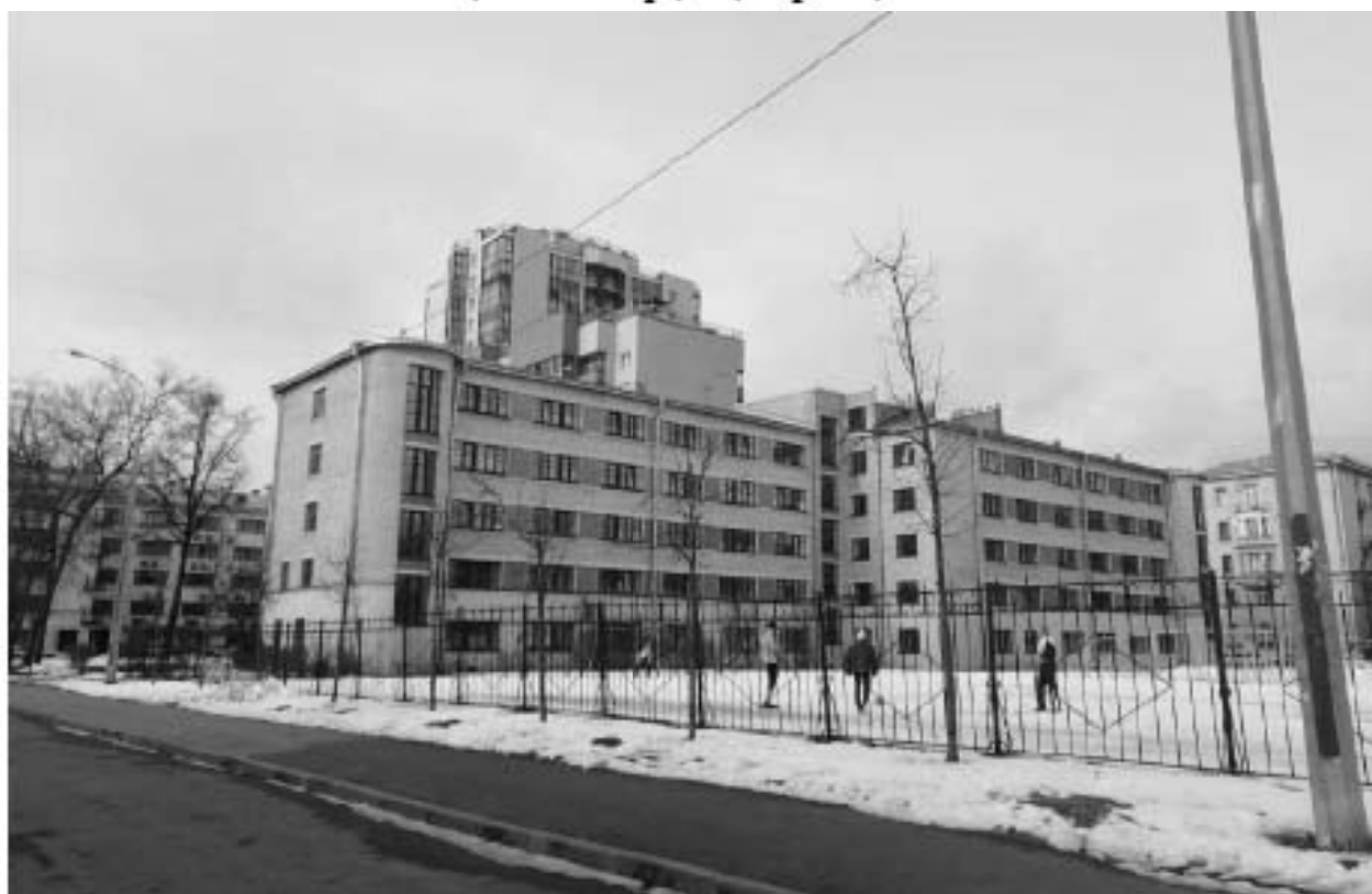
Фото 76. Общий вид на общежитие №3 с юго-востока. Адрес: СПб, Лесной пр., 65, корп. 3, лит. В
