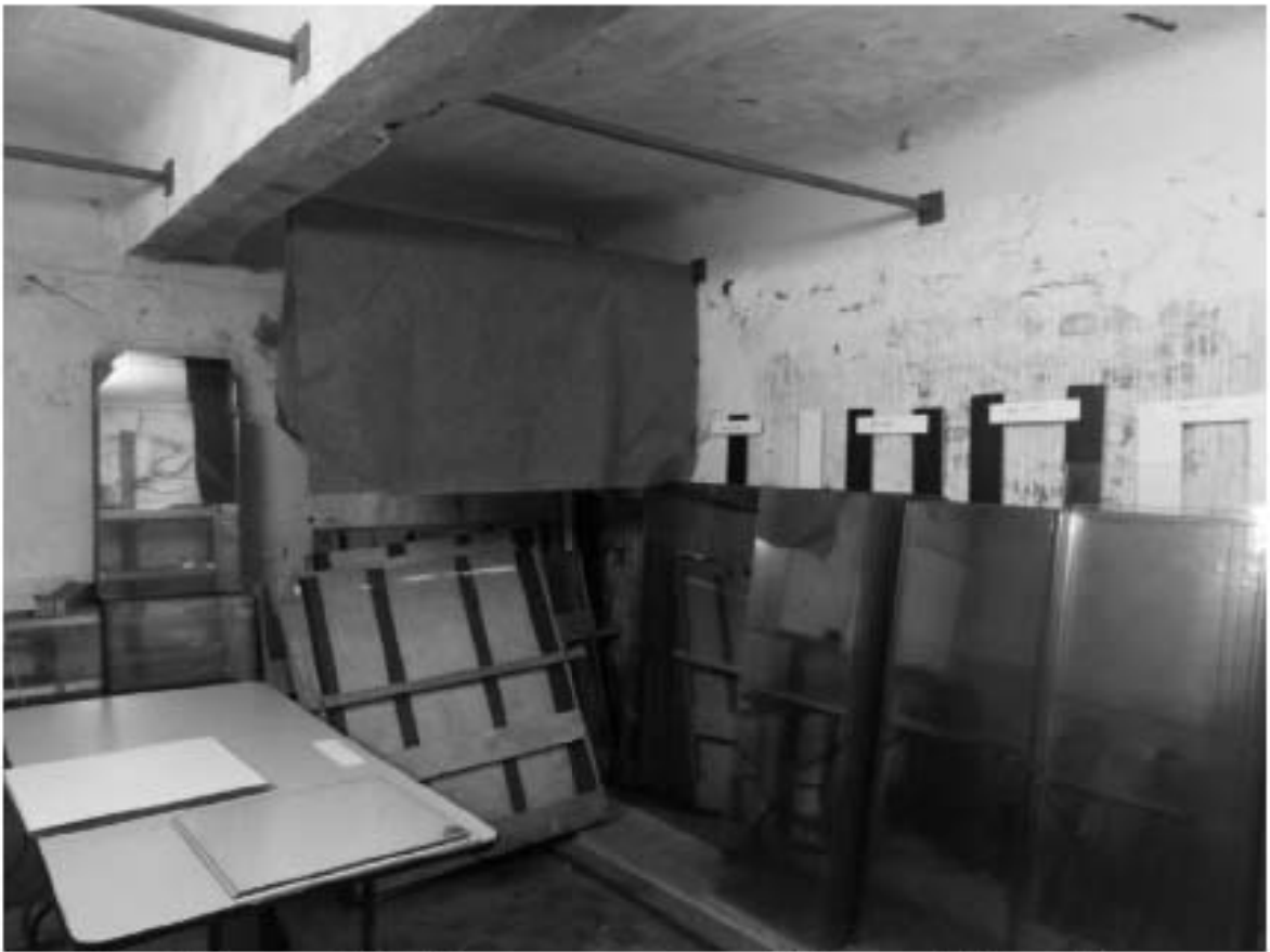
Фото 113. Общий вид на помещение 4. Адрес: СПб, ул. Капитана Воронина, 13, лит. Б.
