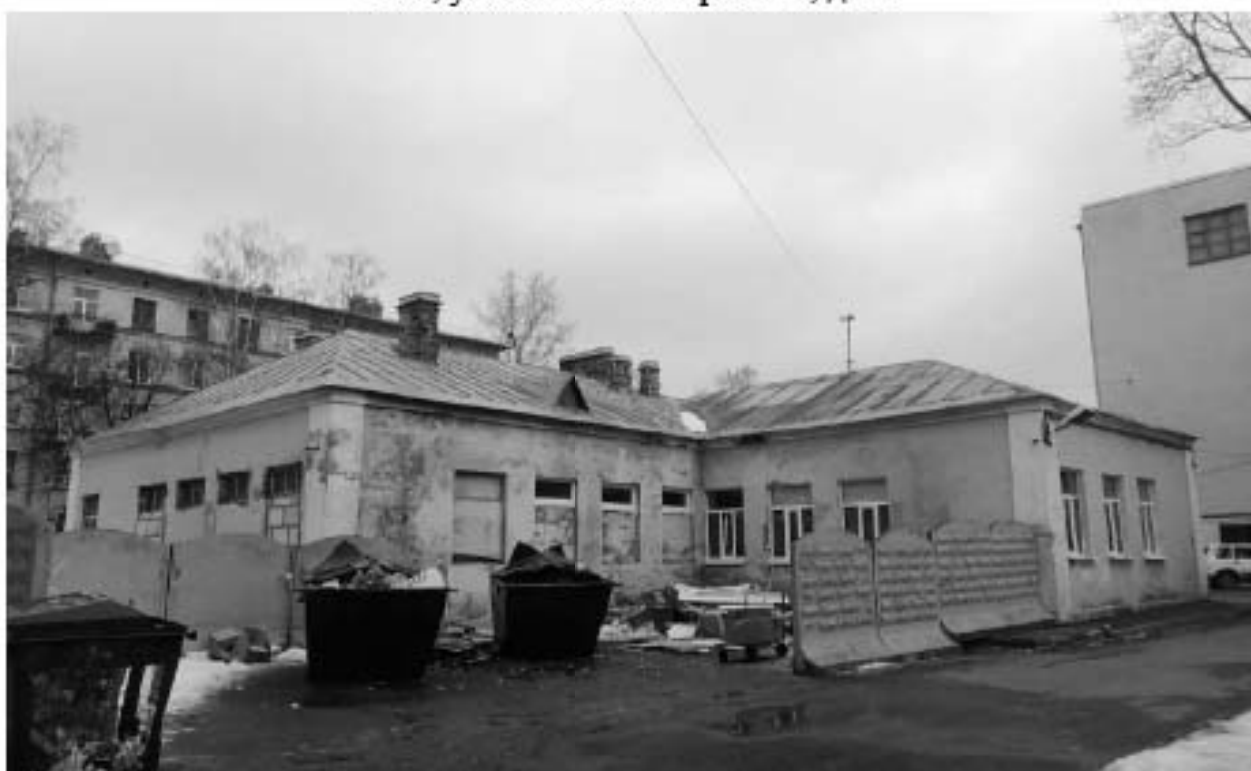
Фото 34. Вид на бывшую прачечную с юго-запада. Дворовый фасад. Адрес: СПб, ул. Капитана Воронина, д 11.
