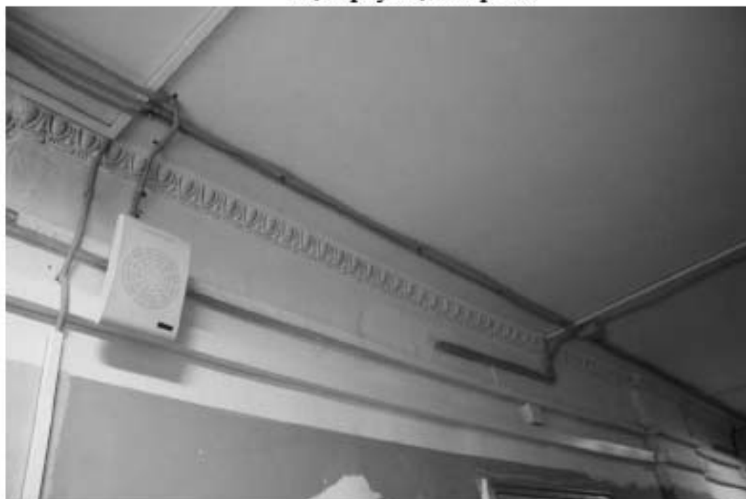
Фото 164. Общий вид штукатурный декор потолка. 4-й этаж. Здание общежития №4 (южные корпуса). Адрес: СПб, Парголово, улица, дом 11, корпус 1, литера А.
