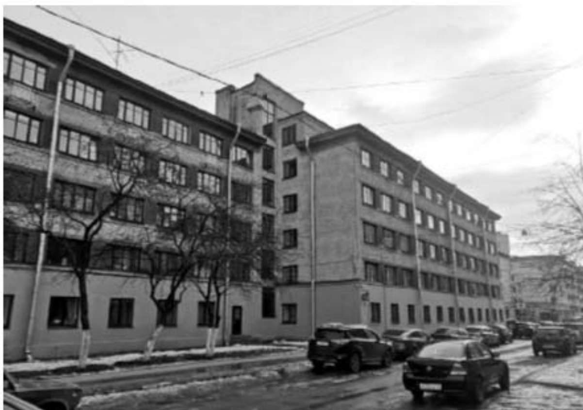
Фото 63. Вид на жилой корпус с северо-запада. Лицевой фасад. Адрес: СПб, Парголовская ул., 11, корп. 1, лит. А
