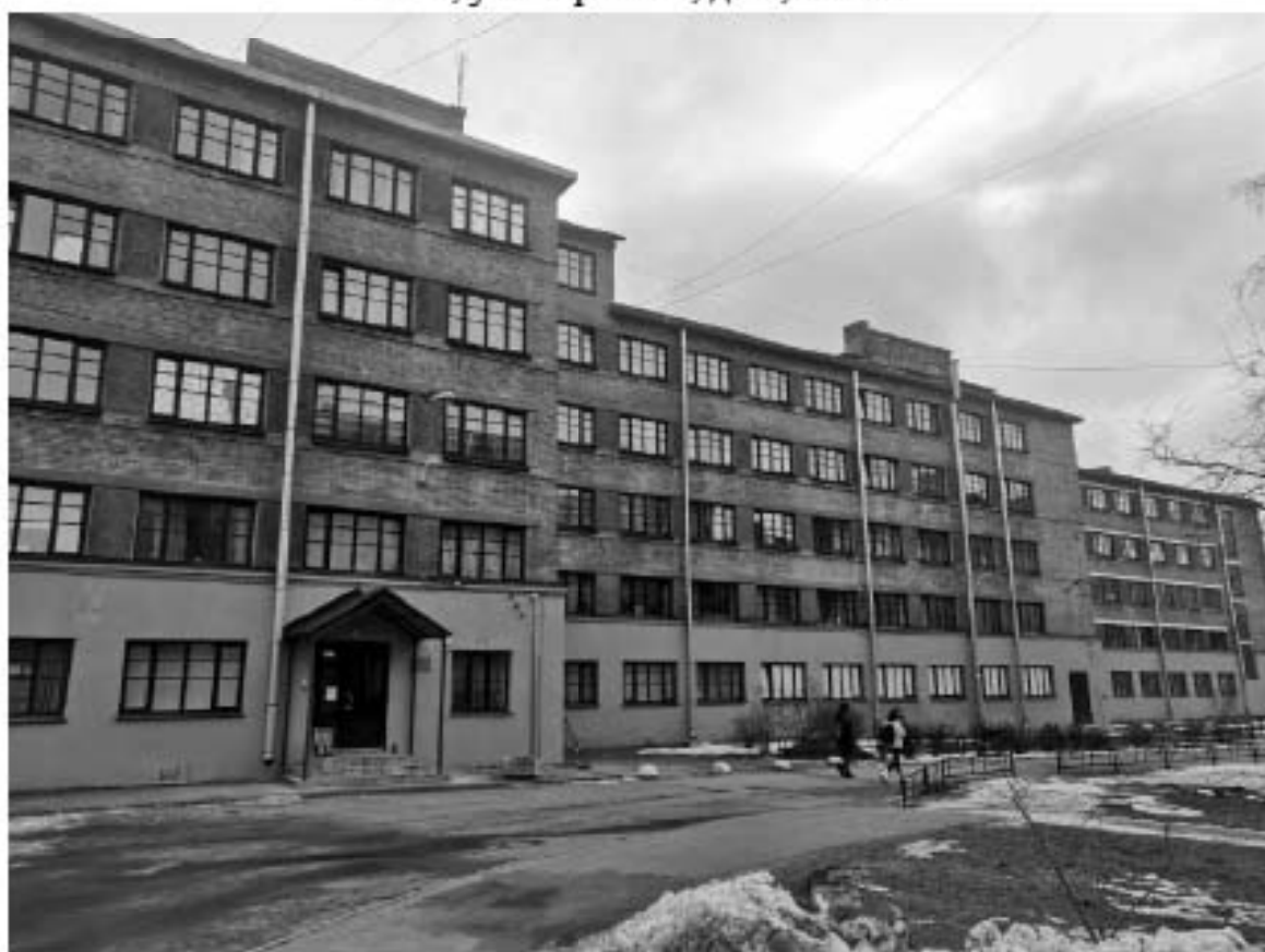
Фото 6. Общий вид на общежитие №6 с запада. Средний корпус южного крыла. Дворовый фасад. Адрес: СПб, ул. Харченко, д 16, лит. А
