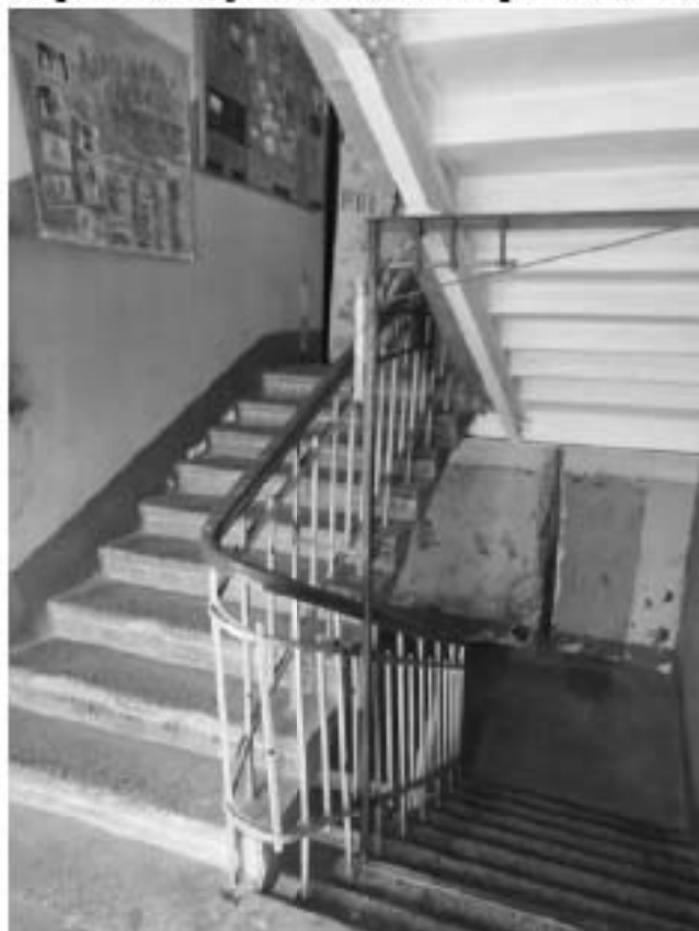
Фото 94. Общий вид на помещение 108 (лестничная клетка). 4-й этаж. Здание фабрики-кухни. Адрес: СПб, ул. Капитана Воронина, 13, лит. А.
