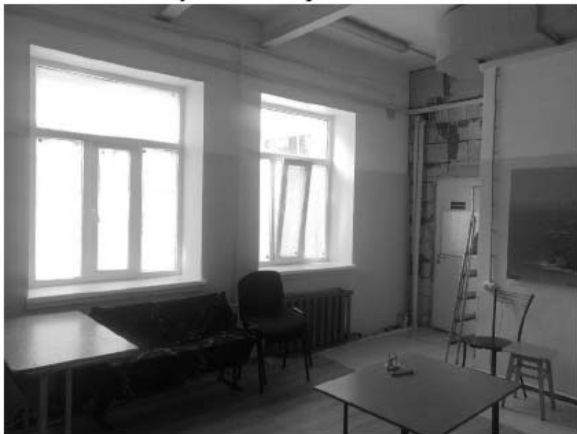
Фото 108. Общий вид на помещение 10. Здание прачечной. Адрес: СПб, ул. Капитана Воронина, 11, лит. А.
