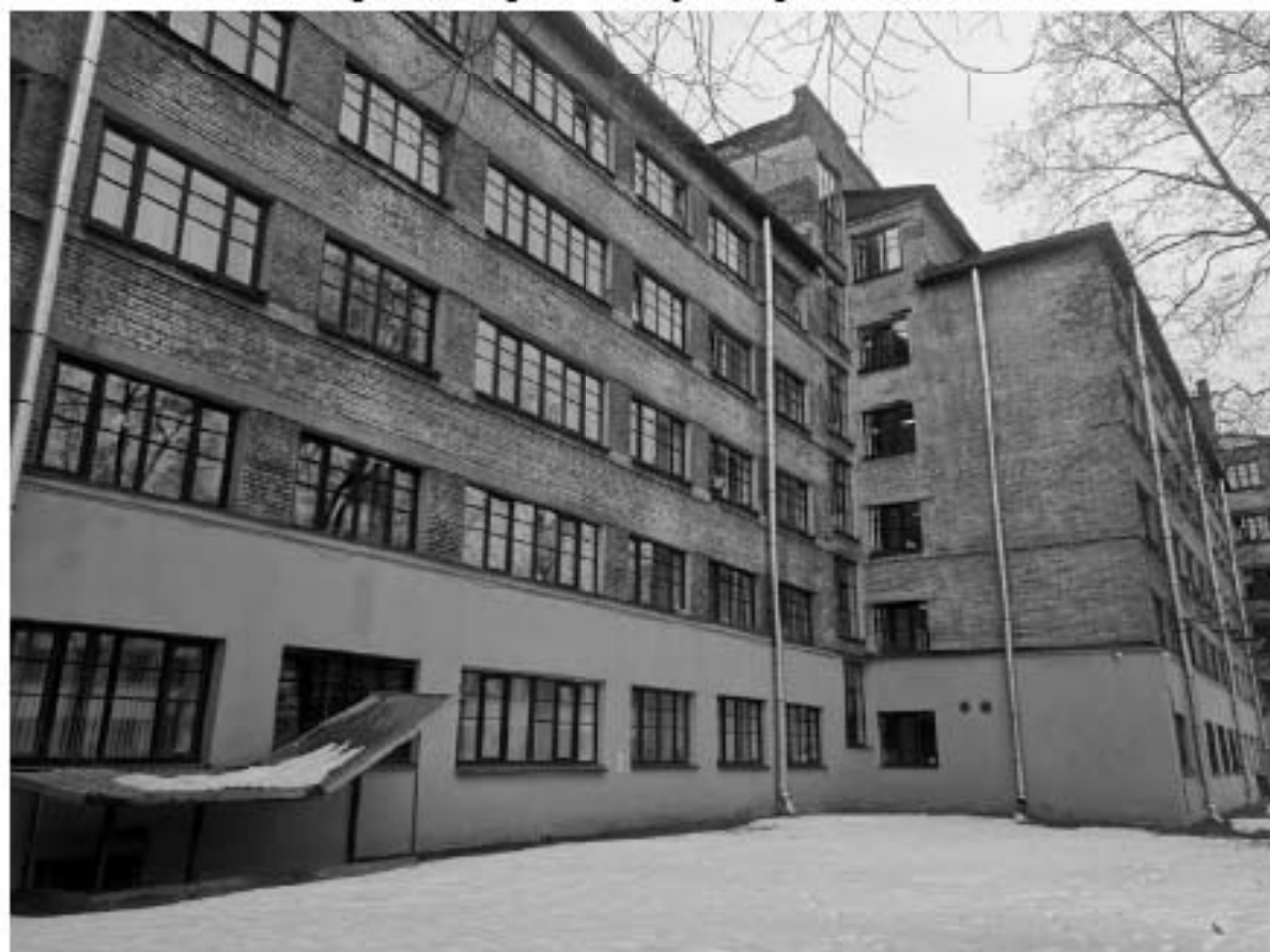
Фото 16. Общий вид на общежитие №6 с северо-востока. Центральный корпус. Адрес: СПб, ул. Харченко, д 16, лит. А
