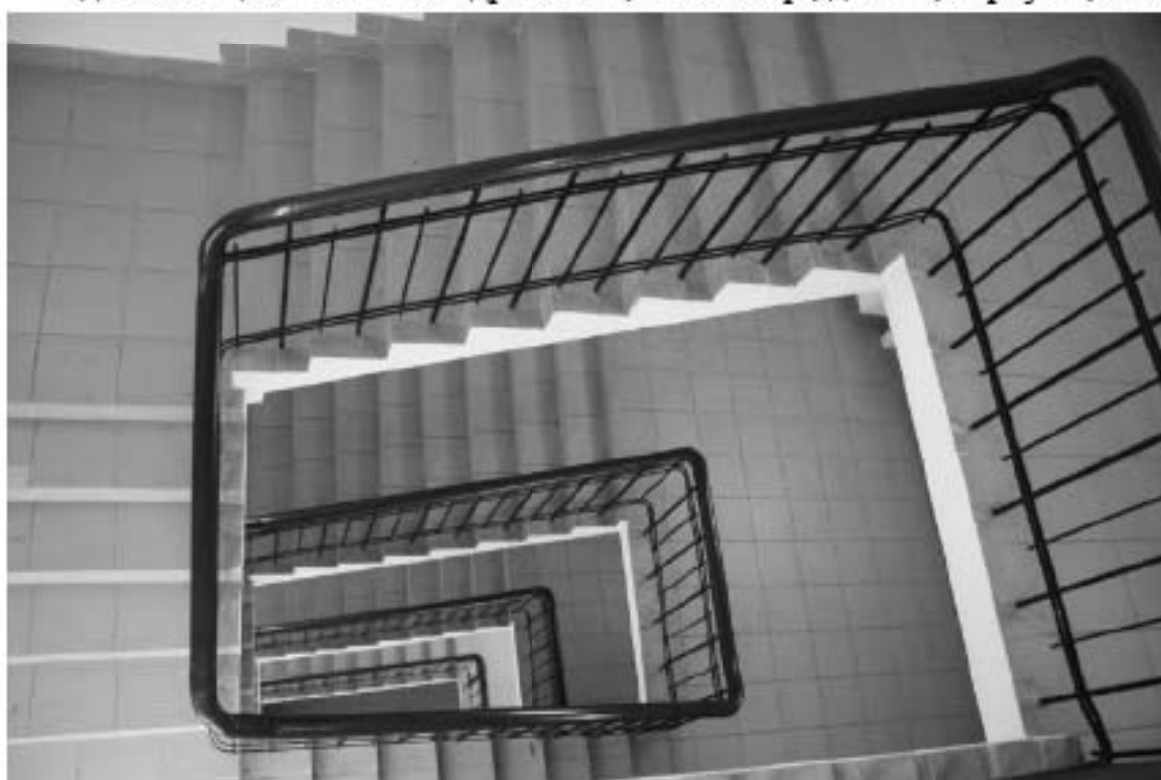
Фото 214. Общий вид на лестничную клетку общежития. Здание общежития № 1. Адрес: СПб, Лесной пр., дом 65, корпус 1, лит. А.
