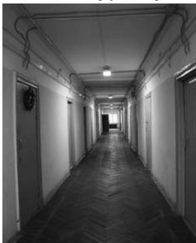
Фото 190. Общий вид типовой коридор общежития. 5-й этаж. Здание общежития №4а (северные корпуса). Адрес: СПб, Парголовская улица, дом 11, корпус 1, литера А.
