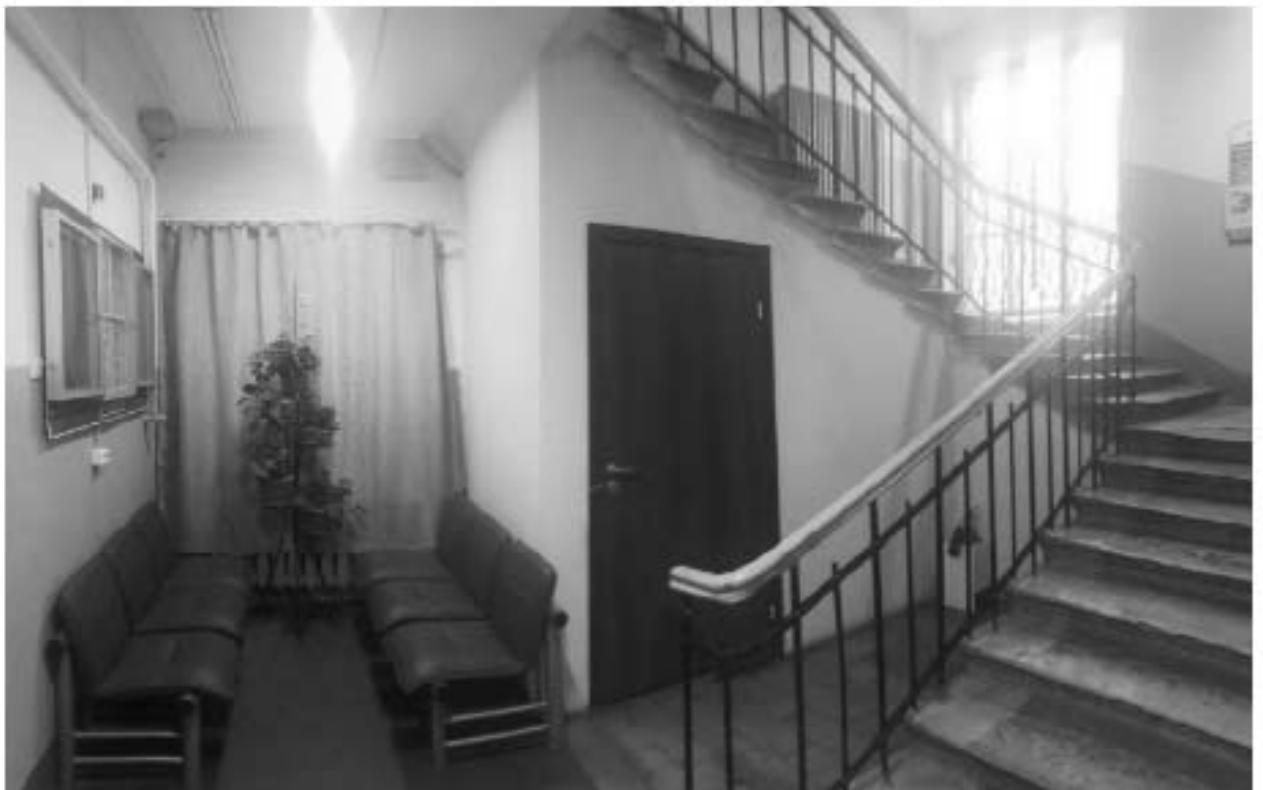
Фото 145. Общий вид на лестничную клетку. 1-й этаж. Здание общежития №5 (западный корпус). Адрес: СПб, Парголовская улица, дом 11, корпус 2, литера А.
