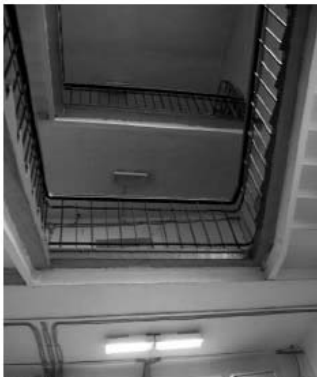
Фото 167. Общий вид типовую лестничную клетку. Здание общежития №4 (южные корпуса). Адрес: СПб, Парголово, улица, дом 11, корпус 1, литера А.
