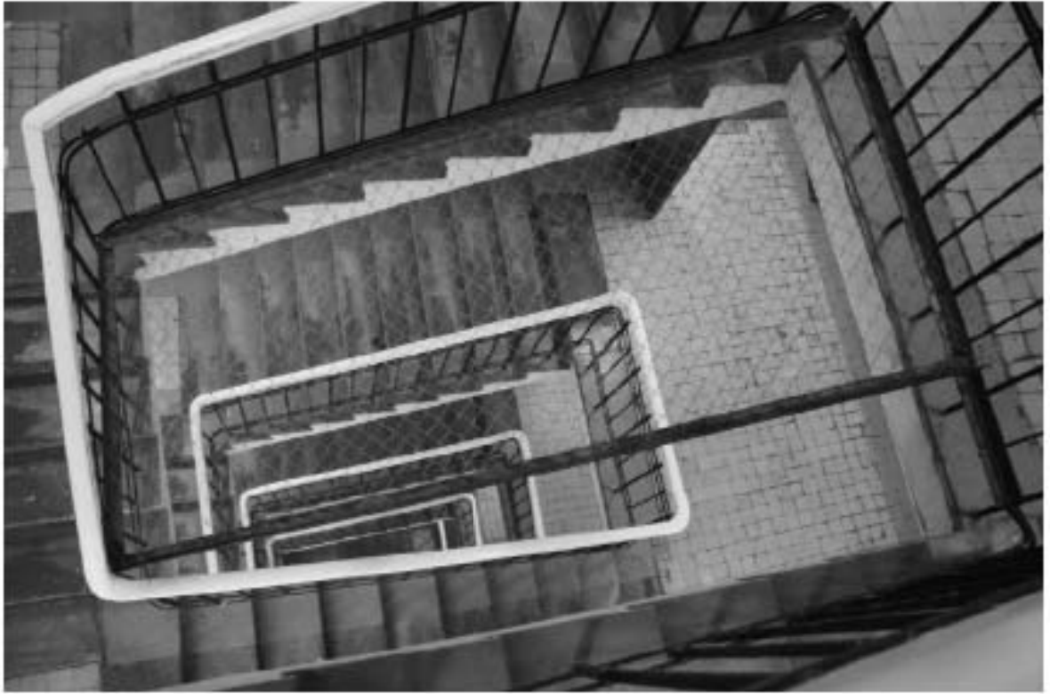
Фото 199. Общий вид на типовую лестничную клетку общежития. Здание общежития № 3. Адрес: СПб, Лесной пр., дом 65, корпус 3, лит. В.
