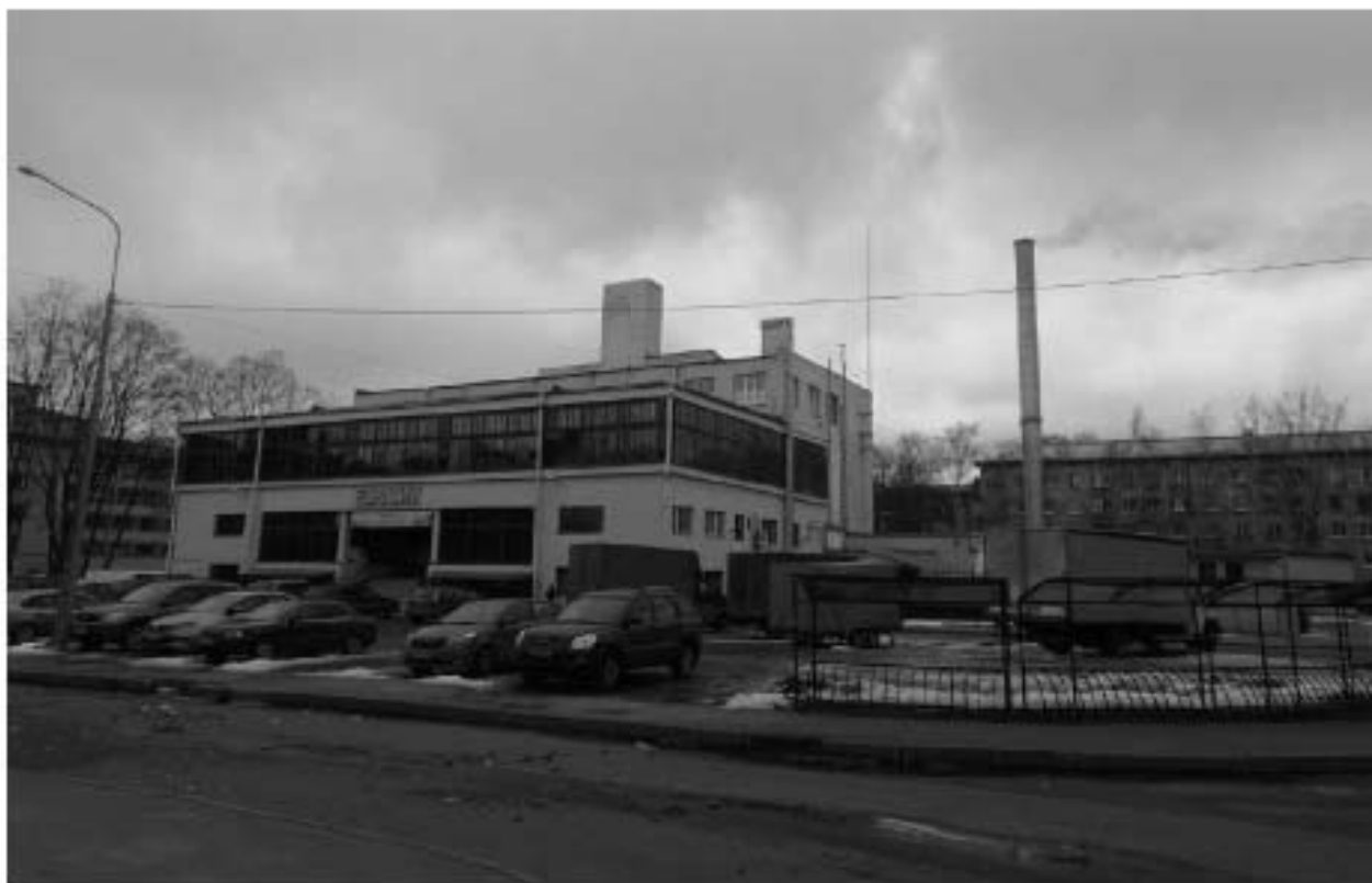
Фото 21. Общий вид на КВЦ «Евразия» с юго-востока. Адрес: СПб, ул. Капитана Воронина, д 13, лит. А
