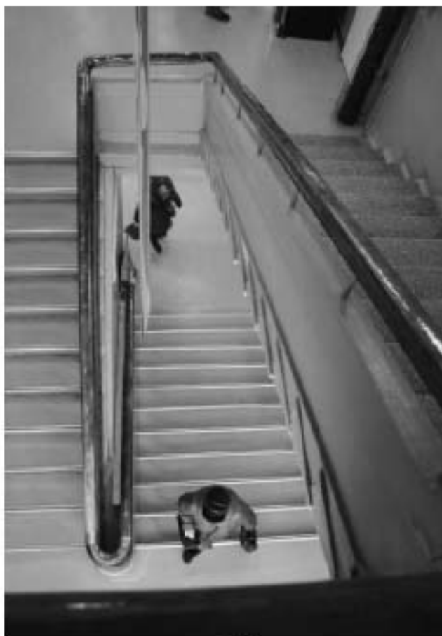
Фото 99. Общий вид на помещение 91 (лестничная клетка). 4-й этаж. Здание фабрики-кухни. Адрес: СПб, ул. Капитана Воронина, 13, лит. А.
