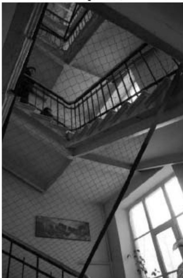
Фото 126. Общий вид на лестничную клетку. 3-й этаж. Адрес: СПб, ул. Харченко, 16.
