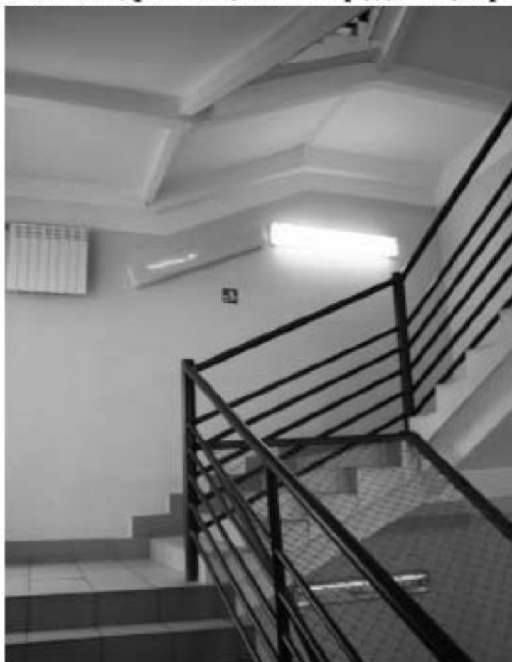
Фото 218. Общий вид на лестничную клетку общежития. 2-й этаж. Здание общежития № 1. Адрес: СПб, Лесной пр., дом 65, корпус 1, лит. А.
