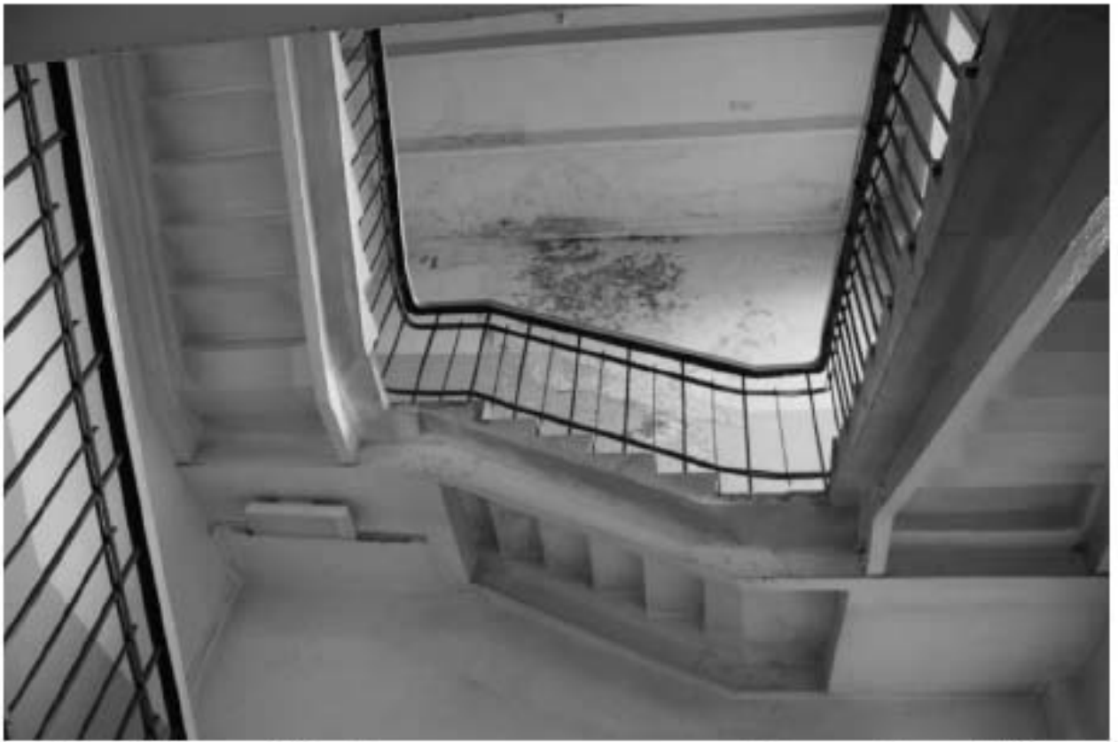
Фото 135. Общий вид на лестничную клетку. 5-й этаж. Адрес: СПб, ул. Харченко, 16.
