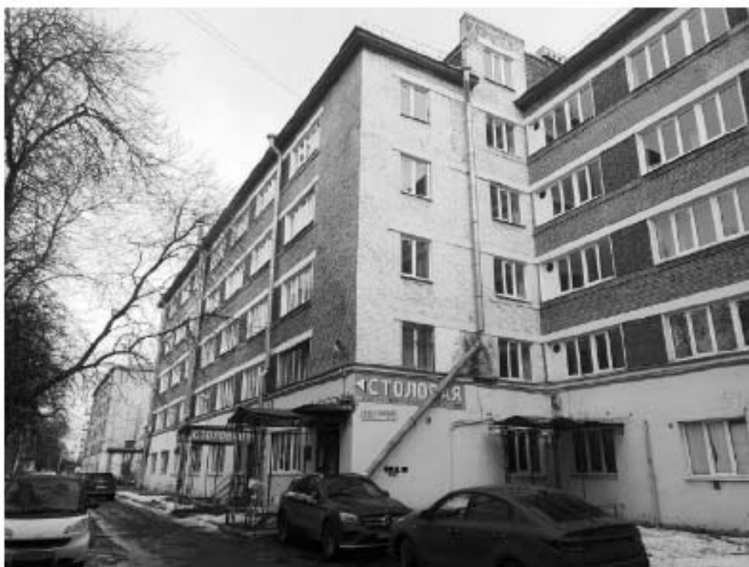
Фото 73. Общий вид на общежитие №1 (ИНЖЭКОН) с юга. Адрес: СПб, Лесной пр., 65, корп. 2, лит. Б
