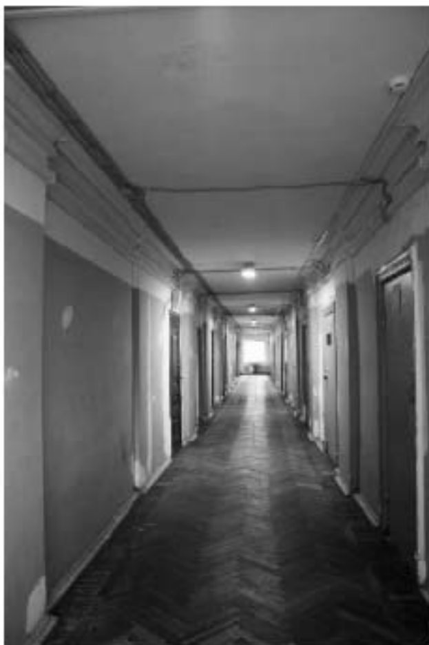
Фото 163. Общий вид на типовой коридор общежития. 3-й этаж. Здание общежития №4 (южные корпуса). Адрес: СПб, Парголово, улица, дом 11, корпус 1, литера А.
