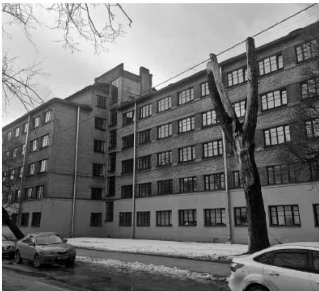
Фото 13. Общий вид на общежитие №6 с юга. Крайний и средний корпуса южного крыла. Адрес: СПб, ул. Харченко, д 16, лит. А
