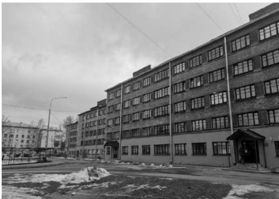
Фото 1. Общий вид на общежитие №6 с северо-запада. Дворовый фасад. Адрес: СПб, ул. Харченко, д 16, лит. А
