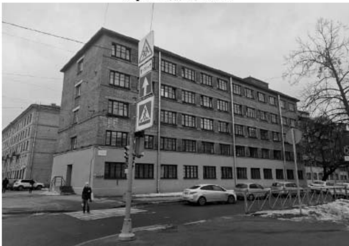
Фото 10. Общий вид на общежитие №6 с юго-востока. Крайний корпус южного крыла. Лицевой и торцевой фасады. Адрес: СПб, ул. Харченко, д 16, лит. А
