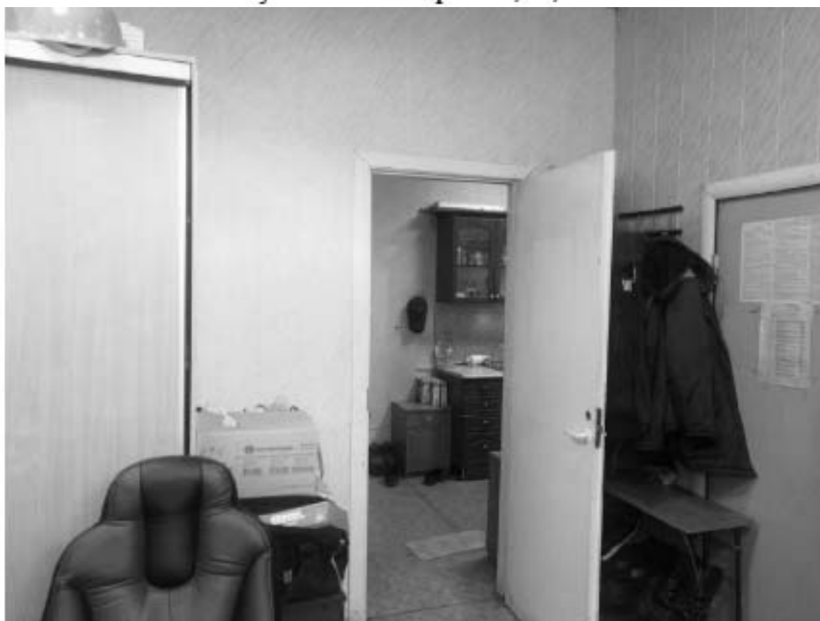
Фото 106. Общий вид на помещение 2. Здание прачечной. Адрес: СПб, ул. Капитана Воронина, 11, лит. А.
