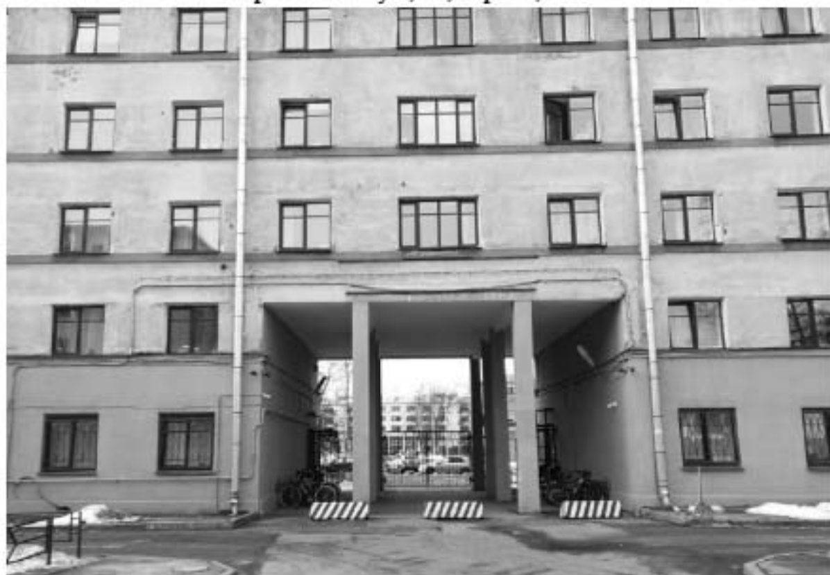
Фото 66. Вид на центральный трехпролетный проход. Адрес: СПб, Парголовская ул., 11, корп. 1, лит. А
