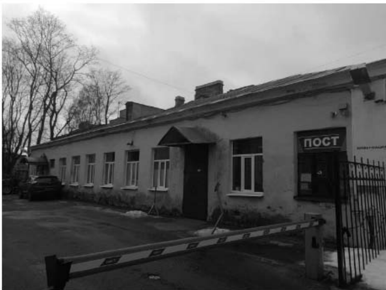
Фото 33. Вид на бывшую прачечную с северо-востока. Торцевой фасад. Адрес: СПб, ул. Капитана Воронина, д 11.
