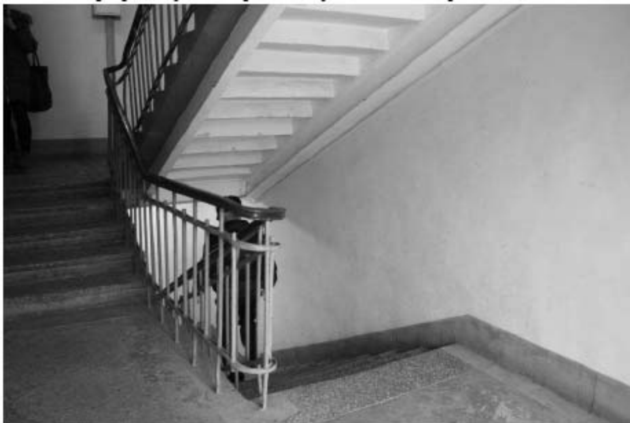
Фото 96. Общий вид на помещение 33 (лестничная клетка). 1-й этаж. Здание фабрики-кухни. Адрес: СПб, ул. Капитана Воронина, 13, лит. А.
