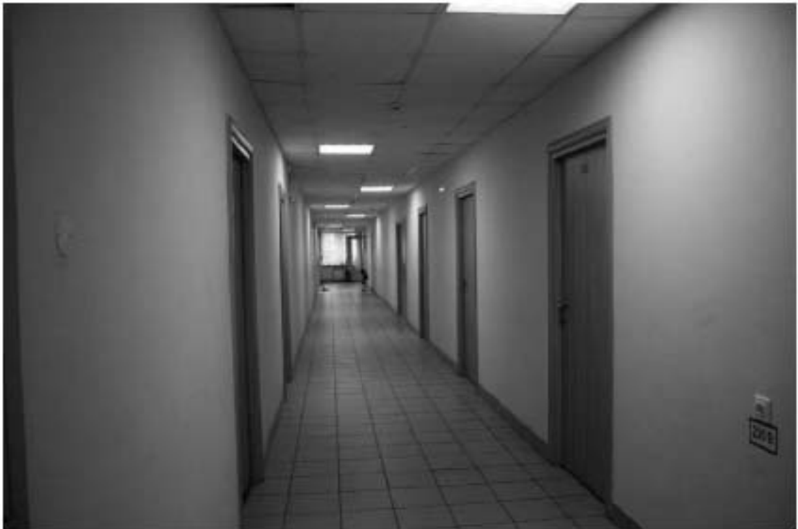
Фото 160. Общий вид на типовой коридор. Здание общежития №4 (южные корпуса). Адрес: СПб, Парголовская улица, дом 11, корпус 1, литера А.
