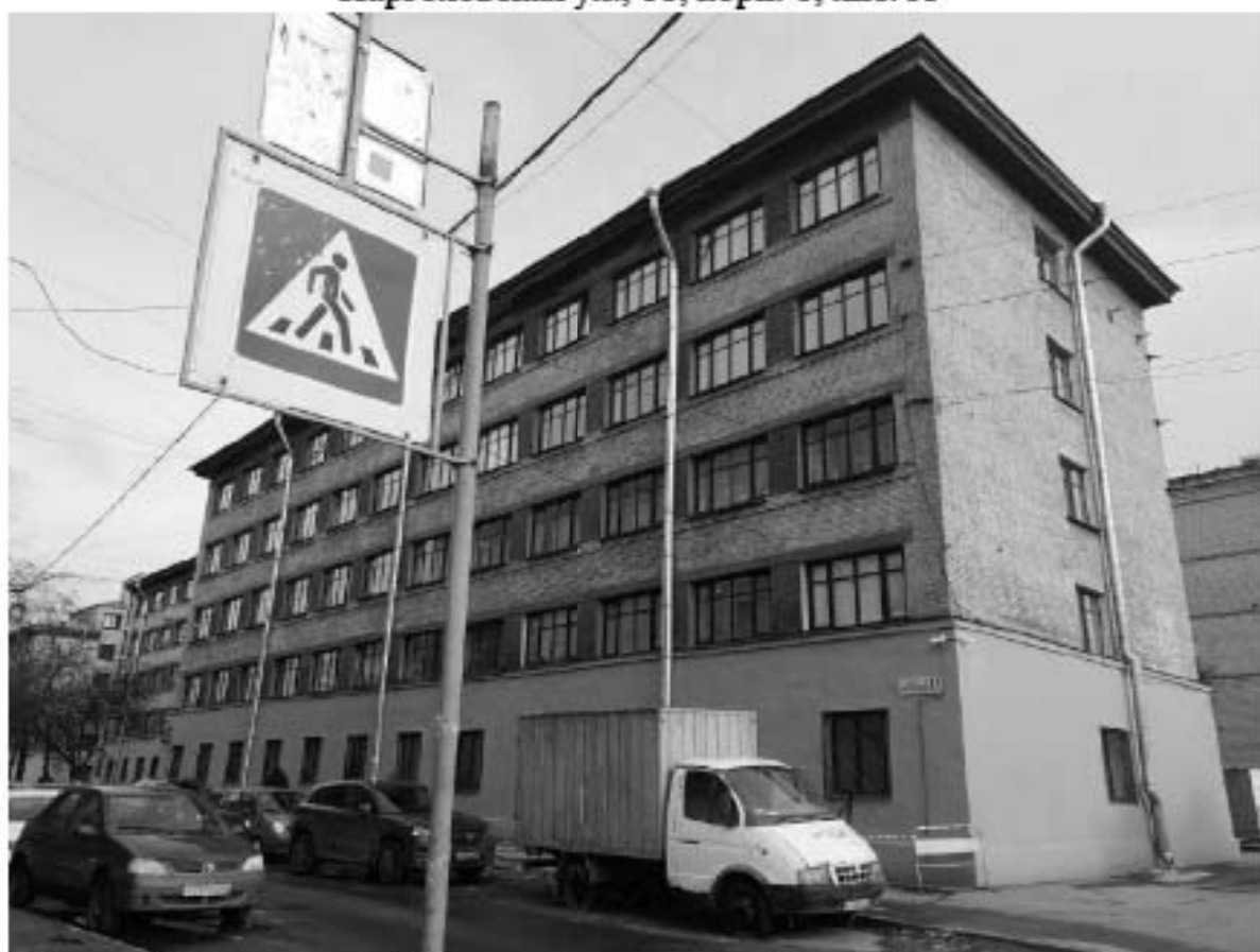
Фото 64. Вид на жилой корпус с юго-запада. Лицевой и торцевой фасады. Адрес: СПб, Парголовская ул., 11, корп. 1, лит. А
