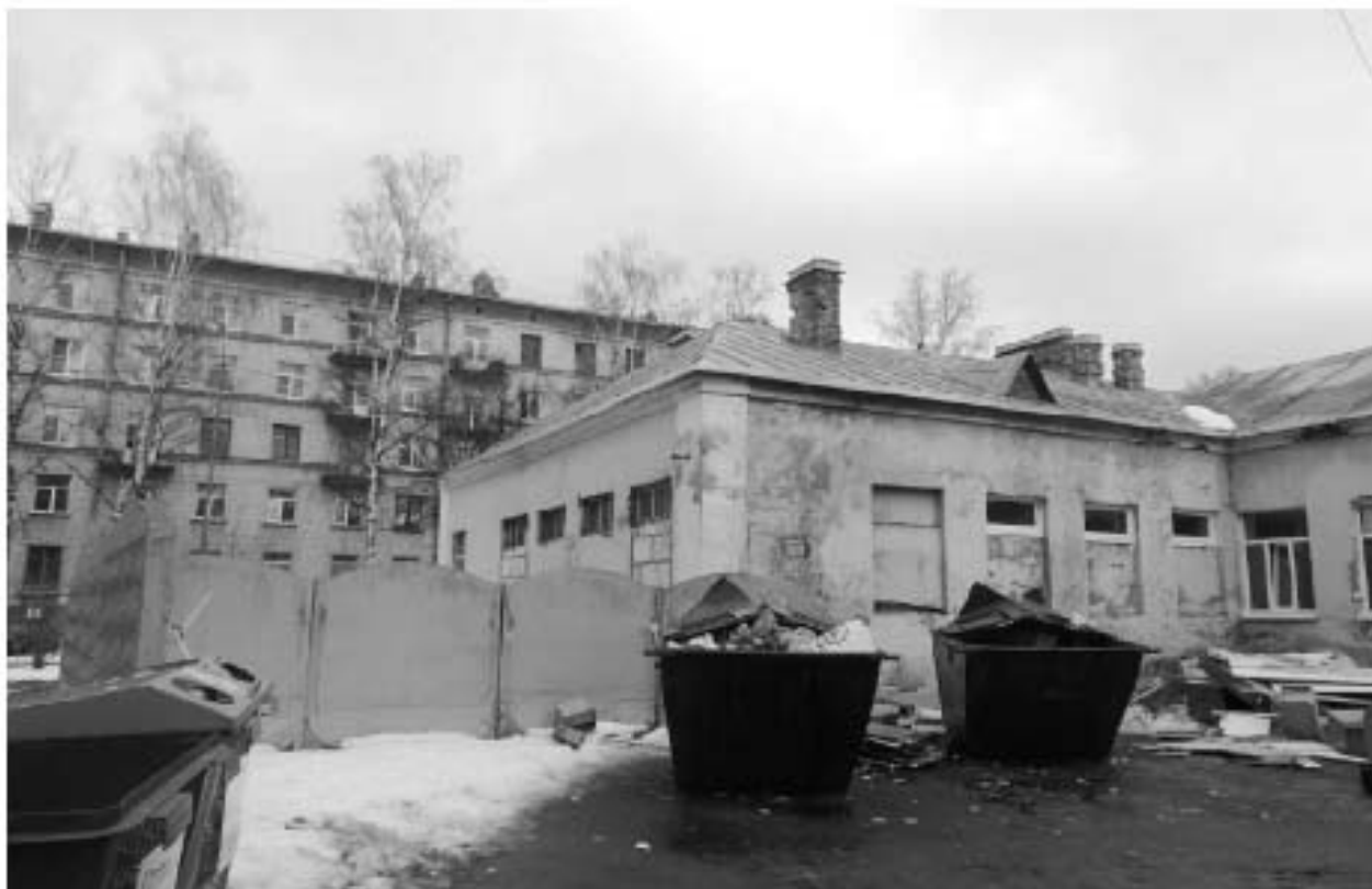
Фото 35. Вид на бывшую прачечную с юго-запада. Дворовый фасад. Адрес: СПб, ул. Капитана Воронина, д 11.
