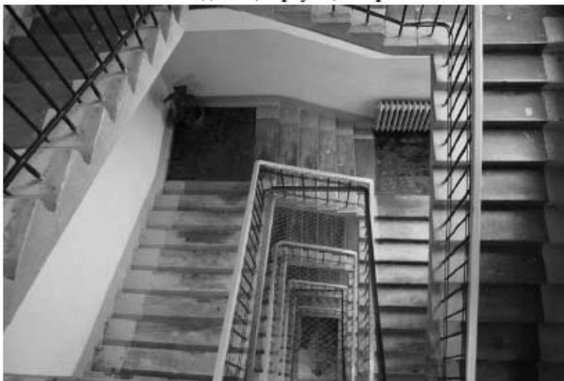
Фото 188. Общий вид типовую лестничную клетку. 5-й этаж. Здание общежития №4а (северные корпуса). Адрес: СПб, Парголовская улица, дом 11, корпус 1, литера А.
