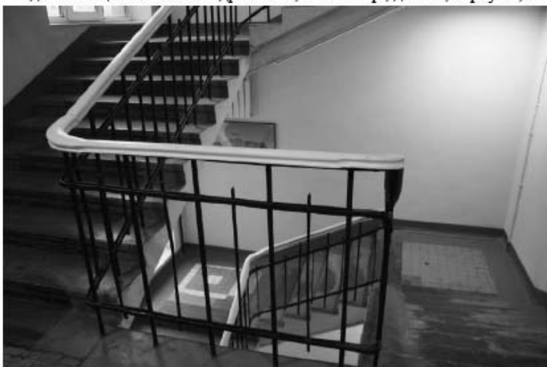
Фото 198. Общий вид на типовую лестничную клетку общежития. Здание общежития № 3. Адрес: СПб, Лесной пр., дом 65, корпус 3, лит. В.
