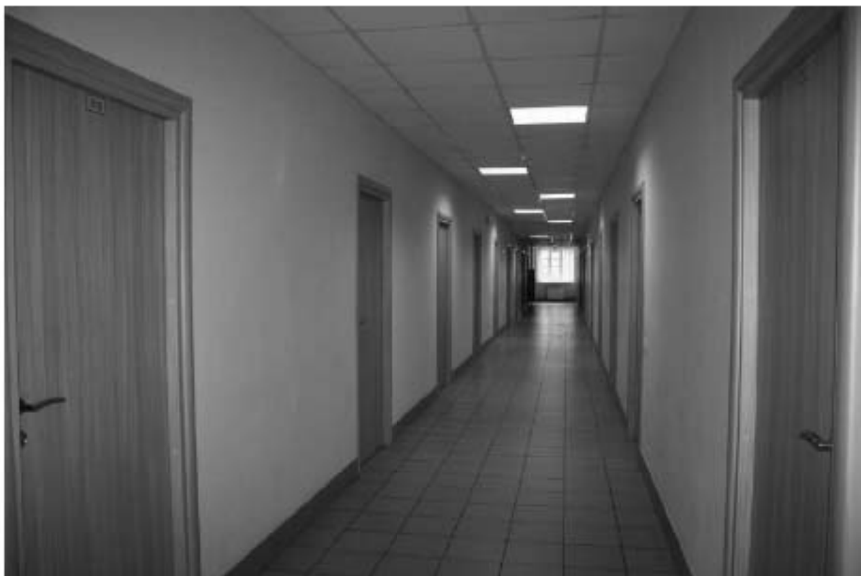
Фото 156. Общий вид на типовой коридор общежития. 4-й этаж. Здание общежития №56 (восточный корпус). Адрес: СПб, Парголовская улица, дом 11, корпус 2, литера А.
