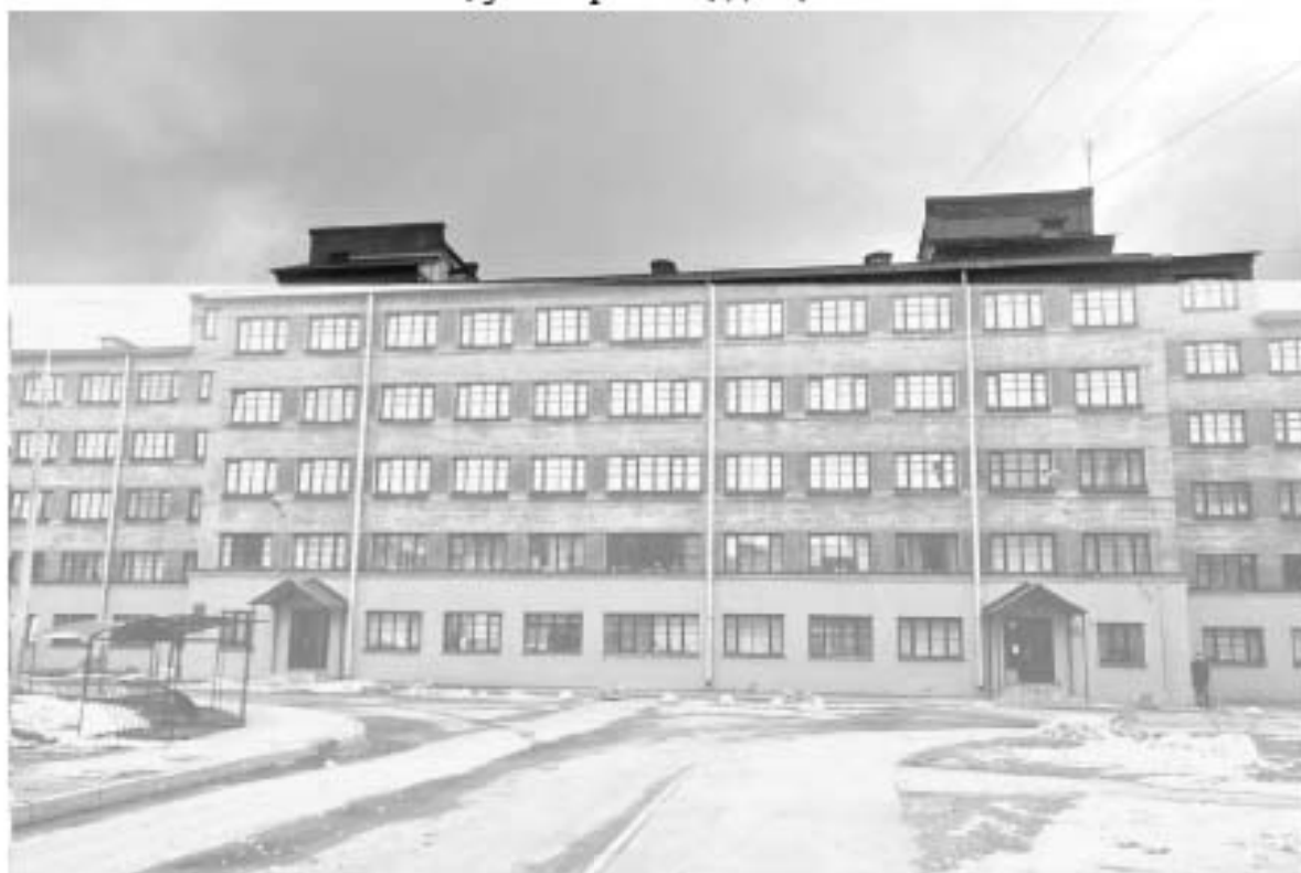
Фото 2. Общий вид на общежитие №6 с запада. Центральный корпус. Дворовый фасад. Адрес: СПб, ул. Харченко, д 16, лит. А
