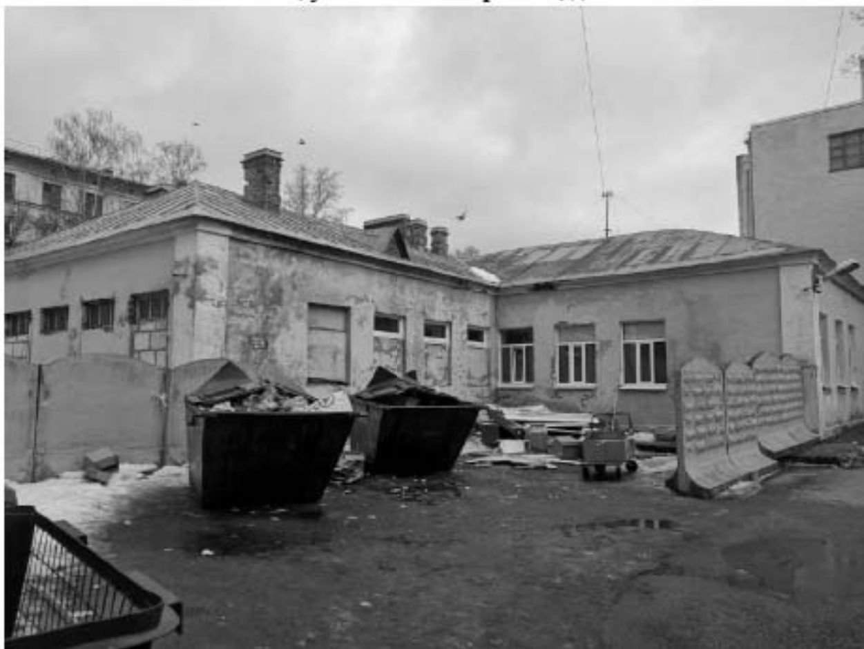
Фото 36. Вид на бывшую прачечную с юго-запада. Часть торцевого фасада. Адрес: СПб, ул. Капитана Воронина, д 11.
