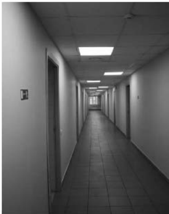
Фото 209. Общий вид на типовой коридор общежития. 2-й этаж. Здание общежития № 1. Адрес: СПб, Лесной пр., дом 65, корпус 1, литера А.
