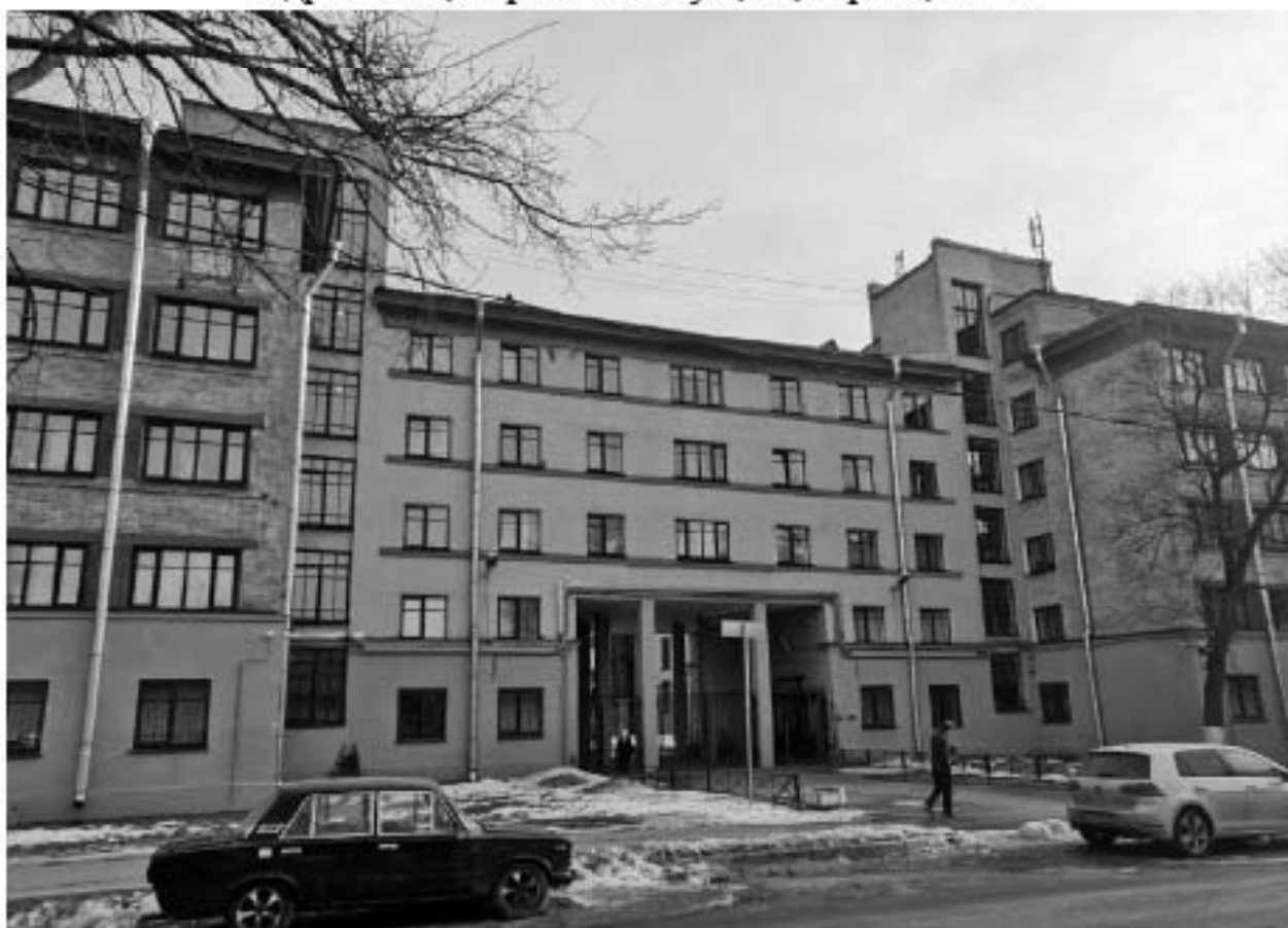
Фото 60. Вид на жилой корпус с запада. Лицевой фасад. Адрес: СПб, Парголовская ул., 11, корп. 1, лит. А
