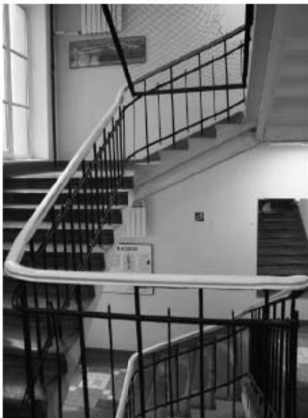
Фото 197. Общий вид на типовую лестничную клетку общежития. Здание общежития № 3. Адрес: СПб, Лесной пр., дом 65, корпус 3, лит. В.
