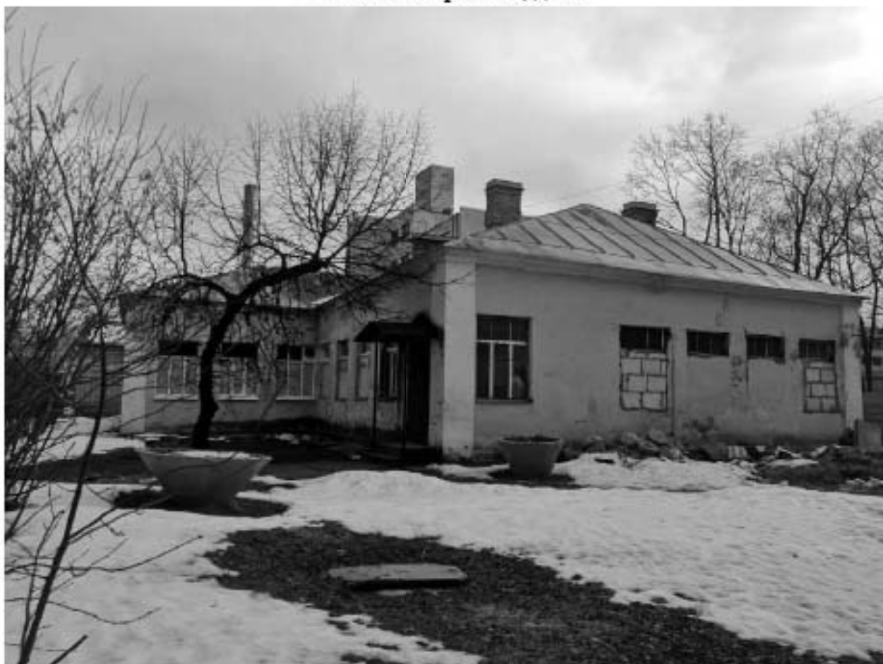
Фото 38. Вид на бывшую прачечную с северо-запада. Адрес: СПб, ул. Капитана Воронина, д 11.
