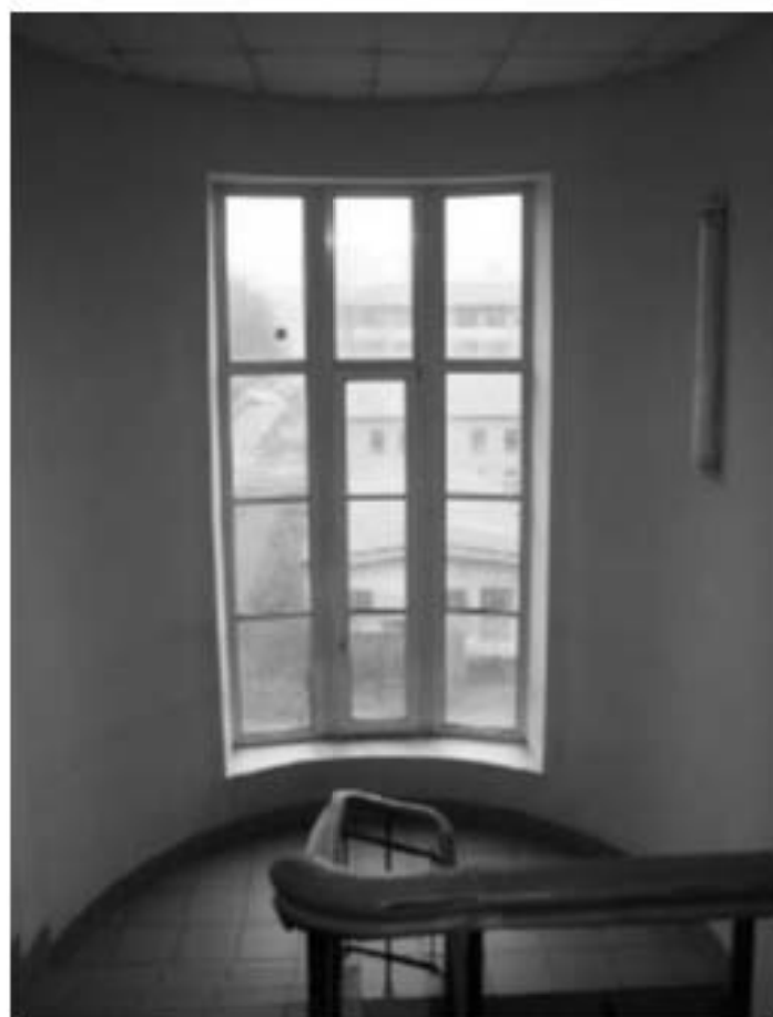
Фото 195. Общий вид на типовую лестничную клетку общежития. Здание общежития № 3. Адрес: СПб, Лесной пр., дом 65, корпус 3, лит. В.
