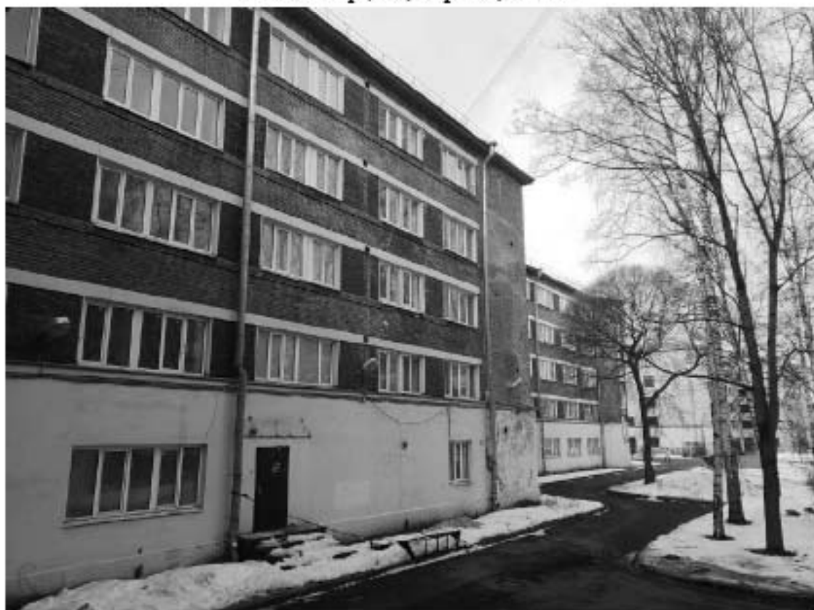
Фото 72. Общий вид на общежитие №1 (ИНЖЭКОН) с юго-востока. Адрес: СПб, Лесной пр., 65, корп. 2, лит. Б
