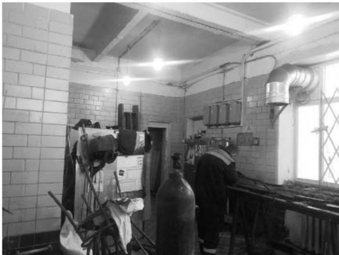
Фото 109. Общий вид на помещение 7. Здание прачечной. Адрес: СПб, ул. Капитана Воронина, 11, лит. А.
