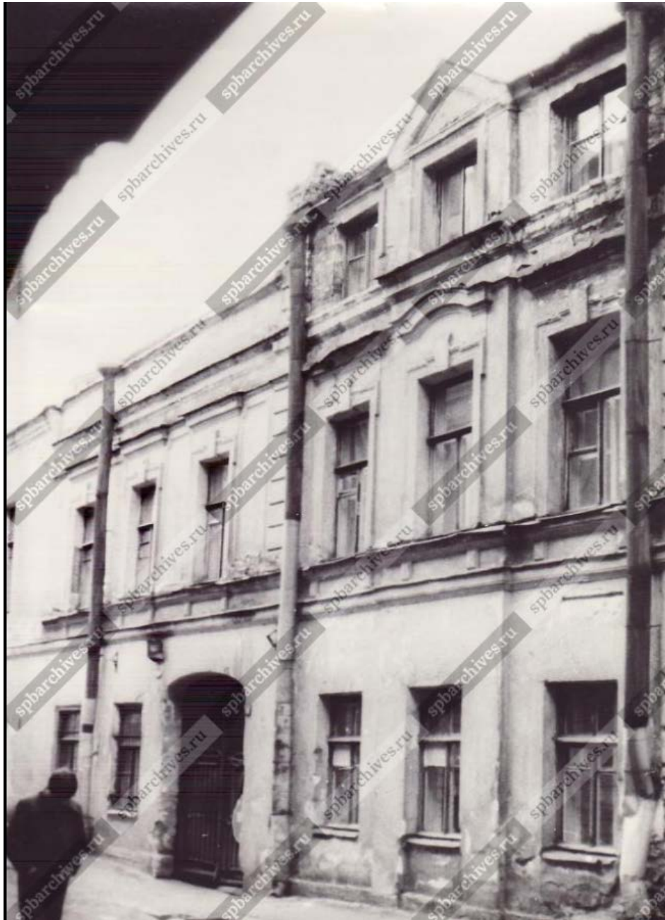
Илл. 28. ЦГАКФФД СПб. Фотодокумент Ар 215644 Вид фасада дома № 4 в Прачечном переулке (бывшее здание типографии "Ф.А.Брокгауз и И.А.Эфро", архитектор П.А.Максимов, 1890-е годы). Дата съёмки: 14 июня 1984 г Автор съёмки: Овчинников Кирилл Владимирович.
