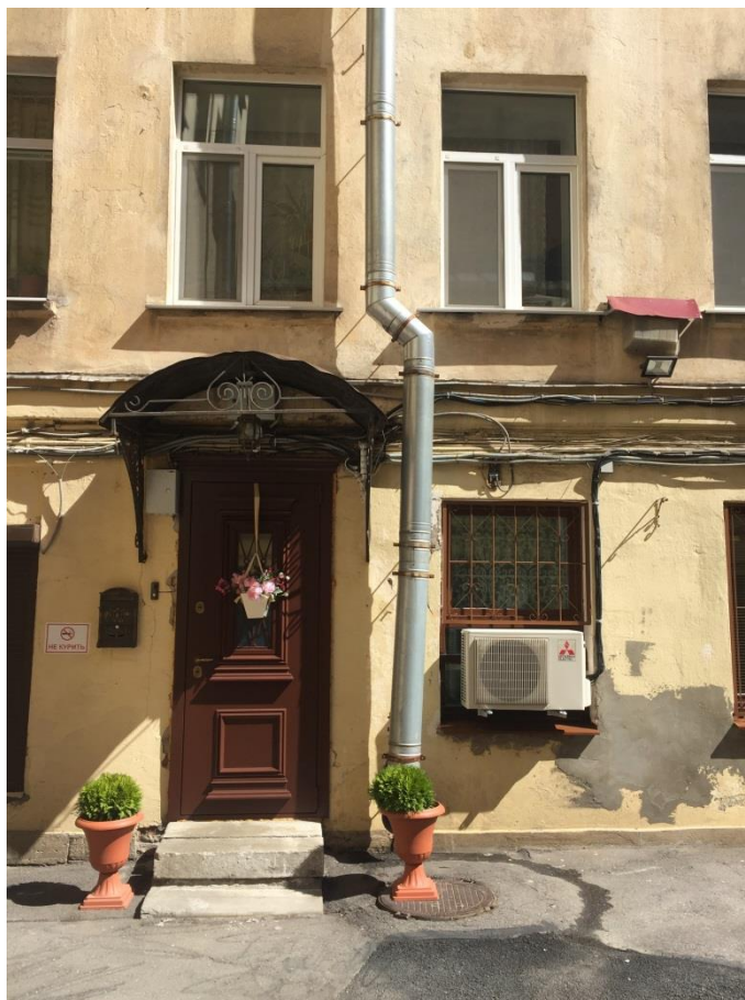
Фото 7. Фрагмент юго-западного дворового фасада. Вход в квартиру № 23 (согласно технической документации) Вид с юго-запада.
