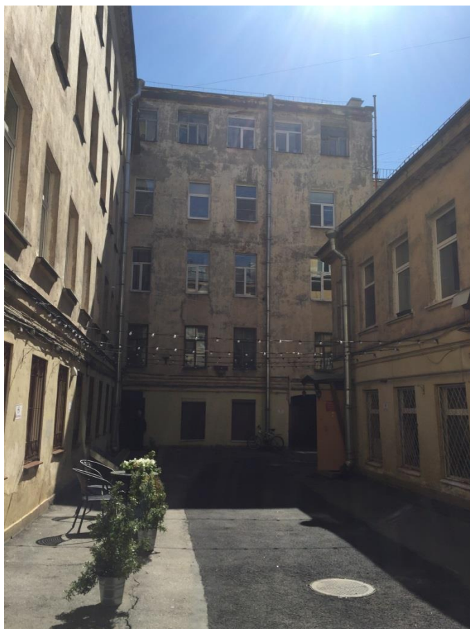
Фото 6. Северо-западный дворовой фасад лит. А 1 . Вид с северо-запада.
