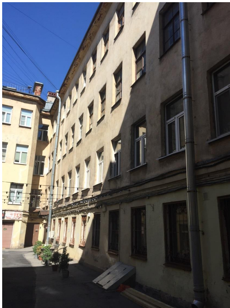
Фото 3. Юго-западный фасад дворового флигеля под лит. А 2 . Вид с юга.
