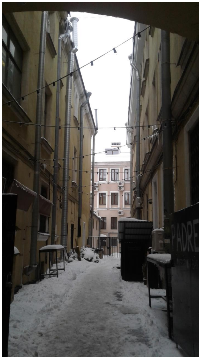
14. Объект культурного наследия регионального значения «Особняк Т.Э. Сильванской (В.А. Слепцова)» по адресу: г. Санкт-Петербург, Большая Конюшенная улица, дом 9, литера А. Второй двор. Дворовые флигели. Вид со стороны первого двора.
