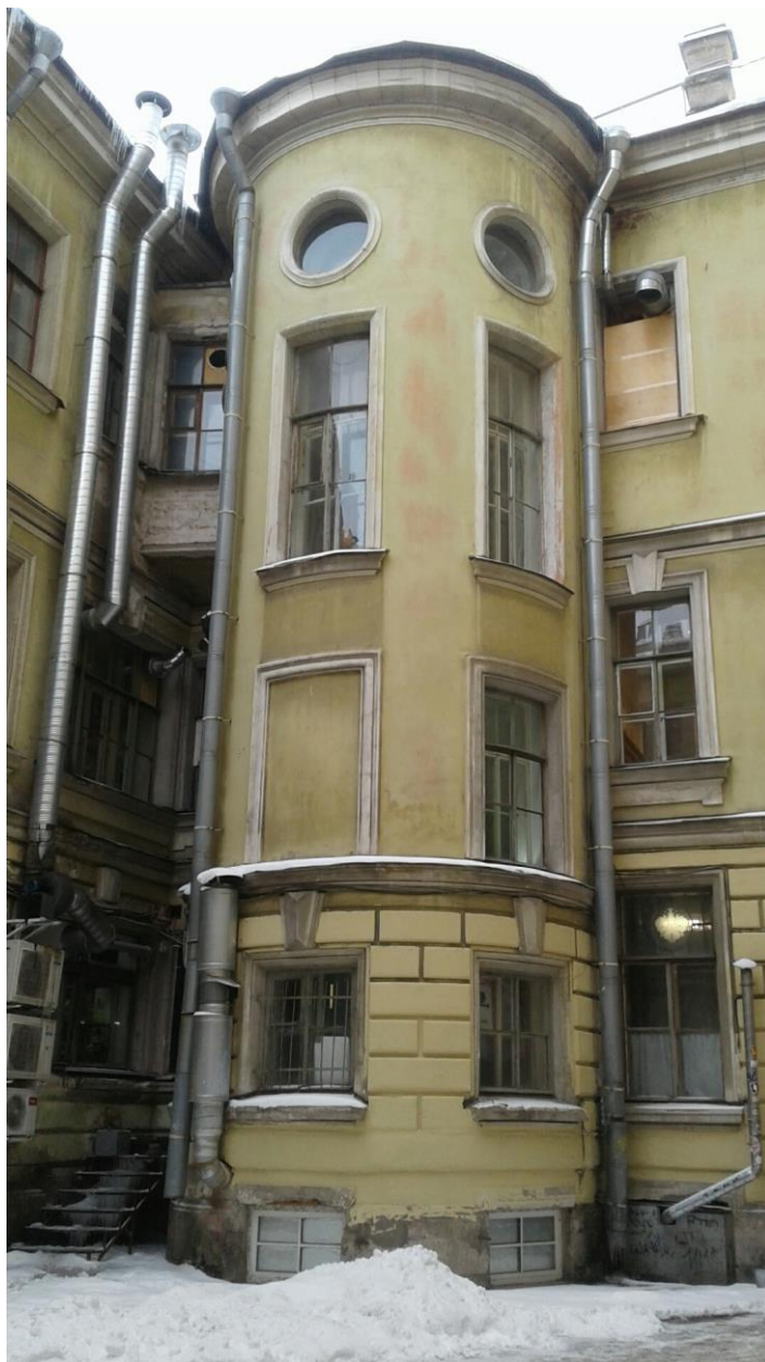
11. Объект культурного наследия регионального значения «Особняк Т.Э. Сильванской (В.А. Слепцова)» по адресу: г. Санкт-Петербург, Большая Конюшенная улица, дом 9, литера А. Дворовый фасад главного дома. Полуциркульный в плане лестничный ризалит дворового фасада главного дома.
