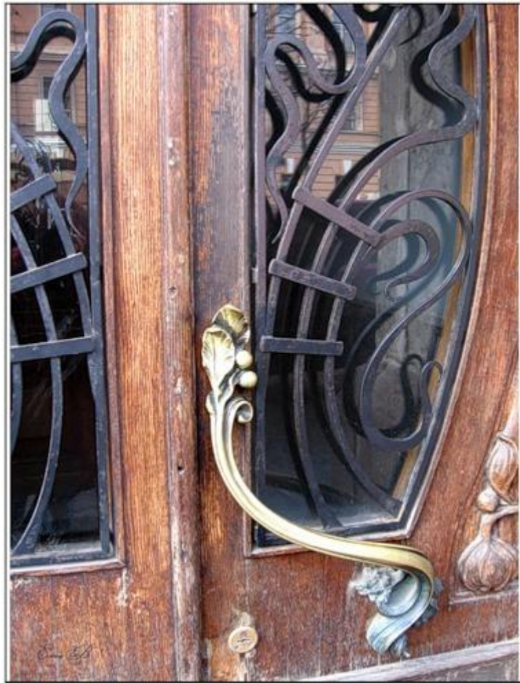
17. Особняк Т.Э. Сильванской (В.А. Слепцова) по адресу: ул. Большая Конюшенная, д. 9. Главный (лицевой) фасад. Фрагмент. Деревянное дверное заполнение. Фрагмент. Фотография. 2011 г. http://www.citywalls.ru .
