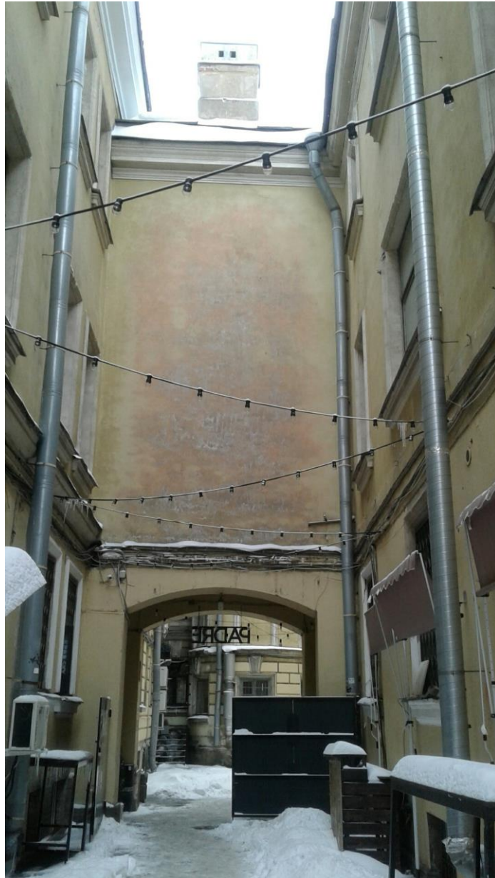
15. Объект культурного наследия регионального значения «Особняк Т.Э. Сильванской (В.А. Слепцова)» по адресу: г. Санкт-Петербург, Большая Конюшенная улица, дом 9, литера А. Второй двор. Дворовые фасады. Вид в сторону первого двора.
