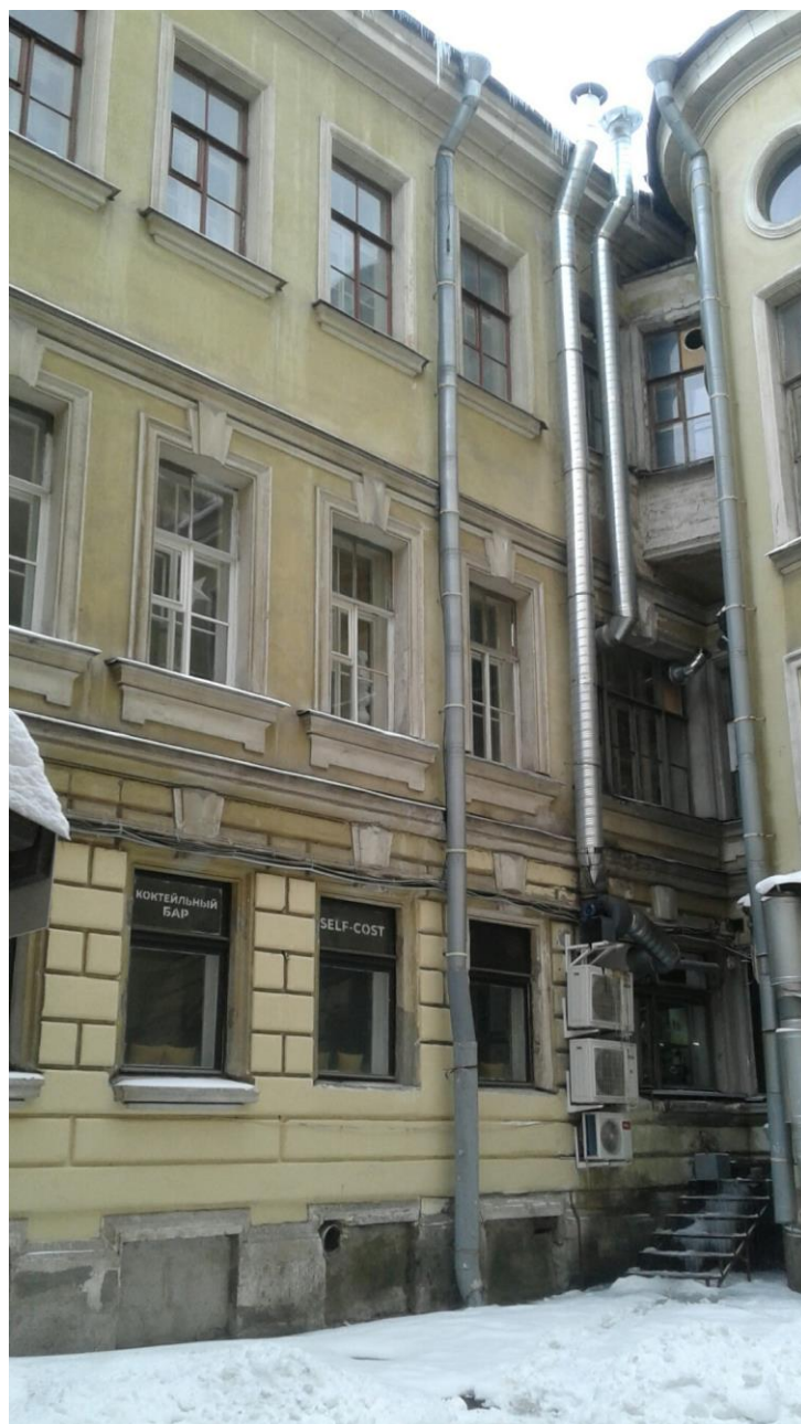
12. Объект культурного наследия регионального значения «Особняк Т.Э. Сильванской (В.А. Слепцова)» по адресу: г. Санкт-Петербург, Большая Конюшенная улица, дом 9, литера А. Дворовый фасад. Фрагмент.
