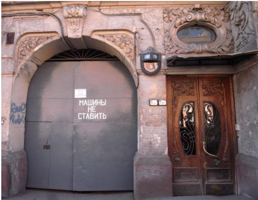
15. Особняк Т.Э. Сильванской (В.А. Слепцова) по адресу: ул. Большая Конюшенная, д. 9. Главный (лицевой) фасад. Фрагмент. Заполнение (позднее, металлическое) воротного проезда. Деревянное дверное заполнение. Фотография. 2011 г. http://www.citywalls.ru .
