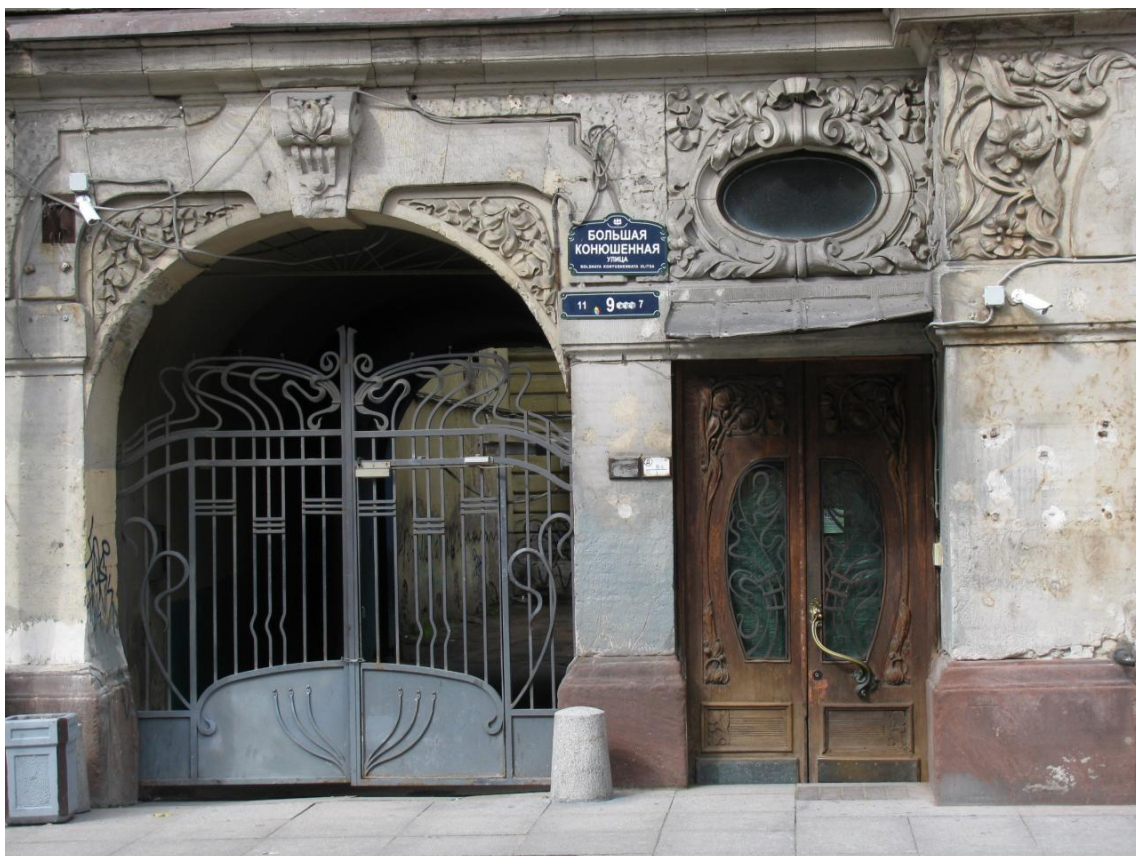
21. Особняк Т.Э. Сильванской (В.А. Слепцова) по адресу: ул. Большая Конюшенная, д. 9. Главный (лицевой) фасад. Фрагмент. Заполнение воротного проезда. Деревянное дверное заполнение. Фотография. 2011 г. http://www.citywalls.ru .
