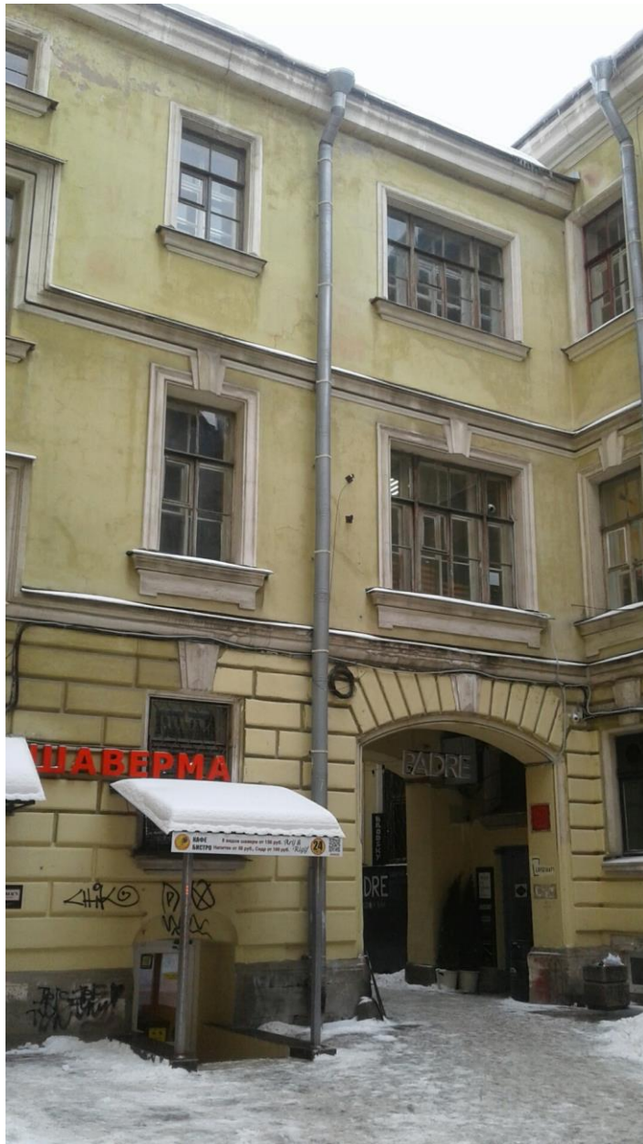
13. Объект культурного наследия регионального значения «Особняк Т.Э. Сильванской (В.А. Слепцова)» по адресу: г. Санкт-Петербург, Большая Конюшенная улица, дом 9, литера А. Дворовый флигель. Воротный проезд дворового флигеля.
