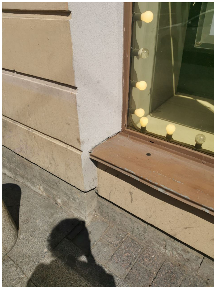
Фото№6: Фрагмент существующего оконного заполнения
