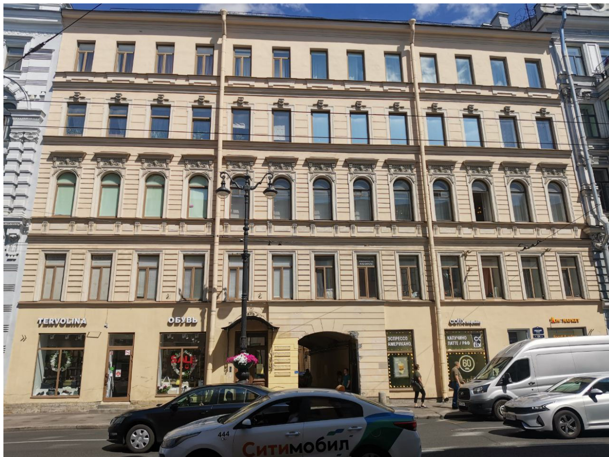
Фото№1: Общий вид рассматриваемого объекта здания со стороны Невского проспекта
