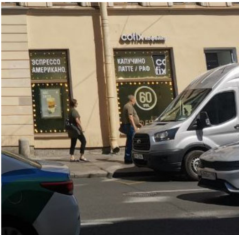
Фото№3: Фрагмент лицевого фасада здания в габаритах рассматриваемого помещения 18-Н
