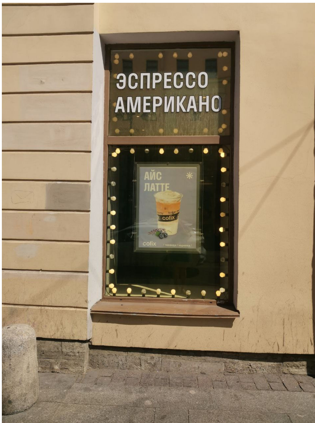
Фото№15: Фрагмент лицевого фасада. Существующее оконное заполнение
