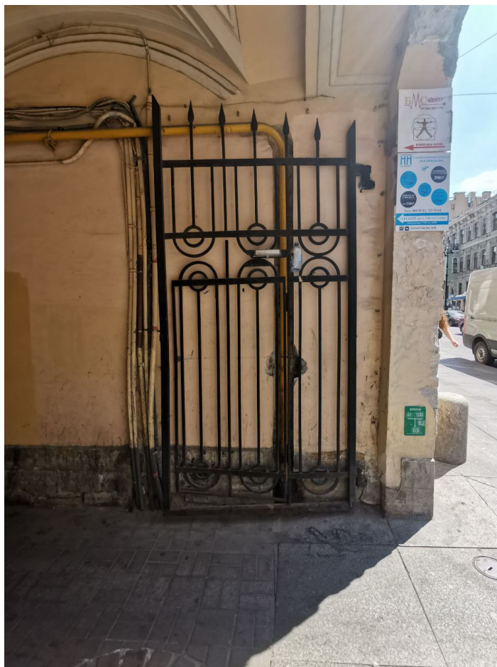
Фото№13: Арочный проезд. Поздняя решетка заполнения проезда (правая сторона)
