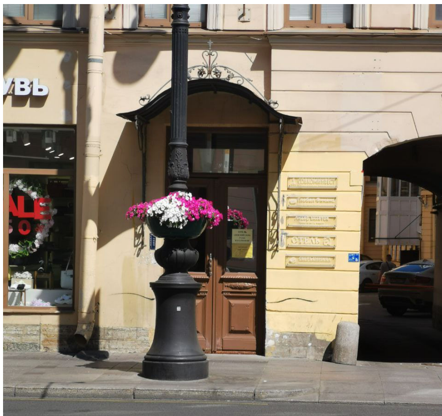
Фото№12: Общий вид дверного заполнения парадного входа здания
