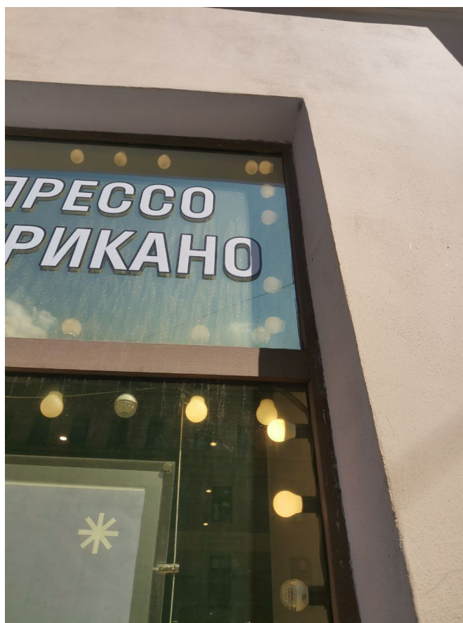
Фото№8: Фрагмент существующего оконного заполнения
