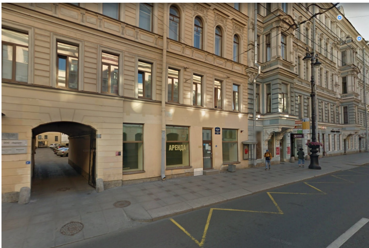
Илл. 11. Вид на лицевой фасад со стороны Невского проспекта. Электронный доступ: http://maps.google.com . Дата: 2019 год.
