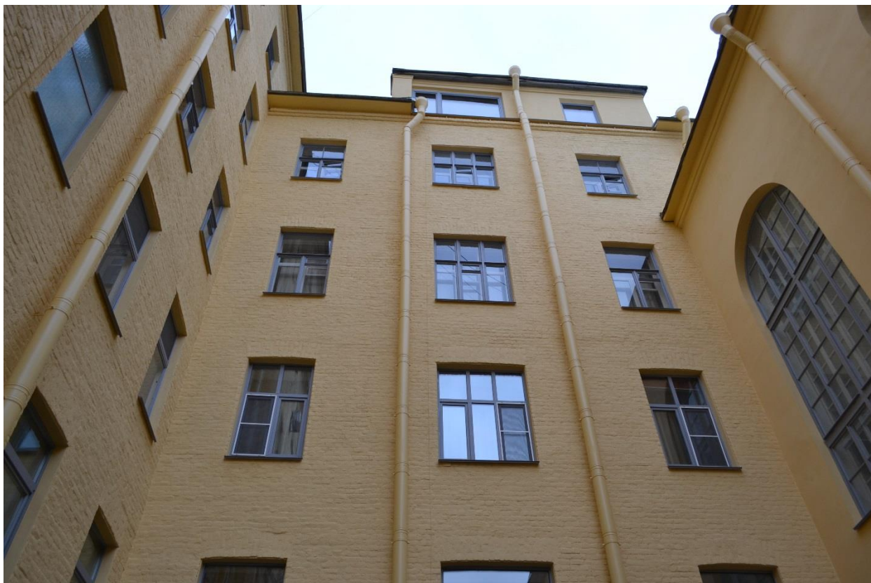
Фото 1. Северо-восточный фасад. Вид с северо-востока.
