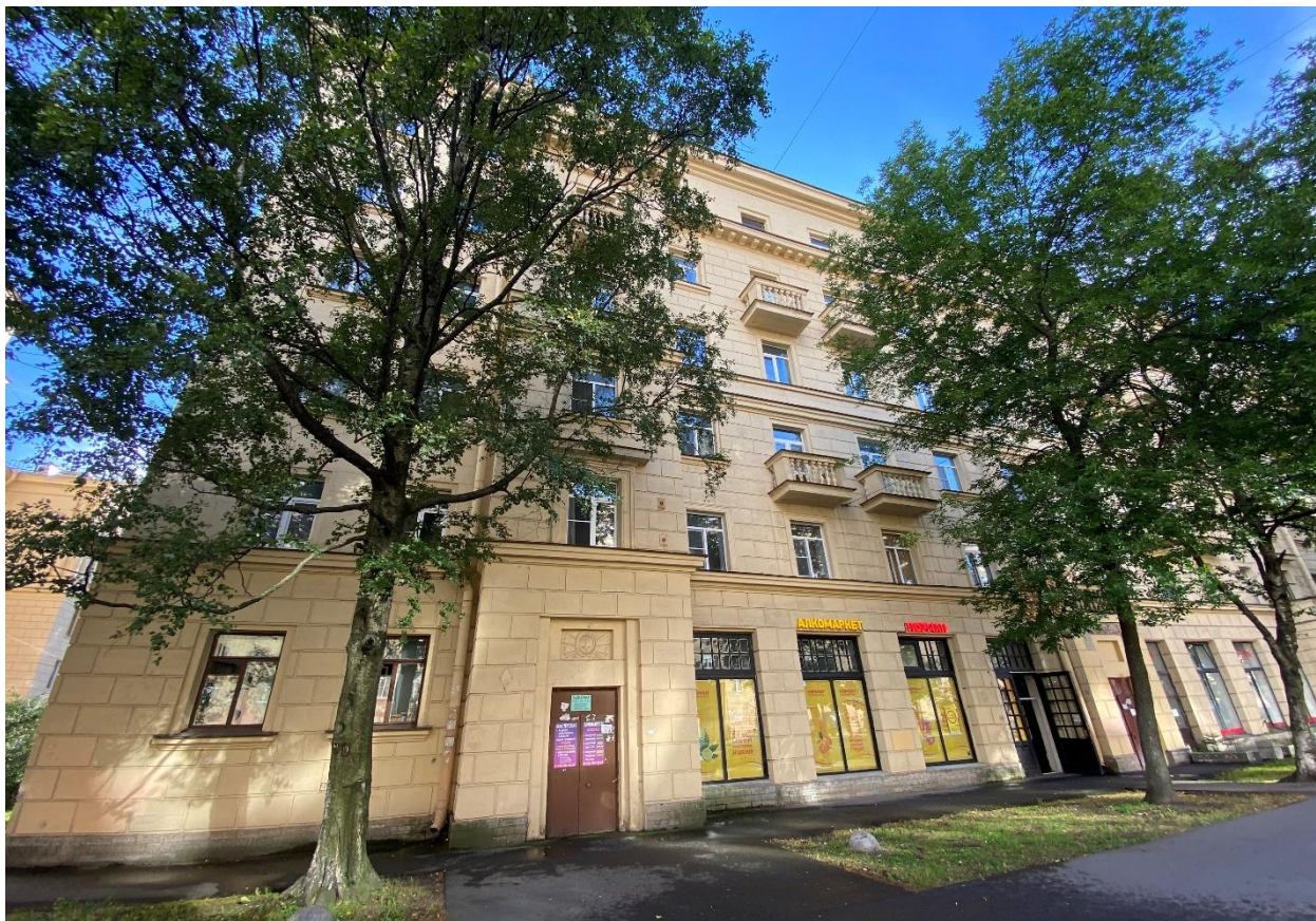
Фото 3. Восточная часть лицевого фасада. Вид с востока
