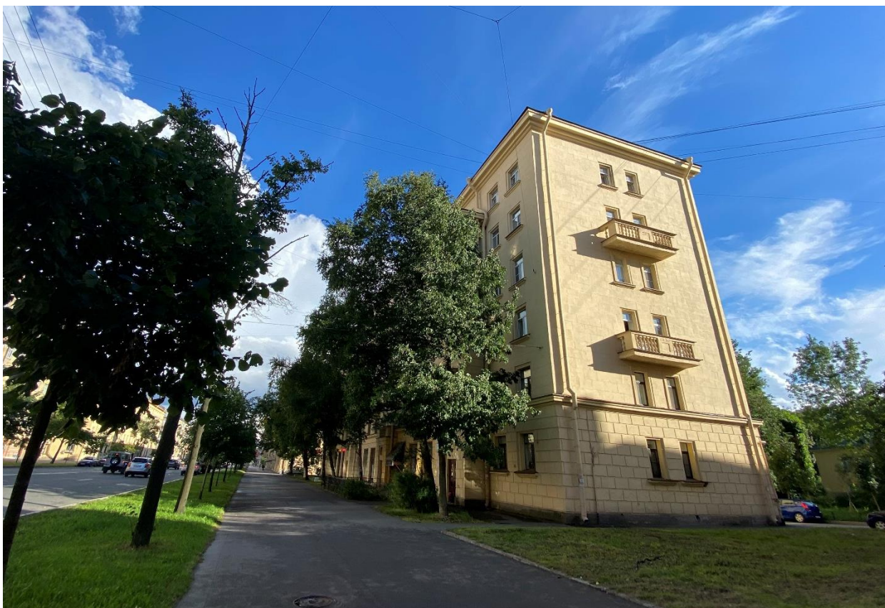
Фото 1. Общий вид с северо-запада
