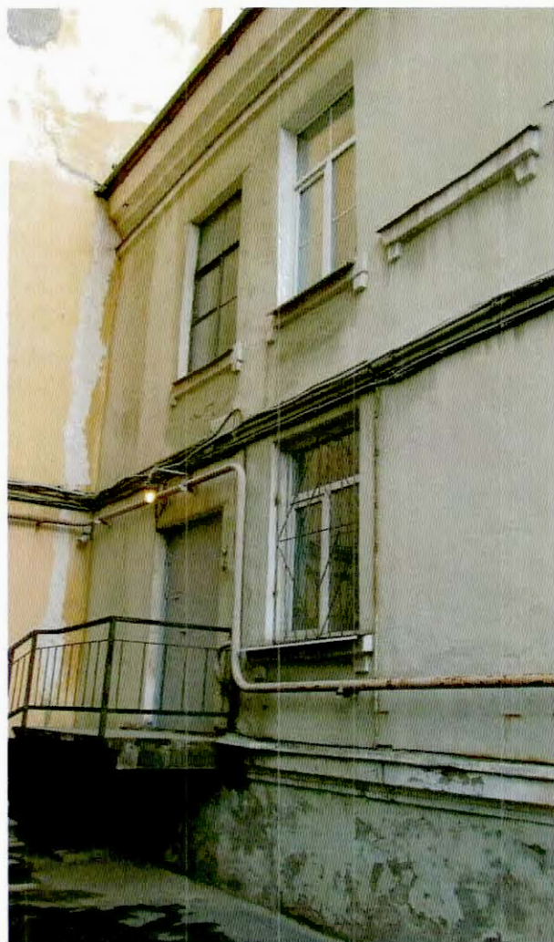
21. Фрагмент западного фасада объекта культурного наследия.
