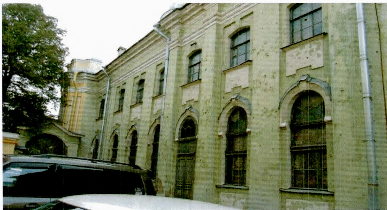
7. Фрагмент восточного фасада объекта культурного наследия.
