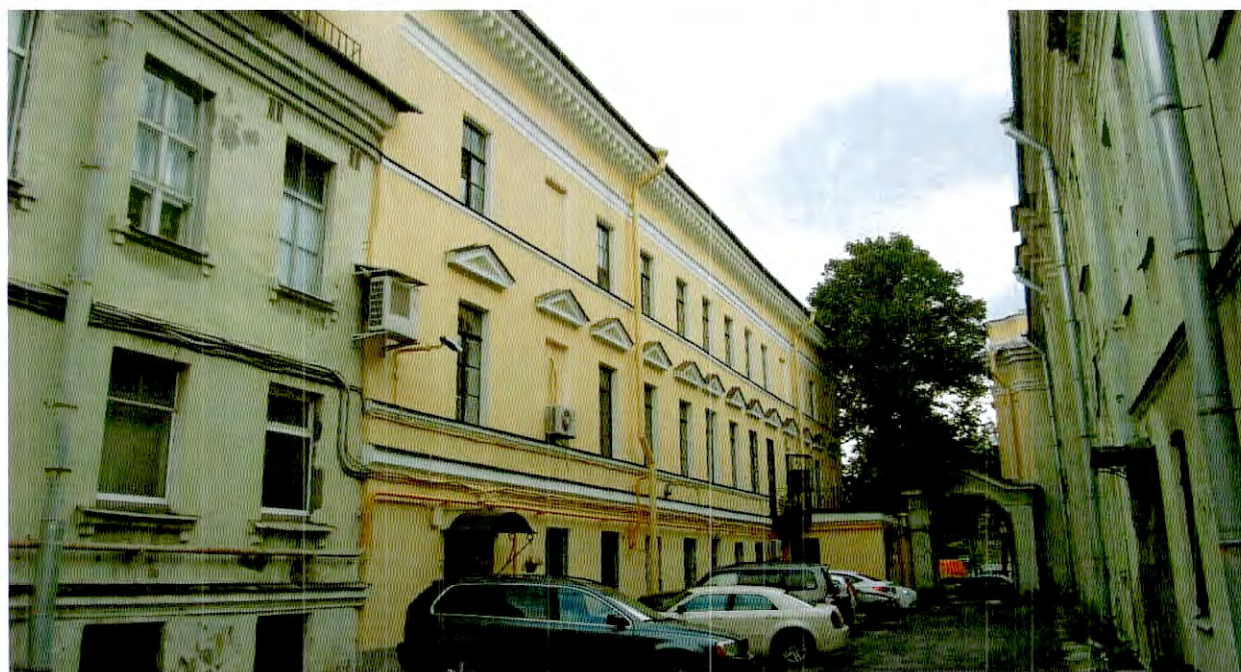
16. Западный фасад объекта культурного наследия.
