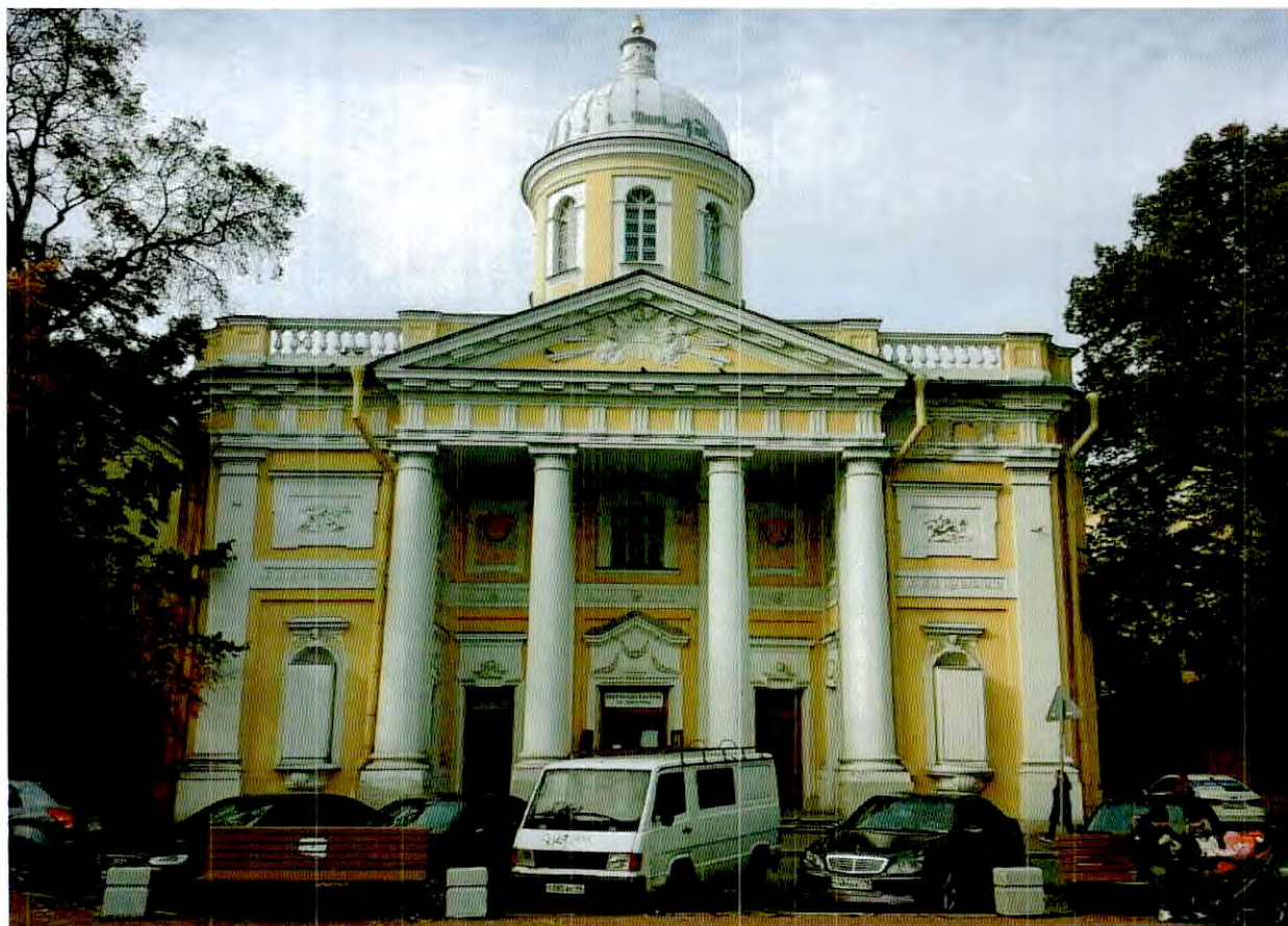
1. Южный фасад объекта культурного наследия.
