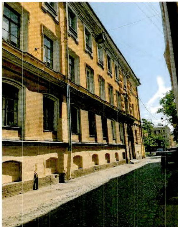
25. Фрагмент западного фасада объекта культурного наследия, южная часть.
