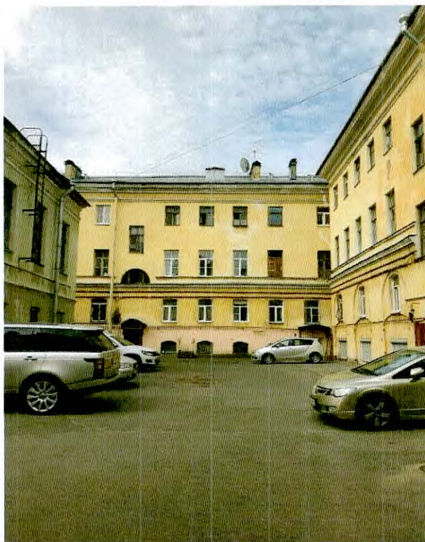
28. Фрагмент восточного дворового фасада объекта культурного наследия.
