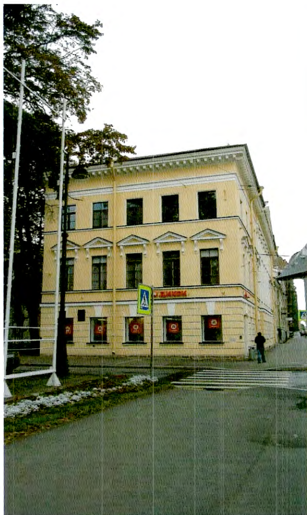
17. Южный фасад объекта культурного наследия.
