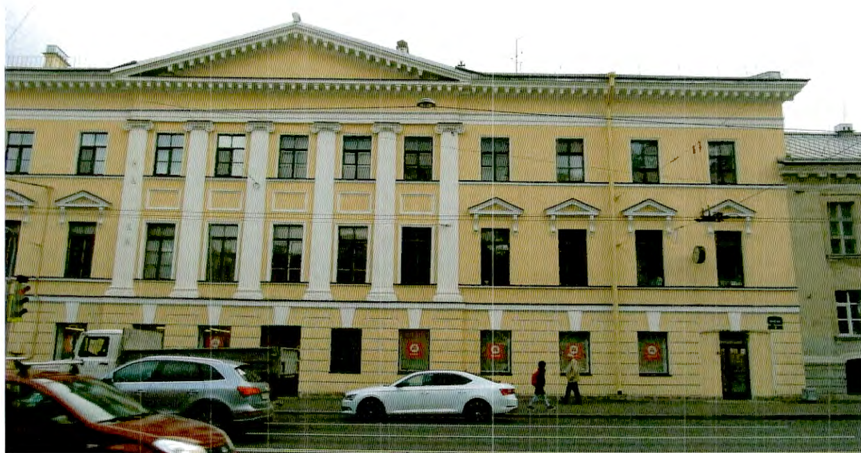
15. Фрагмент восточного фасада объекта культурного наследия.
