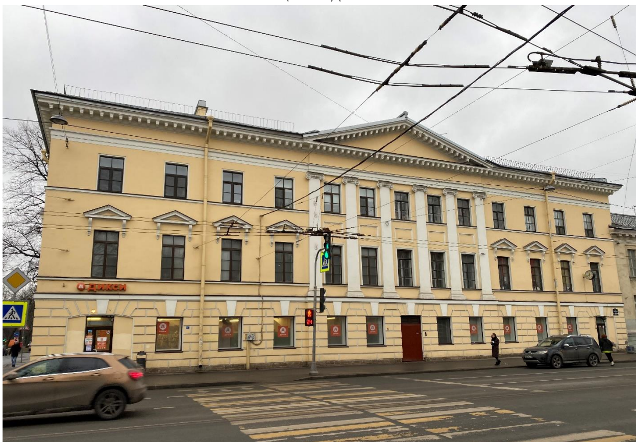
Фото 2. Лицевой северо-восточный фасад. Вид с востока
