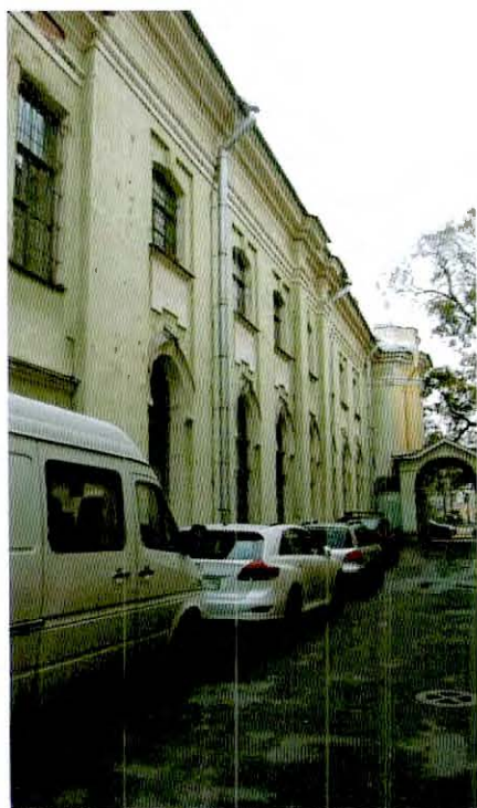
4. Фрагмент западного фасада объекта культурного наследия.
