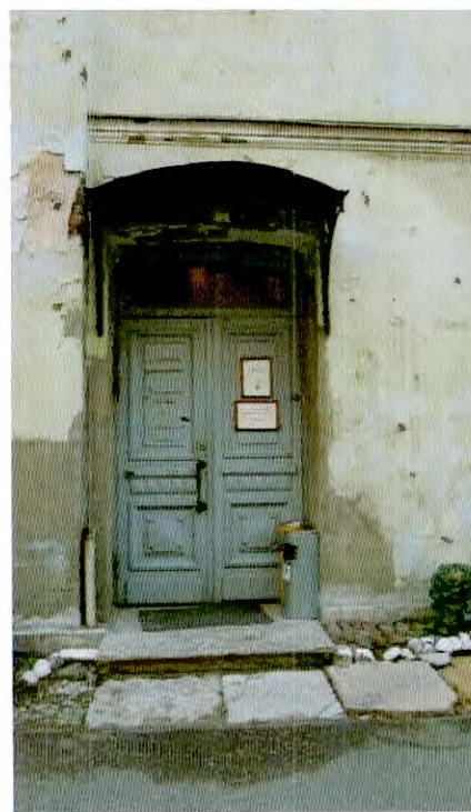
5. Фрагмент восточного фасада объекта культурного наследия.
