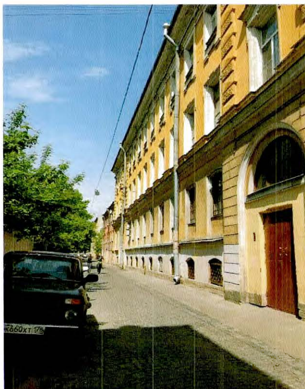
26. Фрагмент западного фасада объекта культурного наследия, северная часть.
