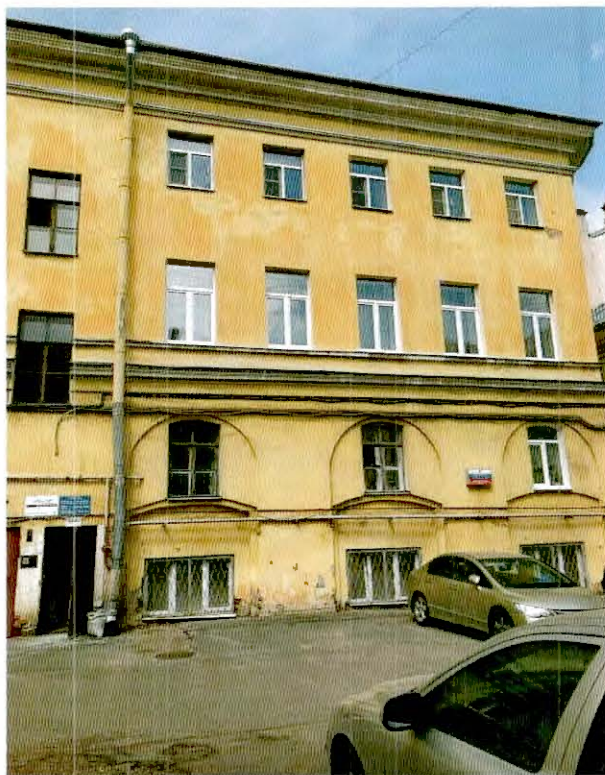
29. Фрагмент южного дворового фасада объекта культурного наследия.
