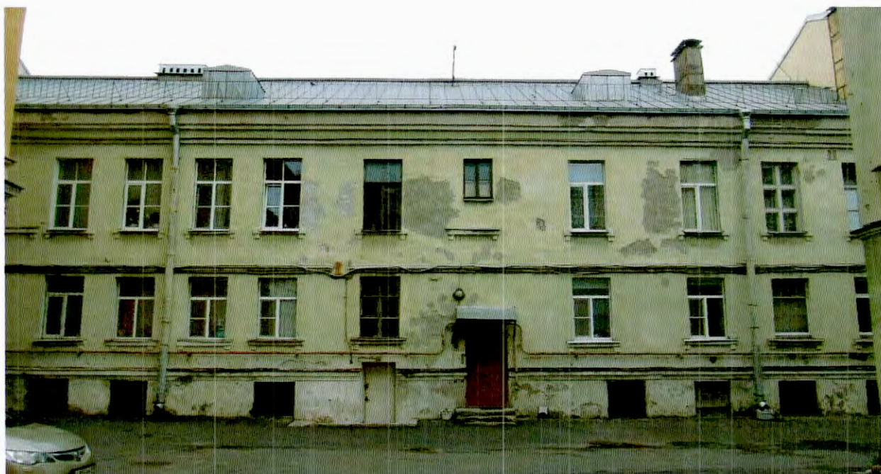
20. Фрагмент западного фасада объекта культурного наследия.
