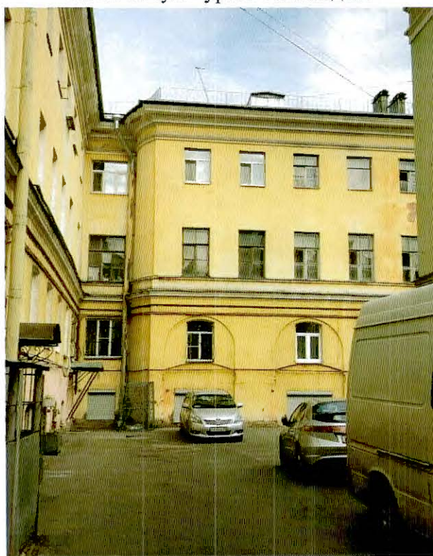
30. Фрагмент южного дворового фасада объекта культурного наследия.
