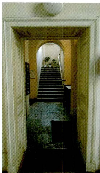
9. Внутренняя планировочная структура объекта культурного наследия. Вестибюль западного входа.
