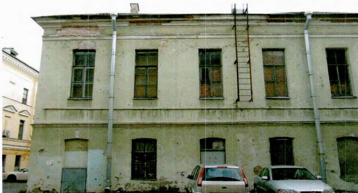
6. Фрагмент северного фасада объекта культурного наследия.
