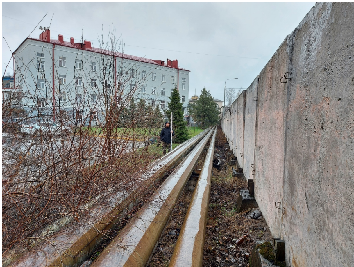
Точка фотофиксации 1. Вид на южную часть участка обследования с Ю.
