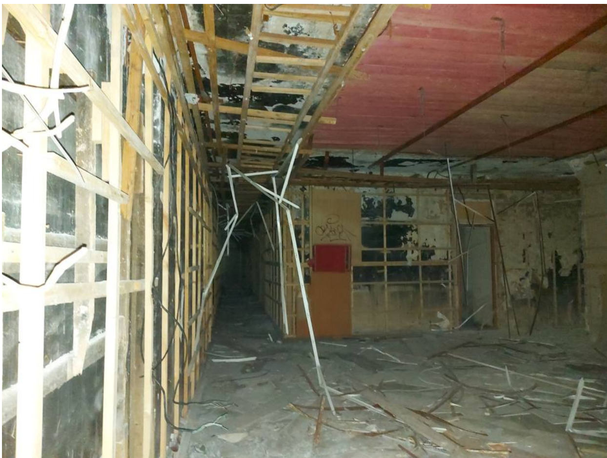
Фото 94. Северо-восточное помещение центрального корпуса.
