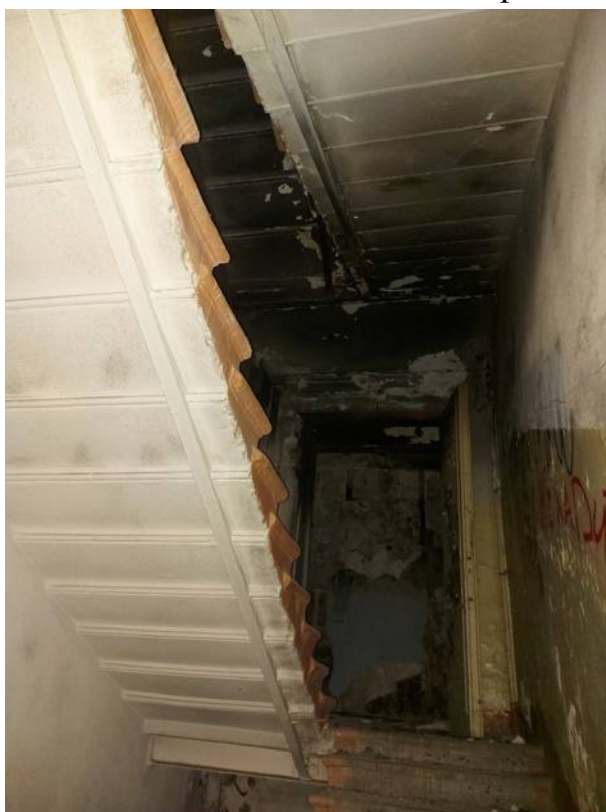
Фото 105. Лестница на 5 этаж.
