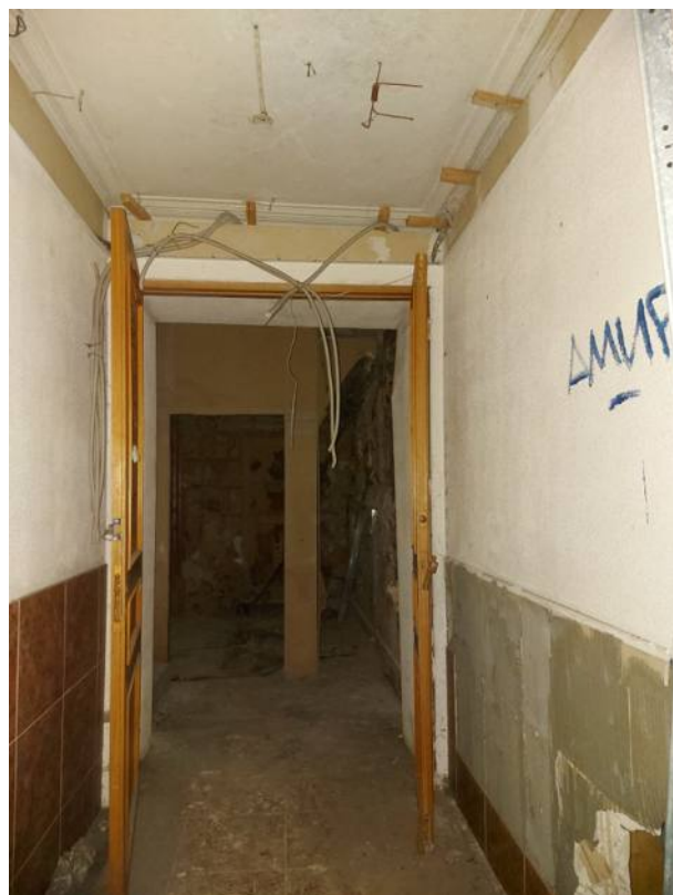
Фото 32. Коридор западного входа.
