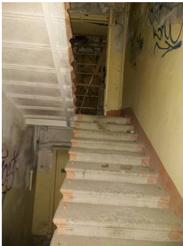
Фото 89. Лестница, вид с междуэтажной площадки.
