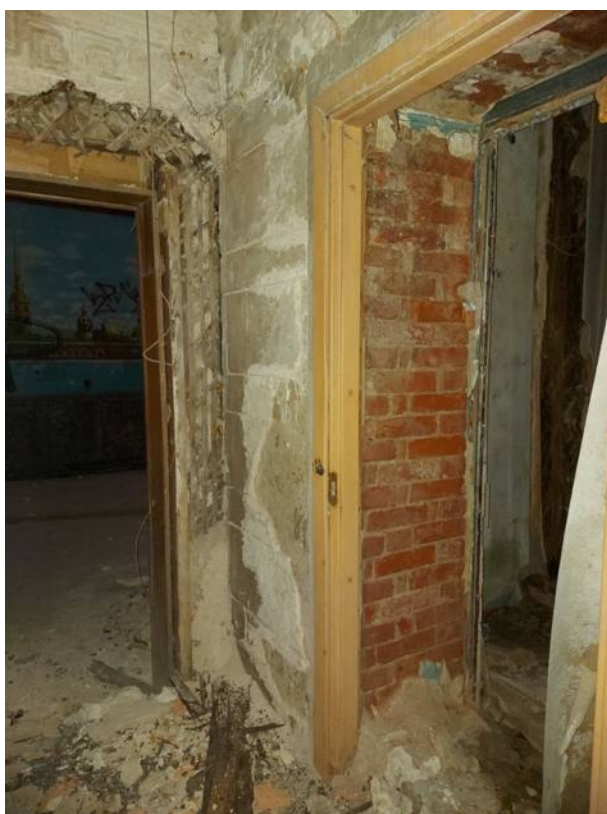
Фото 50. Проемы в центральной части.
