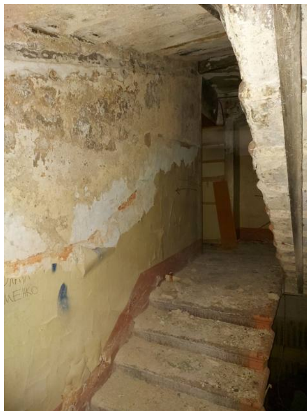
Фото 73. Лестница южного корпуса, междуэтажная площадка.
