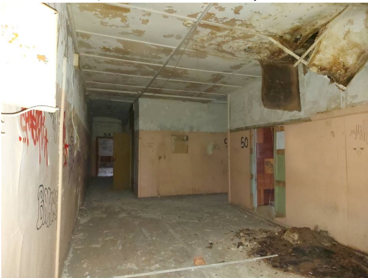
Фото 115. Помещение центрального корпуса на 6 этаже.
