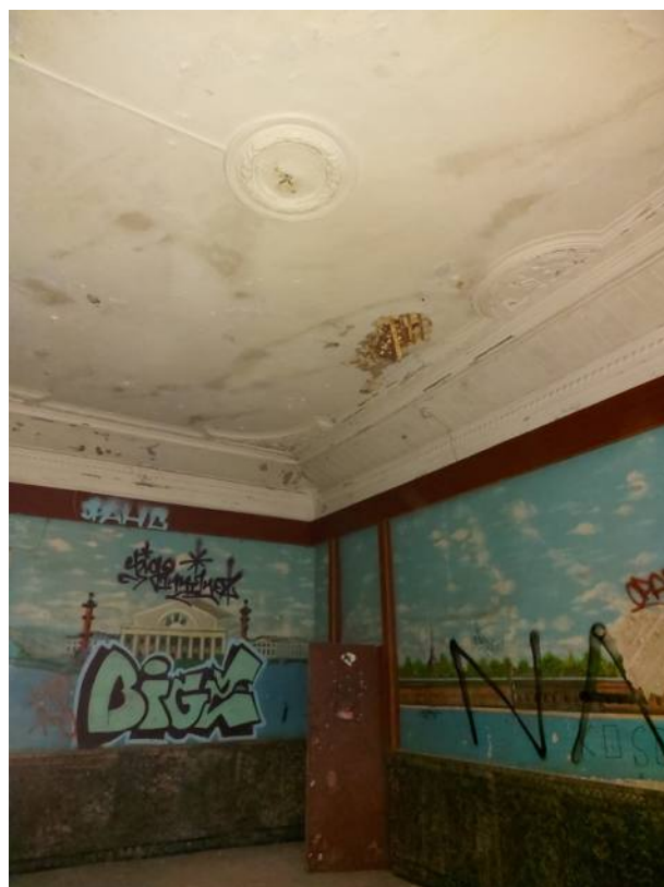
Фото 54. Северо-восточный угол помещения 9.
