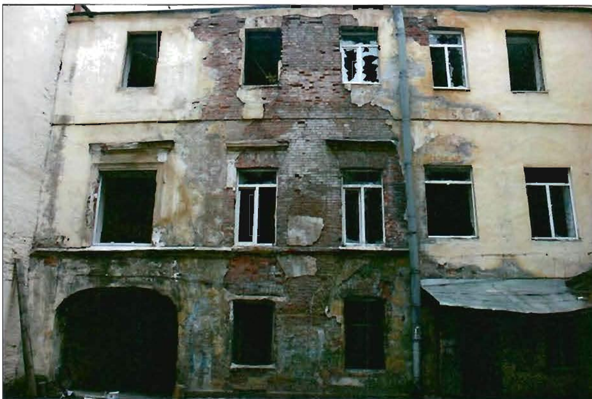
2. Дворовый фасад. Общий вид.
