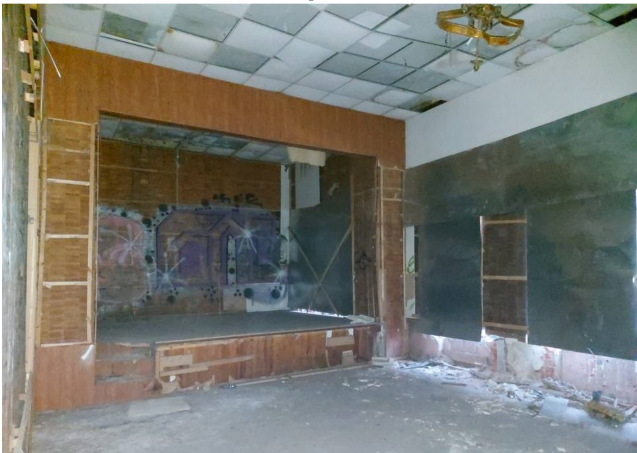
Фото 43. Западная часть помещения 14.
