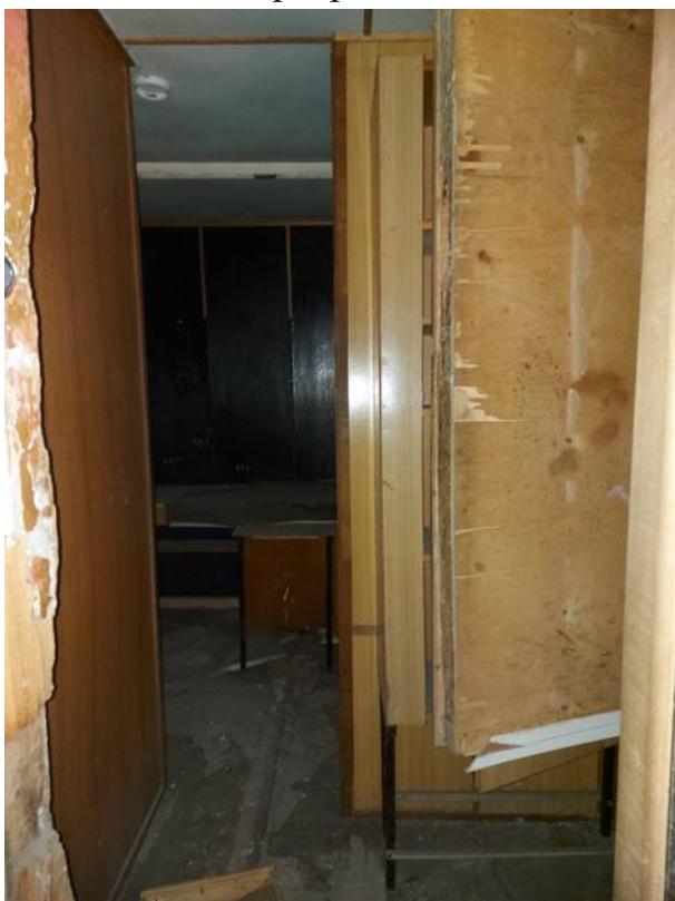
Фото 46. Вид на помещение 13.
