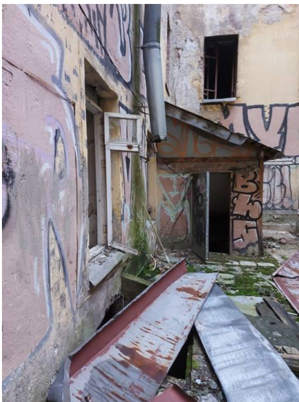
Фото 69. Вход в подвал, недоступен.
