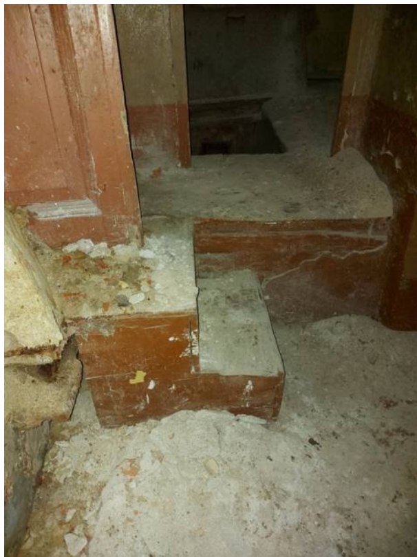
Фото 28. Ступени в западной части.
