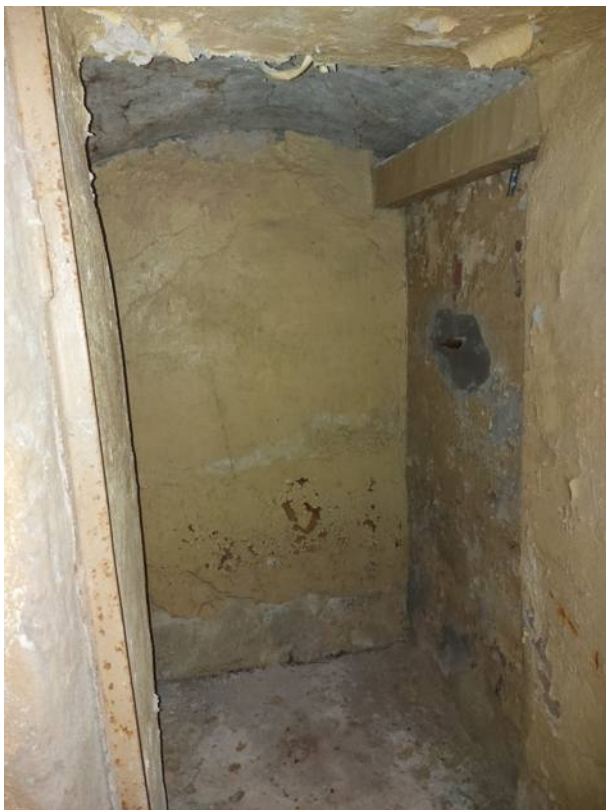
Фото 27. Помещение под парадной лестницей.
