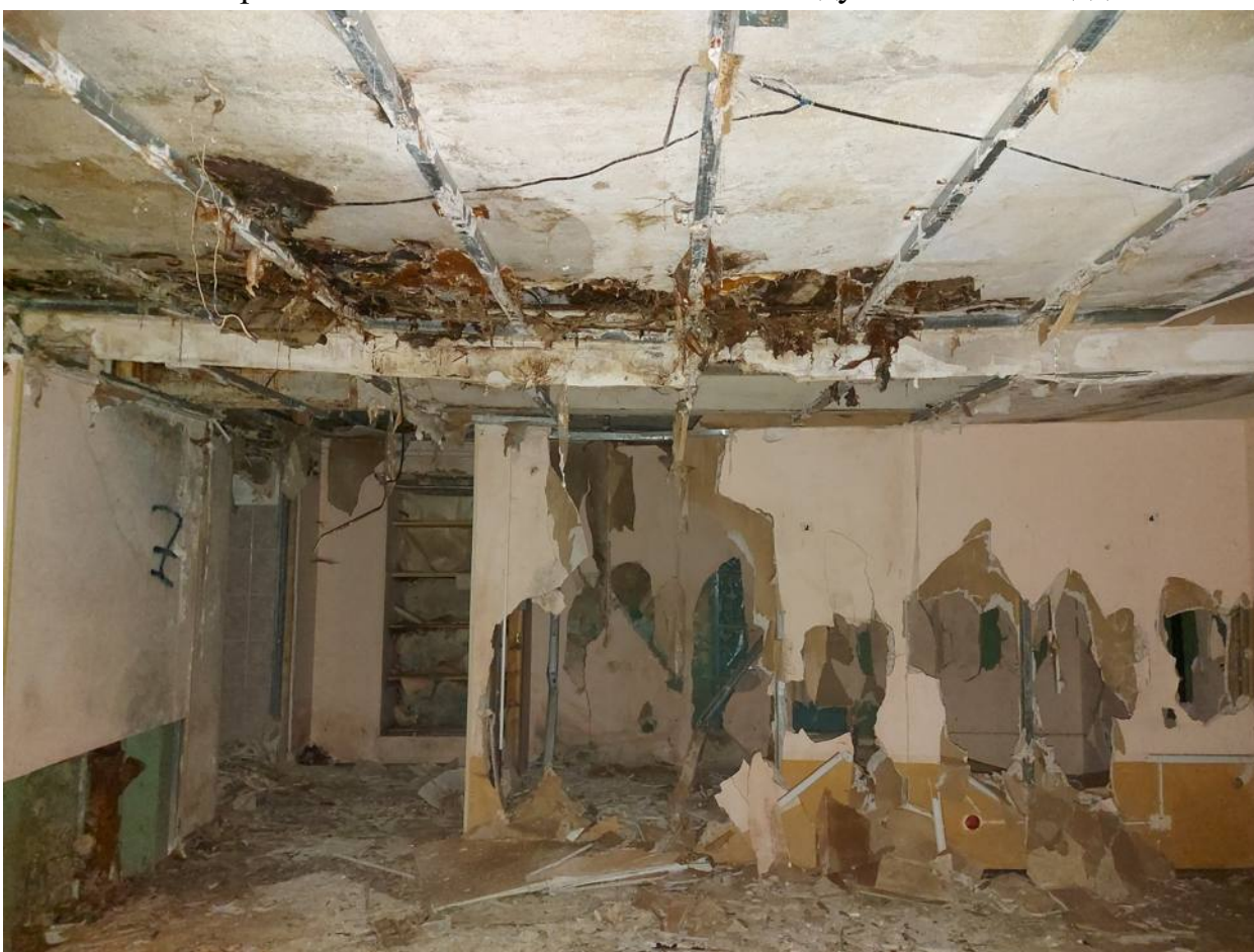
Фото 74. Помещение 1, южного корпуса.
