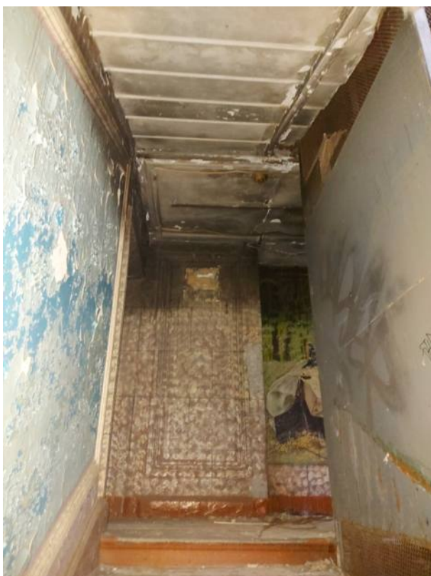
Фото 109. Северная лестница на 5 этаж.
