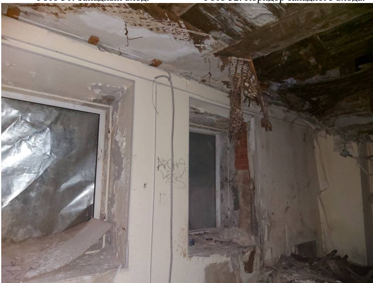
Фото 33. Проемы лицевого фасада.
