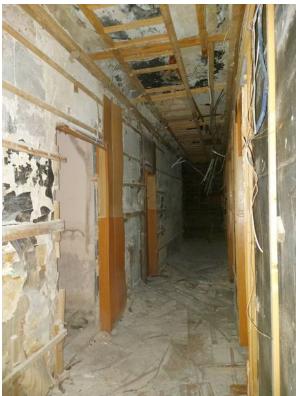
Фото 90. Коридор центрального корпуса.
