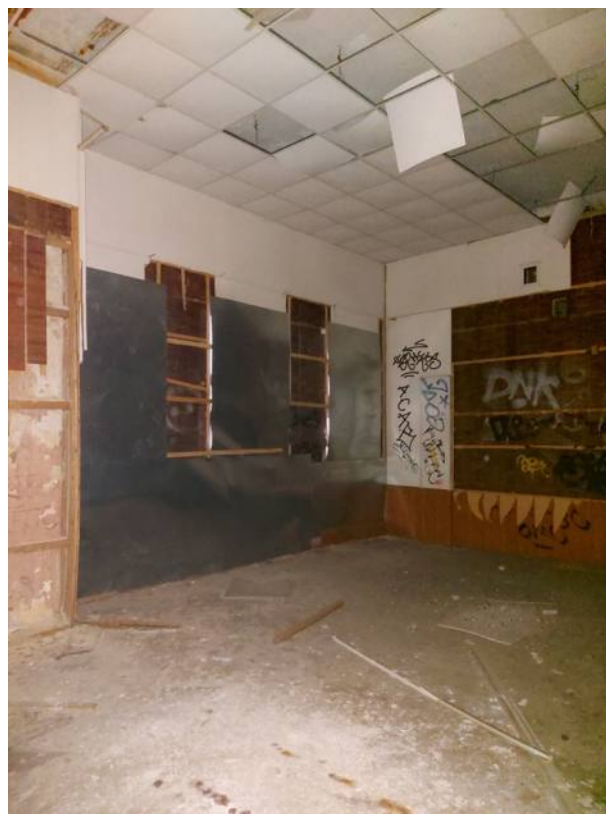
Фото 45. Северо-восточный угол помещения 14.
