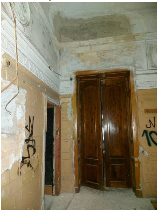
Фото 40. Площадка второго этажа.
