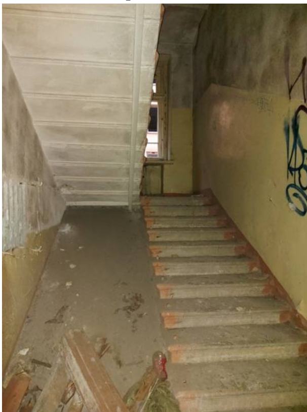
Фото 88. Лестницы центрального корпуса.
