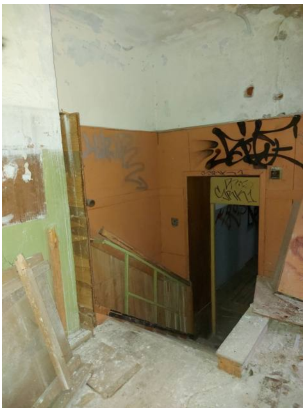
Фото 59. Юго-восточное помещение с лестницей на третий этаж.
