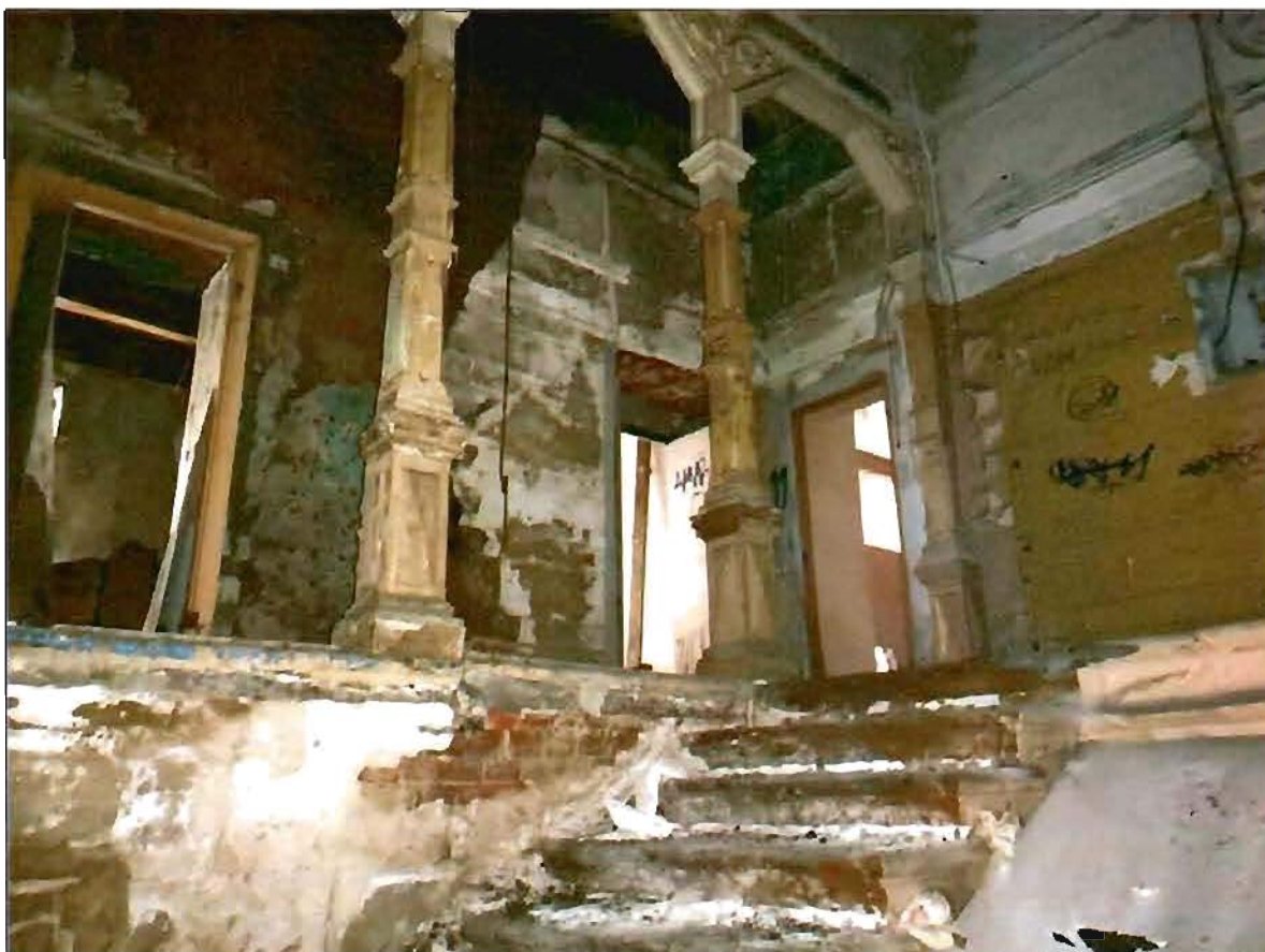
3. Интерьер. Фрагмент. Лестница с арками галереи.
