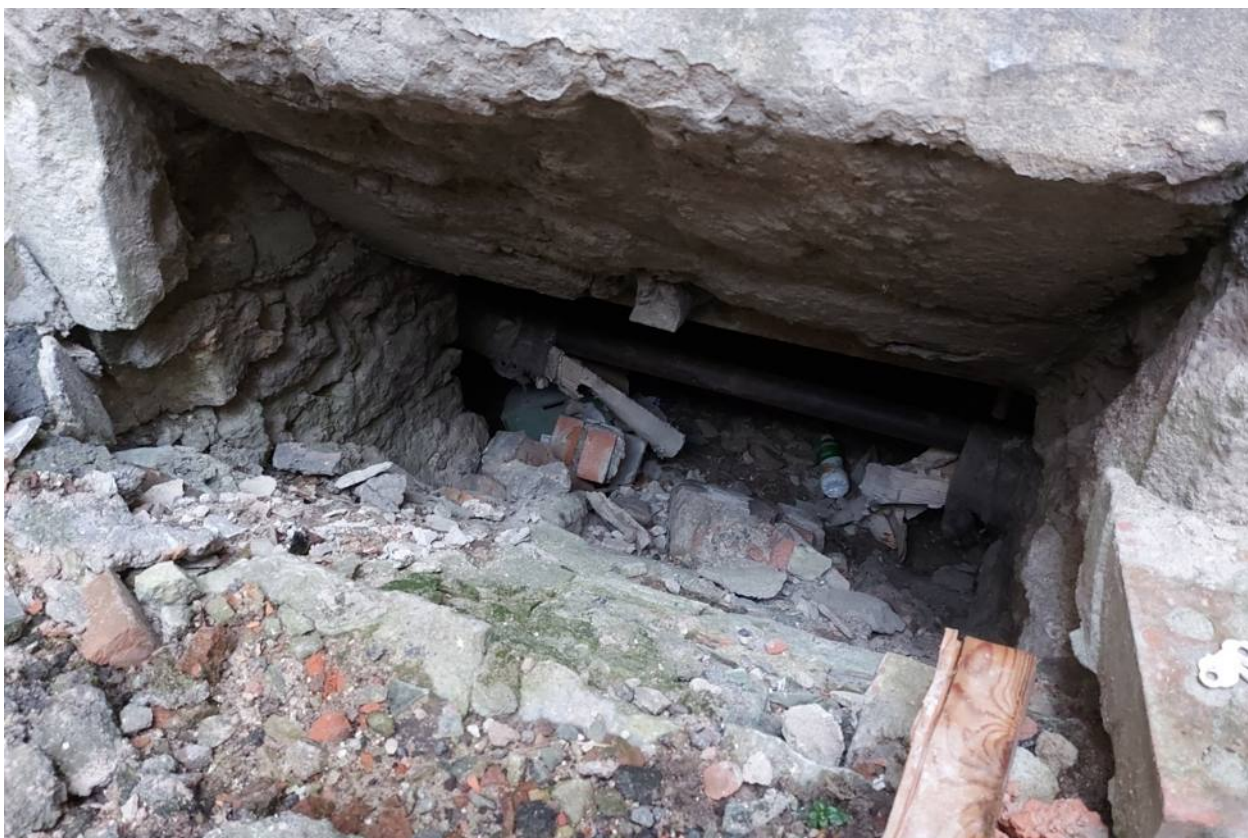
Фото 64. Проем в подвал центрального корпуса.
