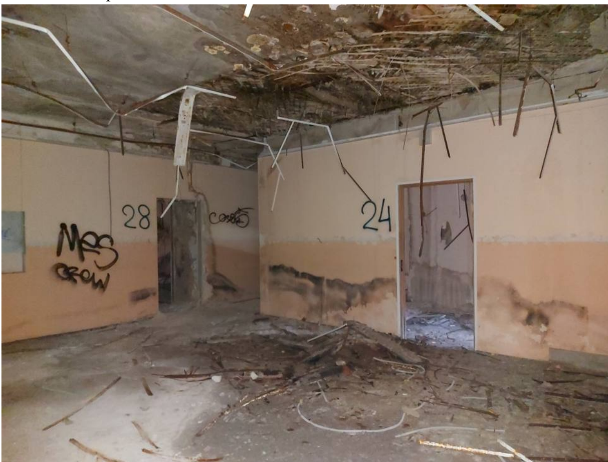
Фото 99. Помещение 1 центрального корпуса.
