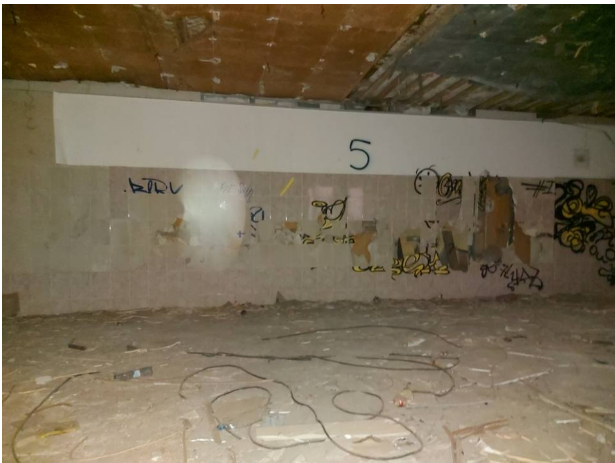
Фото 78. Помещение первого этажа восточного корпуса второго двора.
