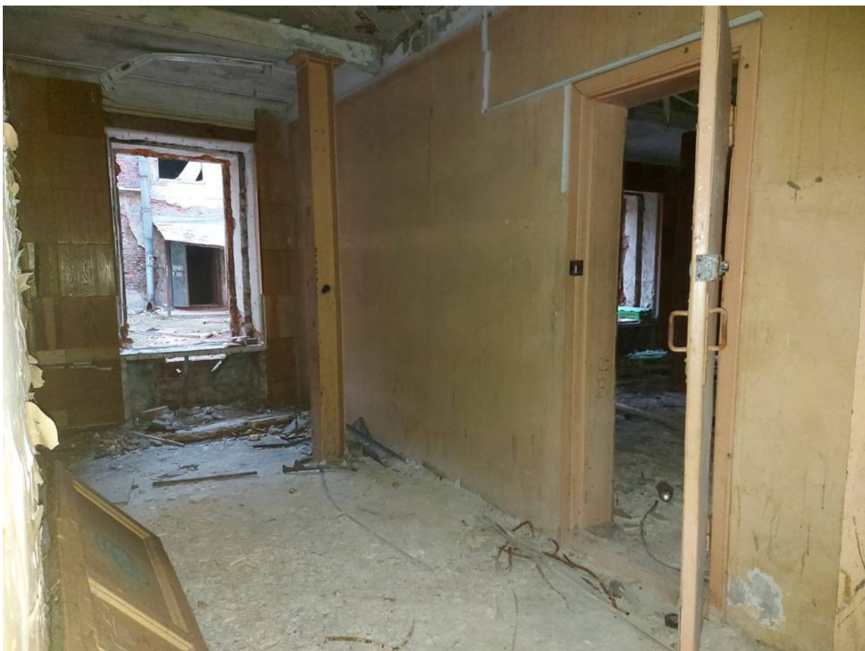
Фото 81. Помещение первого этажа центрального корпуса.
