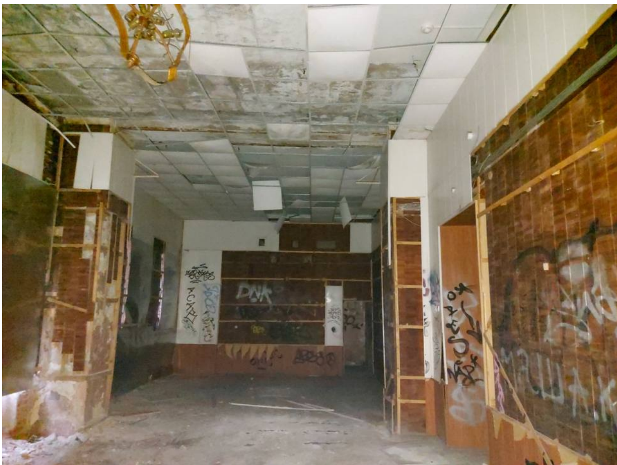
Фото 42. Восточная и центральная часть помещения 14.
