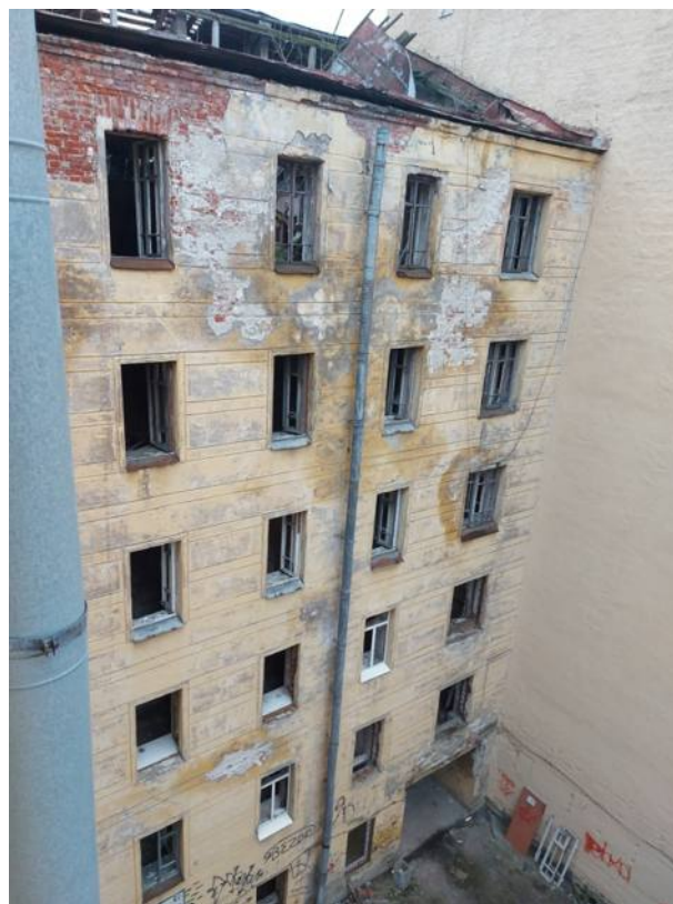
Фото 70. Общий вид сверху центрального корпуса.
