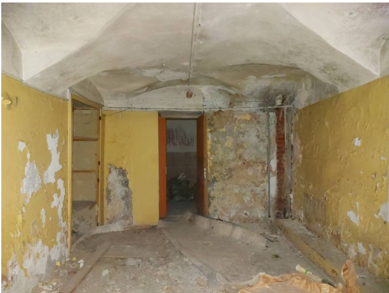
Фото 19. Помещение 5, по дворовому фасаду.
