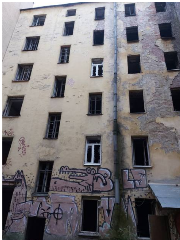
Фото 67. Южный фасад центрального корпуса.
