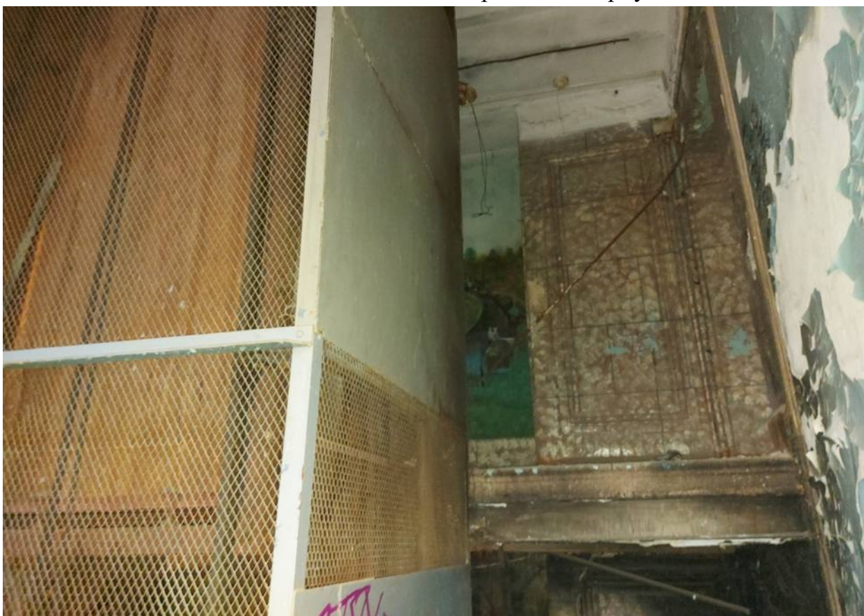
Фото 112. Вид на 6 этаж северной лестницы.
