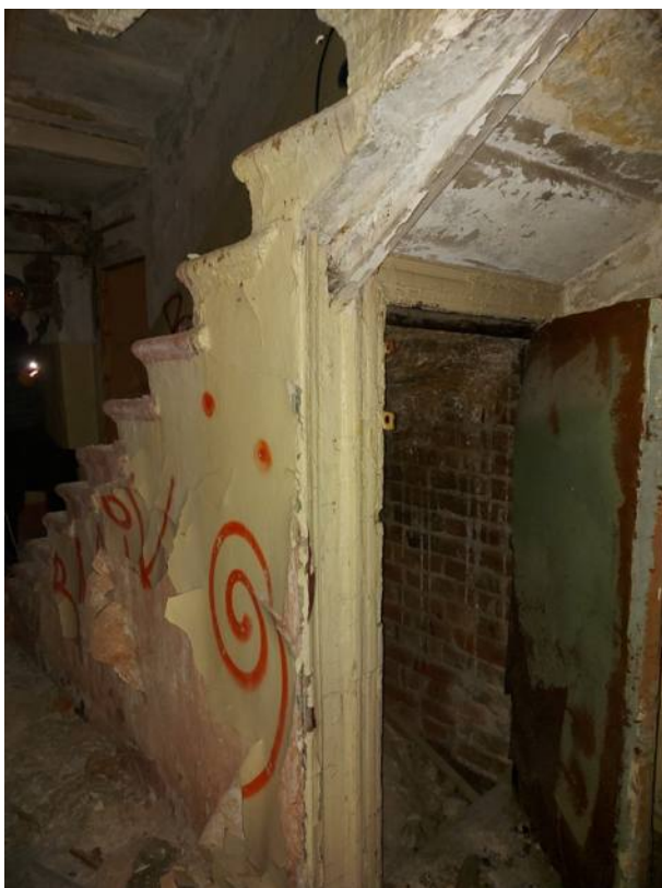
Фото 72. Лестница южного корпуса, первый этаж.
