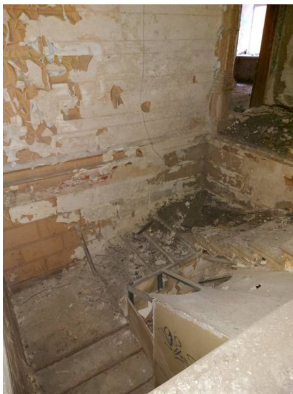
Фото 41. Парадная лестница, вид со второго этажа.
