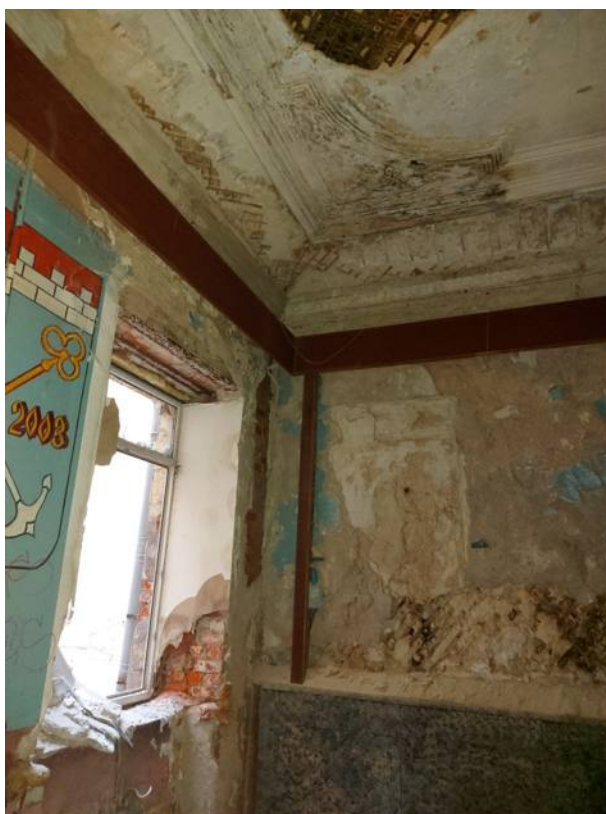
Фото 53. Фрагмент помещения 9, оконный проем.
