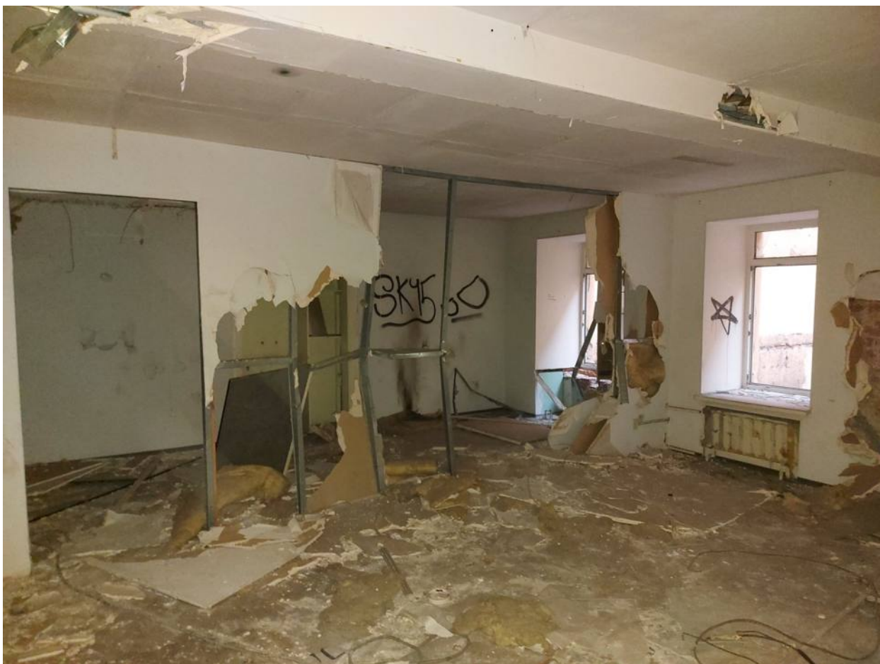
Фото 75. Помещения второго этажа южного корпуса.
