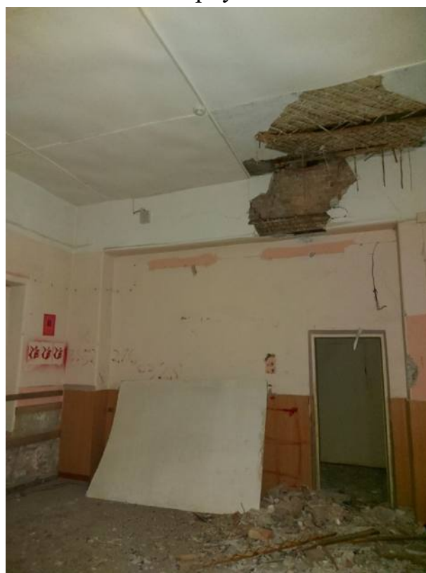
Фото 58. Помещение 8 и проем в помещении 7.
