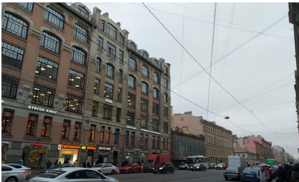
Фото 1. Общий вид по Среднему проспекту с северо-востока.
