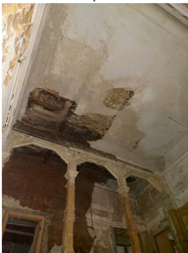
Фото 37. Перекрытие парадной лестницы.
