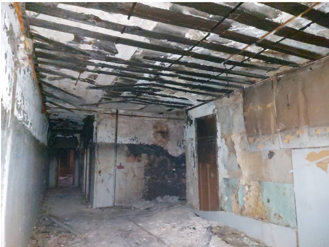
Фото 111. Помещение центрального корпуса.
