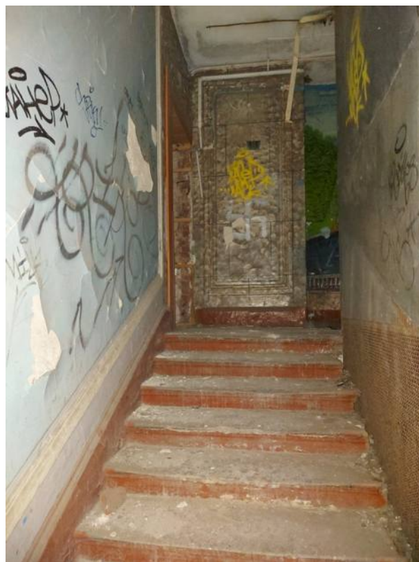
Фото 91. Лестница северная, марш на второй этаж.
