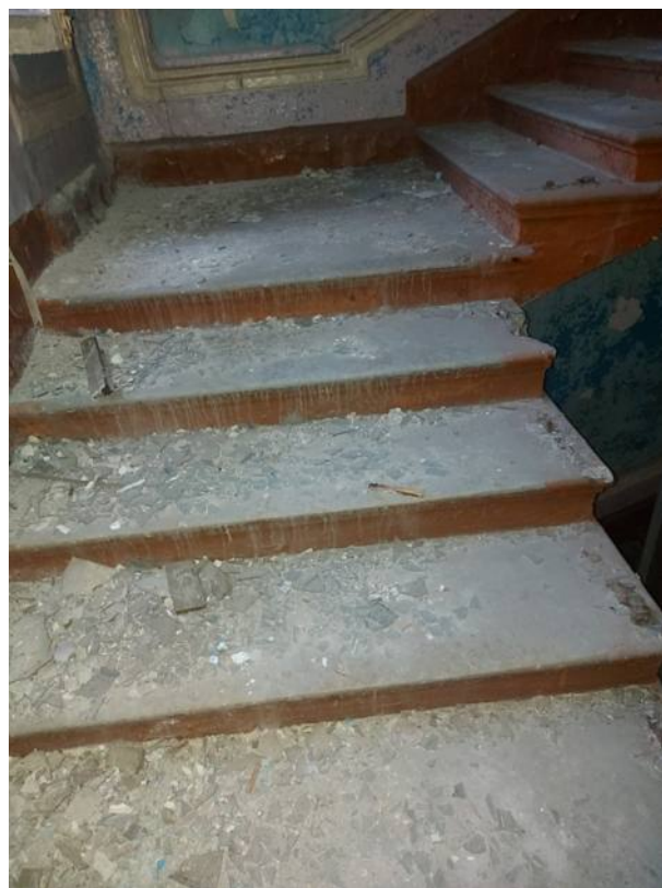
Фото 114. Лестничные марши северной лестницы.
