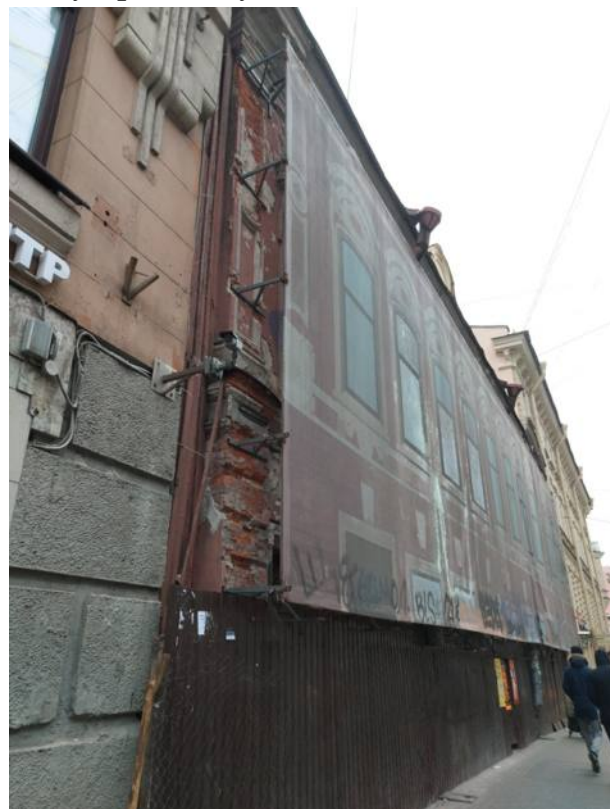
Фото 5. Лицевой фасад с востока.
