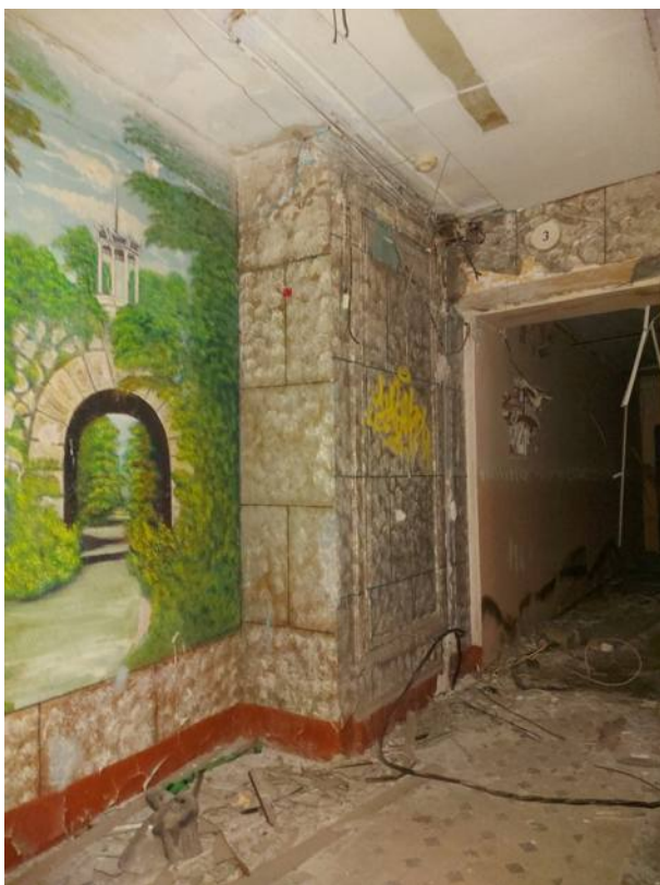
Фото 97. Площадка третьего этажа северной лестницы.
