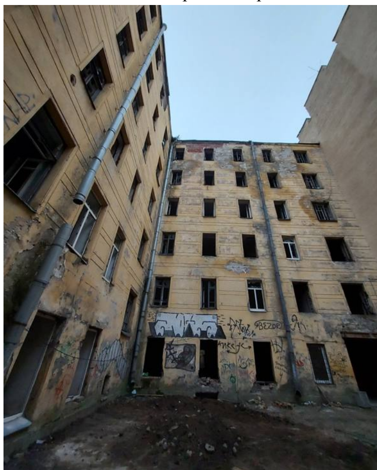
Фото 63. Центральный дворовой корпус, вид с севера.
