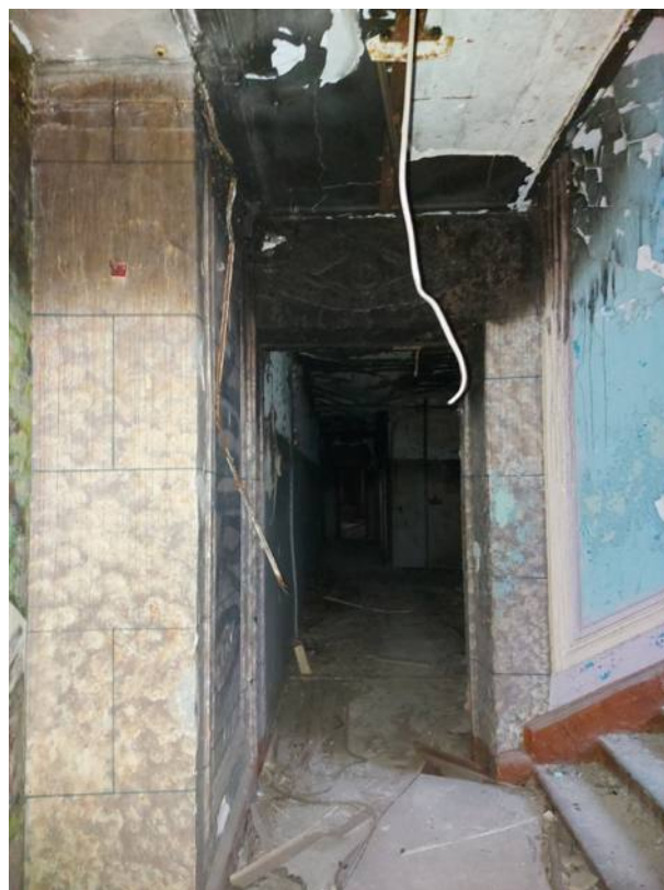
Фото 108. Северная лестница, пятый этаж.
