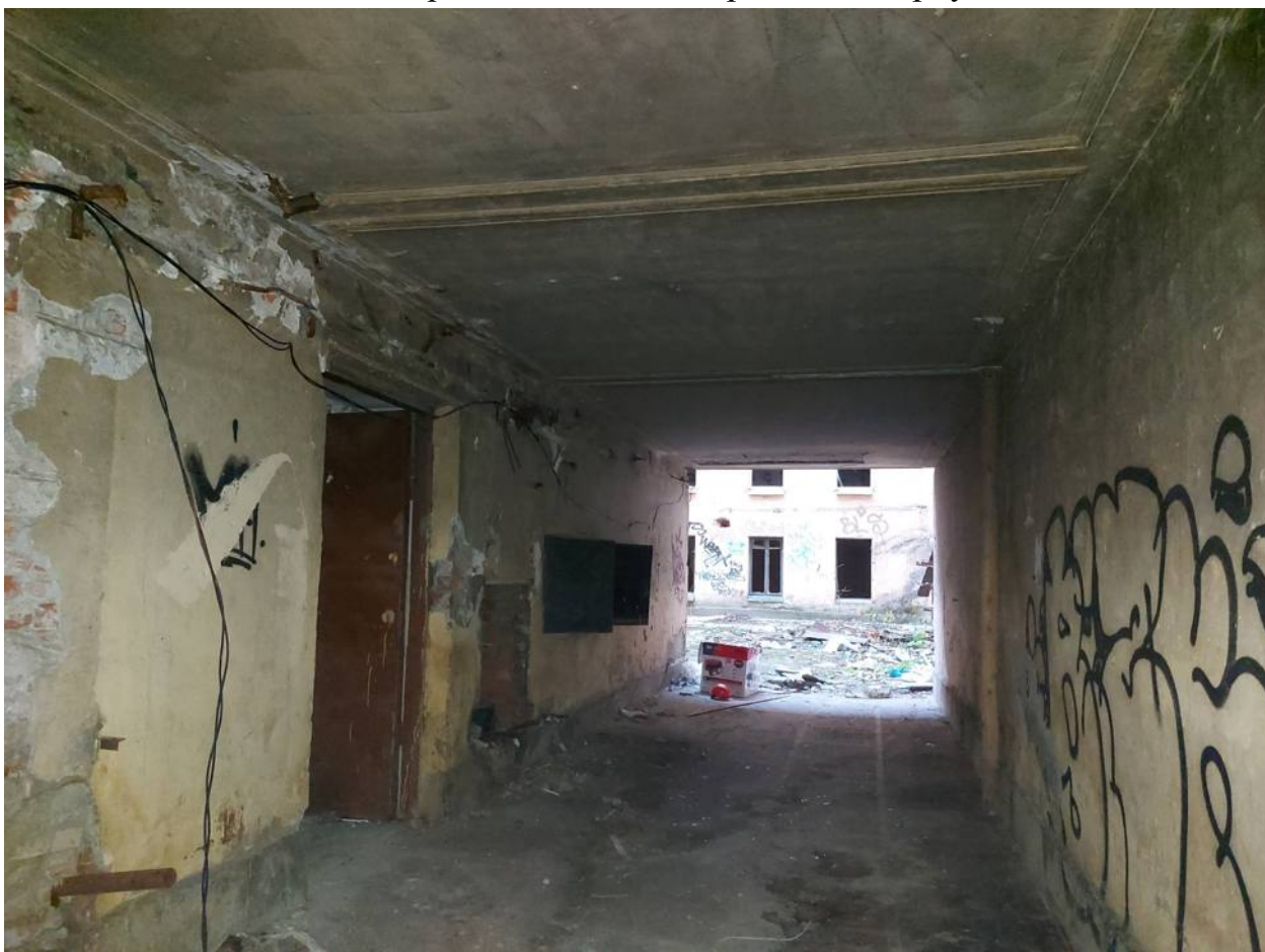
Фото 65. Проездная арка центрального корпуса.
