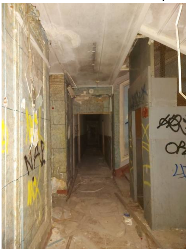
Фото 84. Первый этаж северной лестницы.
