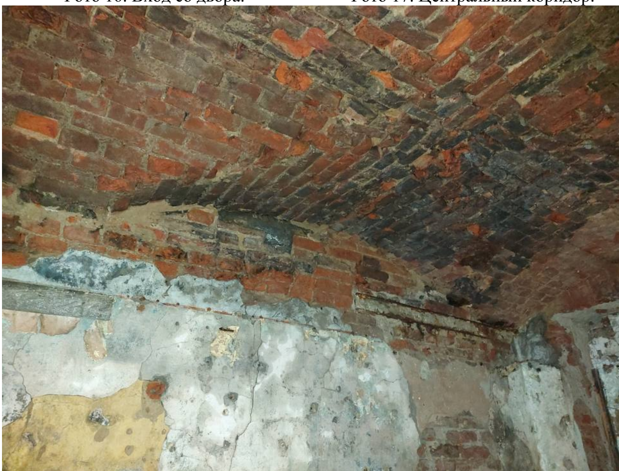
Фото 18. Фрагмент перекрытия, заложенные проемы.
