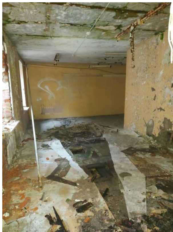
Фото 60. Западное помещение третьего этажа.
