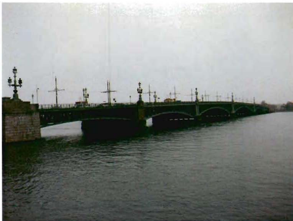
1. Вид на мост со стороны верхового фасада
