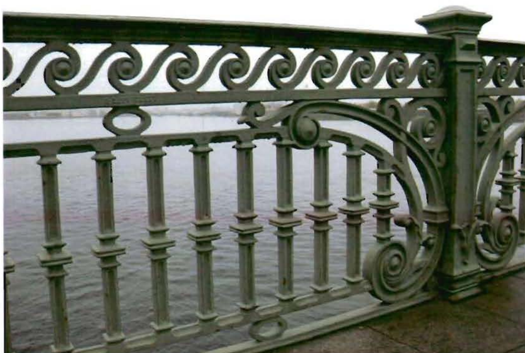
6. Решетка перильного ограждения (фрагмент)
