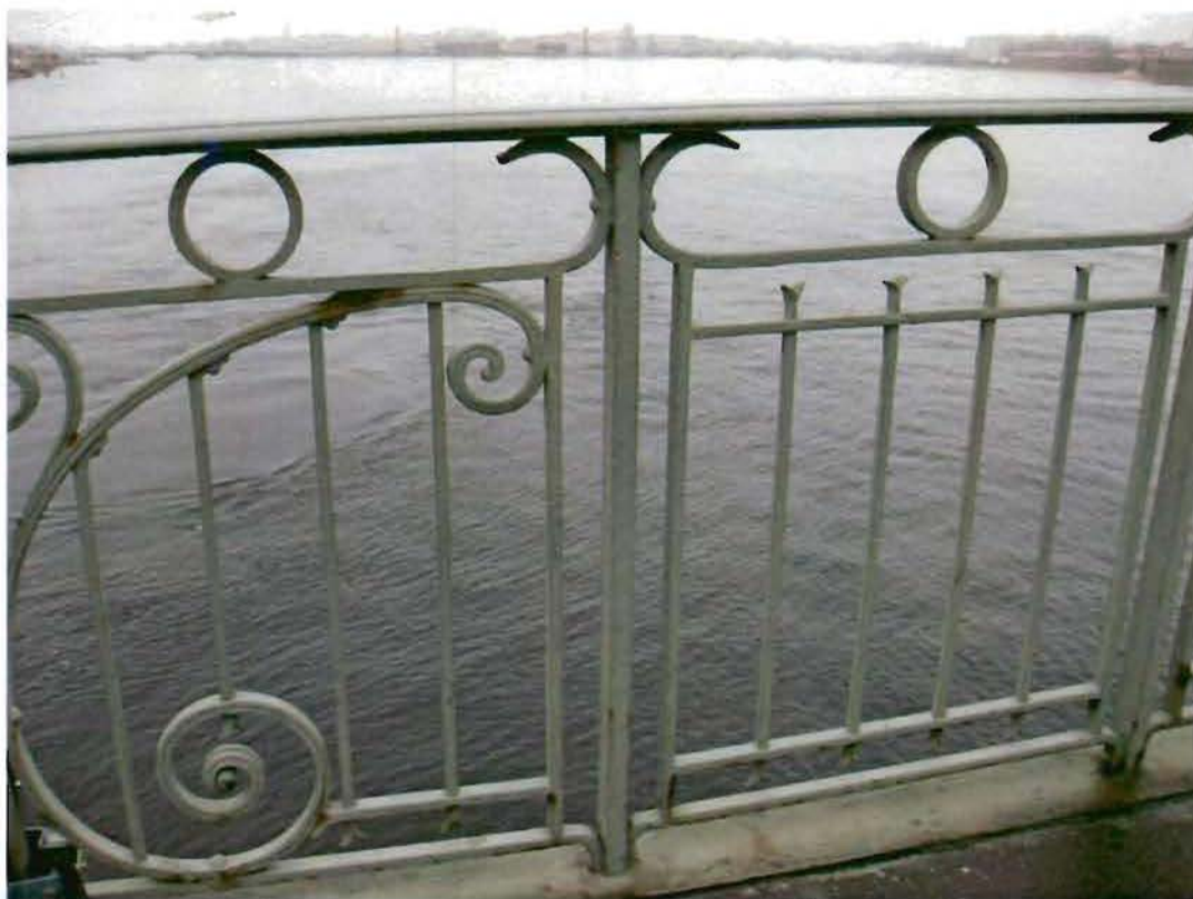
7. Решетка перильного ограждения (фрагмент)
