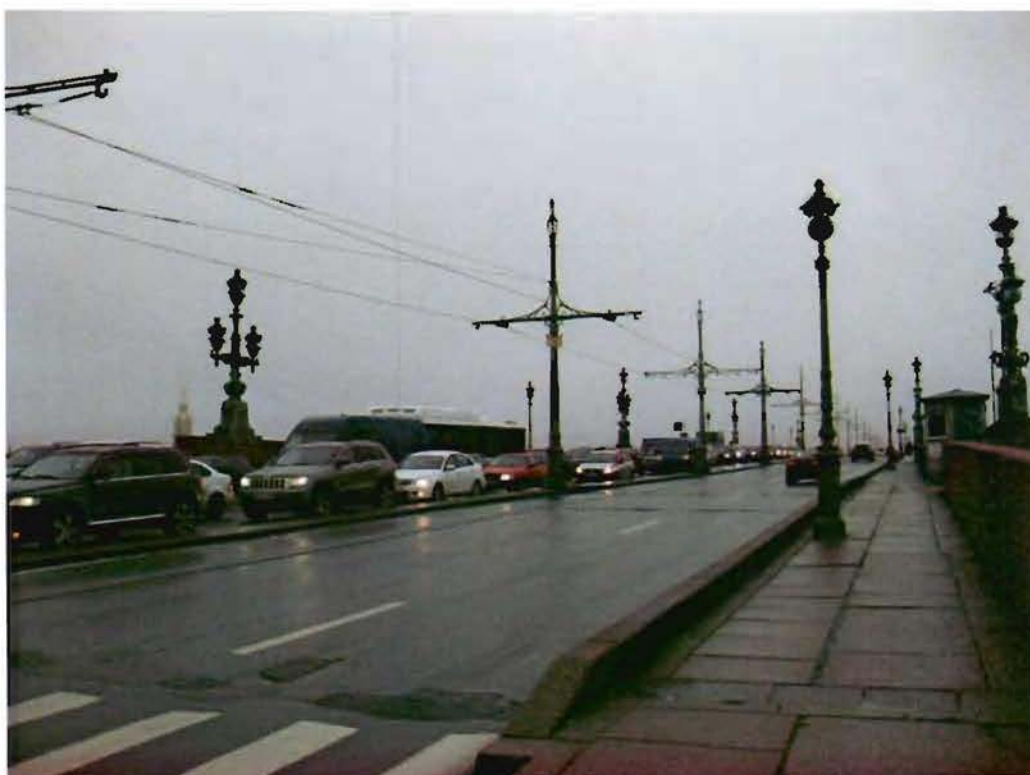
4. Вид на поверхность моста
