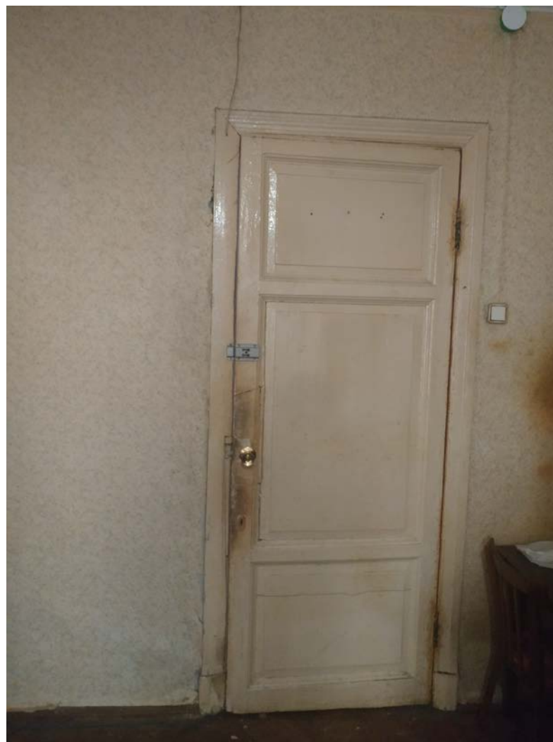
10. Помещение №14 кв. №34 в уровне 2-го этажа выявленного объекта культурного наследия «Доходный дом сельскохозяйственного товарищества «Помещик»», расположенного по адресу: г. Санкт-Петербург, Измайловский пр., д. 16/30, литера А. 15.09.2020.
