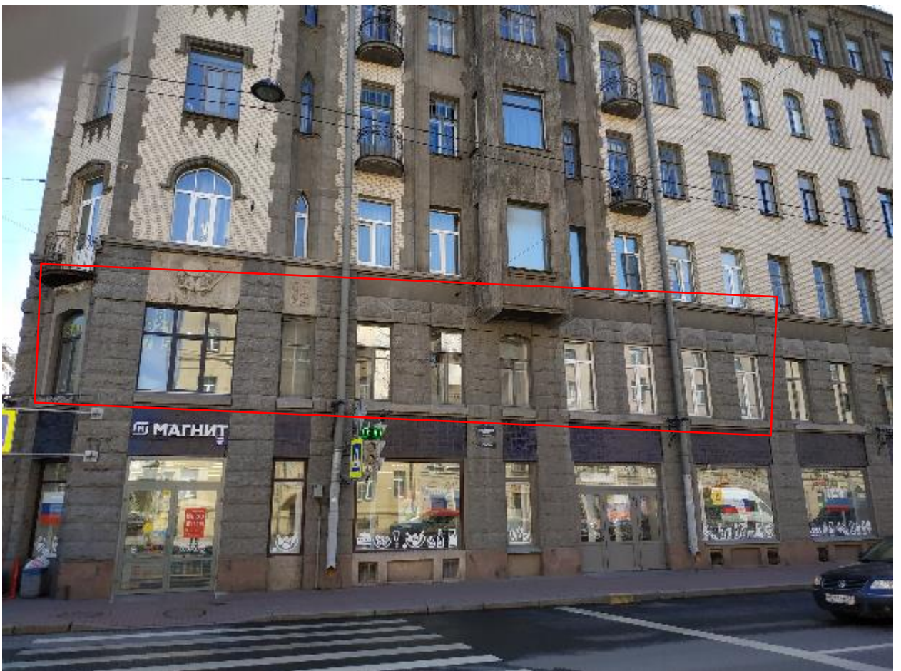
2. Оконные заполнения кв. №34 в уровне 2-го этажа выявленного объекта культурного наследия «Доходный дом сельскохозяйственного товарищества «Помещик»», расположенного по адресу: г. Санкт-Петербург, Измайловский пр., д. 16/30, литера А, по Измайловскому пр. 15.09.2020.
