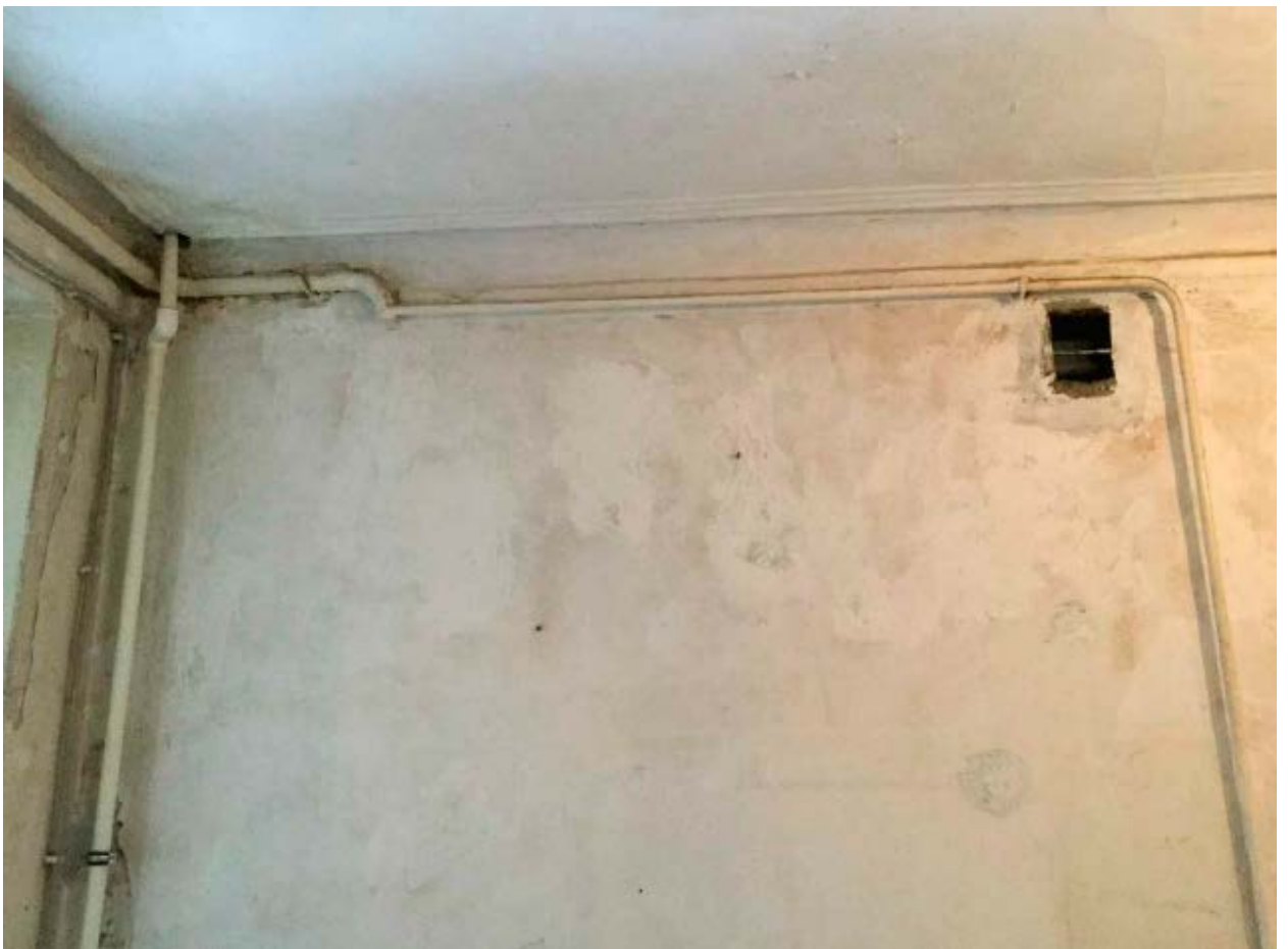
9. Помещение №14 кв. №34 в уровне 2-го этажа выявленного объекта культурного наследия «Доходный дом сельскохозяйственного товарищества «Помещик»», расположенного по адресу: г. Санкт-Петербург, Измайловский пр., д. 16/30, литера А. 15.09.2020.
