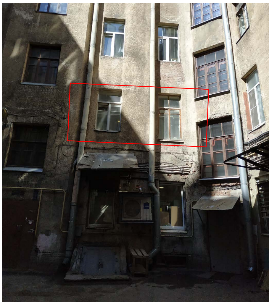
3. Оконные заполнения кв. №34 в уровне 2-го этажа дворового фасада выявленного объекта культурного наследия «Доходный дом сельскохозяйственного товарищества «Помещик»», расположенного по адресу: г. Санкт-Петербург, Измайловский пр., д. 16/30, литера А. 15.09.2020.
