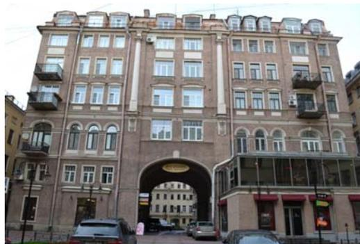
две колонны (3/4) со стилизованными коринфскими капителями на стилизованных кронштейнах оформленными лепным орнаментом – местоположение (в центральной части южного фасада дворового флигеля), конфигурация, габариты;
