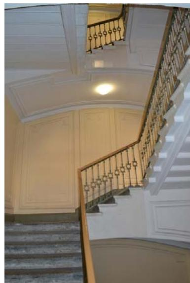
одномаршевые двухуровневые лестницы вестибюлей парадных входов западного и восточного крыльев дворового П-образного флигеля – на перепаде высот с известняковыми ступенями, металлическим ограждением с деревянными поручнями и площадкой с покрытием метлахской плиткой белого и серого цветов геометрического рисунка;
