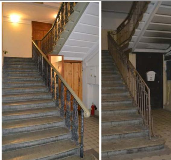
ограждение лестниц (вестибюля и парадной лестницы) восточного крыла – в виде вертикальных прутьев с перехватами и верхним горизонтальным поясом с волютообразными завитками и овальными розетками;
