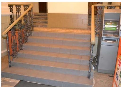
две исторические парадные лестницы дворового флигеля (западное и восточное крылья) – двухмаршевые, на косоурах, с известняковыми ступенями, металлическим ограждением с деревянными поручнями с лестничными площадками с покрытием метлахской плиткой белого и серого цветов геометрического рисунка;
