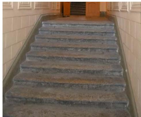
две исторические парадные лестницы лицевого корпуса – маршевые, на косоурах, с известняковыми ступенями и площадками, с металлическим ограждением в виде вертикальных стоек с перехватами, растительными завитками и кругами в центре; с деревянными поручнями;
