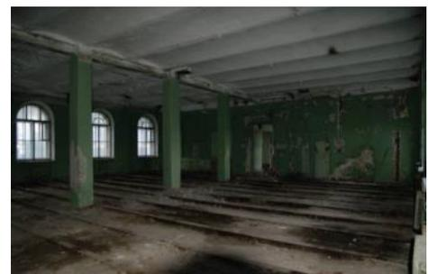
чугунные колонны третьего этажа со стилизованными капителями;
