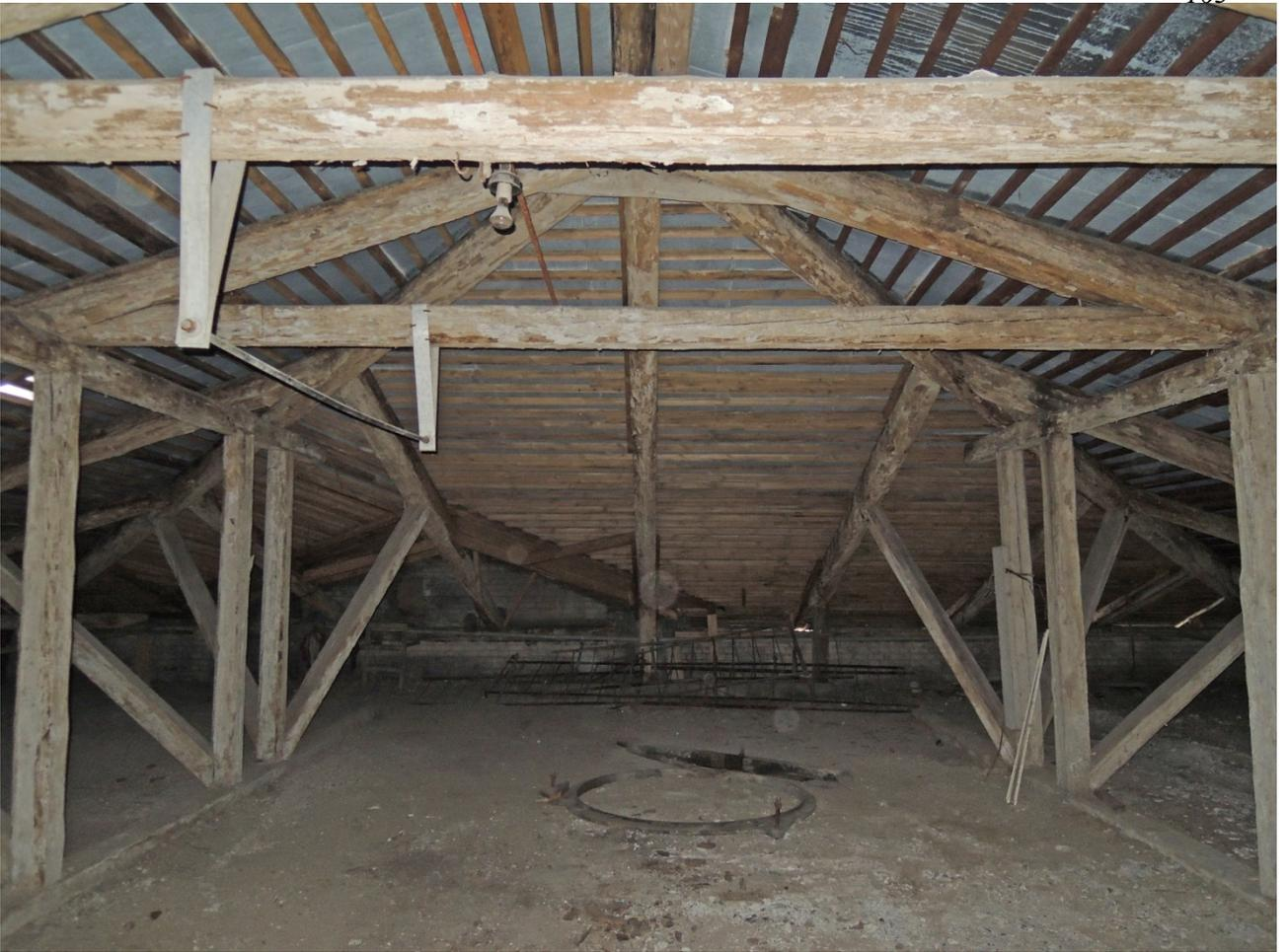
Фото 67. Стропильная система крыши.
