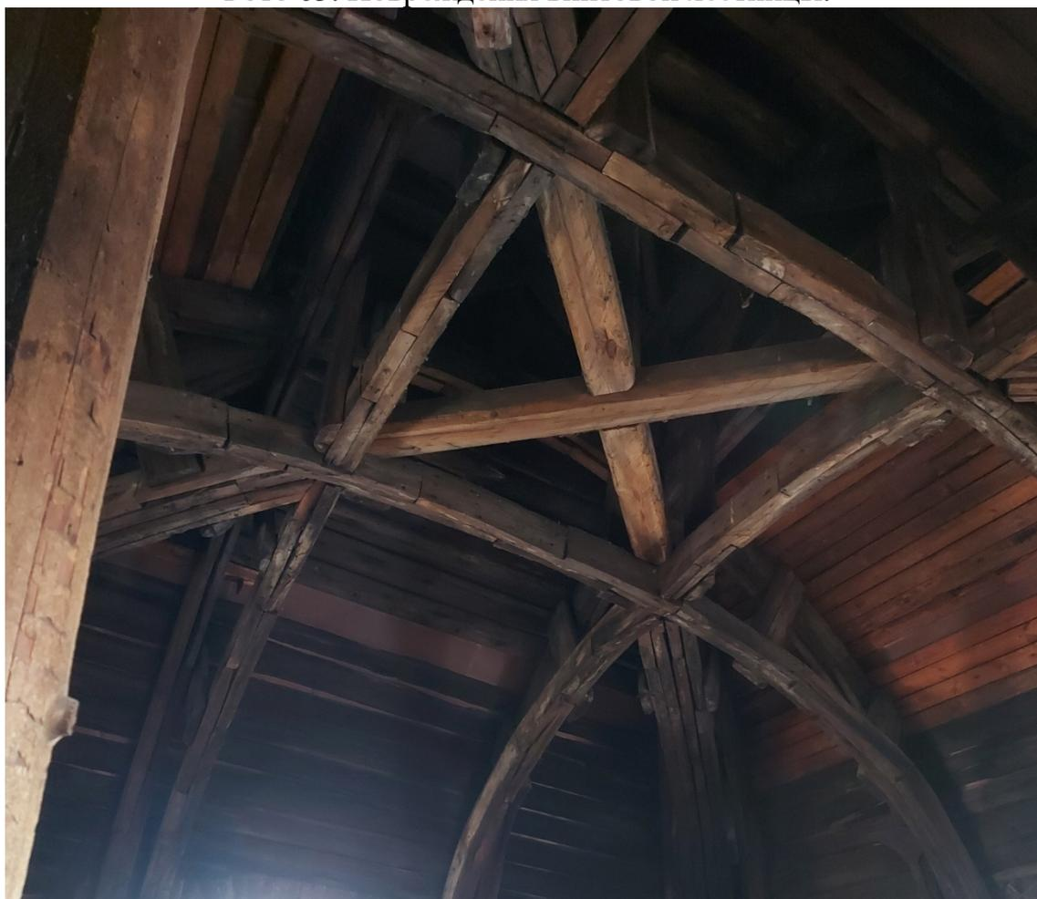
Фото 64. Деревянные конструкции купола.
