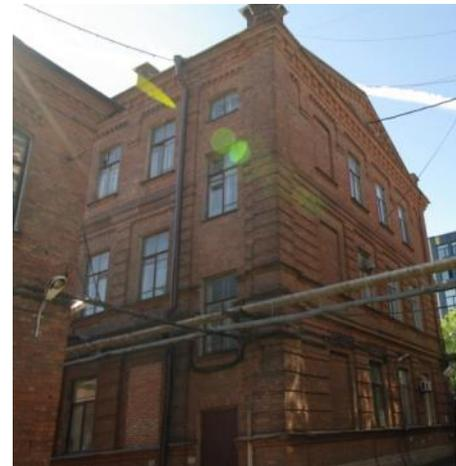
оконные проемы – исторические местоположение, габариты и конфигурация (арочные проемы 2-го этажа, сегментная (лучковая) кладка перемычек окон в уровне 3-го этажей); цвет и рисунок расстекловки (многочастный);
