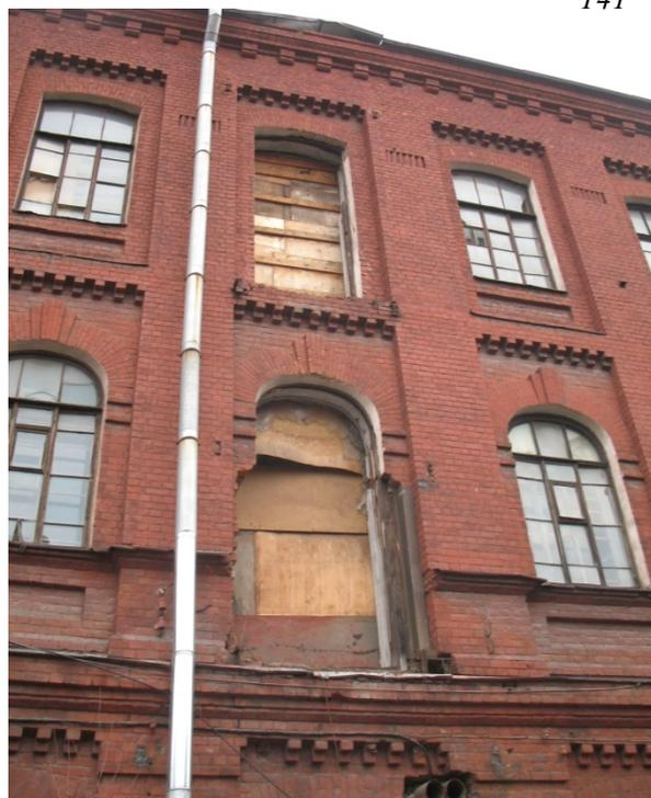
Фото 19. Фрагмент южного фасада, разрушения от позднего балкона.
