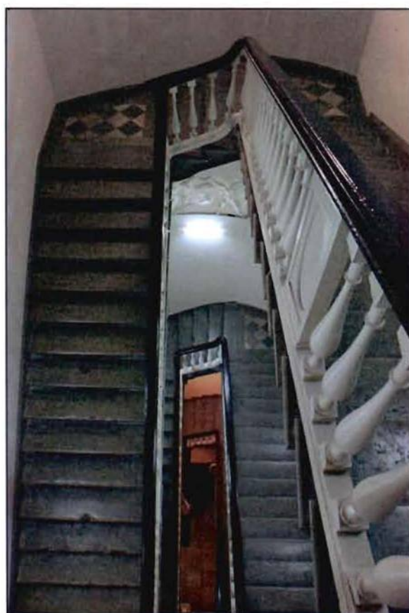
13. Интерьер. Фрагмент. Двухмаршевая лестница с известняковыми ступенями.
