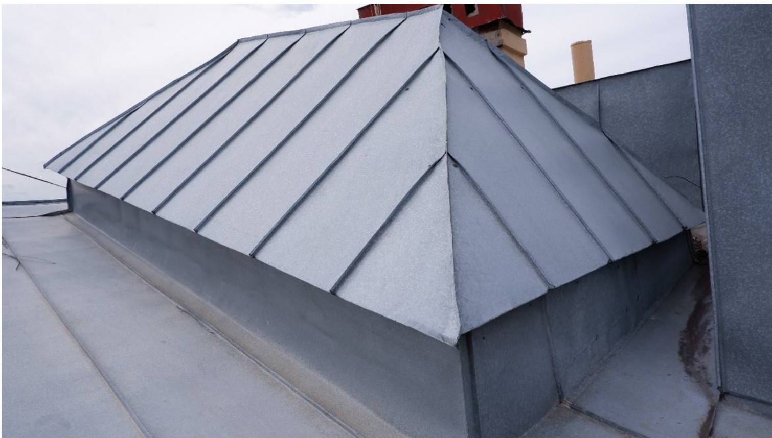
40. “Дом А.Ф. Кларка (здание общества «Мазут») Английская наб., д. 38, лит. А. Фонарь над лестницей №2. Вид снаружи. Фото:01.02.21.
