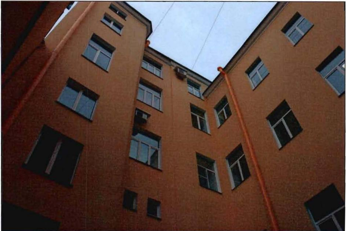
2. Вид на дворовые фасады.
