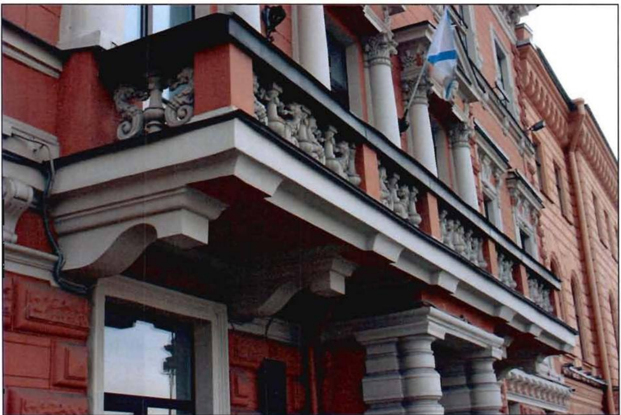
5. Северный фасад. Фрагмент. Балконы на парных каннелированных кронштейнах.
