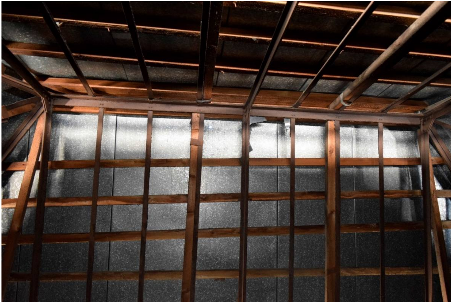
38. “Дом А.Ф. Кларка (здание общества «Мазут») Английская наб., д. 38, лит. А. Фонарь над лестницей №2. Фрагмент. Фото:01.02.21.
