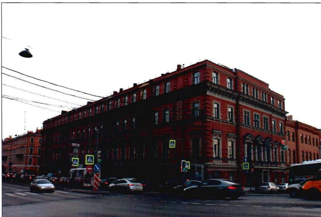
1. Общий вид с северо-востока.
