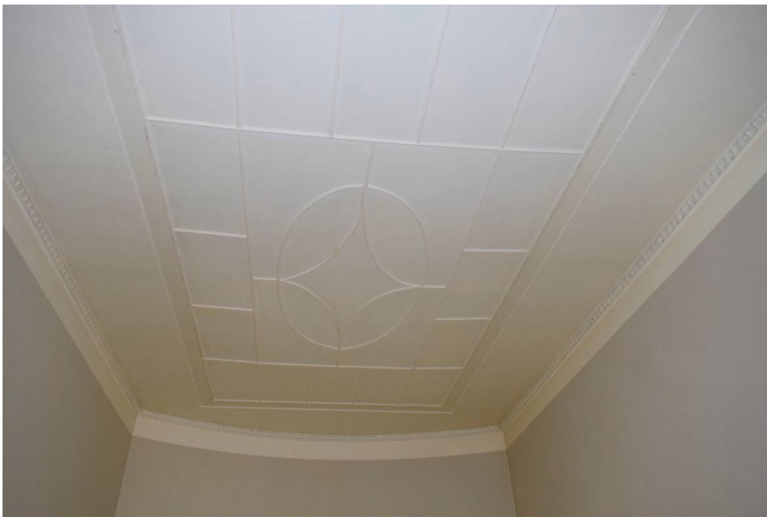
39. “Дом А.Ф. Кларка (здание общества «Мазут») Английская наб., д. 38, лит. А. Фонарь над лестницей №2. Фрагмент. Фото:01.02.21.
