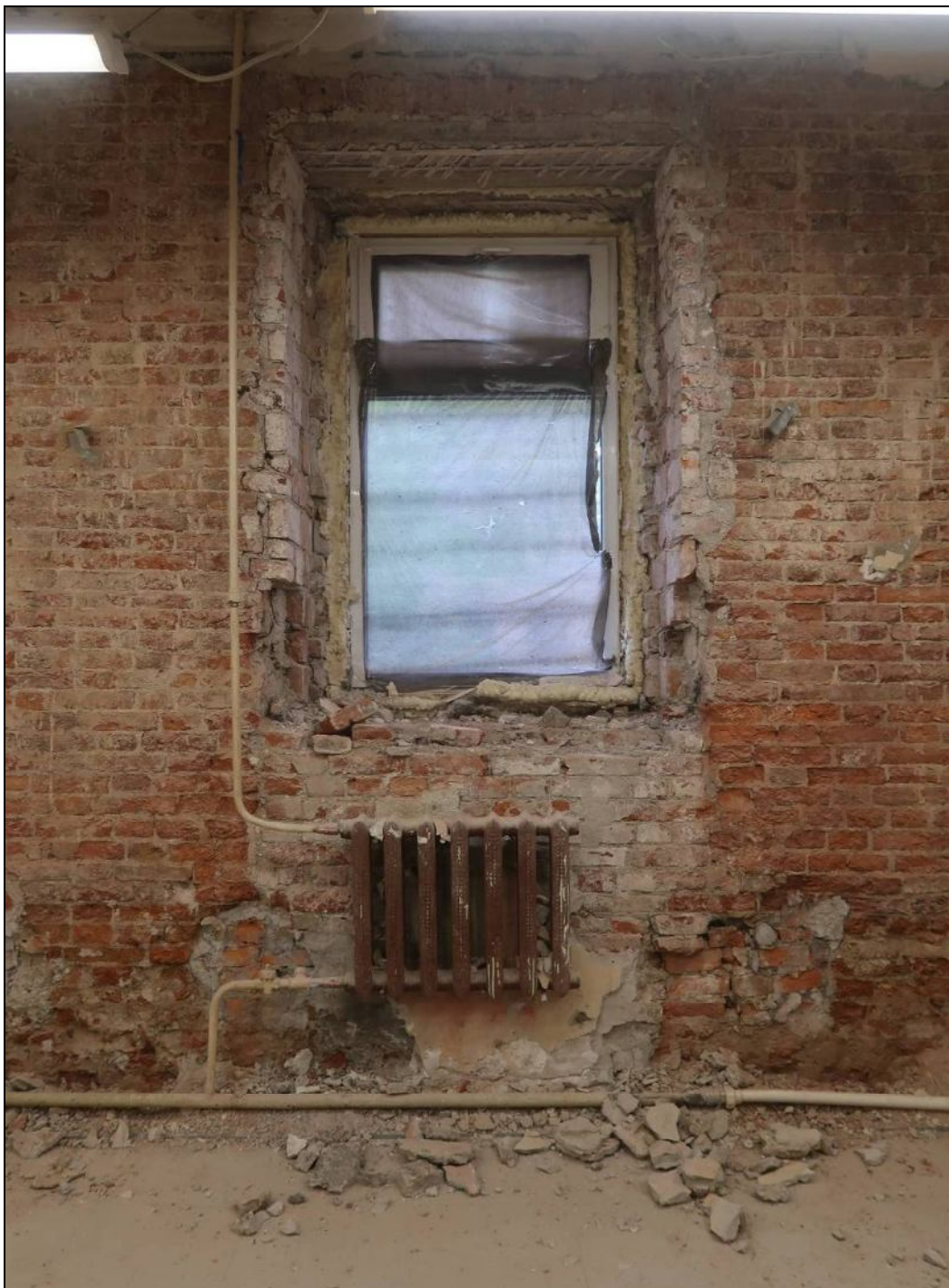
30. Вид в помещении 1-Н. Фрагмент.
