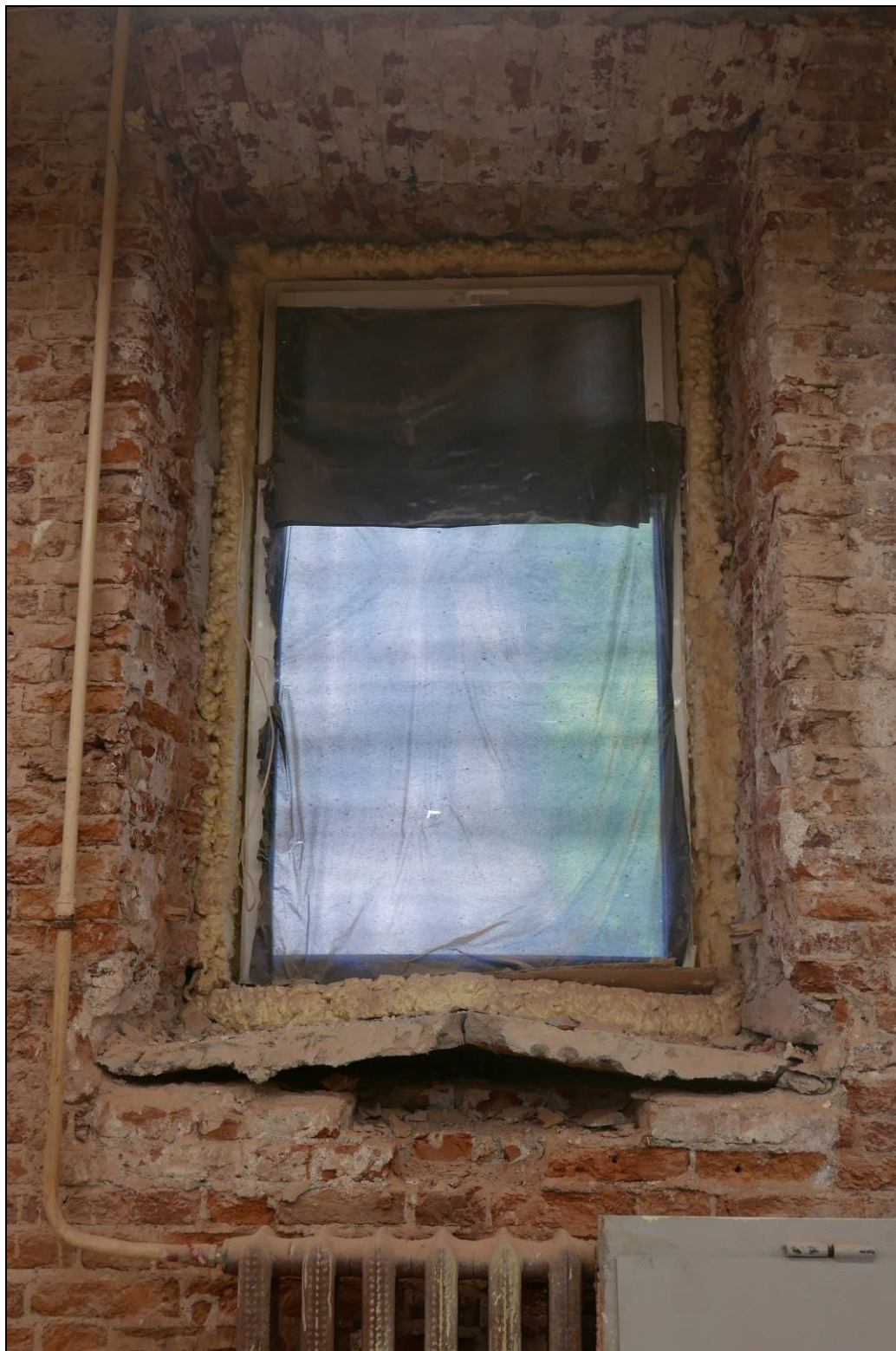
33. Вид в помещении 1-Н. Фрагмент.
