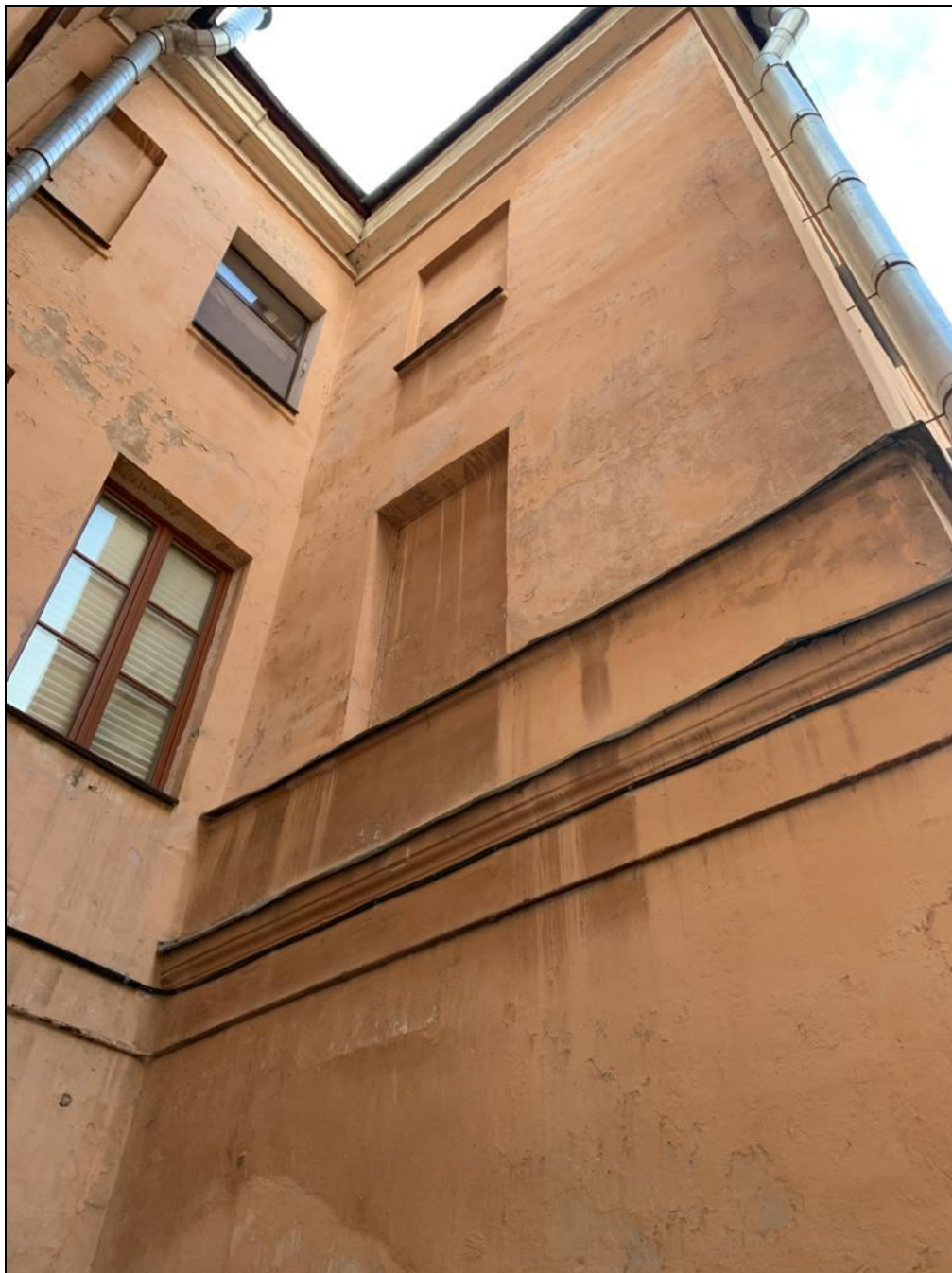
18. Дворовой юго-восточный фасад юго-восточного флигеля. Фрагмент.
