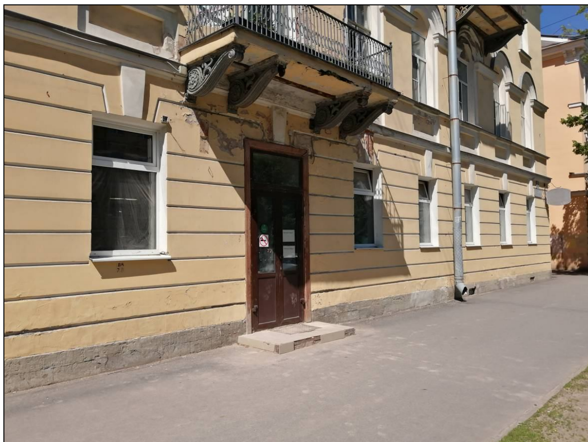
7. Фрагмент лицевого фасада дома №43 со стороны проспекта Ленина. Главный вход.
