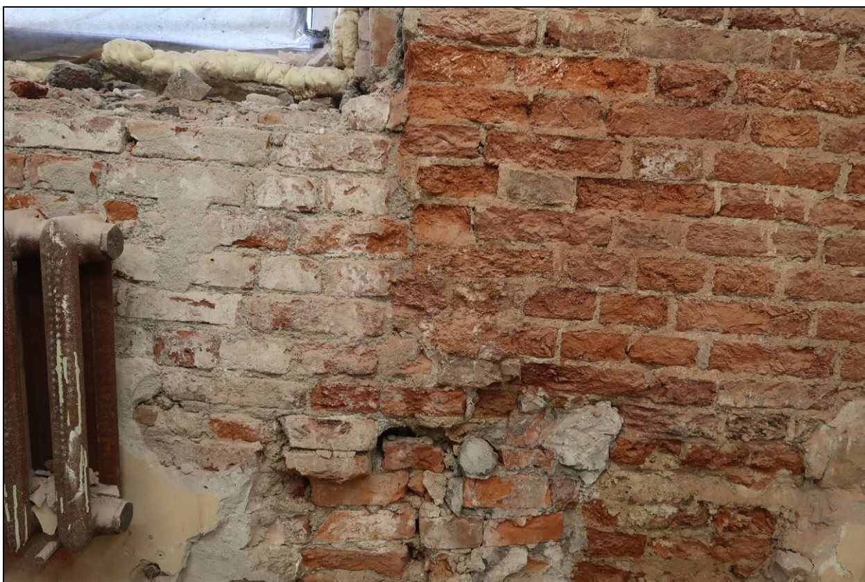
31-32. Вид в помещении 1-Н. Фрагменты стены. Заложенный проем.
