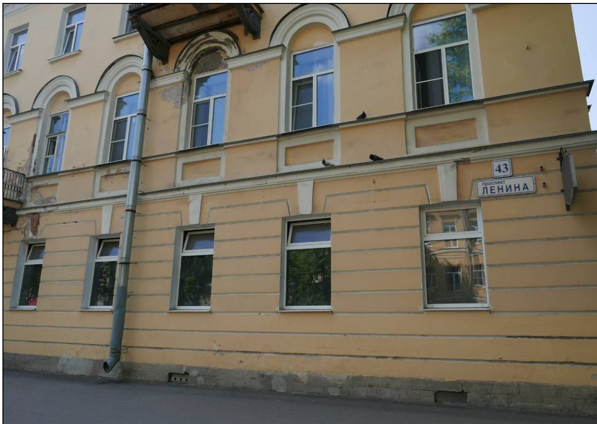
6. Фрагмент лицевого фасада дома №43 со стороны проспекта Ленина.
