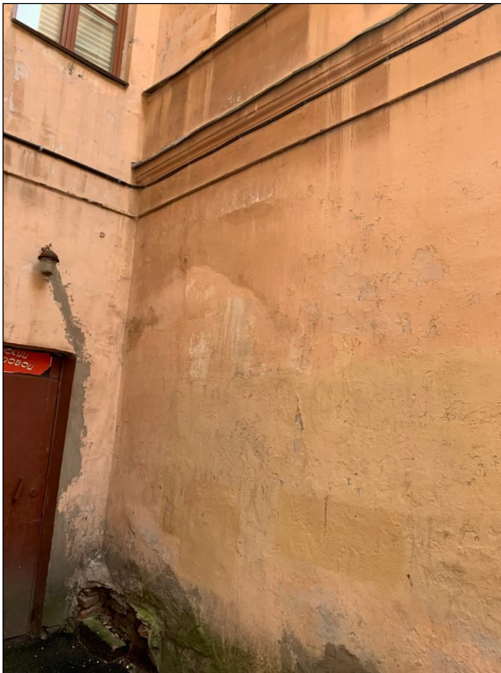
19. Дворовой юго-восточный фасад юго-восточного флигеля. Фрагмент.
