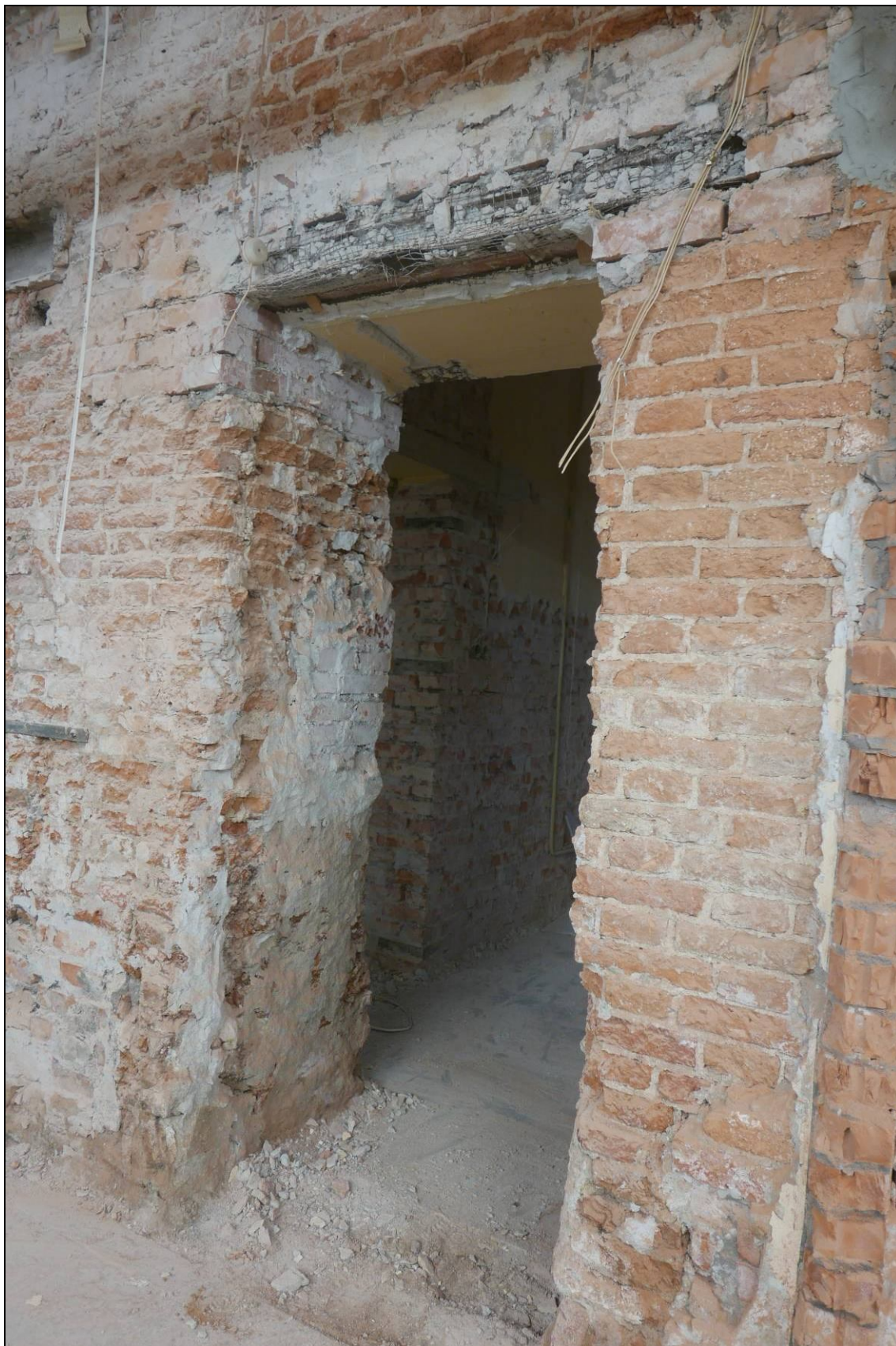
37. Вид в помещении 1-Н. Фрагмент.
