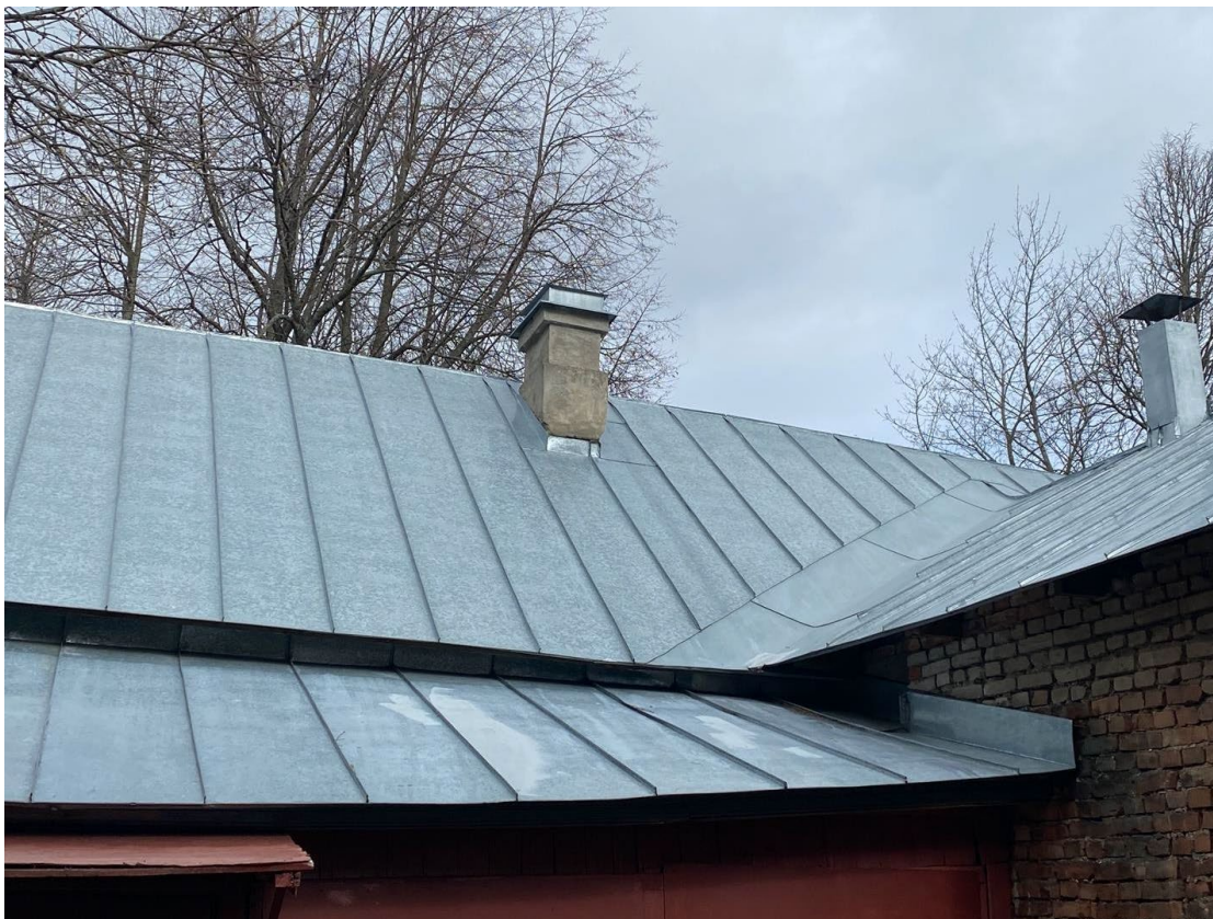
23. Дворцово-парковый ансамбль Сергиевка. Ферма. Кровля лит.Ю. Петухова Н.М. 03.11.2020.
