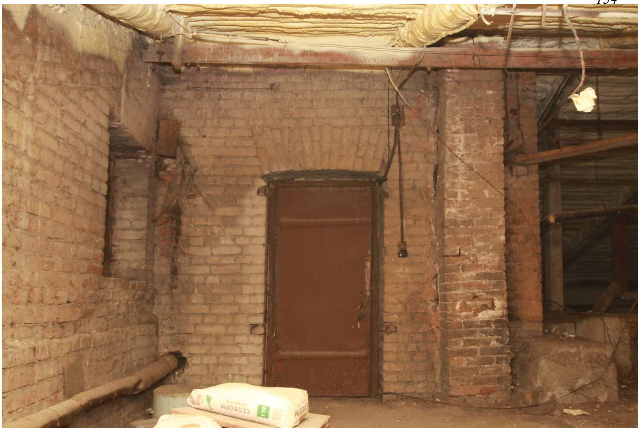
Фото 64. Вход на чердак.
