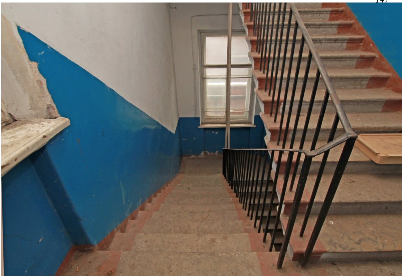
Фото 45. Общий вид 2ЛК.
