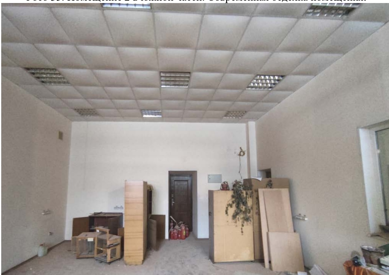
Фото 36. Помещение 16 в северной части.
