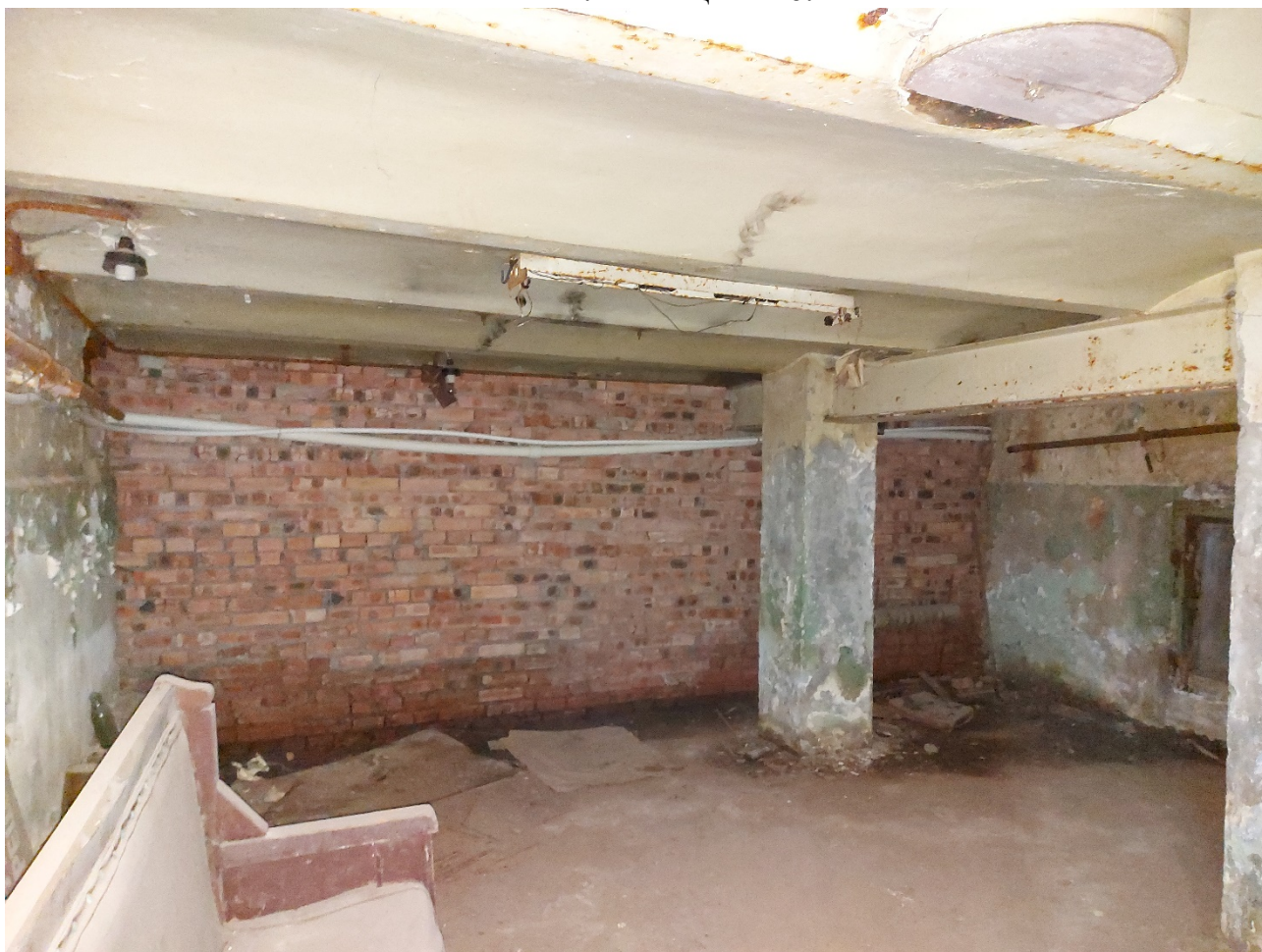
Фото 22. Помещение 2, примыкающее к бывшему подземному проходу. Поздняя кладка перехода.
