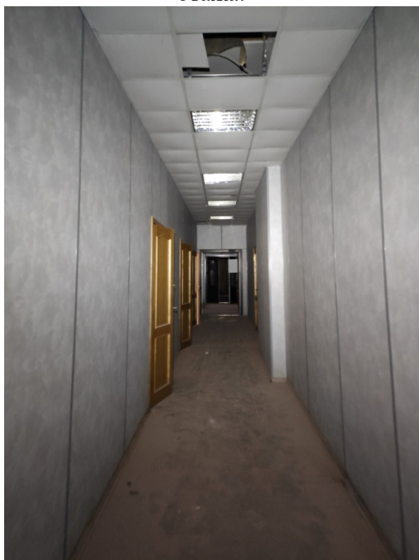
Фото 43. Общий вид помещения 1 (коридор).
