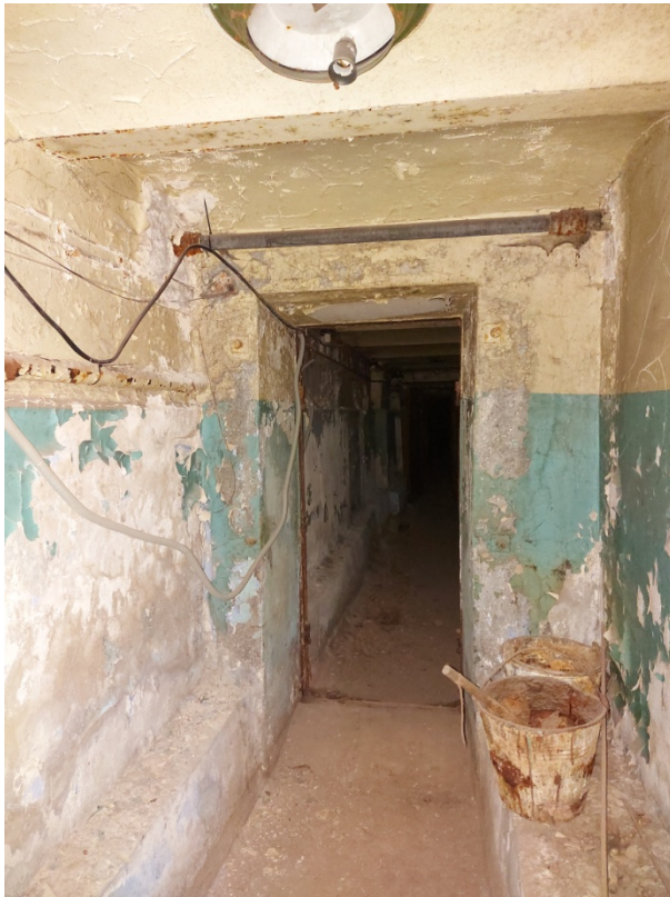
Фото 19. Вход в подвал и центральный проход.
