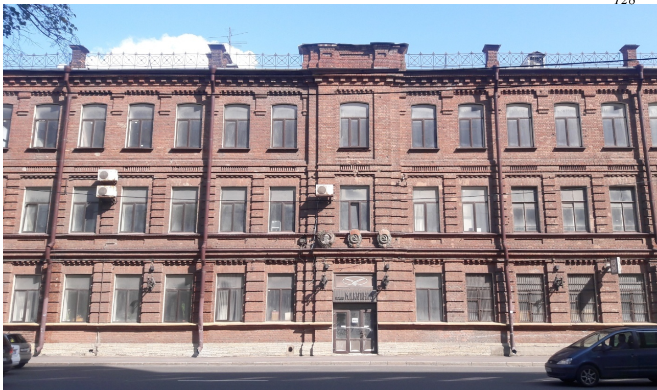
Фото 1. Лицевой фасад по ул. Уральской.
