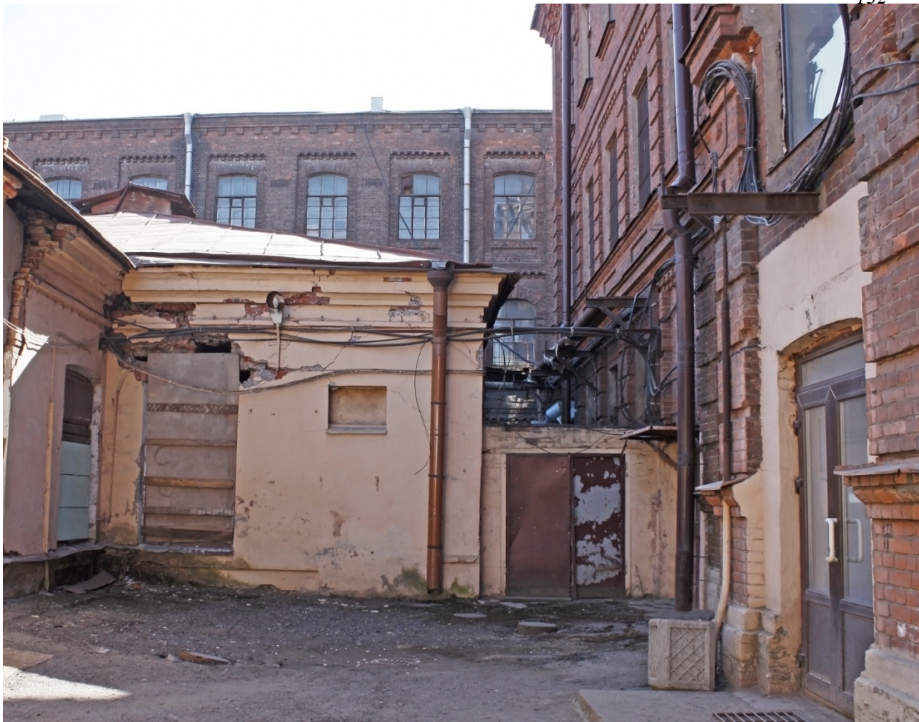
Фото 10. Восточный фасад. Примыкание поздних сооружений.
