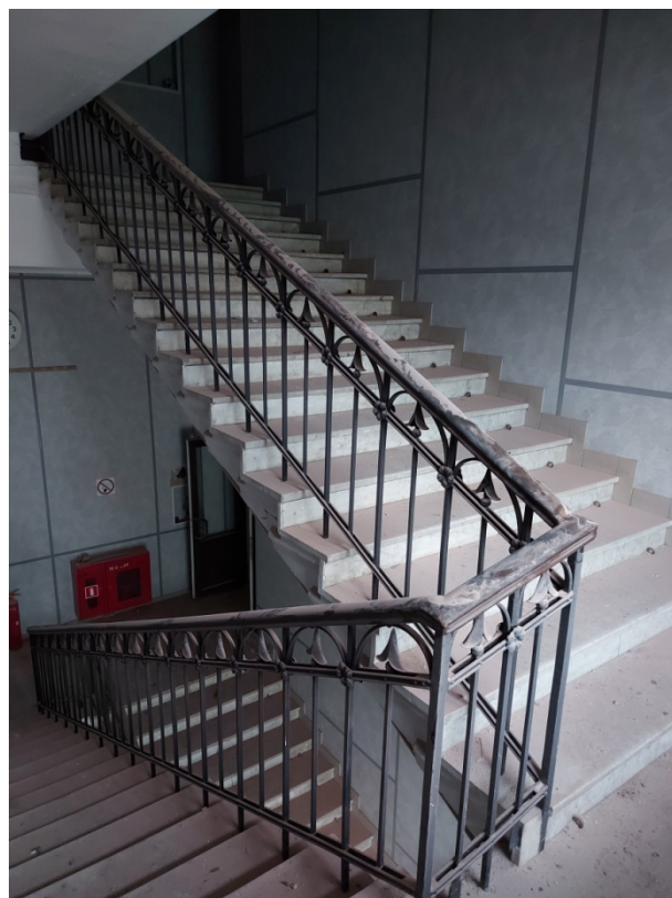
Фото 50. 1ЛК между 2 и 3 этажами.
