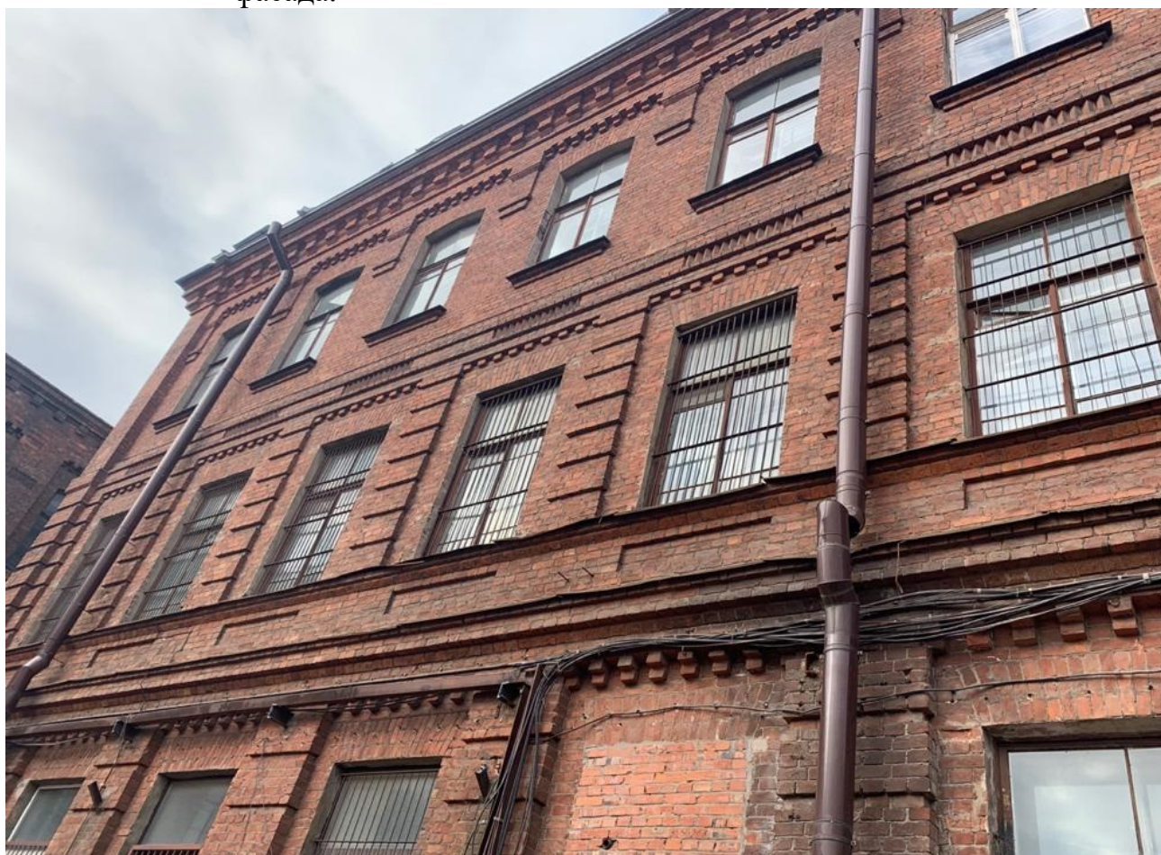
Фото 17. Фрагмент восточного фасада.
