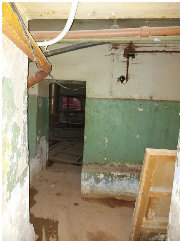
Фото 23. Вид на северную часть подвала.
