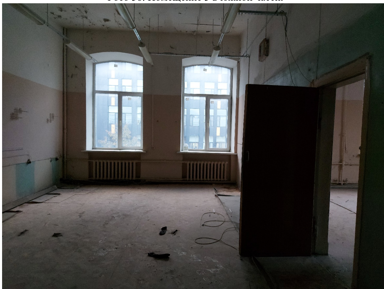
Фото 57. Помещение 2 в северной части.
