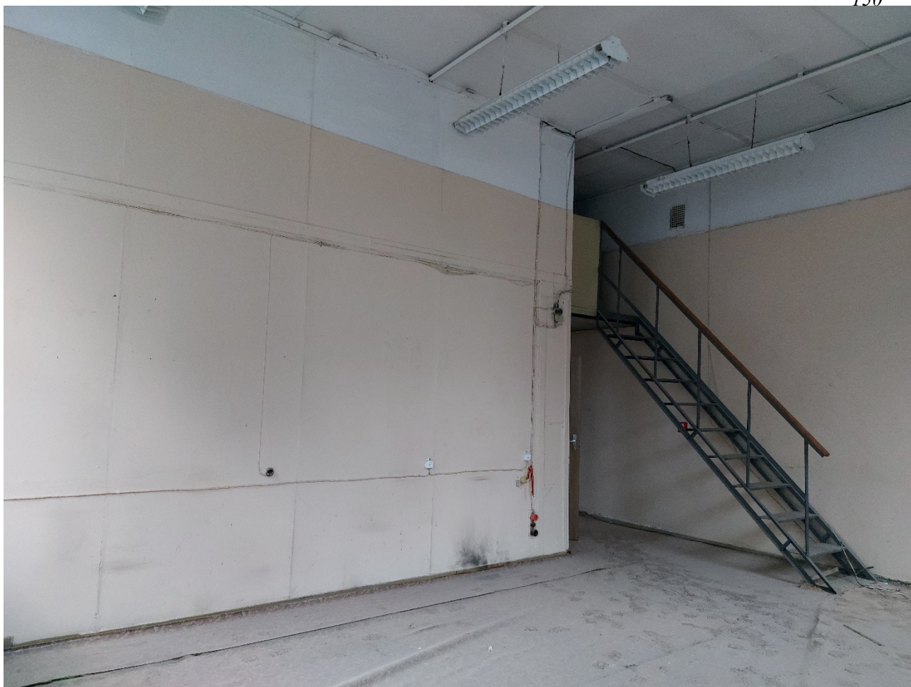
Фото 54. Помещение 9 в юго-западном углу.
