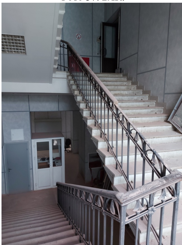
Фото 39. Общий вид лестница 1ЛК.
