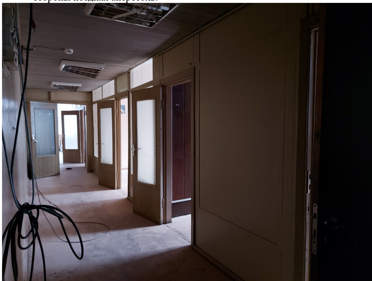
Фото 53. Общий вид южной части на 3 этаже.
