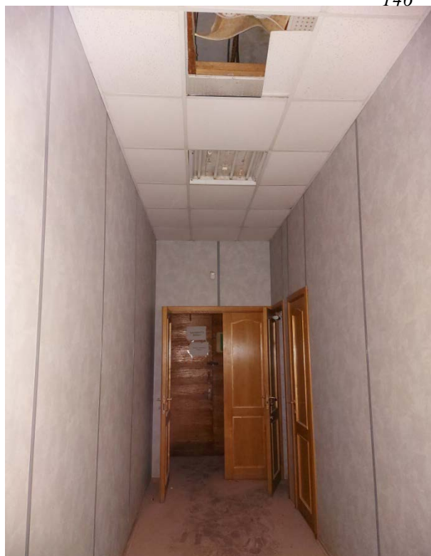
Фото 42. Выход на 2ЛК.
