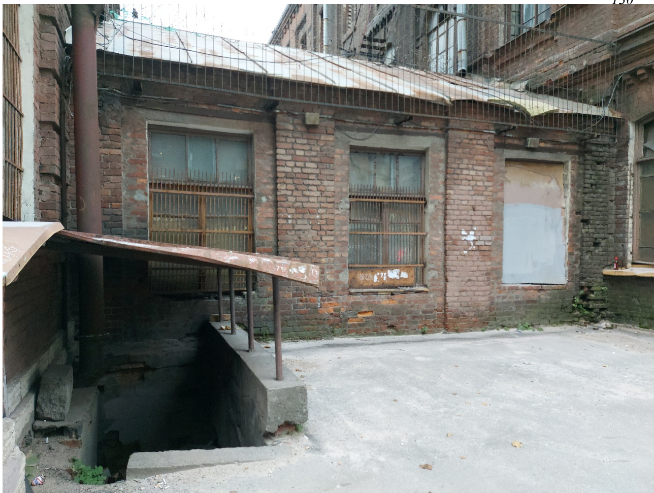
Фото 6. Галерея (переход) с запада.
