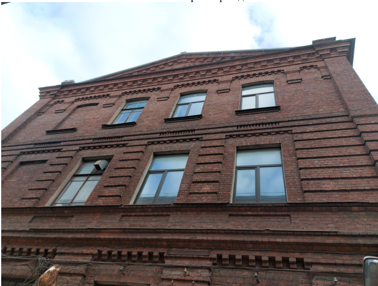
Фото 9. Северный фасад. Верхняя зона.
