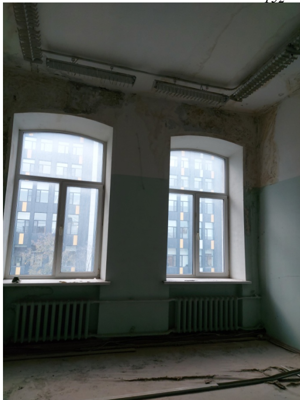
Фото 59. Помещение 20 северной части.
