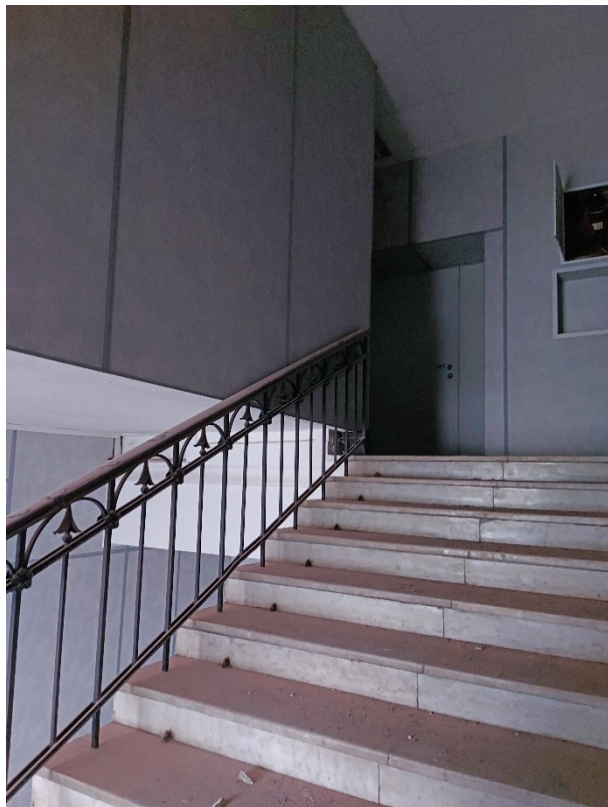
Фото 51. Лестница на 3 этаж. С южной стороны поздняя антресоль.
