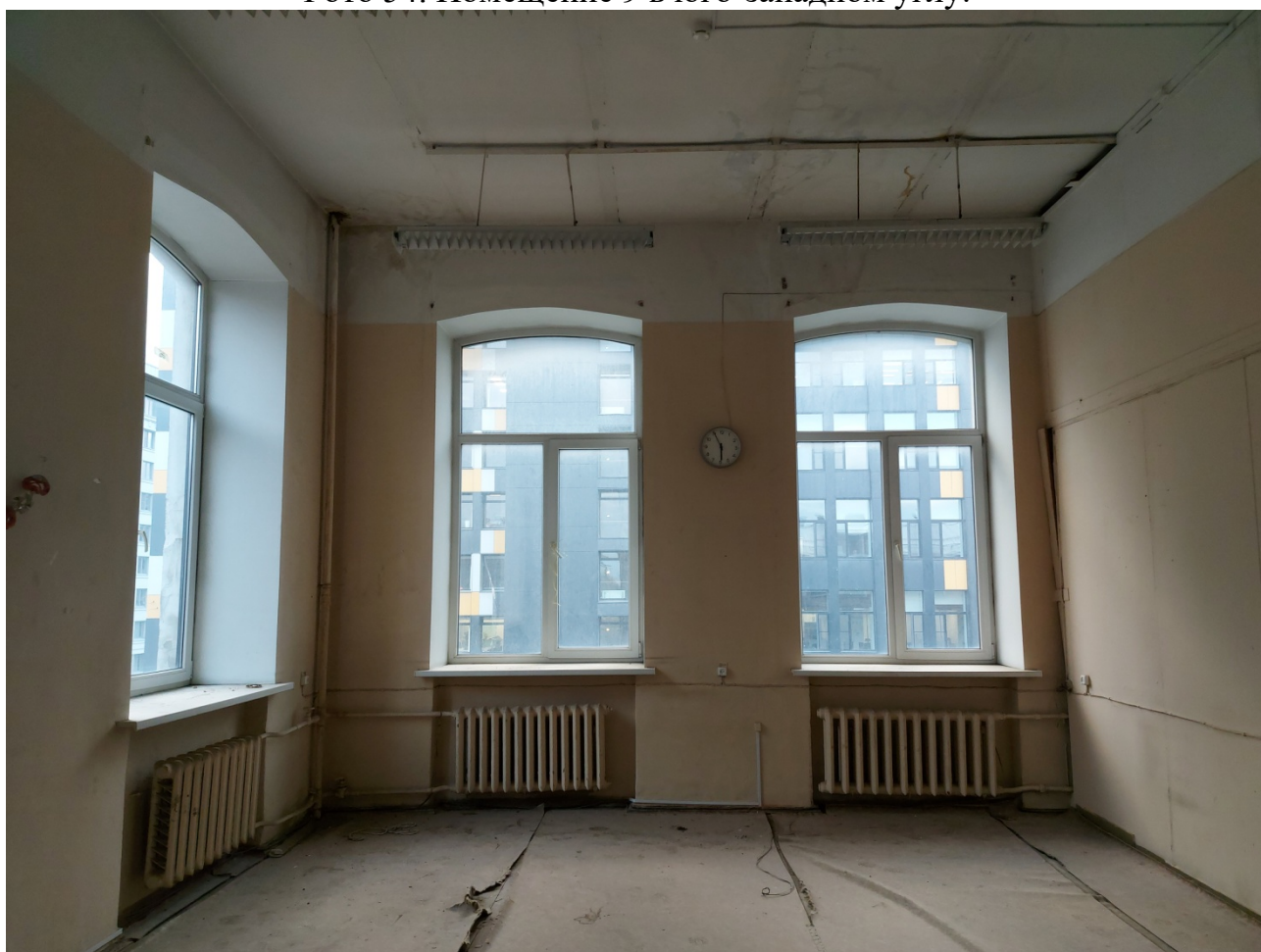
Фото 55. Помещение 9 в южной части здания.
