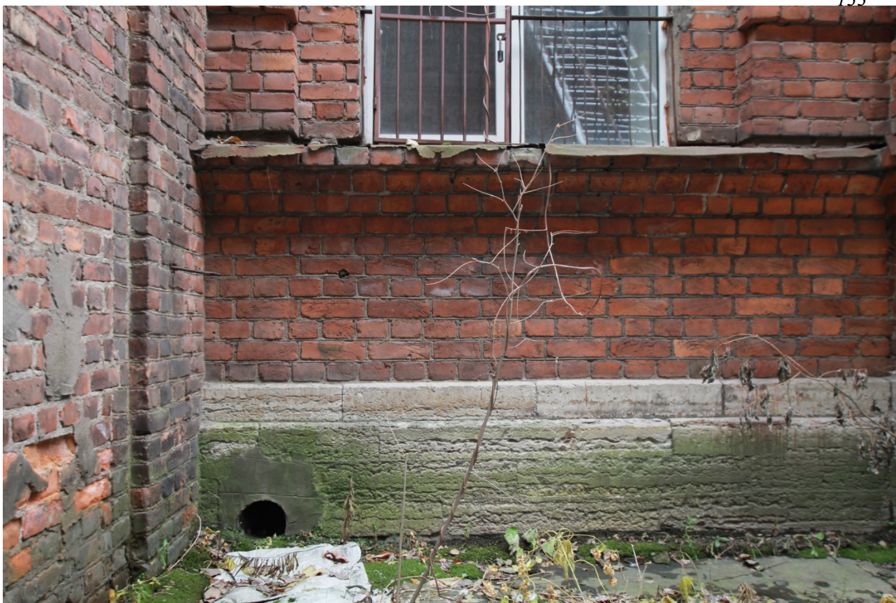
Фото 12. Примыкание поздней галереи.
