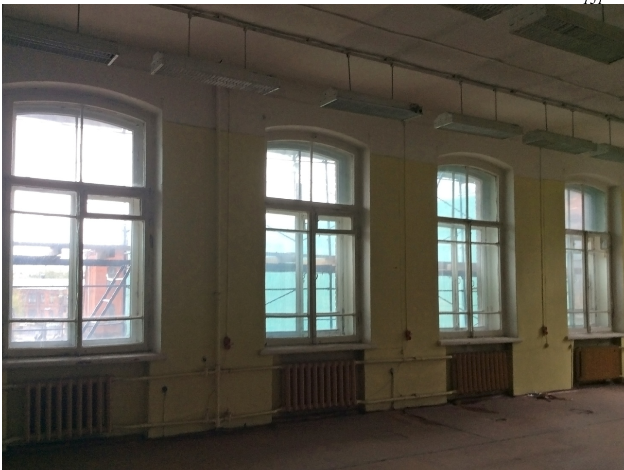
Фото 56. Помещение 5 в южной части.
