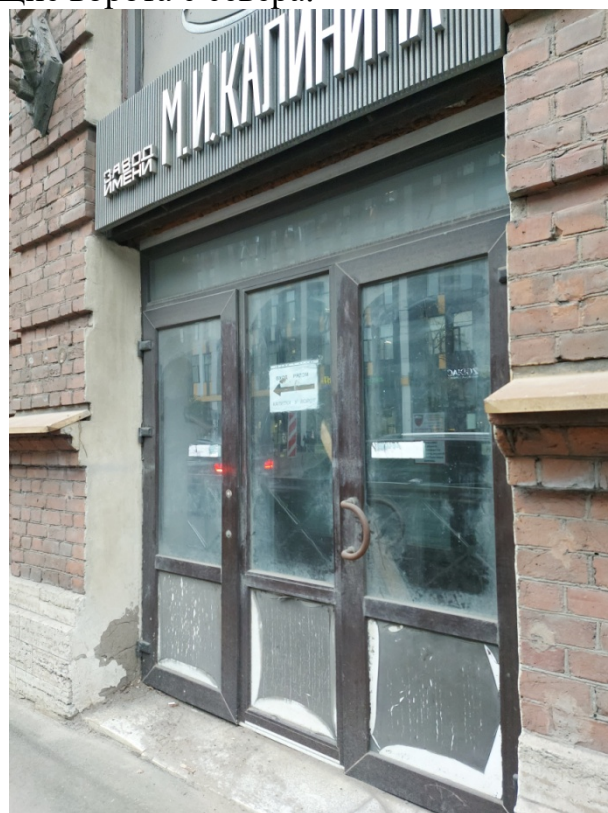
Фото 5. Центральное дверное заполнение.
