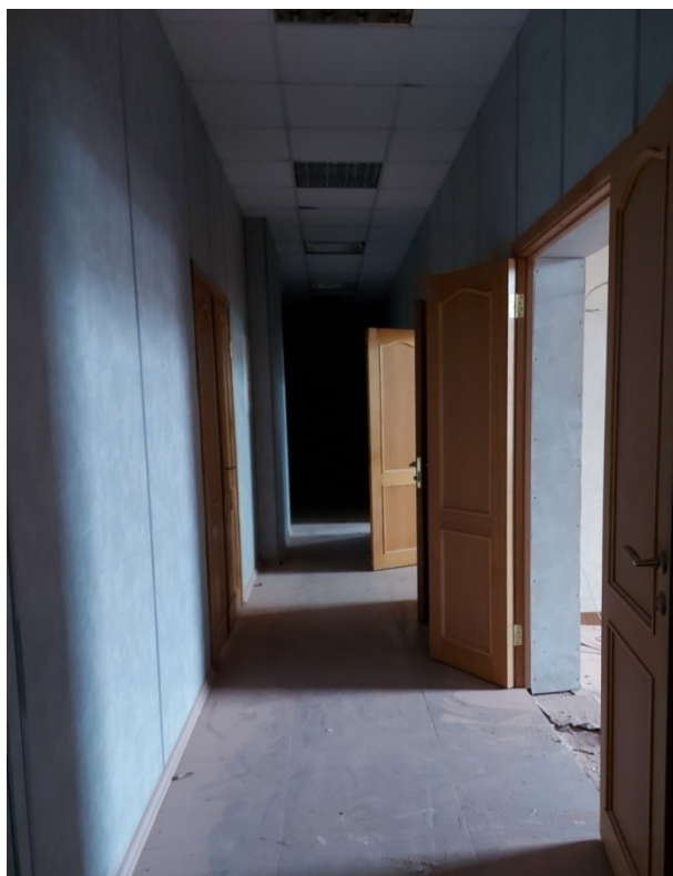
Фото 41. Общий вид южной части 2-го этажа.
