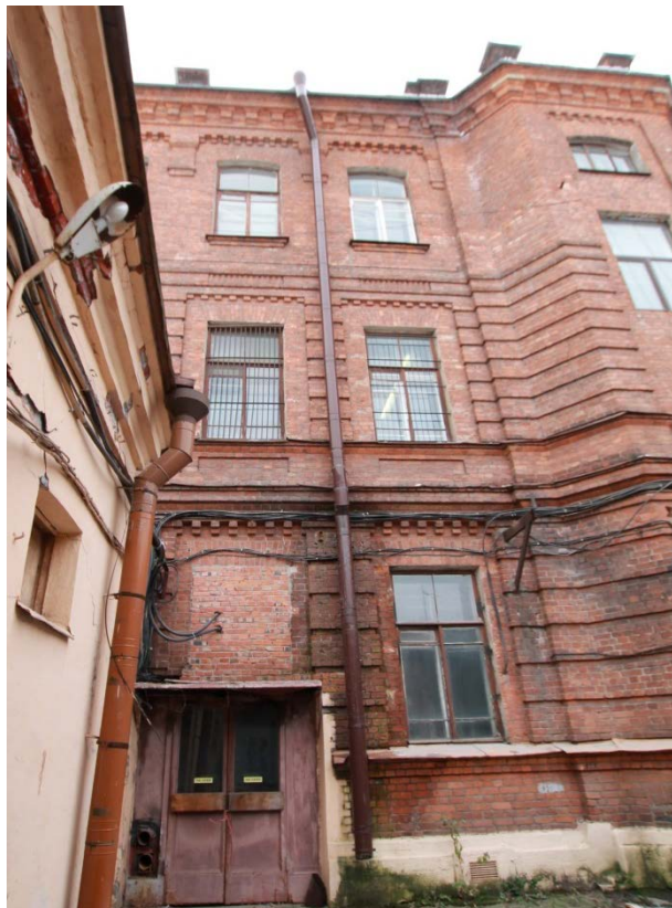
Фото 15. Южная часть восточного фасада.
