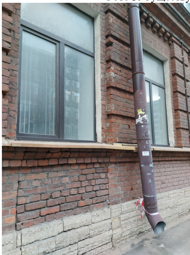
Фото 4. Фрагмент поздней подоконной кладки.
