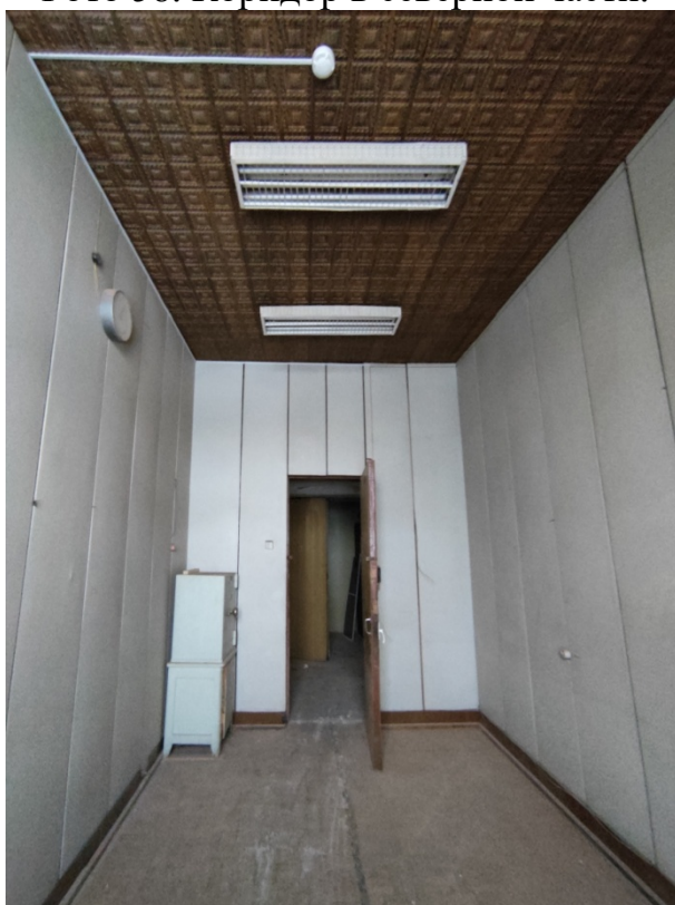
Фото 60. Помещение 16. Современная отделка.
