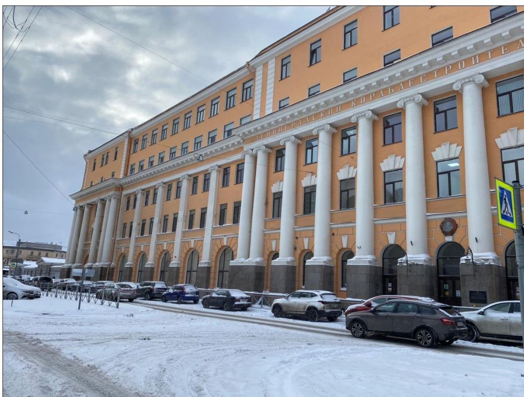
15. «Здание администрации Адмиралтейского судостроительного завода», ул. Лоцманская, д.3, лит. А. Юго-восточный фасад. Фрагмент. Фото 10.02.2021 г.
