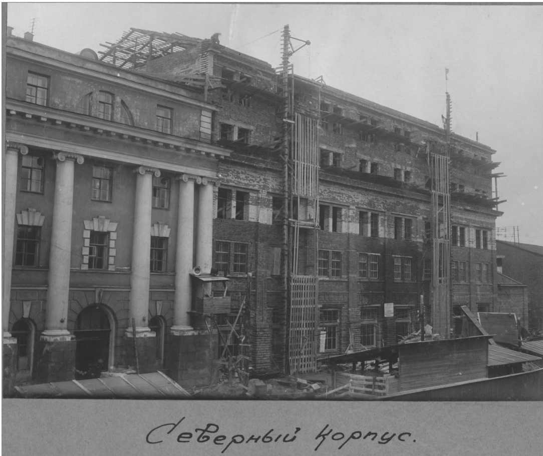
9. Работы по возведению нового северного корпуса. 1936 г.
