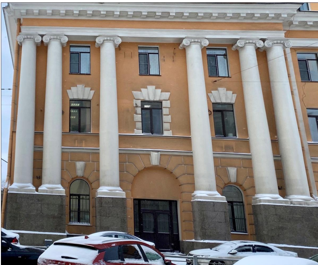
14. «Здание администрации Адмиралтейского судостроительного завода», ул. Лоцманская, д.3, лит. А. Юго-восточный фасад. Фрагмент. Фото 10.02.2021 г.
