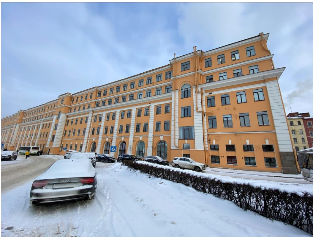
5. «Здание администрации Адмиралтейского судостроительного завода», ул. Лоцманская, д.3, лит. А. Юго-западный фасад. Общий вид. Фото 10.02.2021 г.
