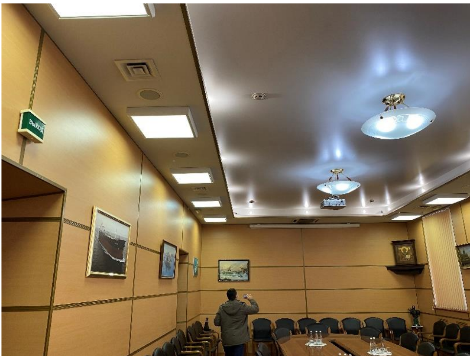
39. «Здание администрации Адмиралтейского судостроительного завода», ул. Лоцманская, д.3, лит. А. Общий вид помещения 2-го этажа. Фото 10.02.2021 г.
