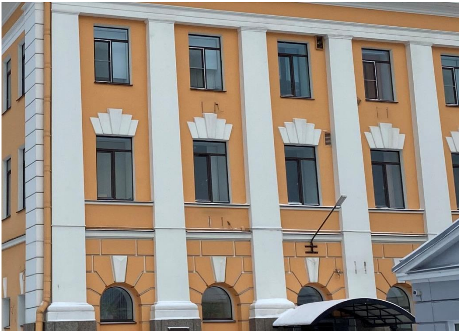
8. «Здание администрации Адмиралтейского судостроительного завода», ул. Лоцманская, д.3, лит. А. Юго-восточный фасад. Фрагмент. Фото 10.02.2021 г.
