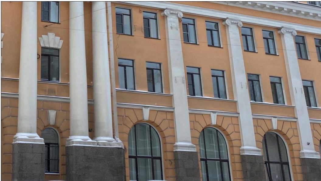
16. «Здание администрации Адмиралтейского судостроительного завода», ул. Лоцманская, д.3, лит. А. Юго-восточный фасад. Фрагмент. Фото 10.02.2021 г.
