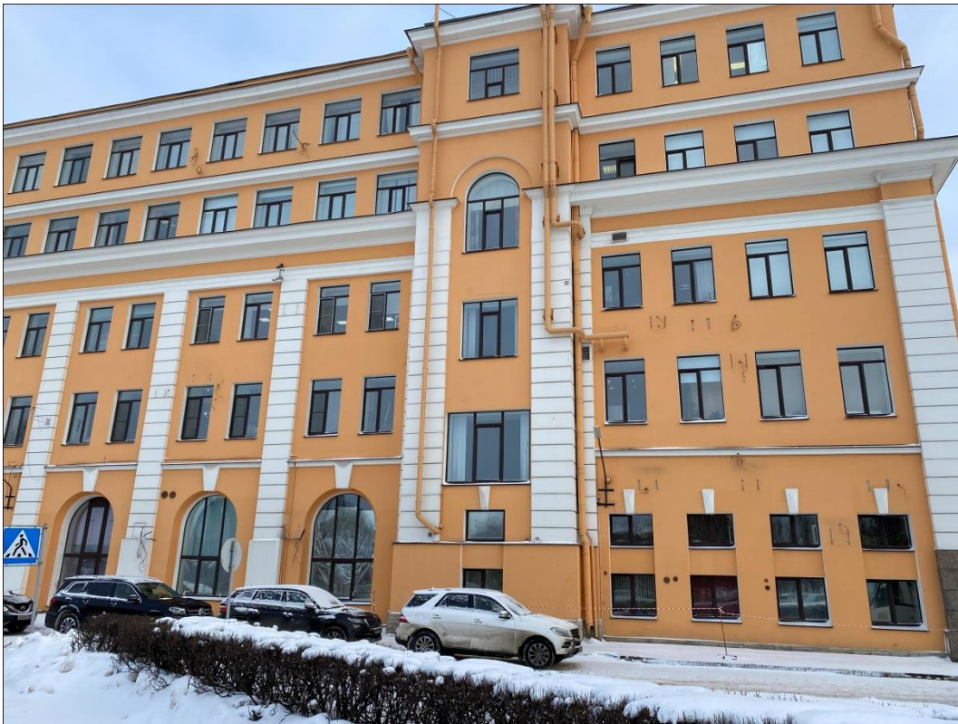
12. «Здание администрации Адмиралтейского судостроительного завода», ул. Лощманская, д.3, лит. А. Юго-западный фасад. Фрагмент. Фото 10.02.2021 г.
