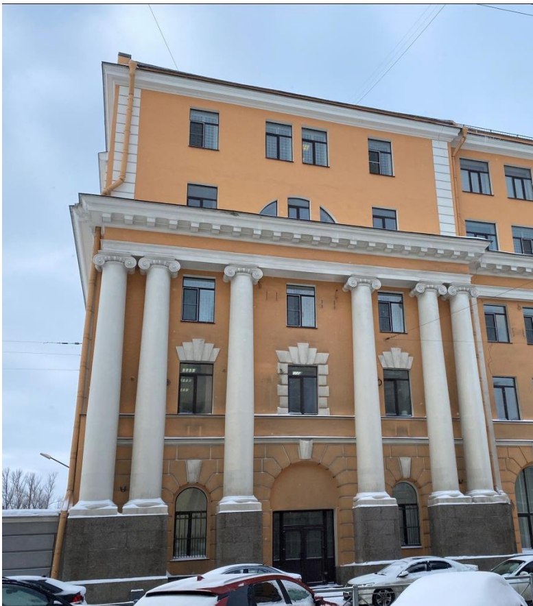
13. «Здание администрации Адмиралтейского судостроительного завода», ул. Лощманская, д.3, лит. А. Юго-восточный фасад. Фрагмент. Фото 10.02.2021 г.
