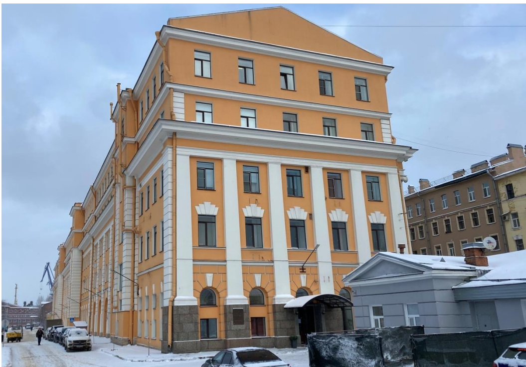
7. «Здание администрации Адмиралтейского судостроительного завода», ул. Лоцманская, д.3, лит. А. Юго-восточный фасад. Фрагмент. Фото 10.02.2021 г.
