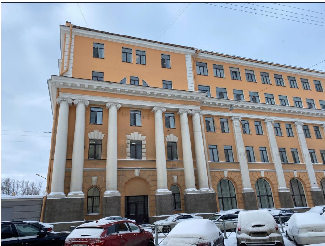
2. «Здание администрации Адмиралтейского судостроительного завода», ул. Лоцманская, д.3, лит. А. Фрагмент восточного фасада. Фото 10.02.2021 г.
