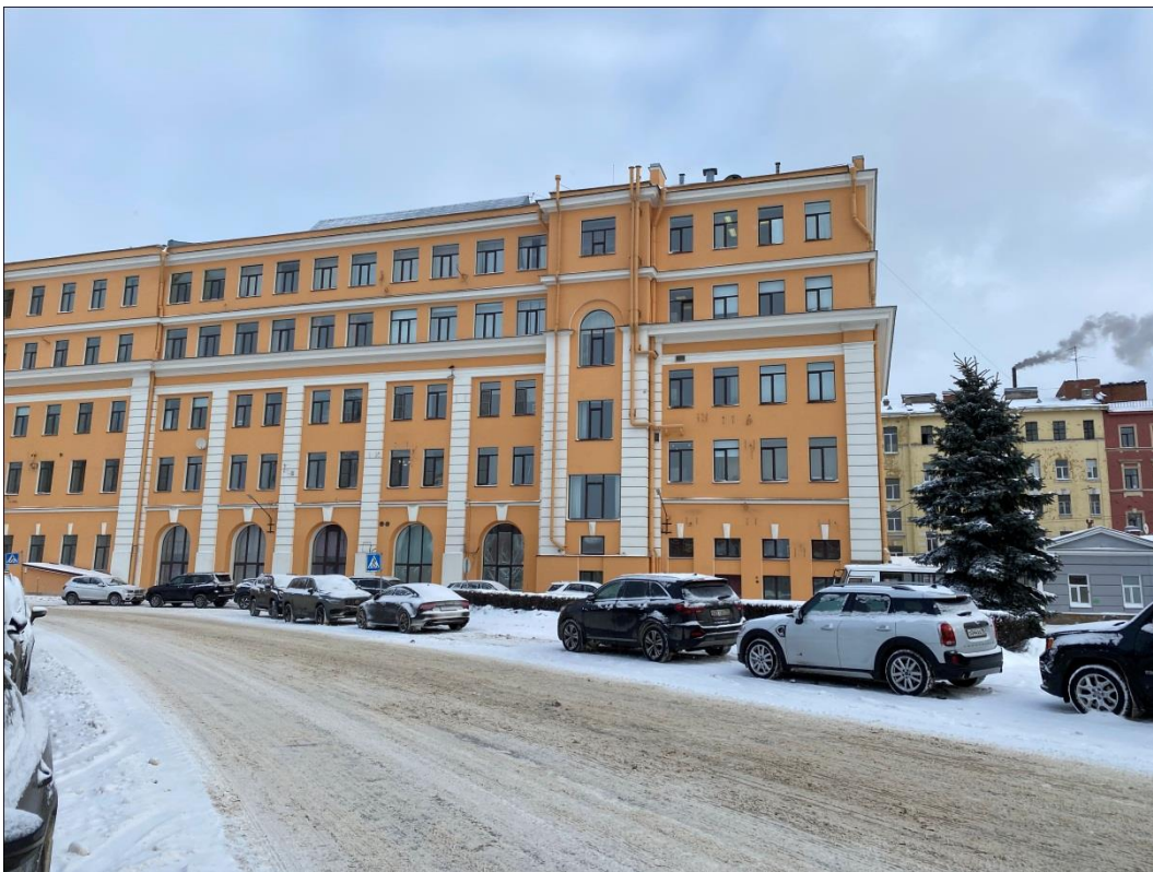
9. «Здание администрации Адмиралтейского судостроительного завода», ул. Лоцманская, д.3, лит. А. Юго-западный фасад. Фрагмент. Фото 10.02.2021 г.
