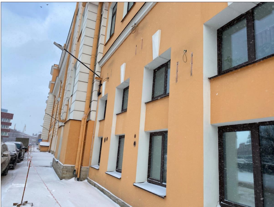
11. «Здание администрации Адмиралтейского судостроительного завода», ул. Лоцманская, д.3, лит. А. Юго-западный фасад. Фрагмент. Фото 10.02.2021 г.
