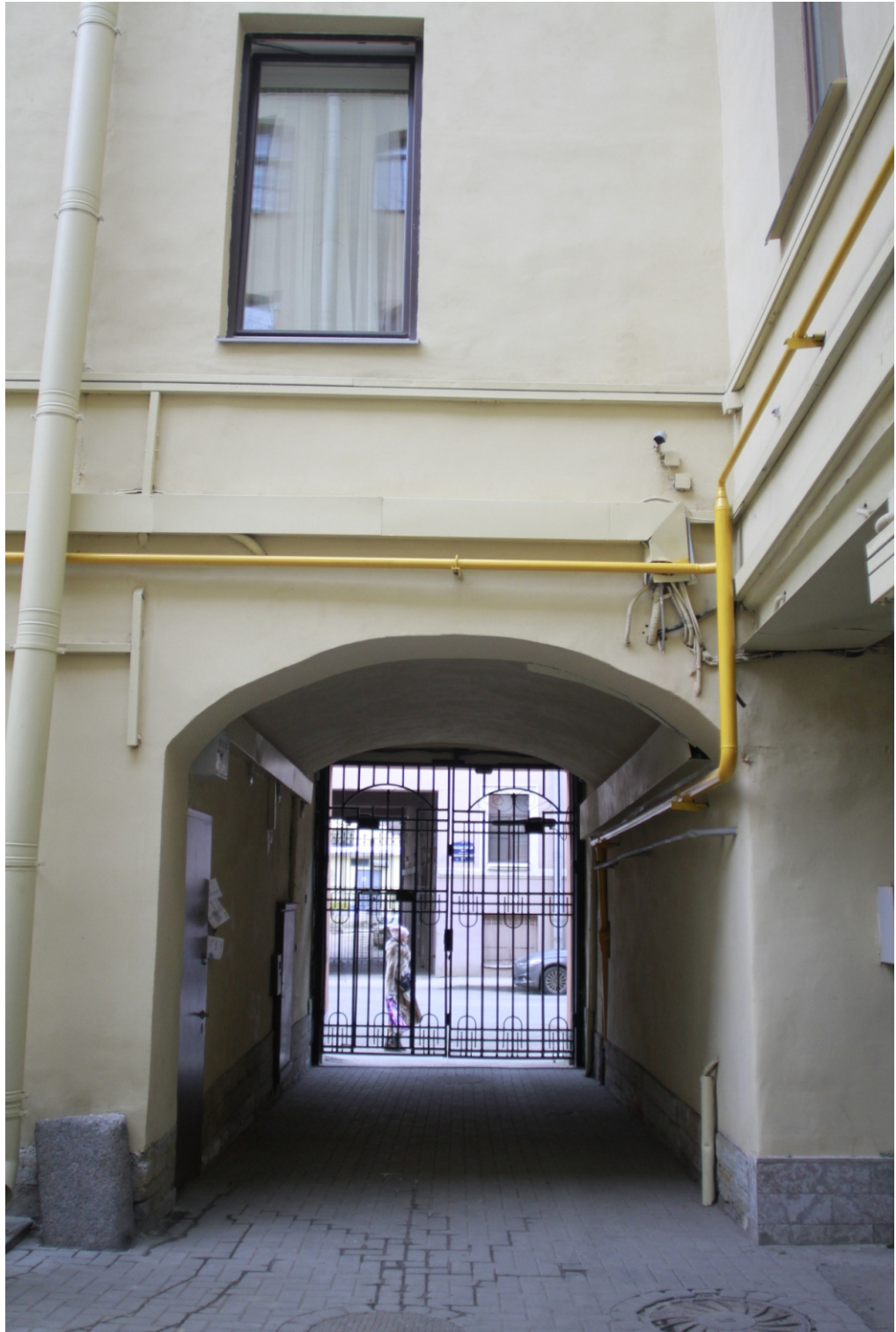
10. «Дом И.Д. Черткова». Санкт-Петербург, ул. Гороховая, д.24/24, литера А. Северный дворовый фасад. Фрагмент. Воротный проезд. Фото: 15.11.2020.
