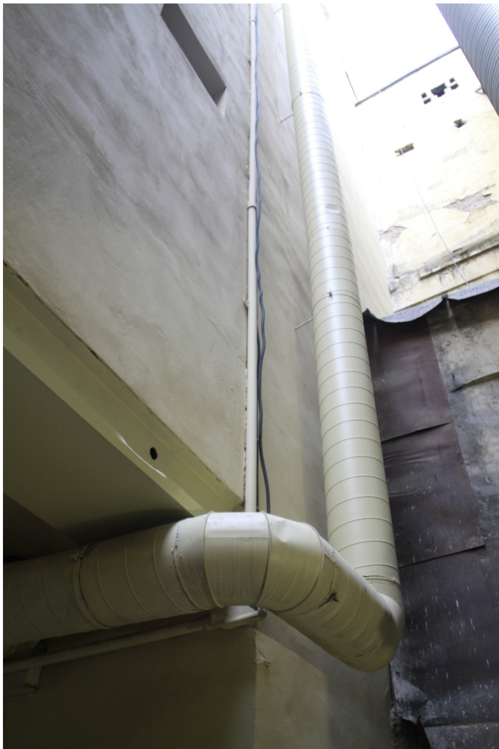
14. «Дом И.Д. Черткова». Санкт-Петербург, ул. Гороховая, д.24/24, литера А. Световой двор. Воздуховод. Фото: 15.11.2020.
