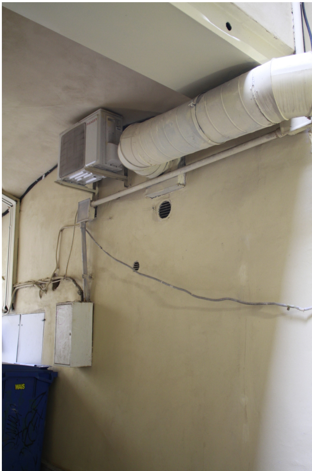
13. «Дом И.Д. Черткова». Санкт-Петербург, ул. Гороховая, д.24/24, литера А. Наружный блок кондиционера в арочном проезде. Фото: 15.11.2020.
