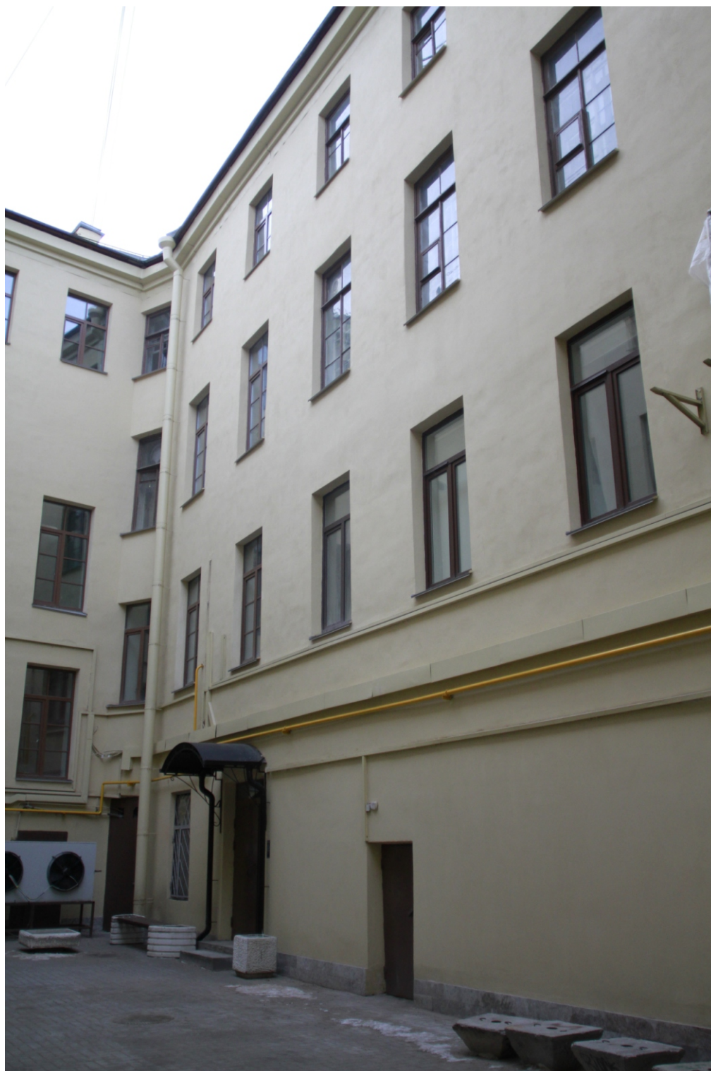
9. «Дом И.Д. Черткова». Санкт-Петербург, ул. Гороховая, д.24/24, литера А. Северный дворовый фасад. Фрагмент. Фото: 15.11.2020.
