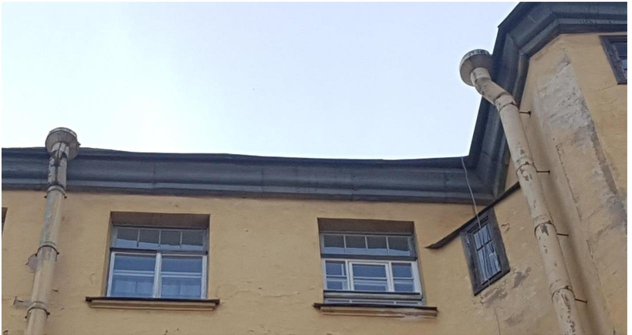
Фото 24. Венчающий карниз обшит металлом.
